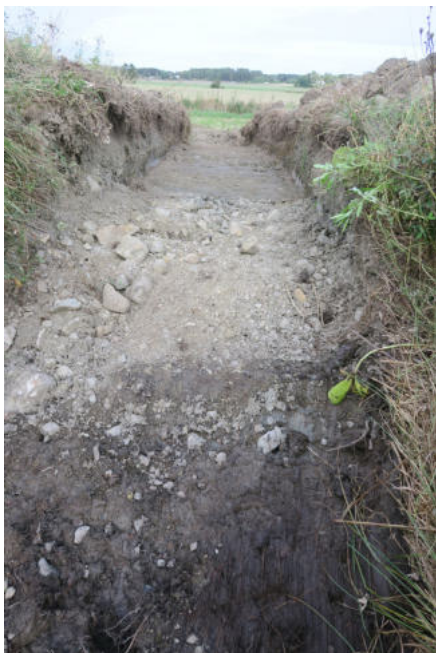
Figur 25. Den SV delen av schakt 6 fotograferat mot NÖ. Foto: Marta Lindeberg.
