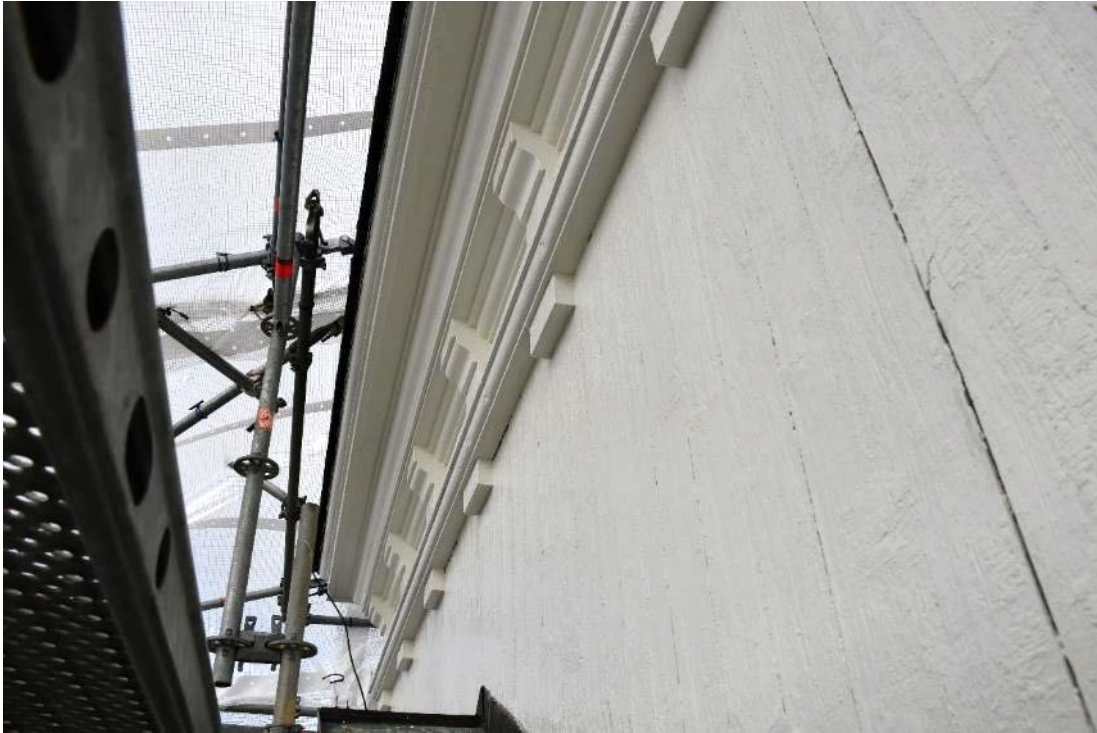
Figur 15 Listverk på lanterninen efter målning.
