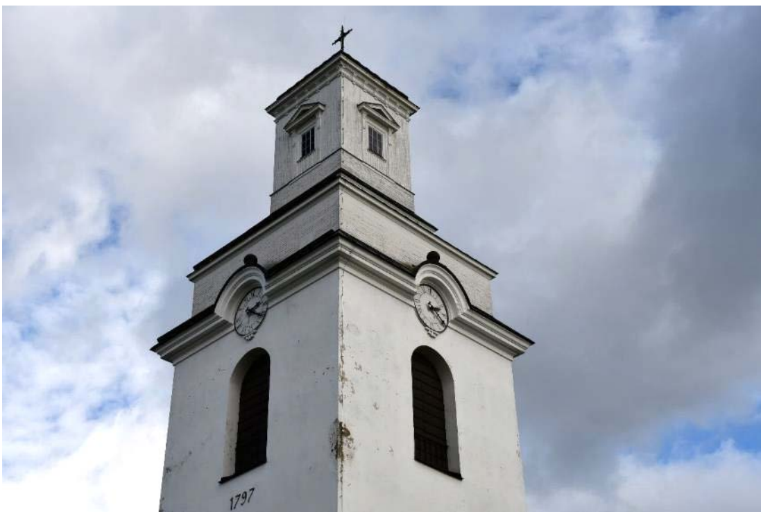
Figur 4 Torn och lanternin före åtgärd.
