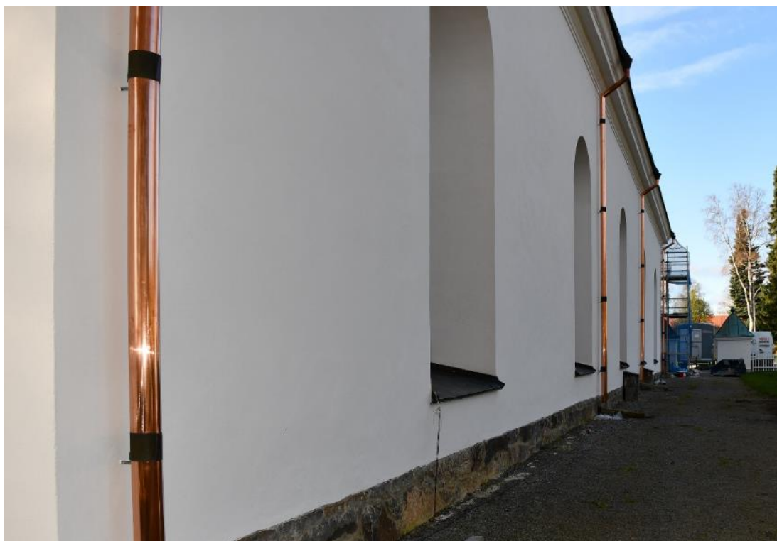
Figur 9 Till avfärgning av fasaden har man använt Keim Granital i kulör 9339.
