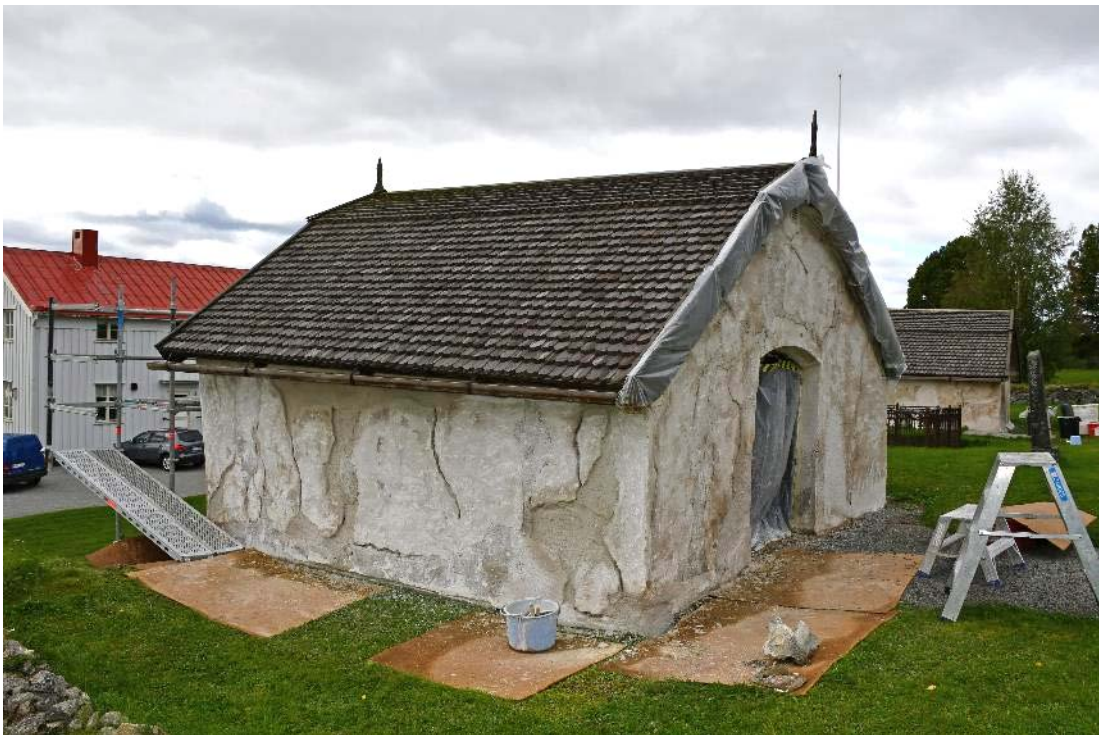
Figur 45 Fasad på gamla bårhuset (östra byggnaden) under pågående putsarbete.
