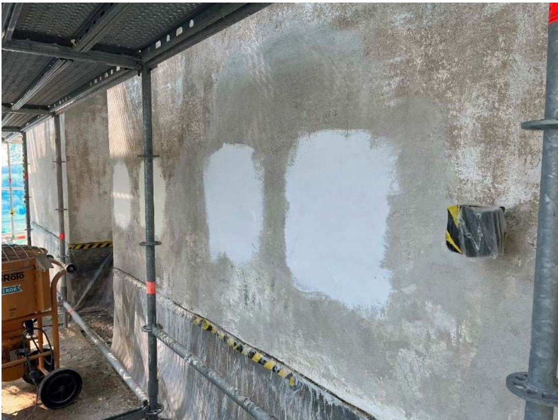
Figur 8 Uppstrykningsprover målades upp på den östra gavelfasaden utifrån färgskalan från KEIM Soldalit: Vit (ingen nummer), vit 9078, gulvit 9339 och rosa 9870.
