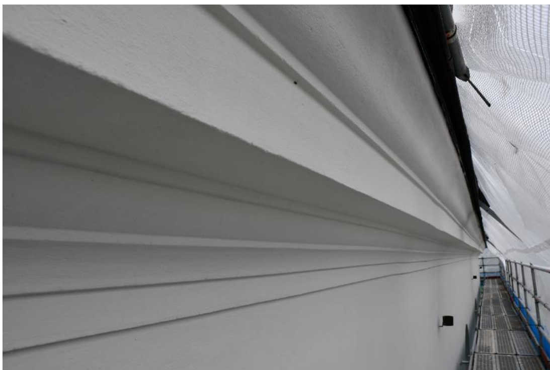
Figur 10 Taklist efter åtgärd.
