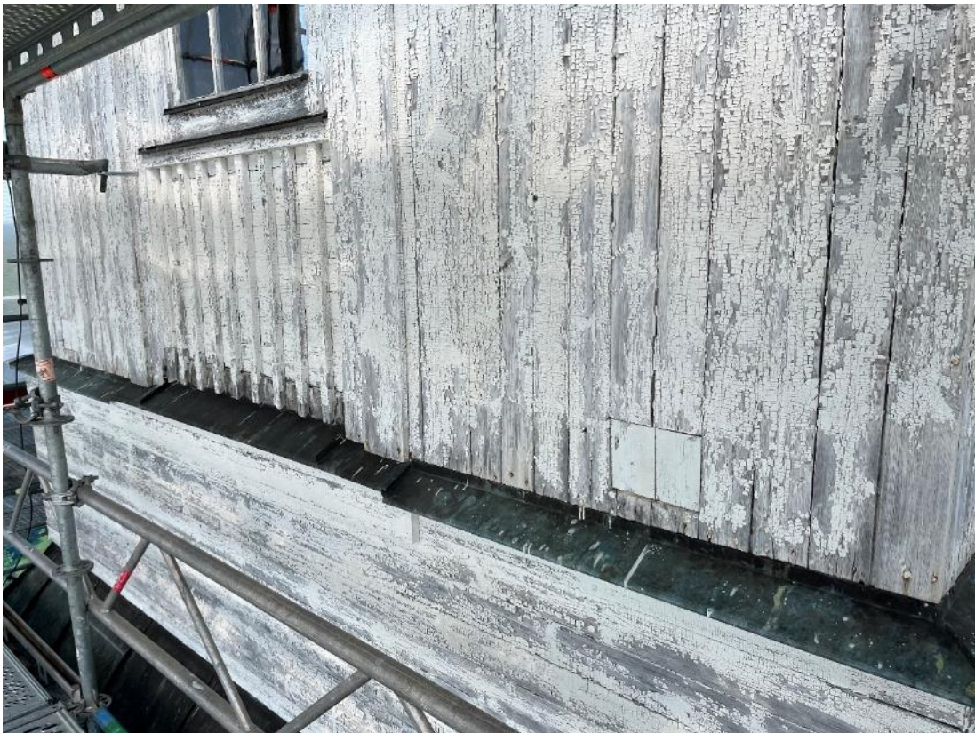
Figur 12 Lanterninen i trä var i stort behov av målningsbehandling.
