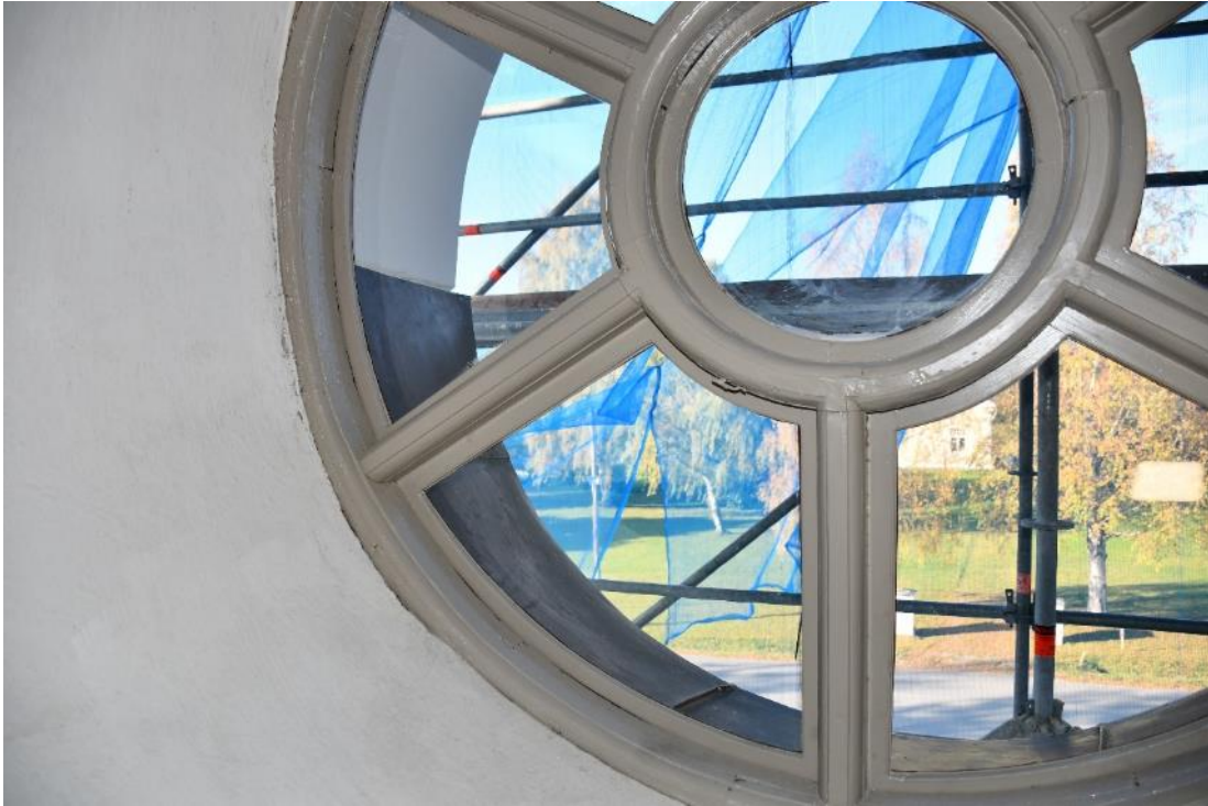
Figur 34 Fönstret ovanför entrén mot väster. Bågarna har kompletterats med trä på insidan så att de fått samma bredd som övriga fönsterbågar.
