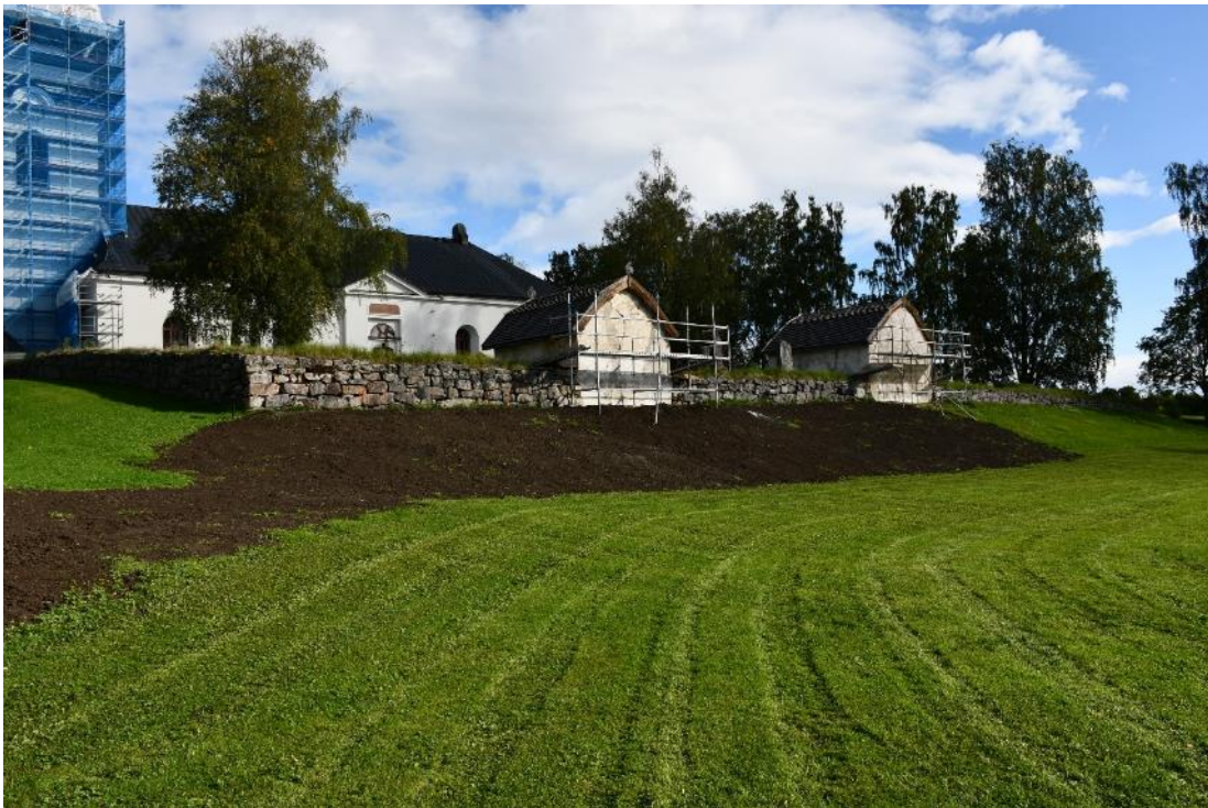
Figur 47 I slänten nedanför kyrkogårdsmuren mot söder fylldes det på med material.
