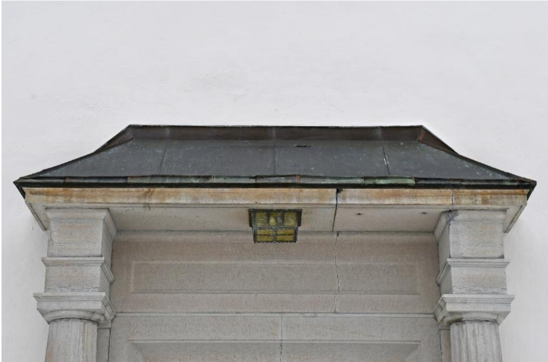
Figur 38 Ovanför ingången mot väster har en liten fotränna tillkommit (ca 5 cm hög) som leder vattnet åt sidan. Till fotrännan har man använt gammal ärgad kopparplåt, varför den upplevs som om den "alltid" varit där.
