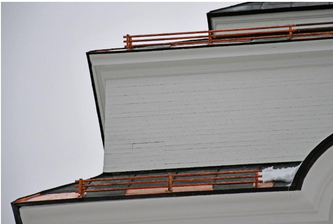
Figur 37 De takplåtar längsmed takfoten som hade hål efter de gamla fästena, har bytts ut. Snörasskydden har ersatts av nya i koppar med tre rör som monterats på taket med falsfästen.
