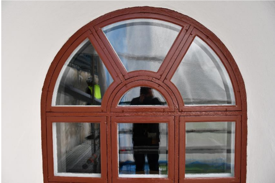
Figur 32 Fönster efter åtgärd.
