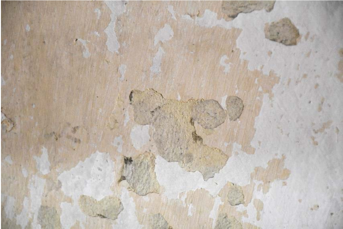
Figur 40 Under det löst sittande vita färgskiktet ytterst, framträdde en laxrosa avfärgning och under den något som uppfattades som ett gult färgskikt.
