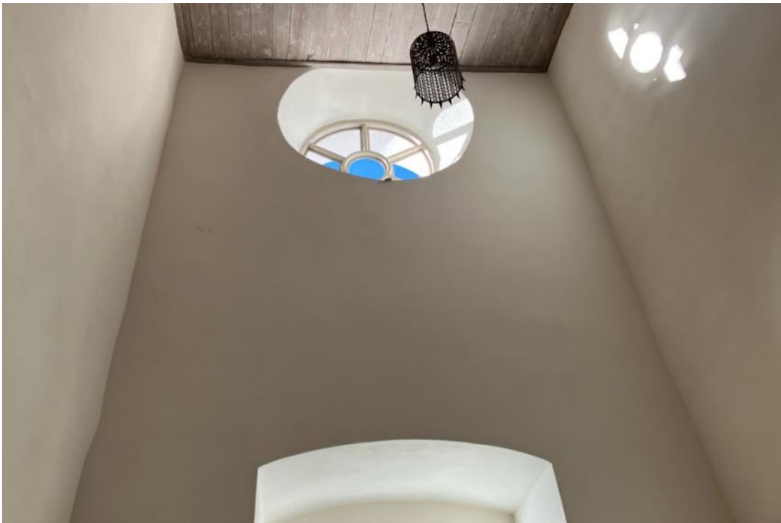
Figur 43 Övre del av vapenhus efter åtgärd (foto: Cristofer Said).
