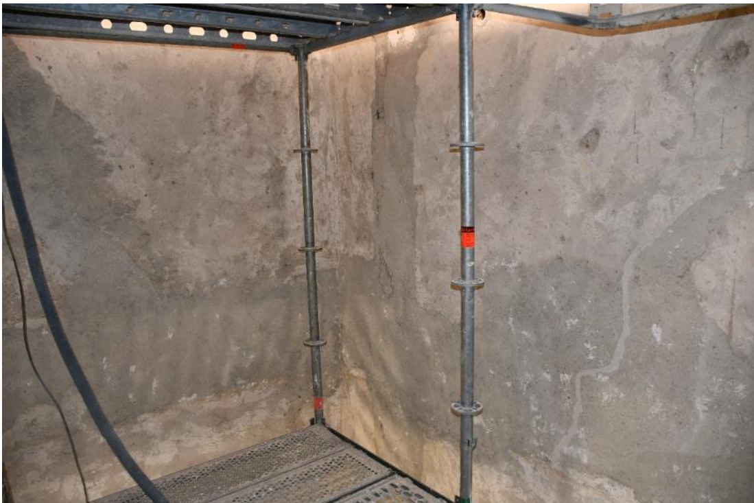
Figur 41 Vapenhuset efter att väggarna försiktigt frästs rena från tidigare färgskikt.
