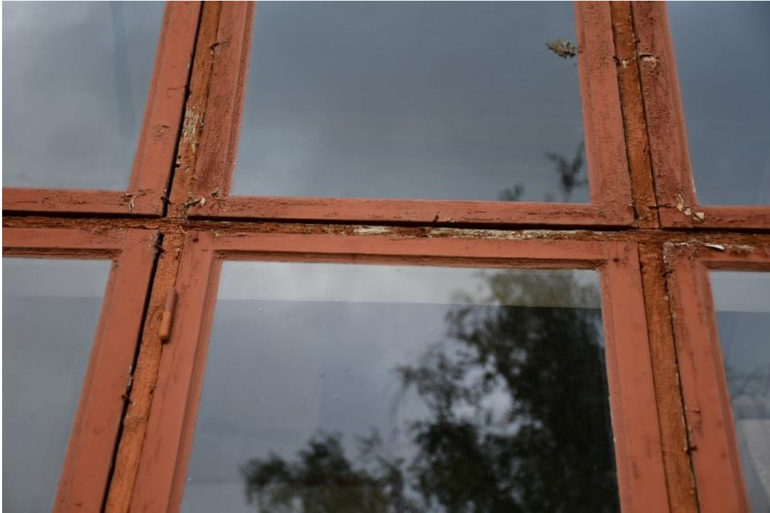
Figur 28 Fönster före åtgärd. Bågarna hade en mer blåröd kulör än karmarna som var målade i en mer röd-brun kulör.
