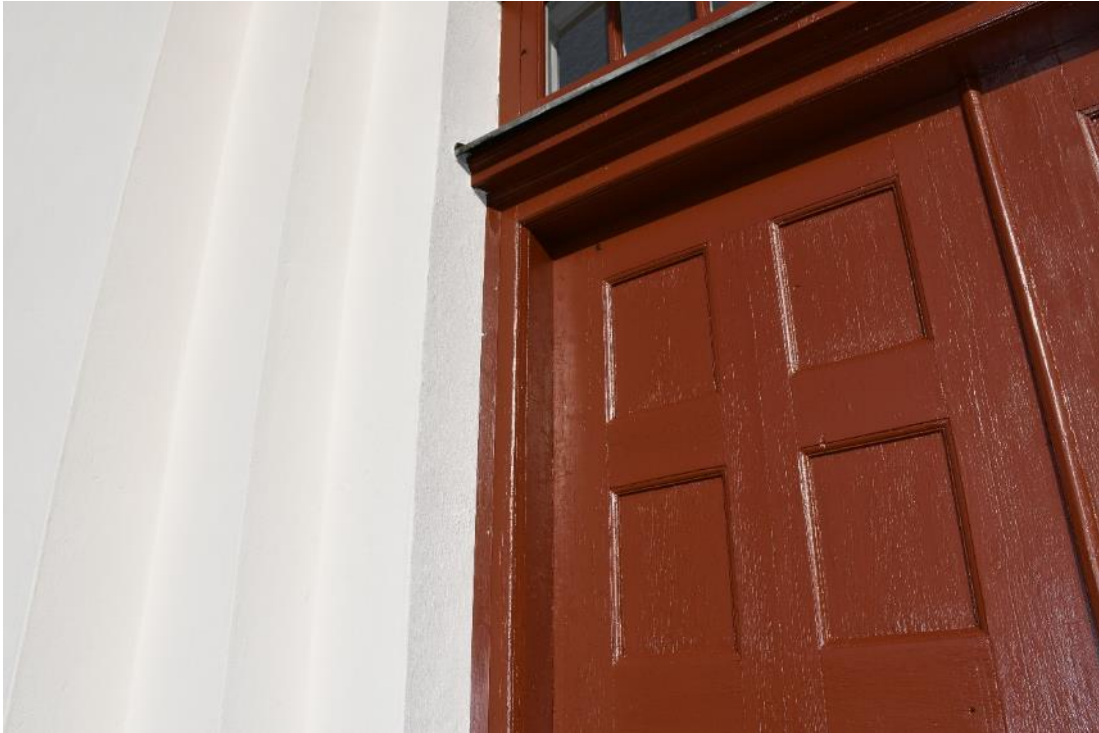
Figur 24 Dörr efter målning. En kvartslist döljer skarven mellan puts och dörrkarm.
