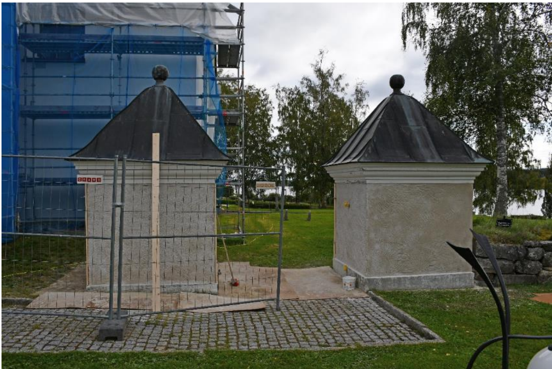
Figur 49 Stigport söder om kyrkan i samband med putsarbeten.
