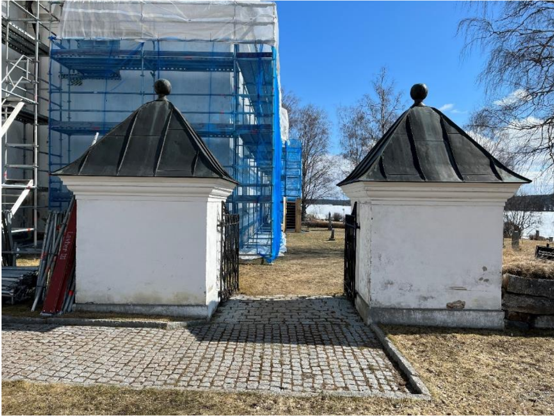
Figur 48 Stigport söder om kyrkan före åtgärd.
