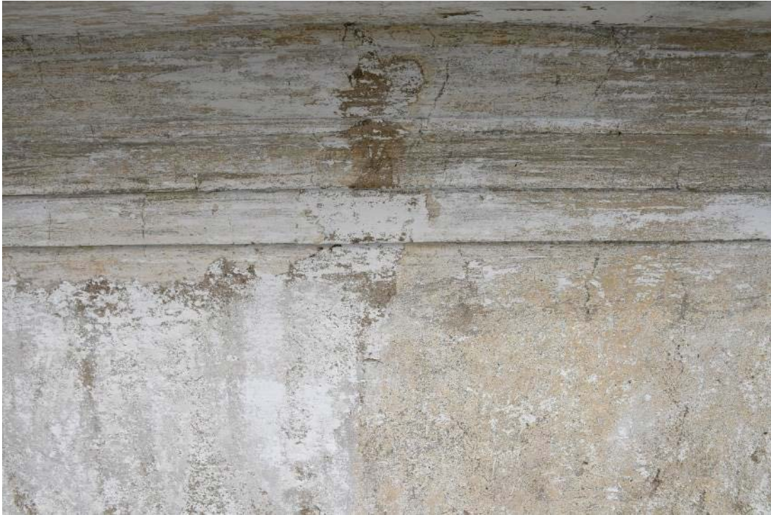
Figur 7 Ytterst fanns en vit kulör, under den spår av en gulvit kulör och en ljusbrun kulör. På taklisten syntes även en ljus gulrosa kulör.
