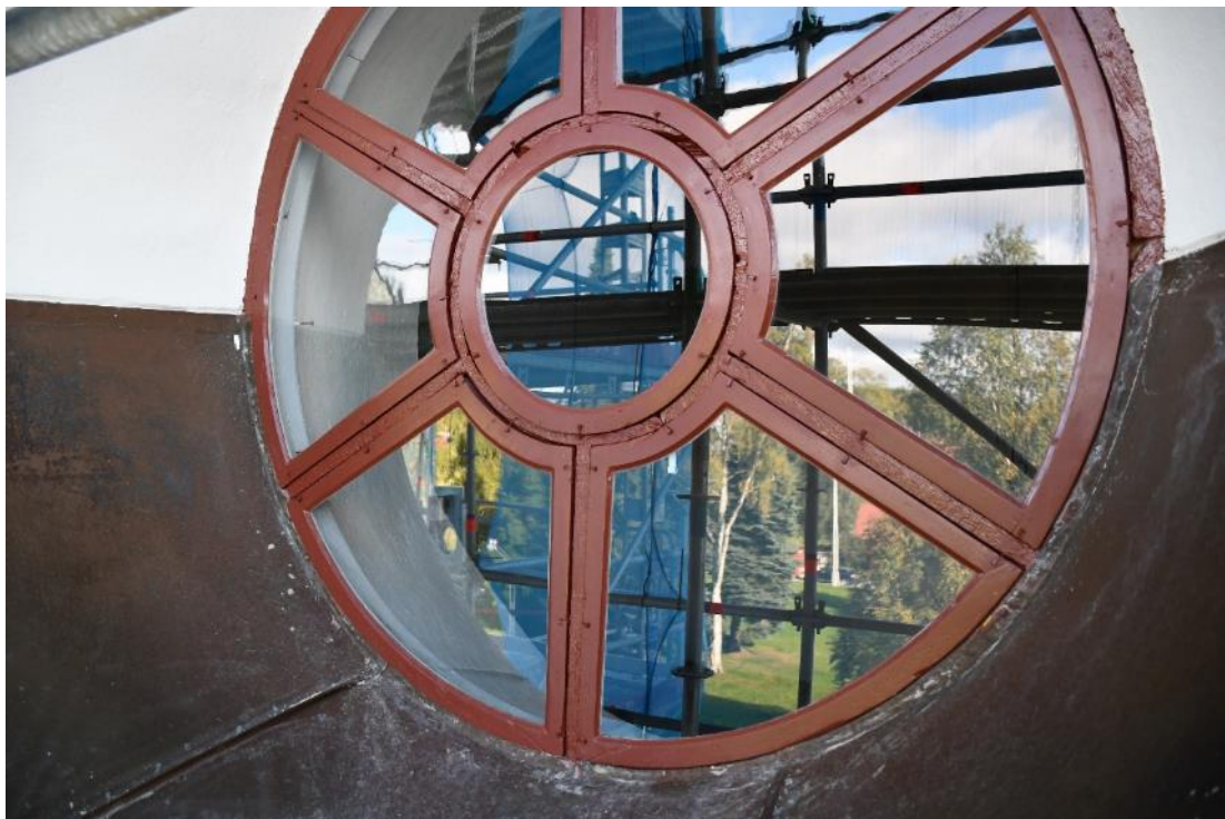
Figur 33 Rundfönster ovanför entrén mot väster, efter åtgärd.
