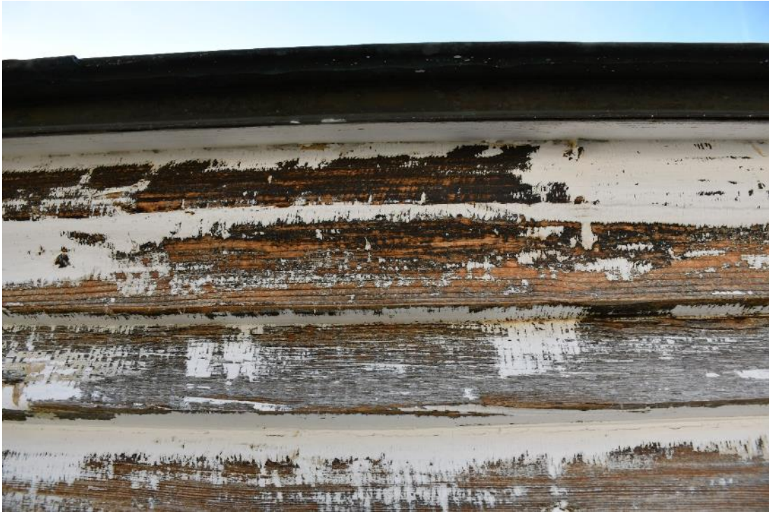
Figur 50 Vid skrapning av taklisten på stolparna, syntes spår av en mörkbrun färg.
