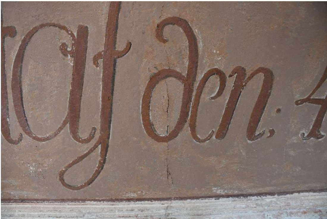
Figur 25 Inskription före åtgärd. På nära håll syntes fina skuggningar på bokstäver och närmast ramen. Tidigare retuscher framträdde med något annan kulör än resten. Färgskikten hade delvis flagat och rakt igenom inskriptionen gick en spricka.
