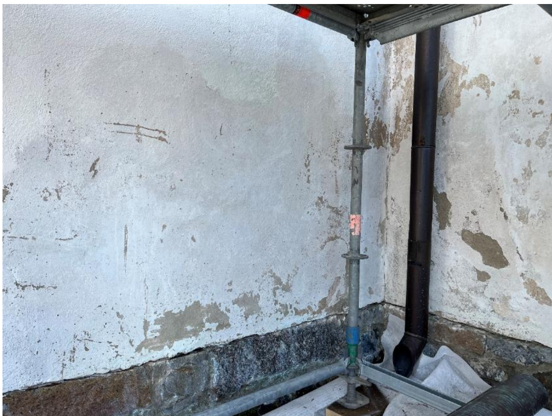
Figur 5 Kalkfärgen har flaggat på vissa partier och kyrkans fasad upplevdes som sliten.
