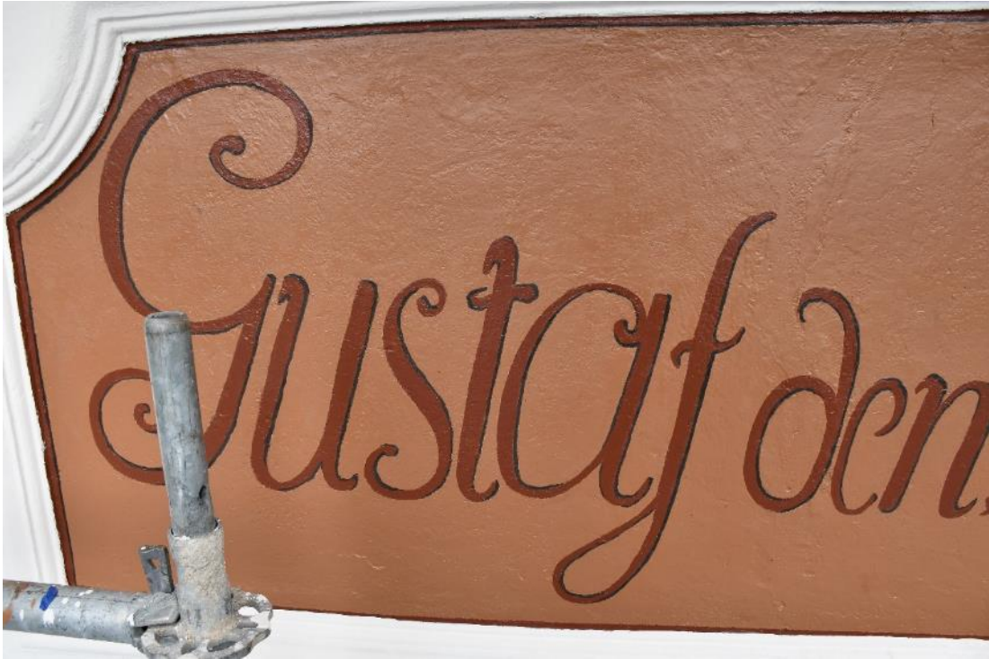
Figur 26 Bakgrund och text är bättrad med linoljefärg av i kulörer lika befinligt.
