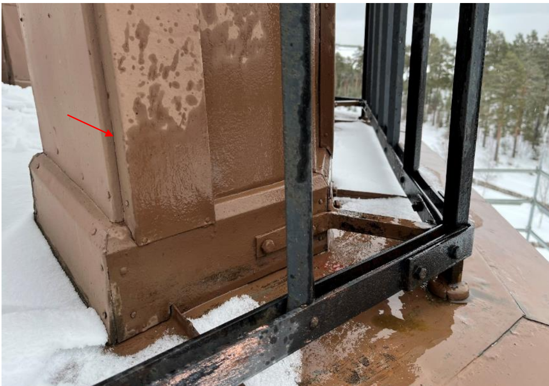
Figur 11 Ner mot golvet satt kring pelarna en plåtklädd golvlister (ca 2,5x13cm) med fasad kant. Pelarna hade urfasningar i hörnen (se pil).
