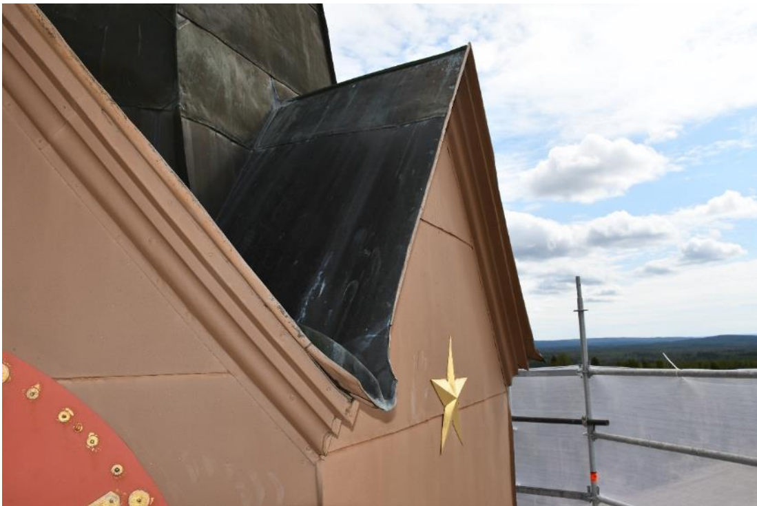
Figur 17 Plåtklädd list i mötet mellan lanterninens plåtbeklädnad och spirans koppartäckning.
