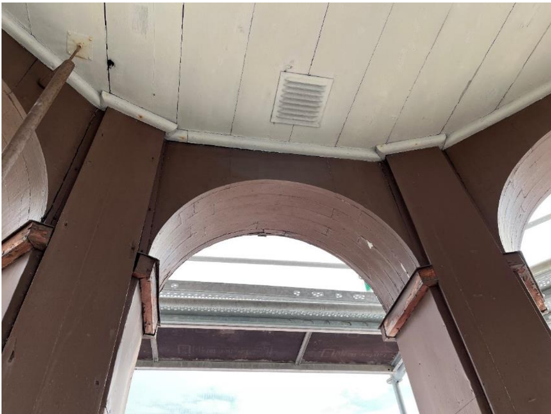
Figur 13 De välvda öppningarna och insidan av lanterninens pelare var målade i samma bruna kulör på trä.
