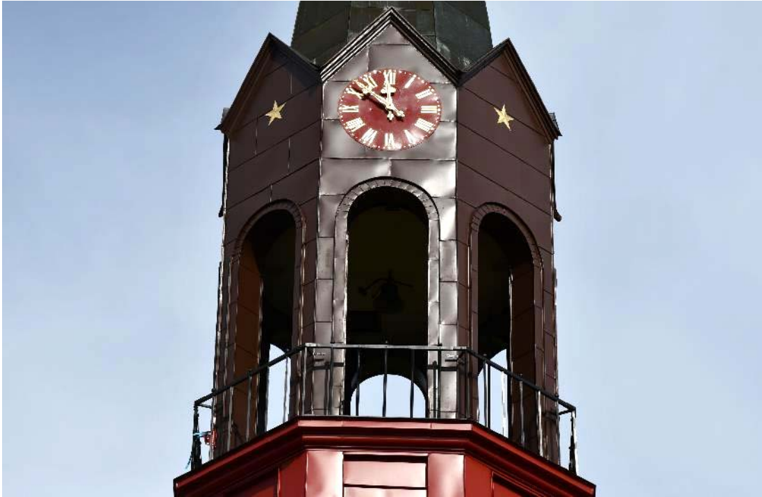
Figur 38 Lanternin efter åtgärd.
