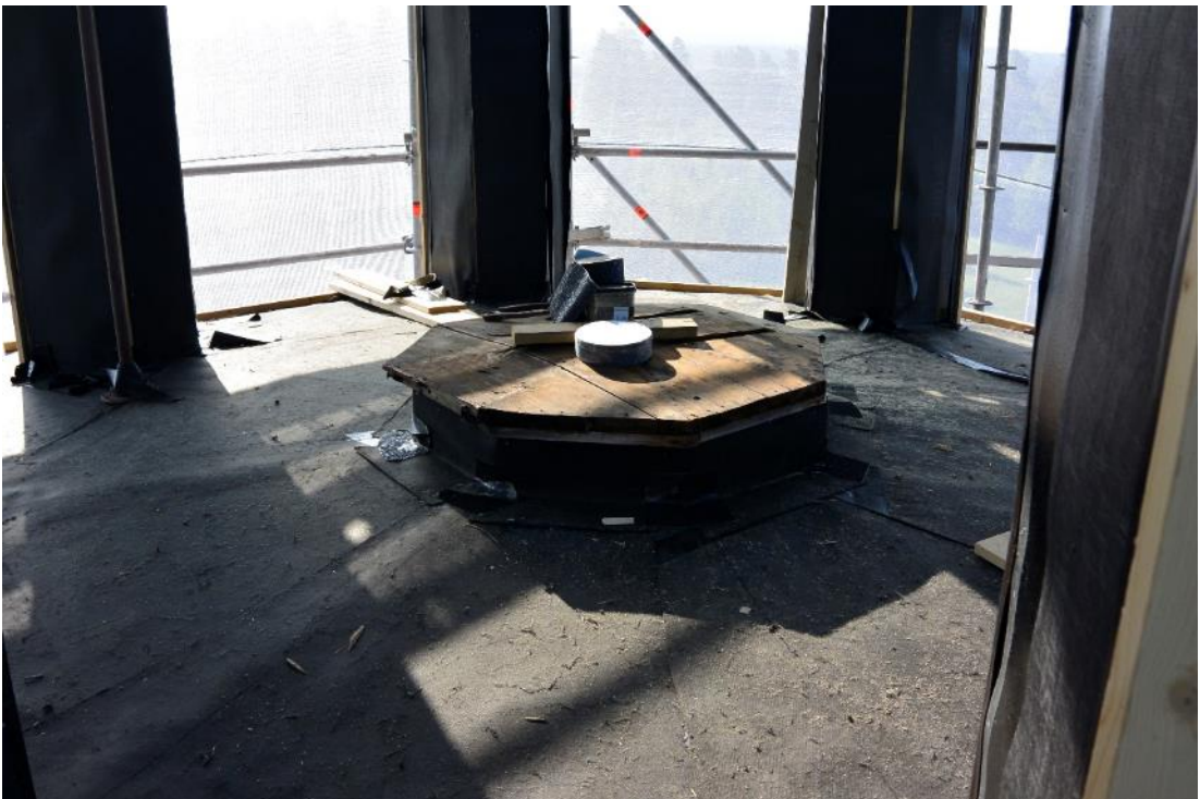
Figur 25 Lanterninens golv efter täckning med papp.
