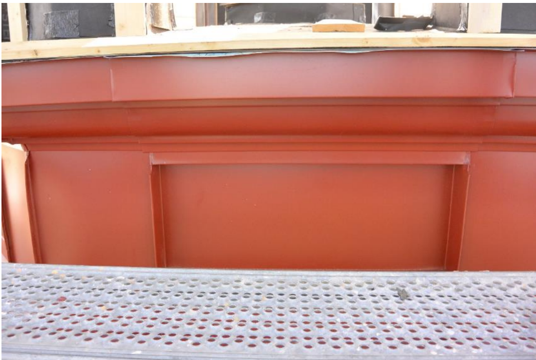
Figur 31 Plåtbeklädning på lanterninens sockel efter åtgärd.
