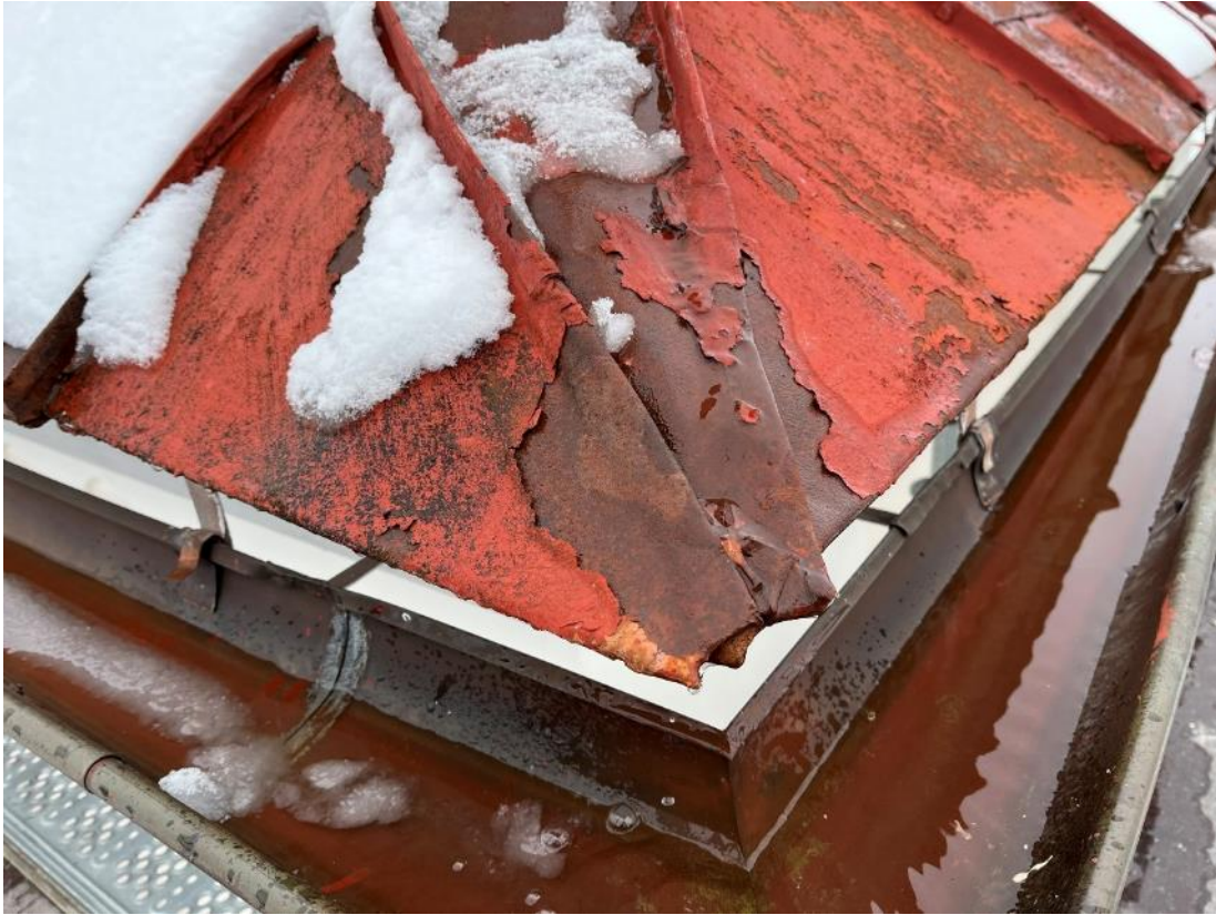
Figur 6 Detalj av tornhuven vid takfoten.
