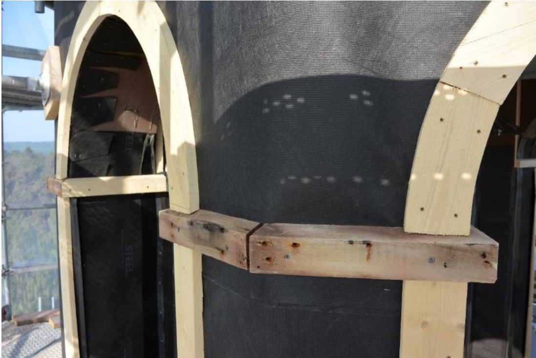
Figur 26 Lanterninen innan den nya plåten monterats. Trälisterna som inramar öppningarna på lanterninen förnyades i samband med åtgärderna.
