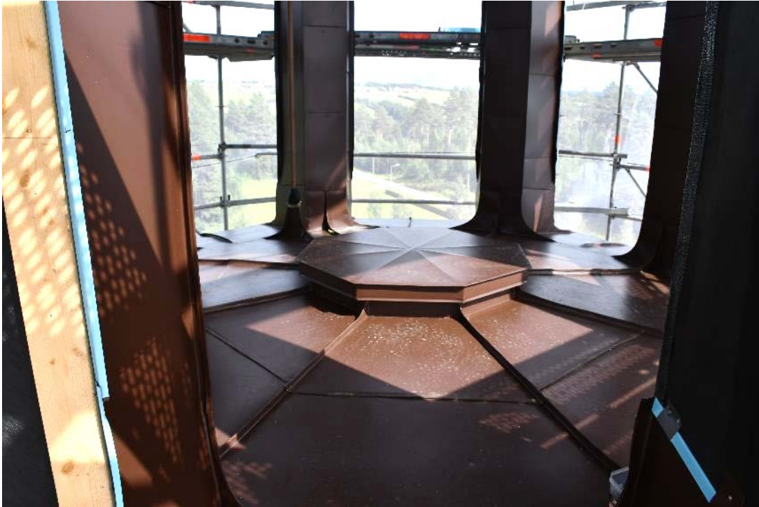
Figur 34 Lanterningolv efter åtgärd.
