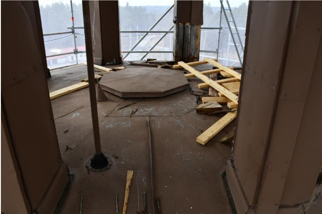
Figur 12 Mitt på lanterningolvet är en åttkantig plåtklädd lucka. Golvet hade en slättäckning med skarvarna strälände ut från luckan i mitten.
