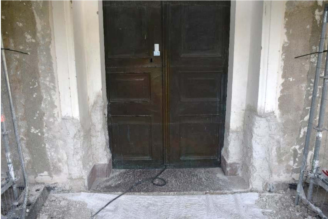
Figur 46 Listverken i puts kring entrén har lagats upp. Till utstockning användes St Astier NHL 3.5 1:2 0-6mm.
