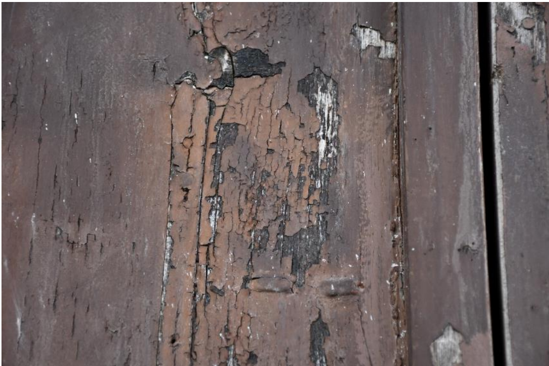
Figur 49 På ljudluckorna fanns ytterst en kraftigt blekt brun kulör. Under den var rester av en något mörkare brun kulör. Längst in fanns spår av ett svart färgskikt.
