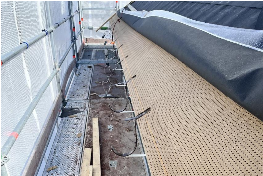
Figur 29 Tornhuven kläddes med masonit innan underlagsduk och plåt.
