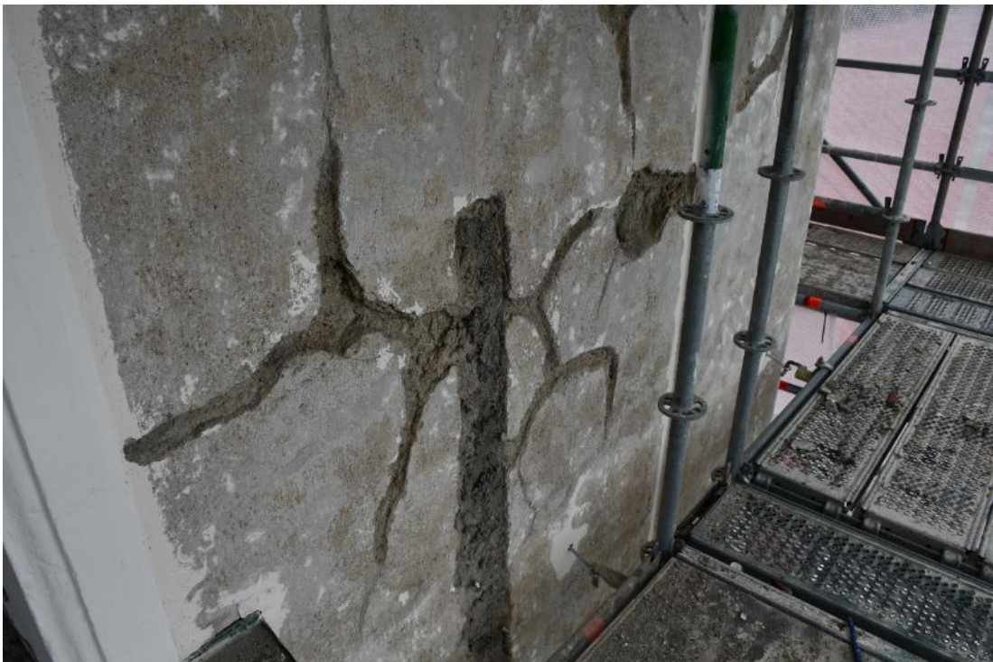
Figur 41 Fasaden efter blästring och renbuggning av skador.
