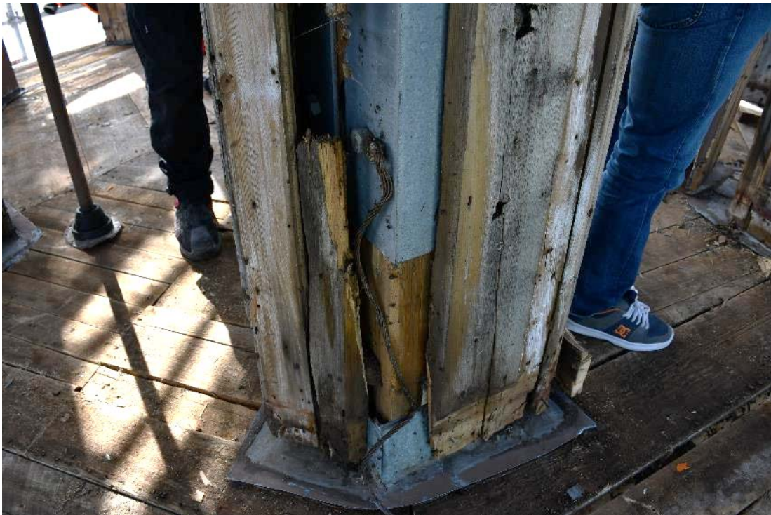
Figur 21 Inuti pelarna fanns förstärkningar i form av stålbalkar.
