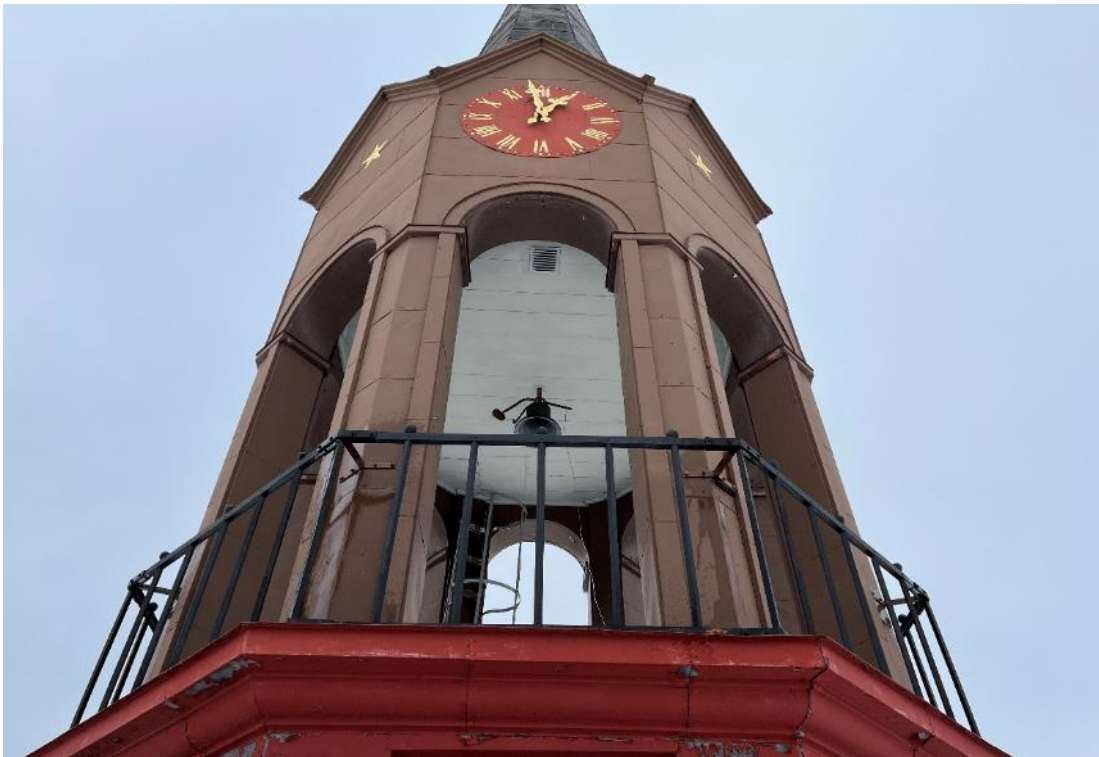
Figur 9 Lanterninens pelare och golv var inklädda med förzinkad stålplåt som platsmålats i en brun kulör. Stående plåtar läg med överlapp utan falsar.
