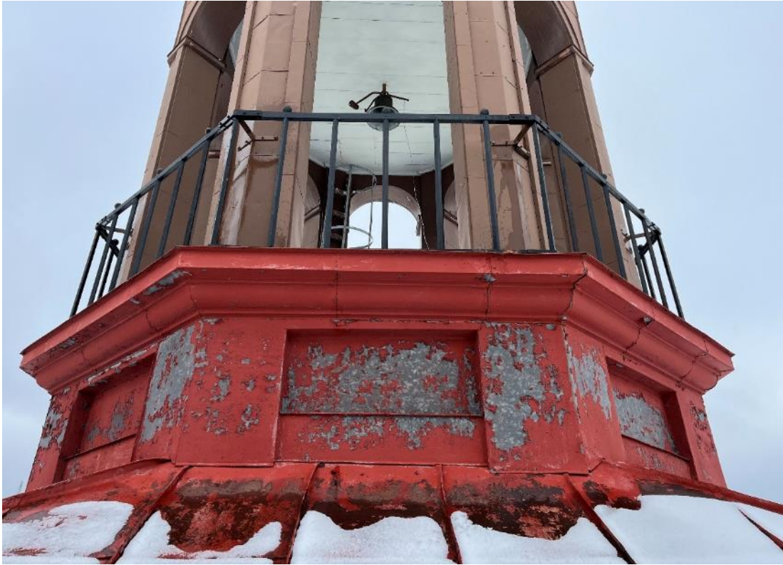
Figur 8 Lanterninens sockel med spegelindelning och profilerad list.
