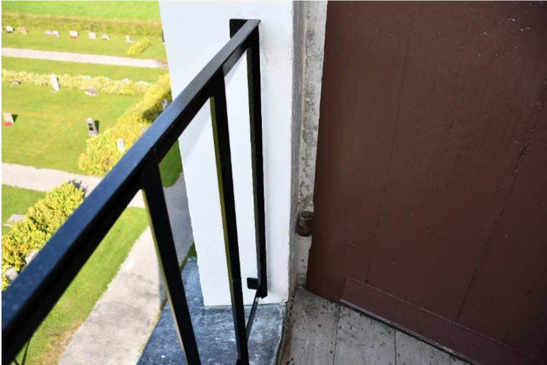
Figur 50 Räckena framför ljudluckorna har målats med rostskyddsfärg i svart kulör.
