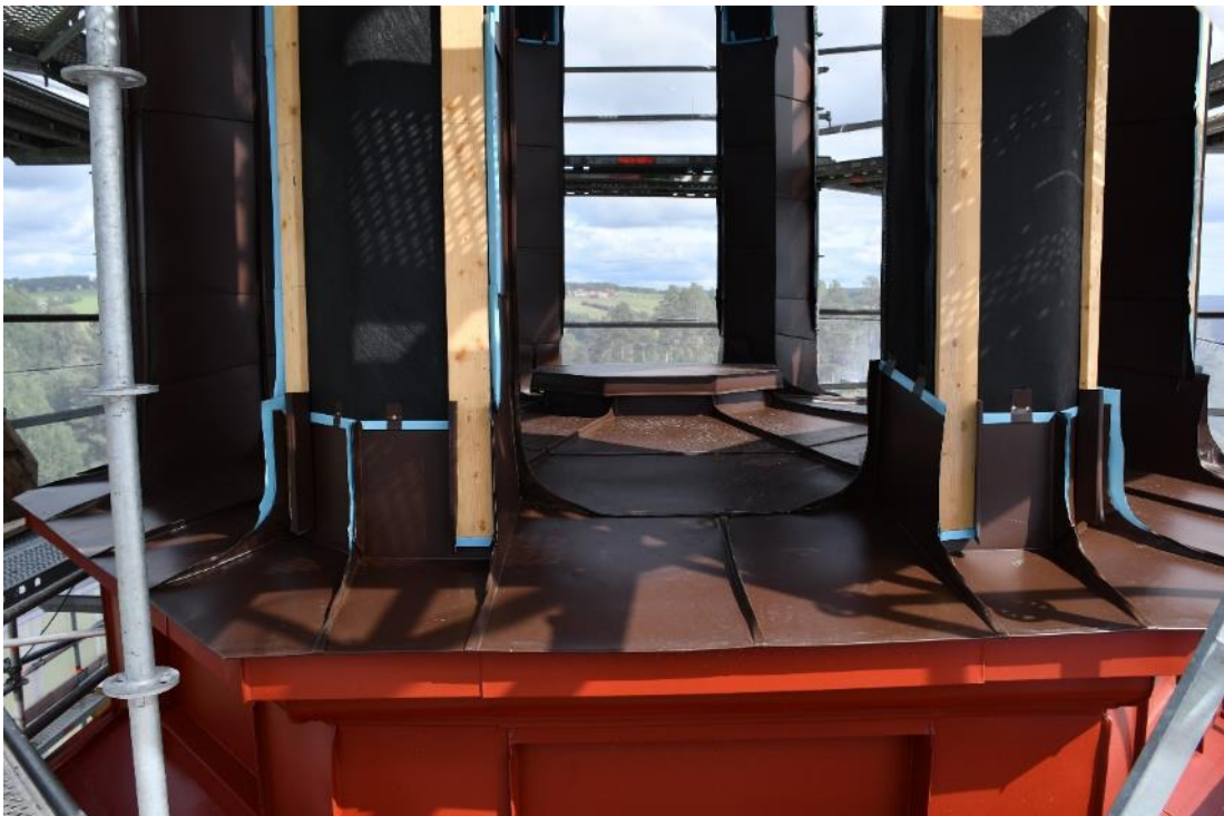
Figur 33 Den nya plåten på plats upp till lanterningolvet.
