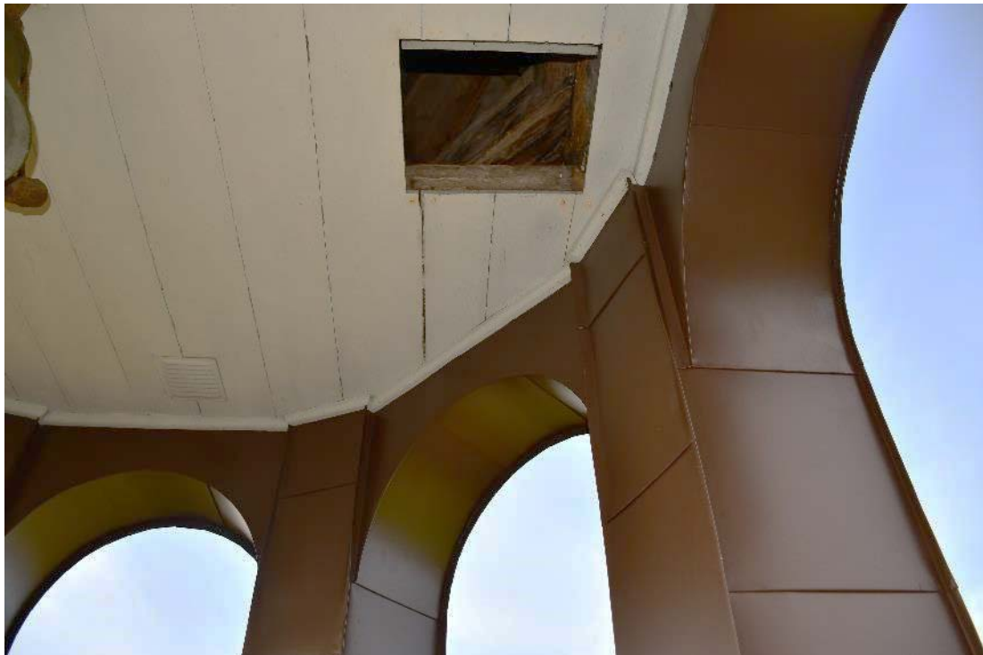
Figur 37 Plåtbeklädnad i lanterninen efter åtgärd. Den horisontella listen nedanför rundningen på öppningarna som satt på plats innan plåtbeklädnaden (se figur 26-27) var borta efter åtgärd.
