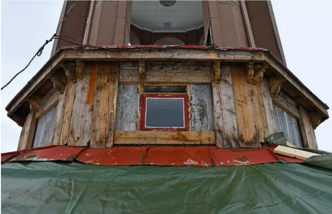
Figur 18 Fältindelningen på sockeln till lanterninen består av omålade brädstumpar som spikats som ramar på en slät bas som har spår av vit färg.
