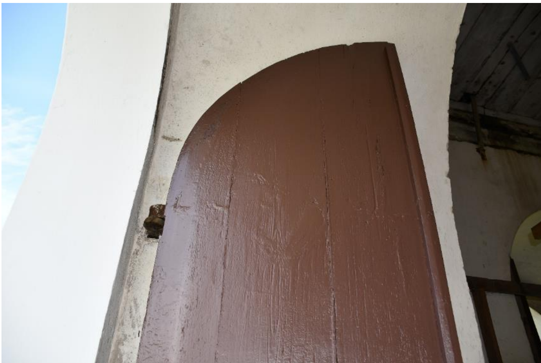
Figur 51 Ljudluckorna har målats i en brun kulör lika tidigare med linoljefärg.
