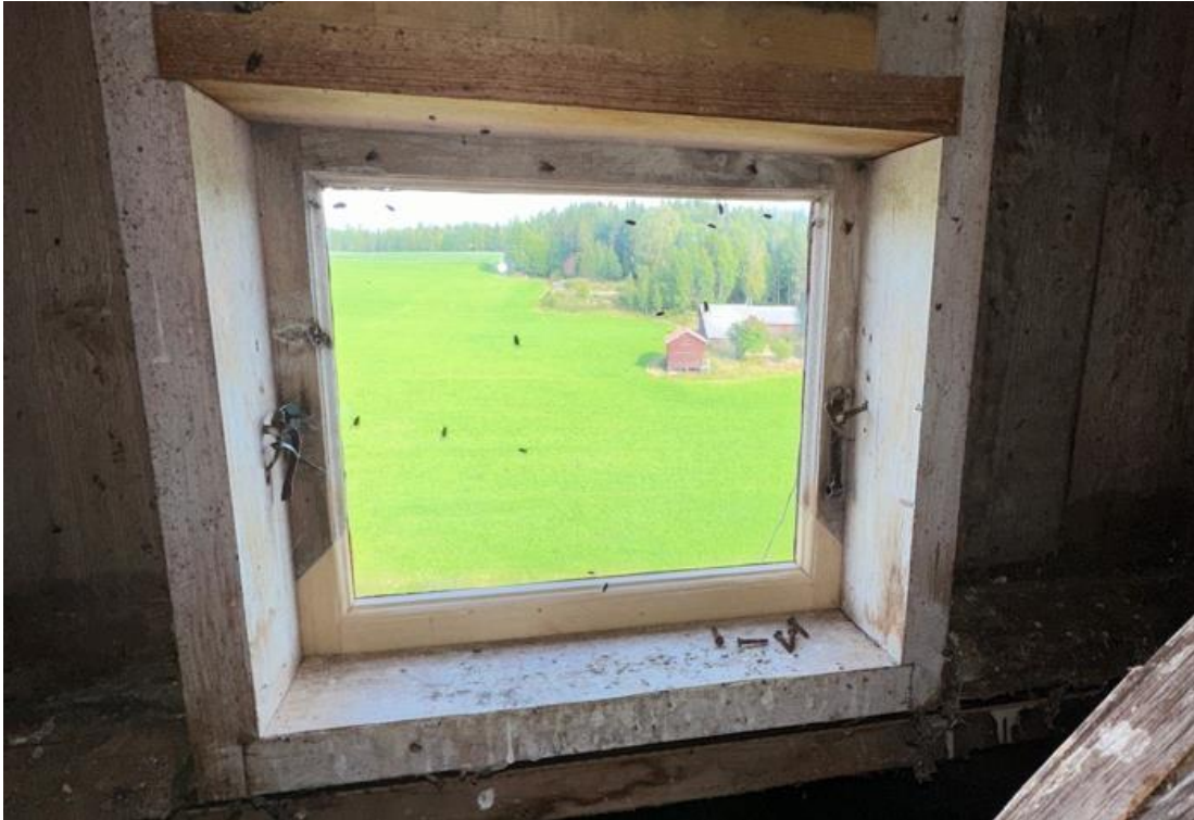
Figur 32 På det lilla fönstret på lanterninens sockel, har understycket på bågen bytts ut. Sidostyckena är skarvade en bit upp (Foto: Winther Bygg AB).
