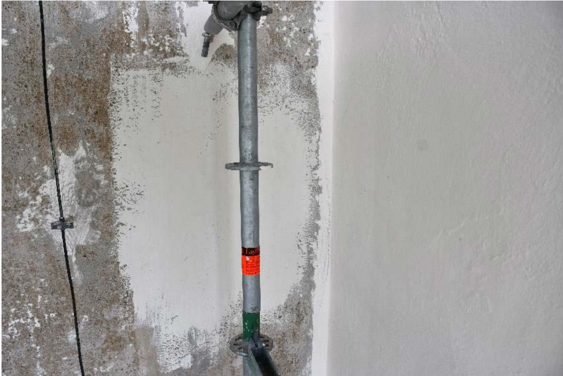
Figur 42 Uppstrykningsprov på tornfasaden.
