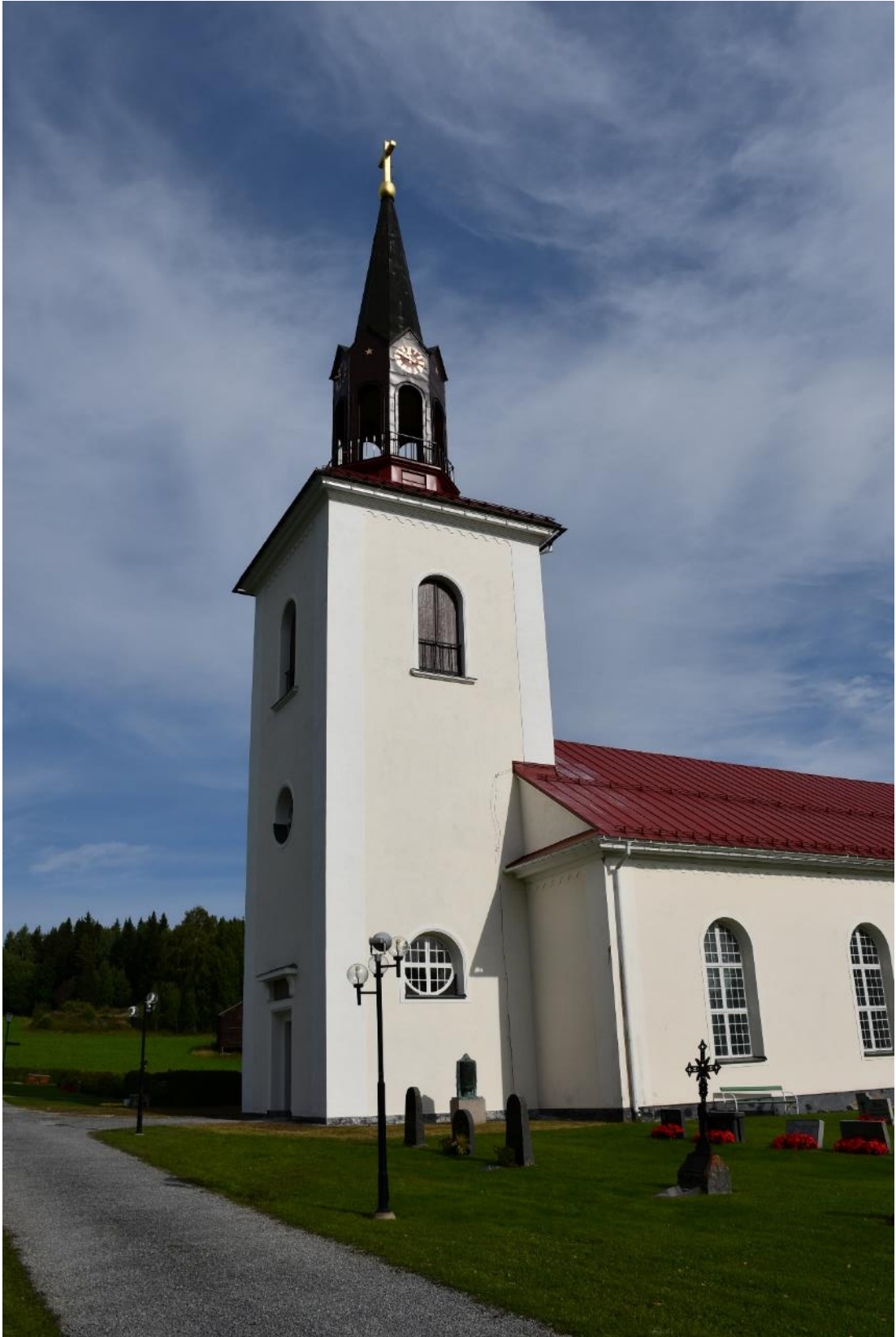
Figur 52 Tornet på Häggenås kyrka efter åtgärd.
