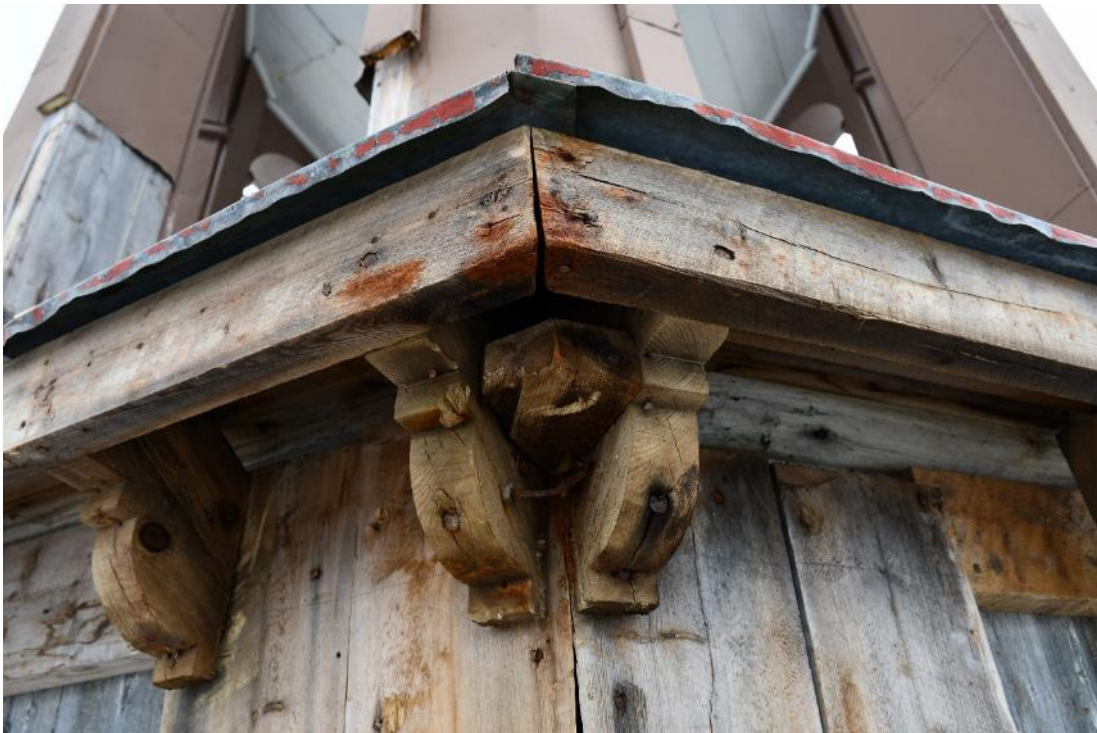
Figur 19 Konsoler i trä utgör grunden för det profilerade listverket. Innanför konsolerna återfinns en vitmålad, mindre taklist.
