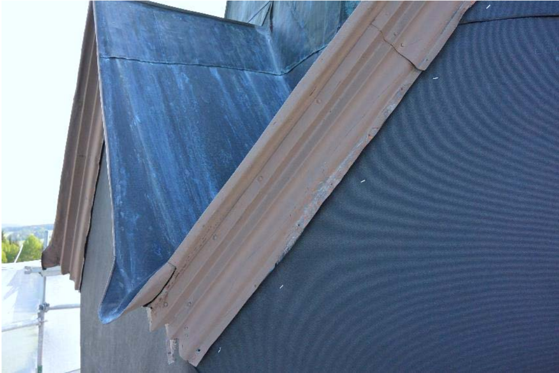
Figur 28 Längst upp mot lanterninens tak kom den gamla profilerade plåtlisten att bli kvar.
