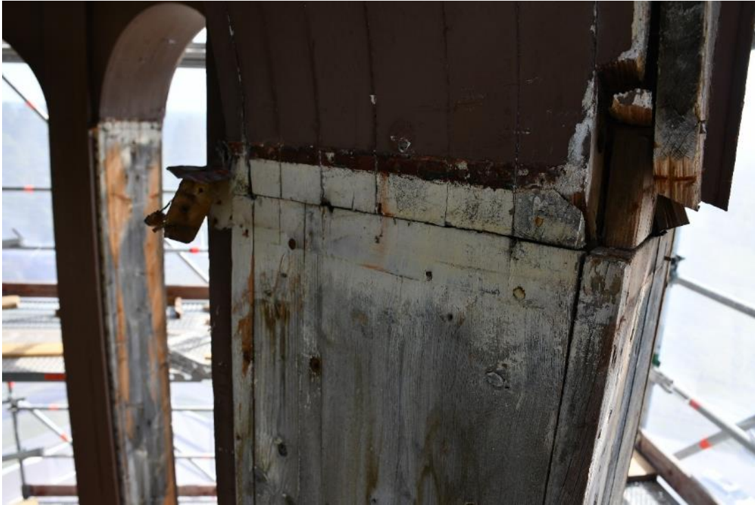
Figur 22 Under plåten på lanterninens pelare framträdde en gulvit kulör på trästommen (ungefär motsvarande NCS S 0907-G90Y).
