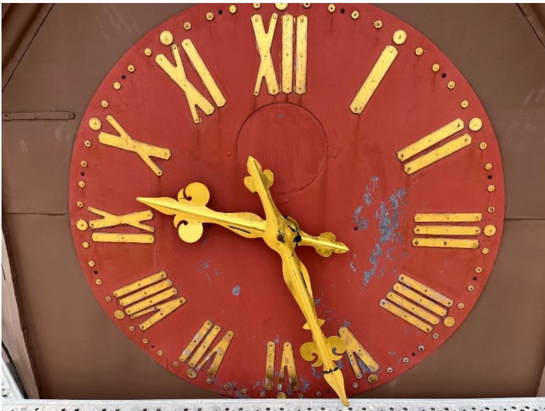
Figur 15 Urtavlornas färglager var före åtgärd slitna och plåten tittade fram. Förgyllningen på urtavloras nummer, visare och stjärnorna var sliten.
