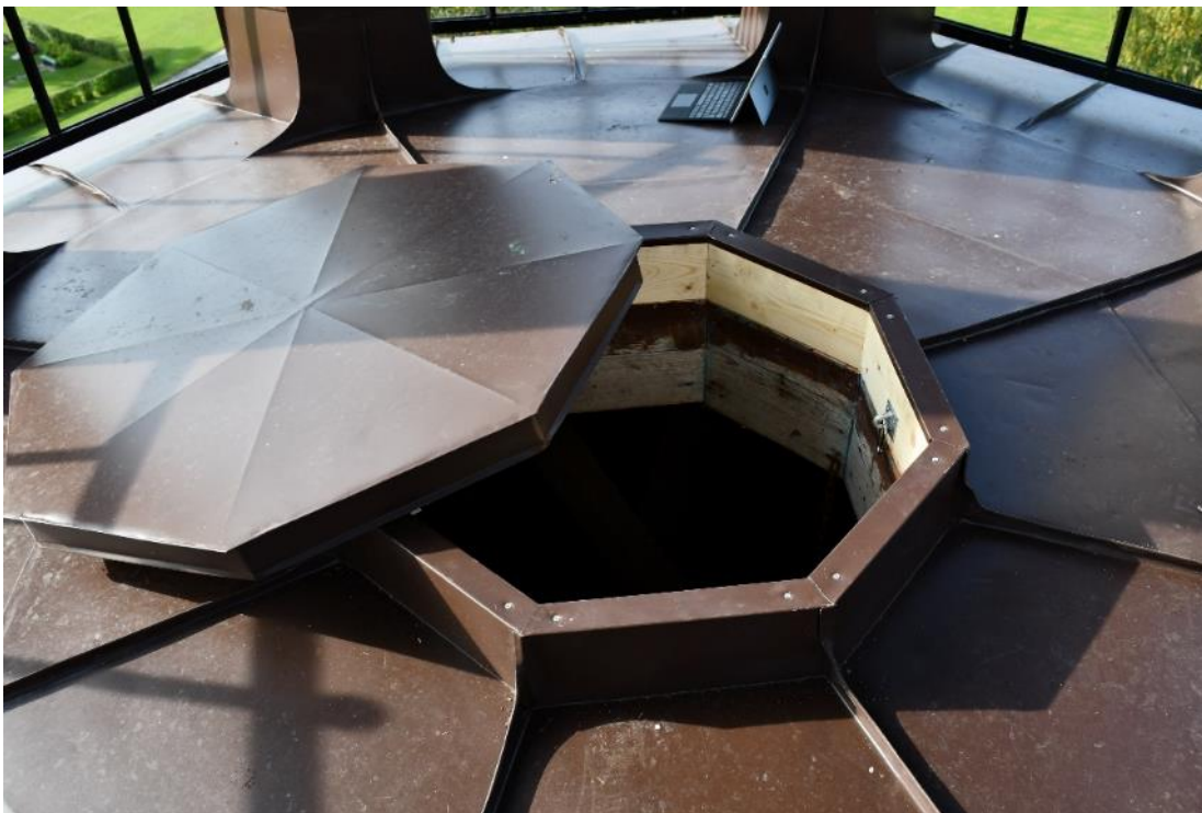
Figur 35 Kring luckan i golvet, har befintlig sarg byggts på.
