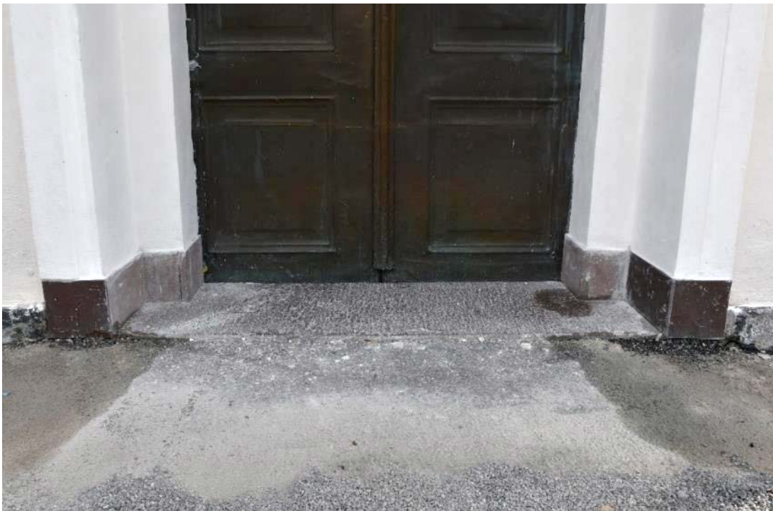
Figur 47 Saknad kalksten har ersatts med ny röd kalksten, en sektion på norra och två på södra sidan om entrédörren.
