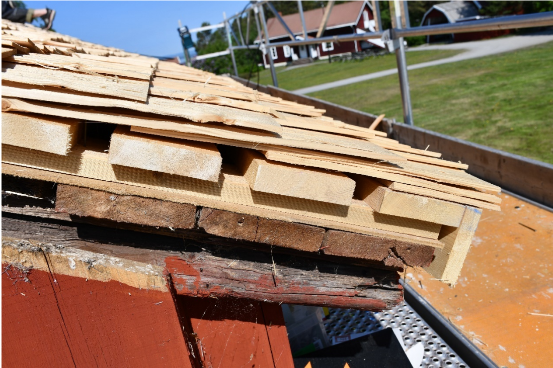
Figur 8 Tillkommande strökläkt och bärläkt har byggts på taket.
