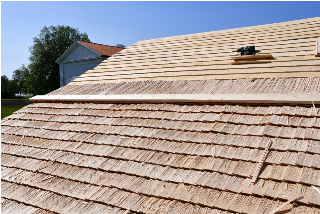
Figur 9 Taket under pågående spåntäckning.
