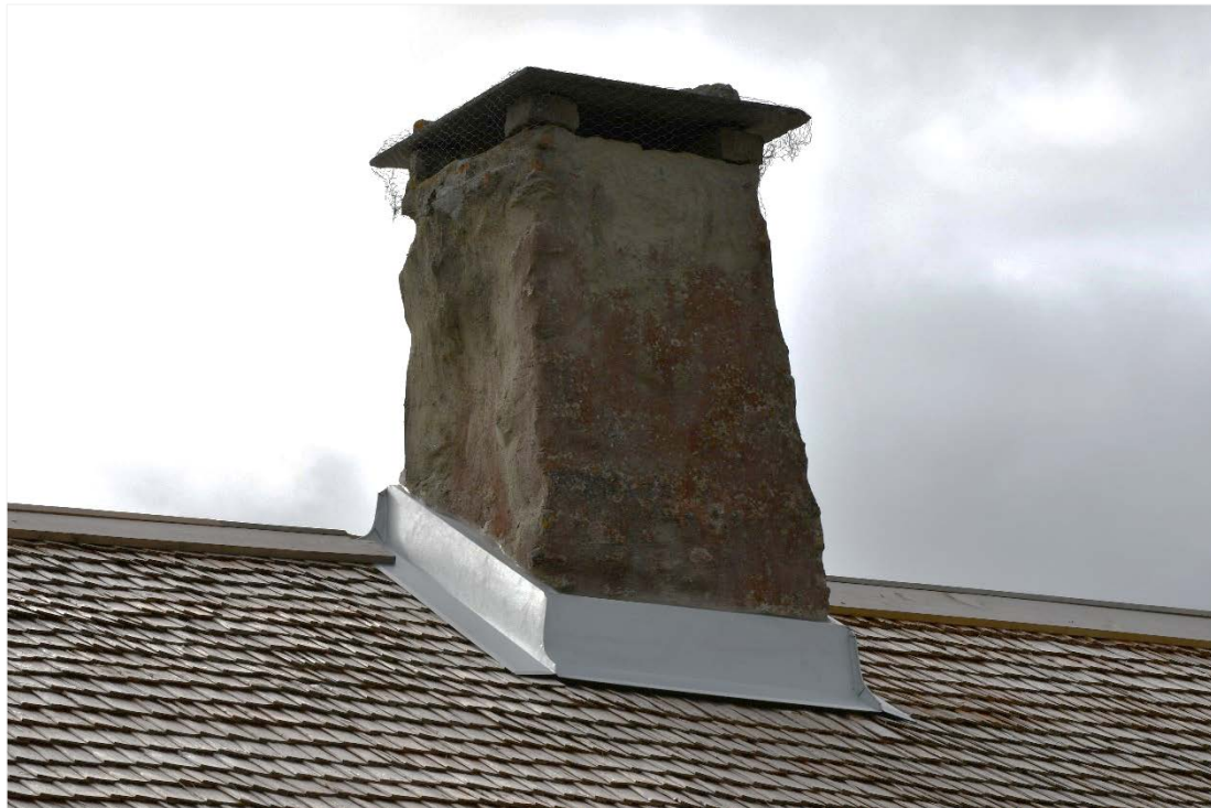
Figur 13 Ovanpå spåntäckningen har ett nytt överbeslag monterats.
