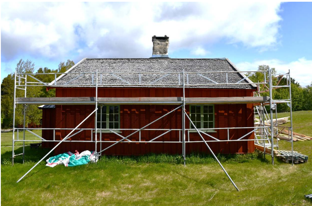
Figur 3 Taket efter att plåten plockats bort.
