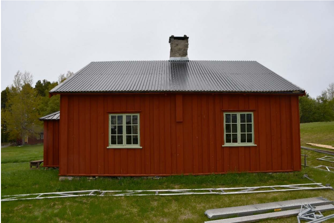
Figur 2 Collegabostaden med provisoriskt plåttak från 2019.
