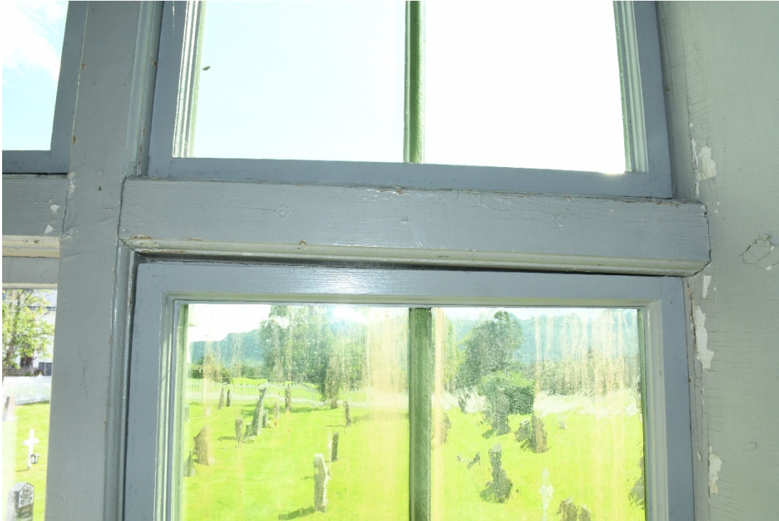
Figur 10 Man har tidigare hyvlat på bågarna för att anpassa dessa till den lutande karmen i fönster nr 3.
