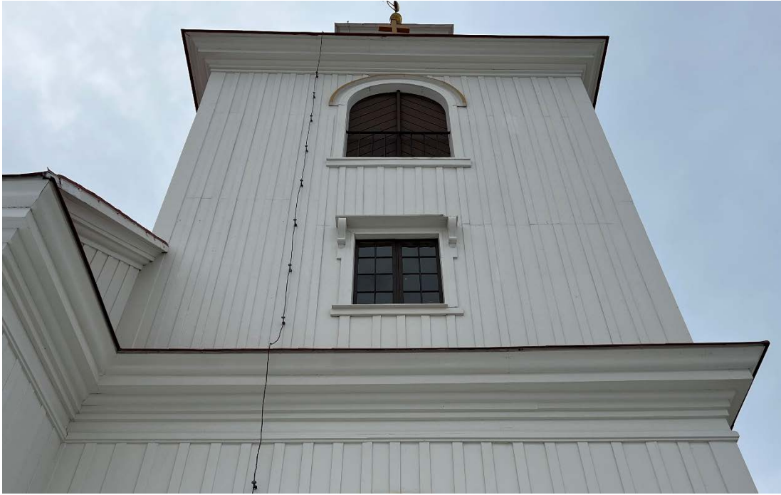
Figur 18 Tornfönster efter åtgärd.
