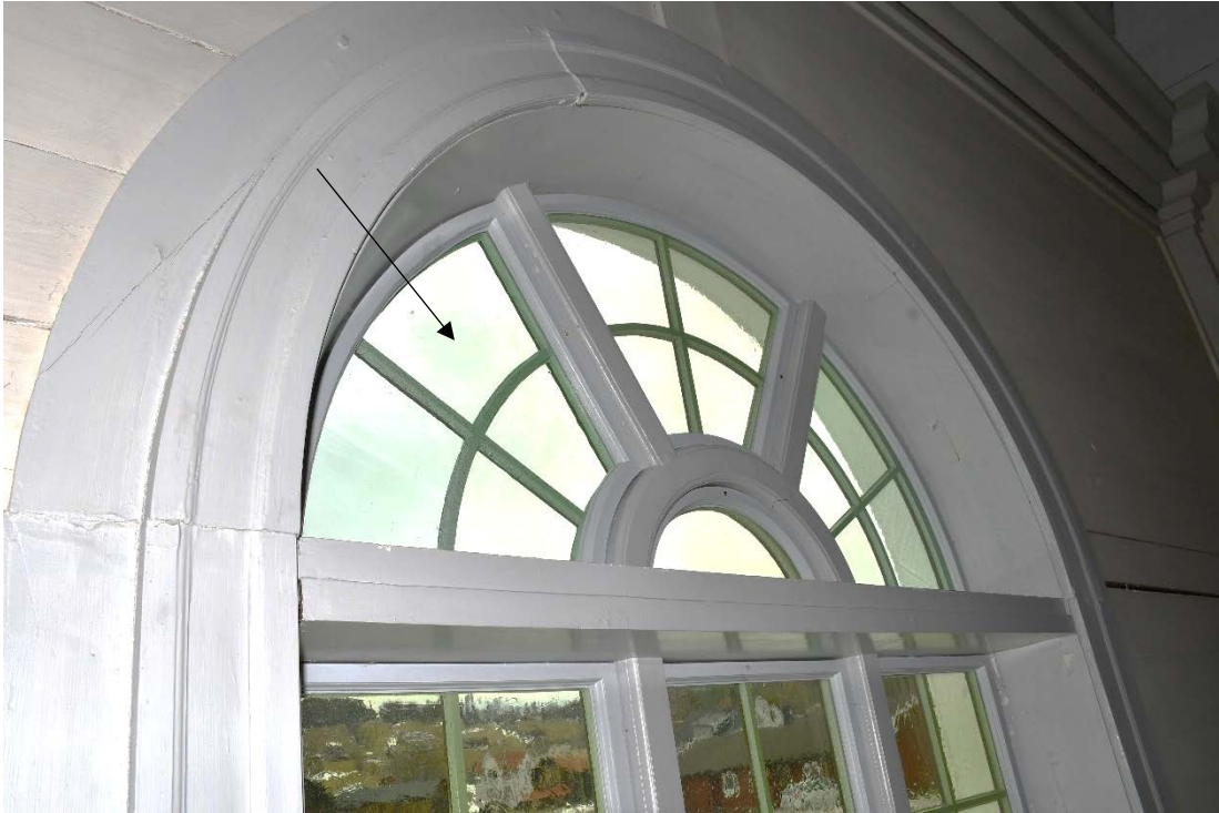
Figur 12 Fönster nr 7 efter att den nya bågen kommit på plats.
