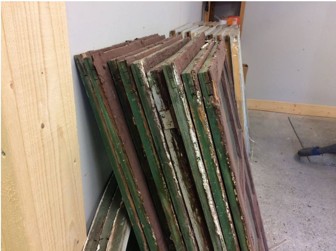
Figur 5 Bågar i verkstaden. Notera den gröna kulören.
