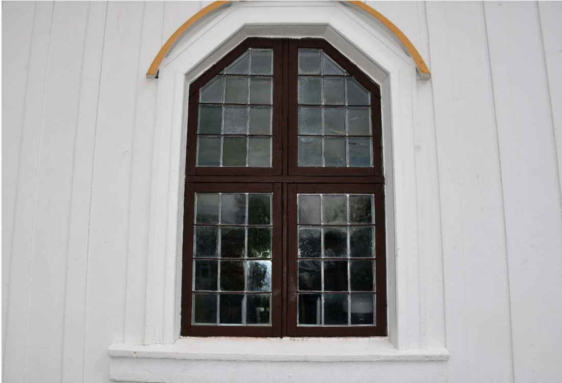
Figur 16 Fönster på sakristian efter åtgärd.
