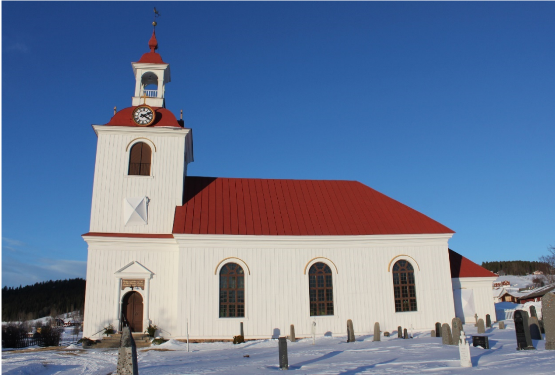
Figur 2 Klövsjö kyrka, fönstren i torn och sakristia har plockats ned för åtgärd.
