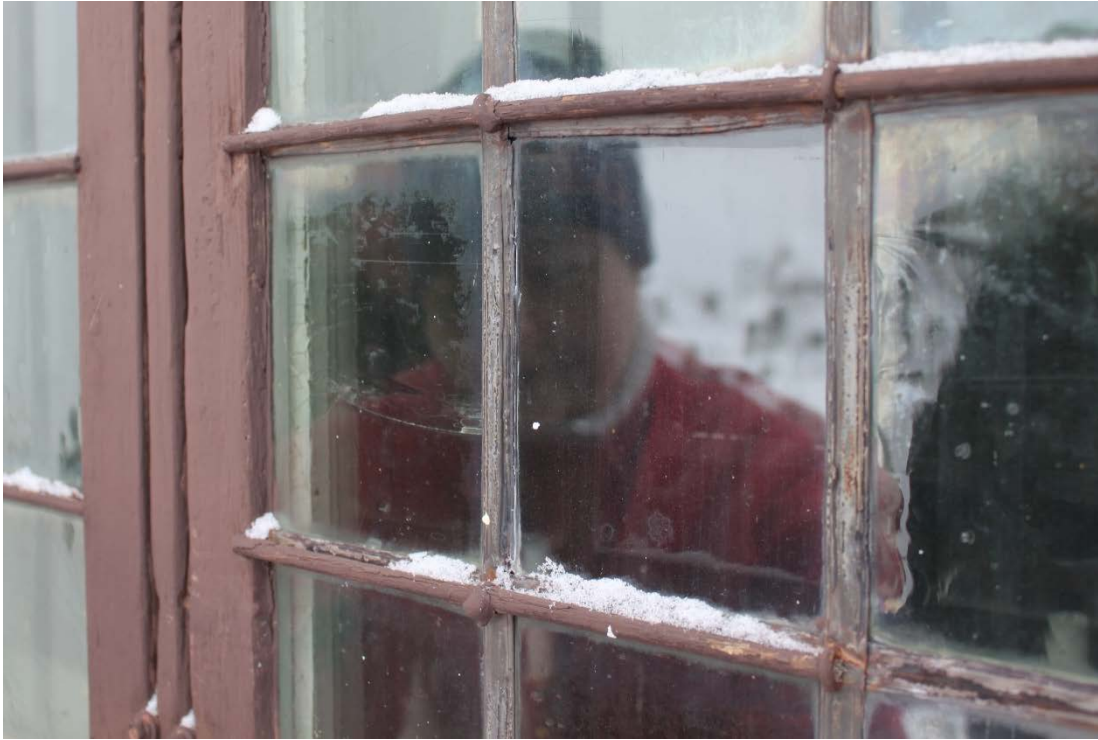
Figur 14 "Stormjärnen" i trä hade delvis ramlat bort.
