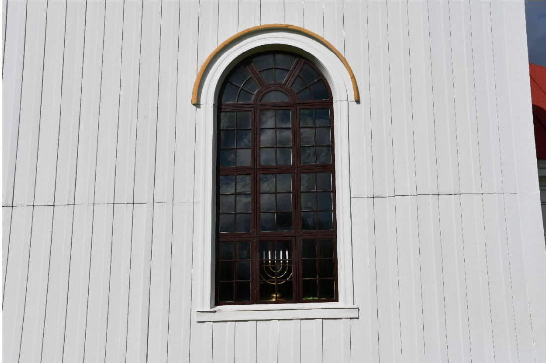
Figur 8 Fönster nr 3 på södra långsidan efter åtgärd.
