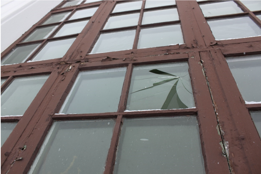
Figur 4 Den blekta färgen flagade delvis. En del trasiga rutor förekom innan åtgärd.
