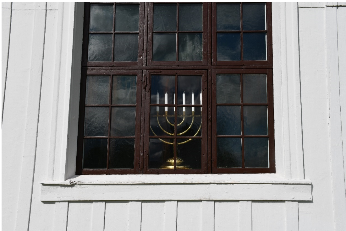
Figur 9 Närbild på fönster nr 3 efter åtgärd.
