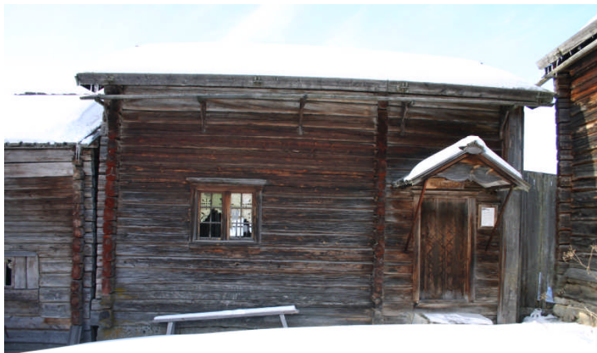
Lillstugan, byggnad II. Mellan huvudbyggnaden och lillstugan finns ett plank.
