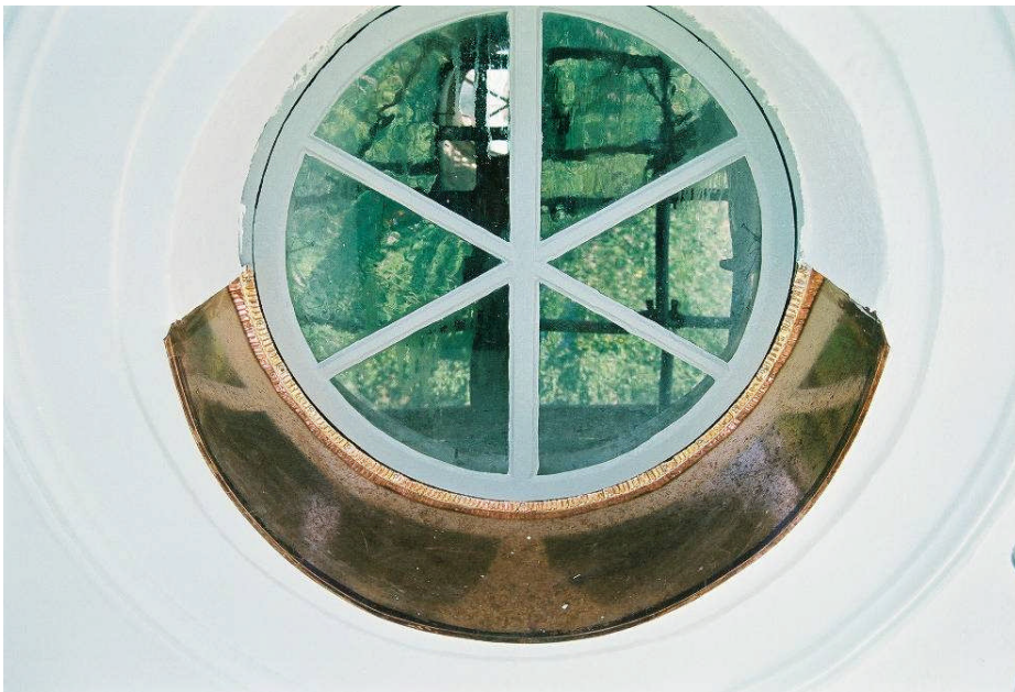
Bild 11. Ett av tornfönstren efter omputsning, ommålning och utbyte av fönsterblecket till kopparplåt (JLM07M053/29).
