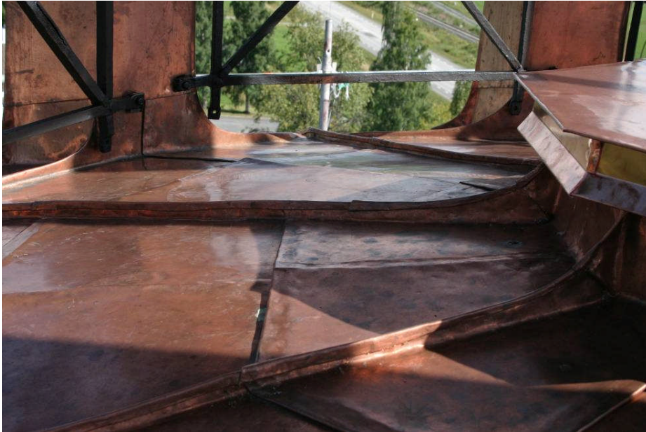
Bild 8. Plåtlagningen på golvet i lanterninen (digital bild pict 9796).
