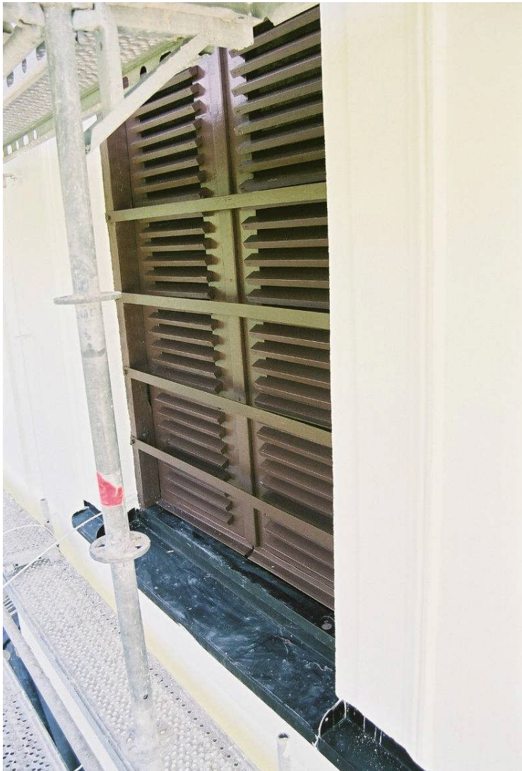
Bild 13. Ljudlucka efter ommålning och komplettering av ribbor (JLM07M053/24).
