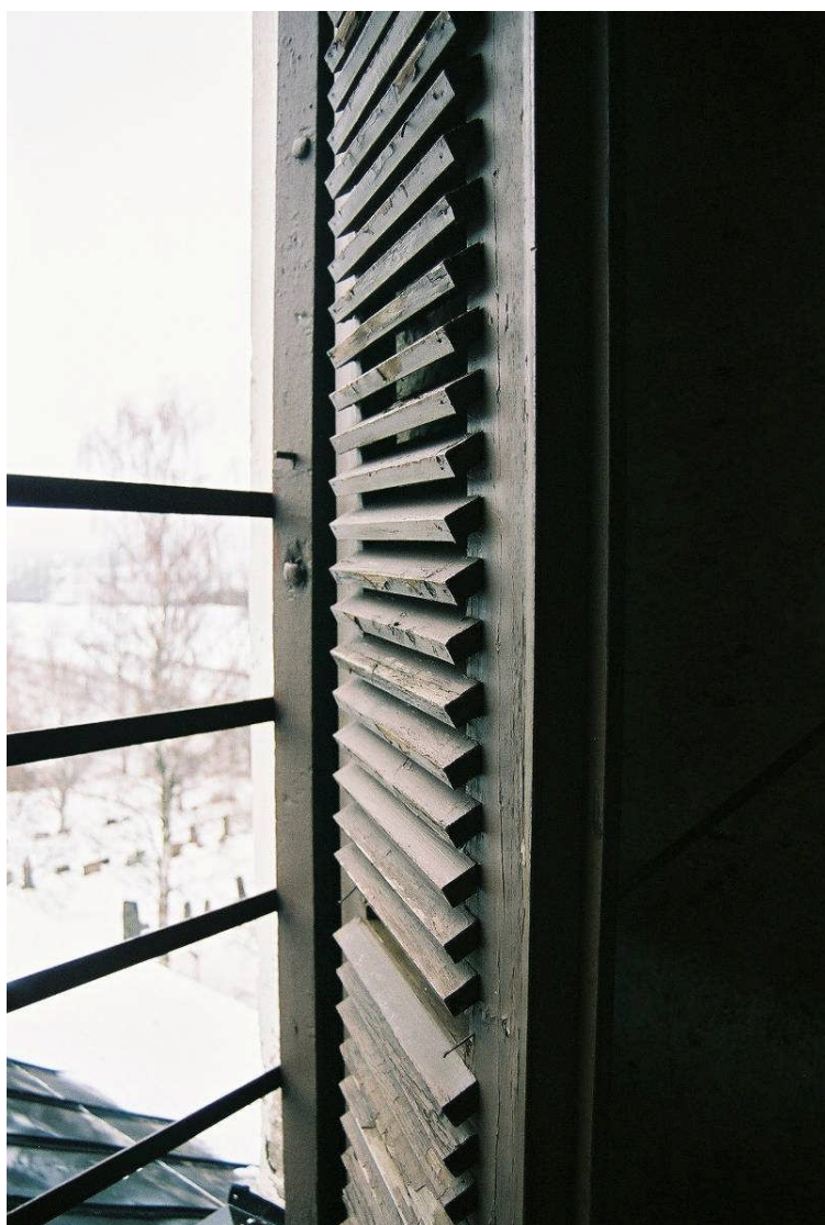
Bild 12. En av ljudluckorna mot öster som var i mycket dåligt skick (JLM06M086/26).
