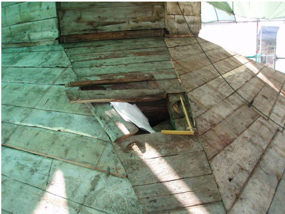
Bild 9. Träilagningar vid tornets nordvästra sida (digital bild pict 5070020).
