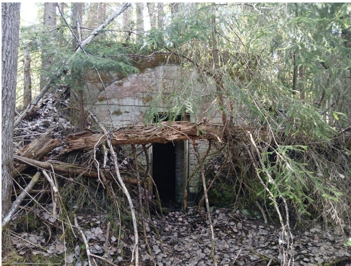
Figur 4. Ett av ammunitionsförråden inom lämning L2025:5613 (område med militära anläggningar). Foto: Anna Engman.
