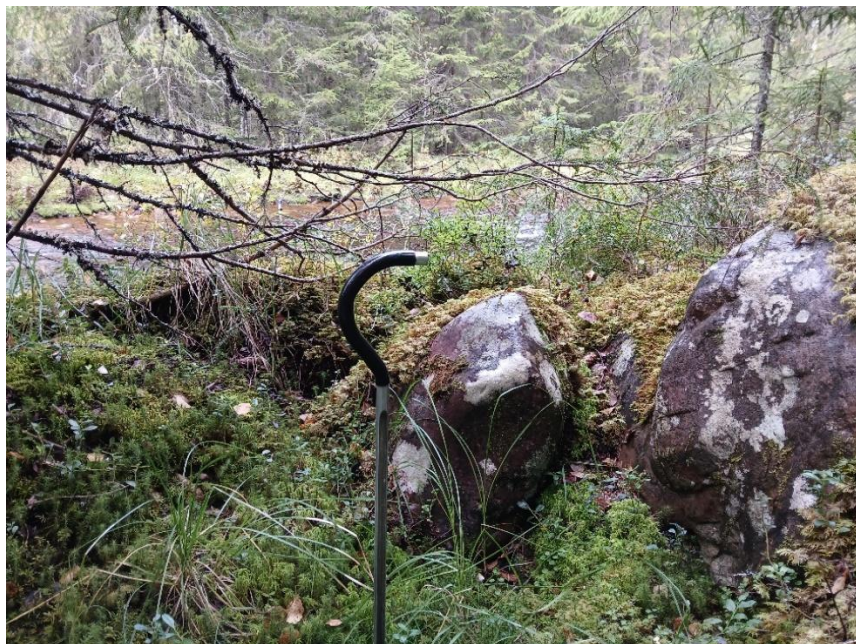
L2025:5620. Flottningsanläggning. Ledarm. Bild tagen mot V.
