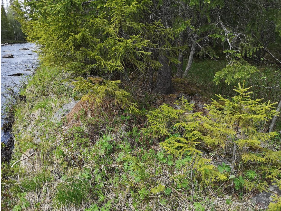
L2025:3563 Flottningsanläggning. Bild tagen mot NV.
