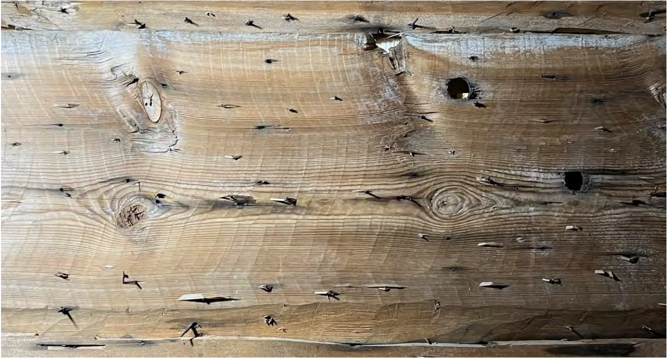
Fig. 69. Sprättäljningen på undersidorna är skickligt utförd. Här har den okände timmermannen växlat huggriktningar med sin yxa för att bemästra några kvistar och få till en så plan yta som möjligt. De täljda ytorna är så släta och lena att man kan dra med fingret längs fiberriktningen utan att riskera att få stickor. Fasningen i nederkanten är gjord i samband med återbrukandet av brädan på 1520-talet. En likadan fasning är gjord i övre kanten, mot utsidan. En del av den övre kanten är ändå bevarad och, som synes, spikrak. N19 T2–T4. Bredd: ca 38 cm.
