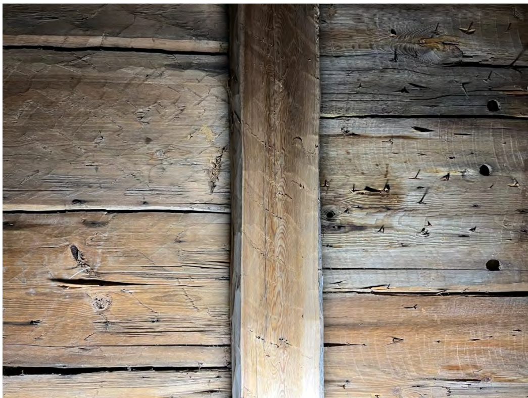
Fig. 3. 1500-talsbrädor som bilats tvärs fibrerna och 1100-talsbrädor som sprättäljts, här monterade på samma takstol. Bilden återkommer i kapitlet "En stavkyrka i Marby". Foto: OH.
