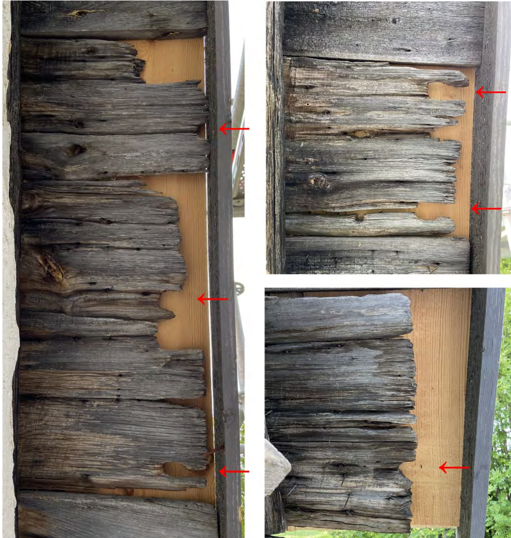
Fig. 85 a-c. Före detta plugghål i ändarna på återanvända undertaksbrädor, synliga innanför vindskivan i nordost på Marby gamla kyrka. Vittringen är här främst orsakad av att brädändarna har suttit fria i gavelsprånget sedan 1520-talet, tidvis utan någon skyddande vindskiva (jfr med de gamla foton fig. 61 och 66). T.v.: brädorna N11, N10 och N9. T.h., upptill: N6; nedtill: N1. Pilar markerar plugghål bedömda som säkra. Foton: OH.
