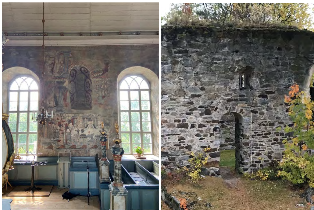
Fig. 11 a–b. Romanska fönster mot söder i Hackås kyrka (t.v., igensatt) och i Sunne kyrkoruin (t.h., från utsidan). Fönstren har haft/har smygar både utåt och inåt. Tumstocken på det senare fotot är 3 m hög. Foton: OH.
