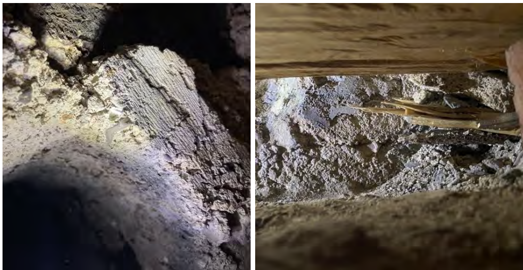
Fig. 25 a–b. Avtryck i murbruket av årsringar i ursprungligt byggnadsvirke i Frösö kyrka. T.v. norra högbenet i korets gaveltakstol mot triumfbågsmuren, intill ett hål efter en ställningsbom. T.h. norra yttre remstycket i koret. Upp till på denna bild ses det nuvarande remstycket, som är lagt ovanpå tegelstenar. Foton: OH.
