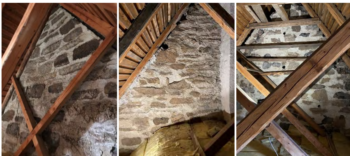
Fig. 17 a–c. Murpartier i korets gavelröste mot öster (t.v.), långhusets gavelröste mot öster (mitten) och långhusets nuvarande gavelröste mot väster (t.h.). Foton: OH.
