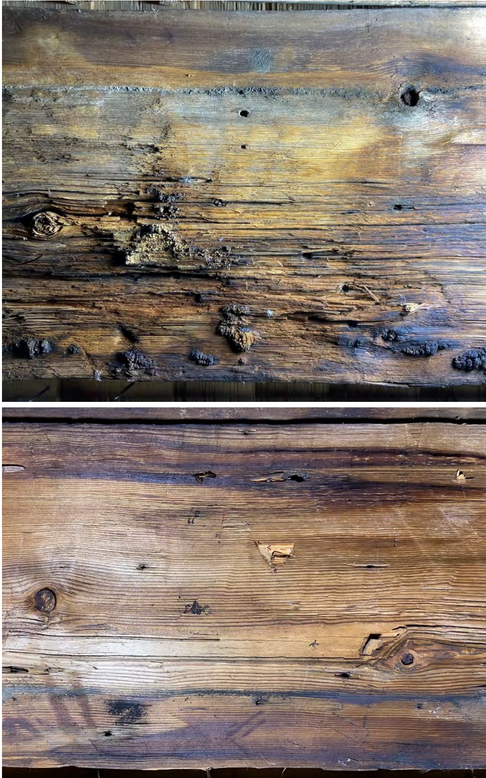
Fig. 95 a–b. Spår av vittring samt överlappningar. Uptill: Ursprunglig ovansida av S7 T5–T9, nu vänd inåt. Längs övre kanten är träet helt ovittrat, här har en överlappande bräda legat an. Nedanför denna yta är träet hårt väderbitet och vittrat, trots att vissa tjärrester vittnar om att träet har varit tjärbestruket. Den långt gångna vittringen tyder på att denna bräda har suttit vänd mot söder, där solen har legat på. Se även förstoring fig. 96. – Nedtill: Undersidan av S6 T5–T9. Längs nedre kanten ses spår av att brädan har överlappat en annan nedanför. Den nedanför var av allt att döma redan intjärad på ovasidan när den avbildade, överlappande brädan monterades. (Det övre fotot har för åskådlighetens skull vridits 180 grader; den ursprungliga överkanten sitter nu vänd nedåt.)
