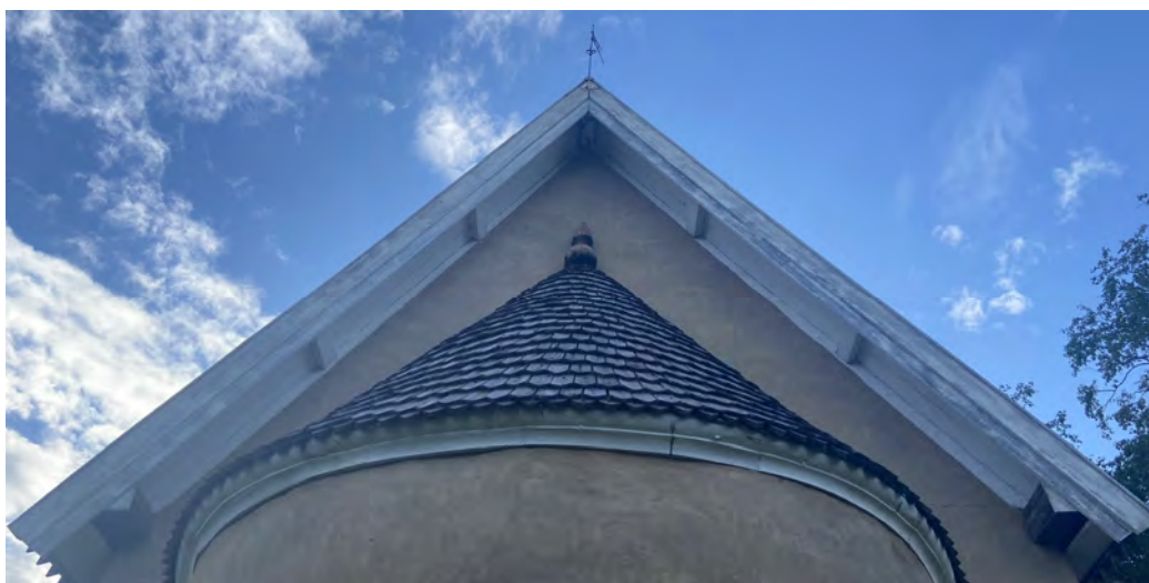
Fig. 24. Östgaveln på koret (nuv. sakristian) i Hackås kyrka. Till skillnad från vad som tycks ha varit fallet i Frösö kyrka har koret här byggts med sidoåsar som fällts in i takstolarnas högben och murats in i gavelmurens krön. Sidoåsarna sticker alltjämt ut i gavelsprånget, men är numera inklädda med vitmålad brädor. Foto: OH.
