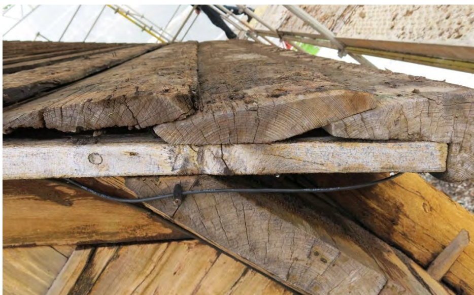
Fig. 98. Medeltida yttertaksbräddor på långhuset i Haltdalen stavkirke, avtäckta i samband med takre- novering 2015–16. Foto: Leif Anker, Riksantikvaren. Jfr med följande figur.
