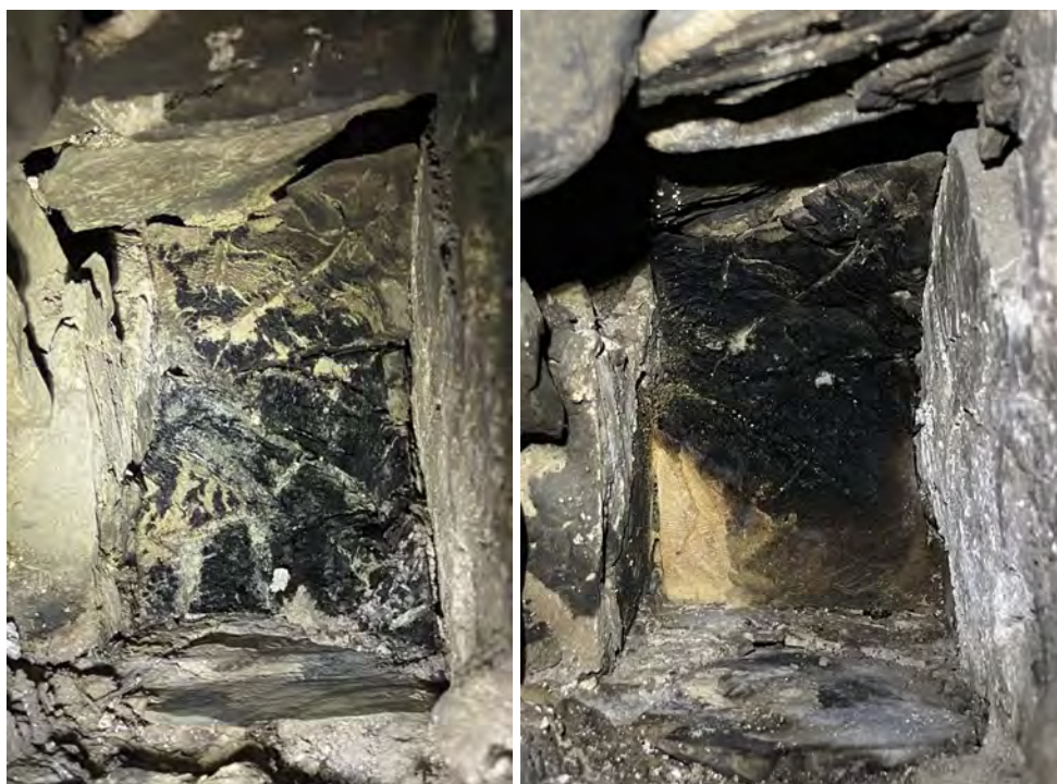
Fig. 41 a–b. Kvarsittande bränd stump av en ursprunglig sparre i hål nr 3 i södra långhusmuren i Frösö kyrka före och efter provtagning. Två bitar utsågades (provnr 86382). De yngsta årsringarna sitter i det nedre högra hörnet. (Att den sågade ytan har blivit nedsotad i detta hörn beror på att vi vattenbegöt träet i samband med provtagningen, som en säkerhetsåtgärd.) Foton: OH resp. BO.
