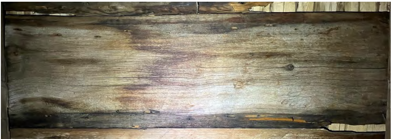
Fig. 116. Väderbiten utsida, nu vänd inåt, av plankan S13 T5–T7. Här partiet mellan T6 och T7. Bredd: 37 cm. Notera de raka ränderna längs kanterna.
