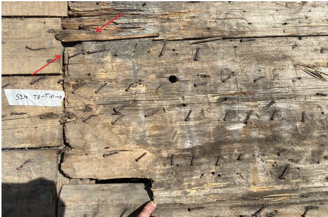
Fig. 123. Änden av plankan S24 T8–T10 ovanpå takstol 10. Det med röda pilar markerade, från övre kanten utgående snittet är av allt att döma ursprungligt. Dess vinkel mot längdriktningen har uppmätts till 32 grader, d.v.s. samma vinkel som motsvarande snitt på föregående bild. Obs. att såväl snittet som plankan fortsätter en bit till inunder brädan ovanför. Kapningen i rät vinkel är tydligen gjord när plankan återanvändes på 1520-talet. Detta snitt har i sin tur ansats längst ut 1922 i samband med monteringen mot de moderna ersättningsbrädorna till vänster i bild. Foto: OH.
