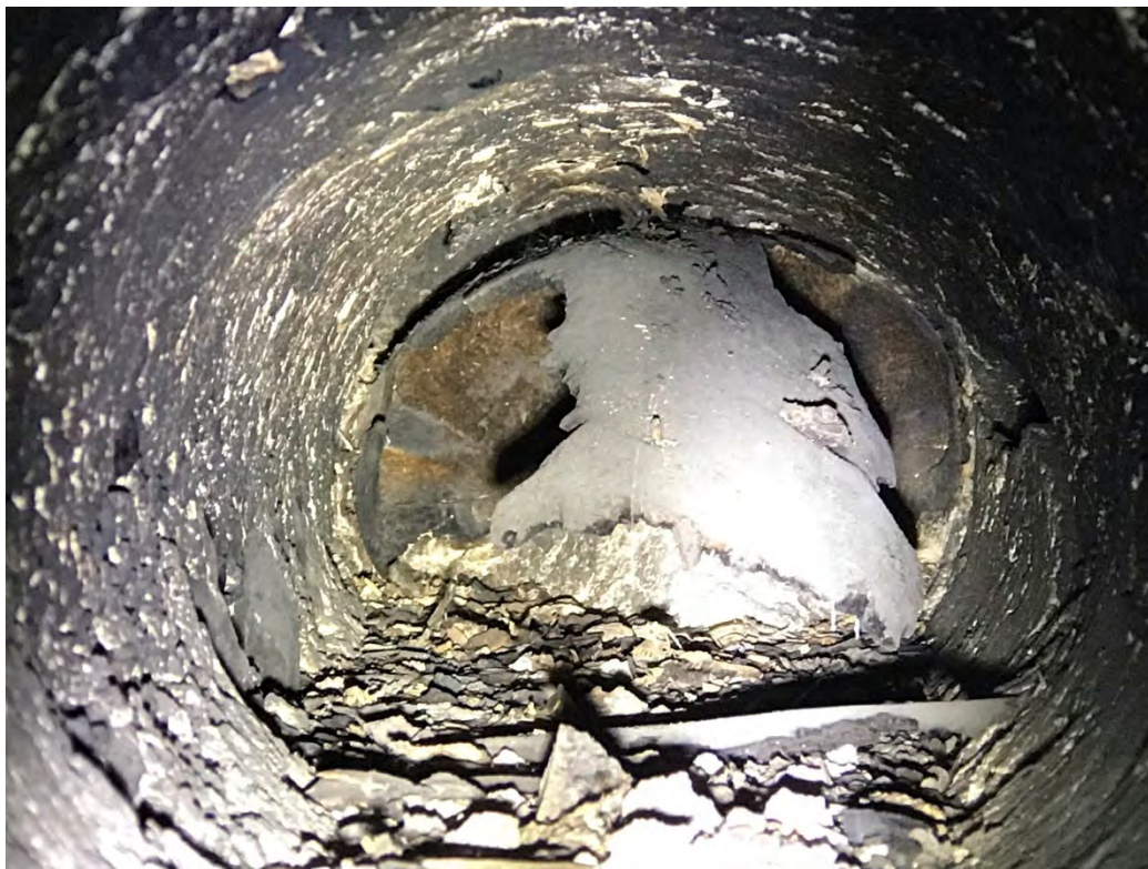
Fig. 35. Fragment av en inmurad ställningsbom på korvinden i Frösö kyrka, längst in i ett 115 cm djupt hål i väggen mot långhuset (nära nuv. takluckan på norra takfallet). Bredd: ca 13 cm. Fragmentet har, efter fotograferingen, i sin helhet dragits ut ur hålet av författarna för att användas som dateringsprov (provnr i laboratoriet: 86365). Foto: OH.
