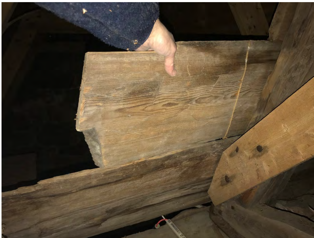
Fig. 154. En bit av de gamla (ursprungliga?) undertaksbrädor som är bevarade över långhuset i Ragunda gamla kyrka. (Just denna bit har någon sågat loss vid byggnadsarbete/elinstallation för att vidga öppningen in till sakristians vind.) Foto: OH.
