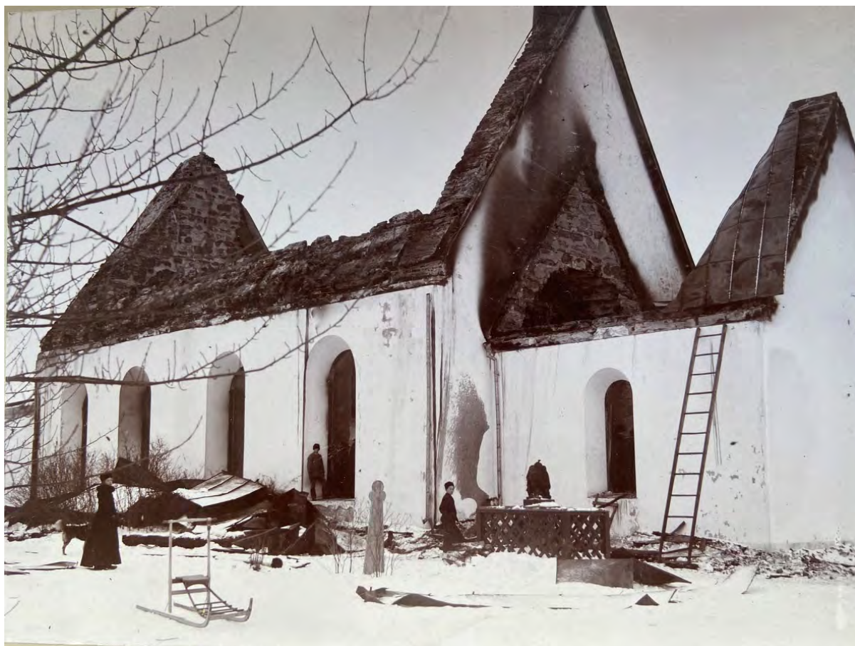
Fig. 14. Frösö kyrka efter branden 20 december 1898. Från sydost. Av bilden framgår tydligt att långhusväggarnas murkrön i koret är plana, medan de i långhuset är uppmurade så att de har slutit an mot taket. Se även detaljbilder återgivna nedan. Foto: Elin Rosdahl, privat ägo.
