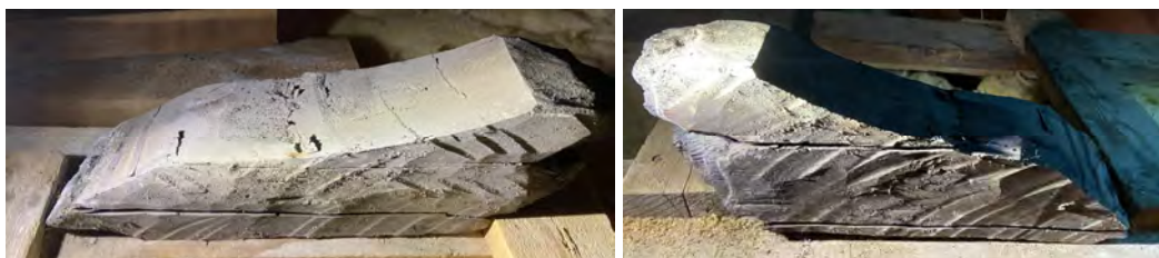
Fig. 37 a–b. Sparrstump som utdragits ur hål nr 14 i norra muren. Ändens svängda form är anpassad efter den kvarsittande, ursprungliga Fragmentet har efter fotografering satts tillbaka på sin plats. Foto: OH.
