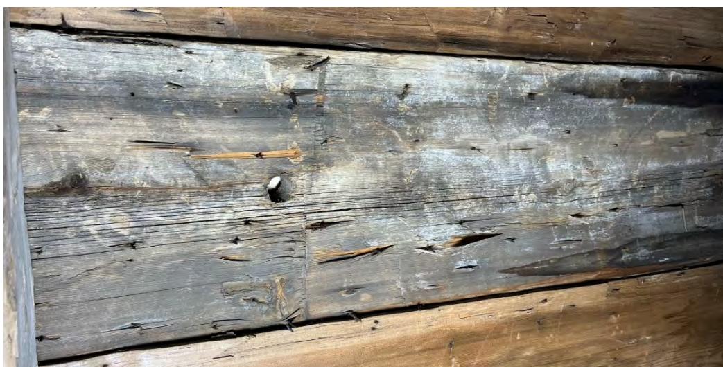
Fig. 72 a–b. Upptill: Ursprunglig undersida av N21 Ö–T4, omsorgsfullt sprättäljd, nu vänd utåt. Foto: David Pettersson. – Nedtill: Ursprunglig ovansida eller "fulsida" av samma bräda, nu vänd inåt mot vinden. T.h. om plugghållet ses spår av ett skyrhugg (inhugg) från bilningen av stocken. Notera även tjärrinningen: brädan har ursprungligen suttit stående med den högra änden på bilden nedåt.
