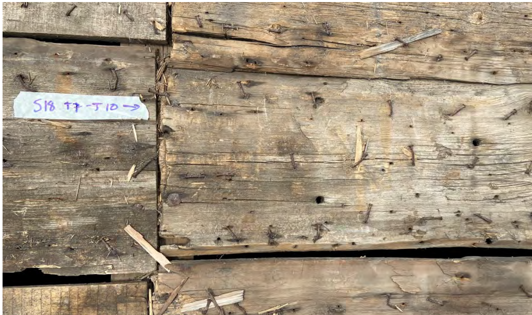
Fig. 63. Skarven mellan den återanvända undertaksbrädan S18 T7–T10 (t.h. i bild) och en flyttad 1500-talsbräda (t.v.). I änden på S18 har en av två gamla, smidda spikar som går ned i takstolen dragits ut varpå den tidigare troligen fasade änden har ansats med yxa för att få bättre plats att spika fast den ditflyttade, mötande brädan. Sågsnittet och de moderna spikarna i den senare tyder på att detta gjordes vid takrenoveringen 1922. Foto: OH.
