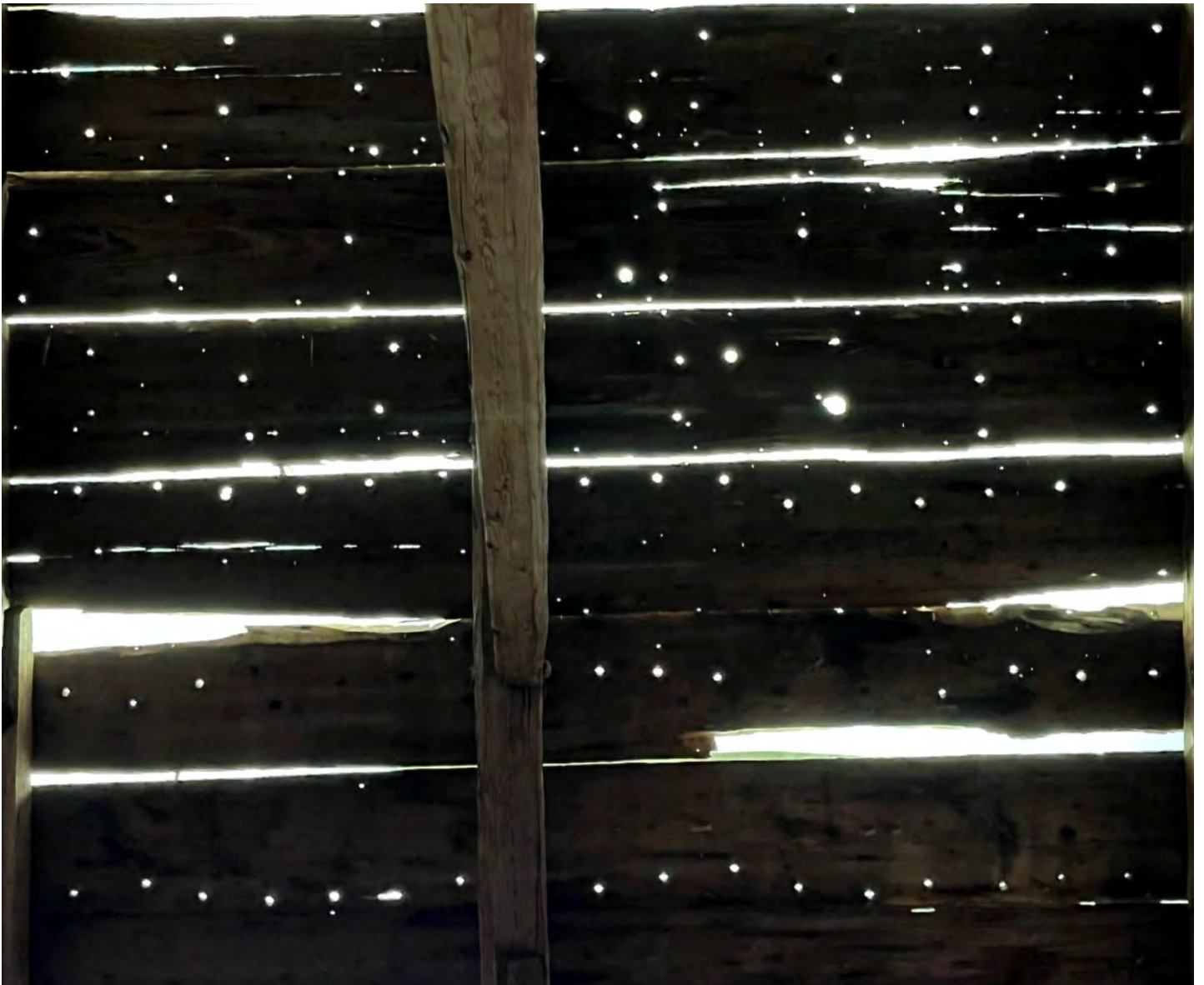
Fig. 104. Stavspånsplugghål i f.d. yttertaksbrädor S19–S21 T5–T7 (nedtill) och undertaksbrädor S22–S24 T5–T7 (upptill), fotograferade inifrån Marby gamla kyrkas vind en dag i juli 2022 när den yttre spåntäckningen var avlägsnad. Även en del sentida spikhål syns. Foto: OH.
