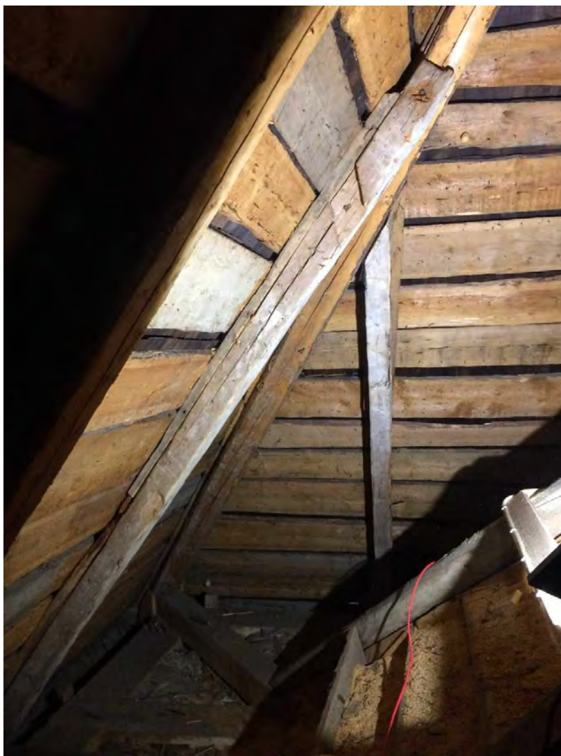
Fig. 52. Grånade, återanvända bjälkar i SÖ hörnet av kyrkvinden i Hallens kyrka: nr 1 närmast i bild (nuv. längd: 355 cm); nr 2 längst bort. Foto: BO.
