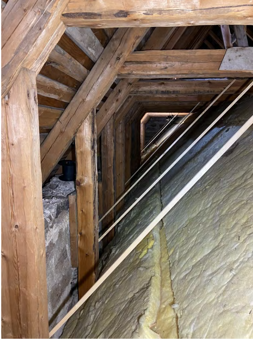
Fig. 29. Alla sparrhål som har undersökts har samma lutning. För att illustrera detta har här stavar stuckits ned i ett antal hål i norra muren (nr 2–4, 9, 11–13). Foto: OH.
