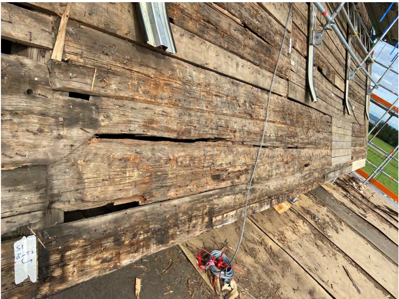
Fig. 105. Återanvända yttertaksbrädor S1–S4 Ö–T7 (”9-metersbrädorna”), längst ned på Marby gamla kyrkas södra takfall. Den nedersta brädan löper ända bort till vindskivan, 8,57 m. De övriga har gjort det tidigare men har under 1900-talet utbytts mellan takstolarna 1 och 3, se nästa bild. (Samma brädor är avbildade från andra vinklar ovan fig. 92–93.) Foto: OH.
