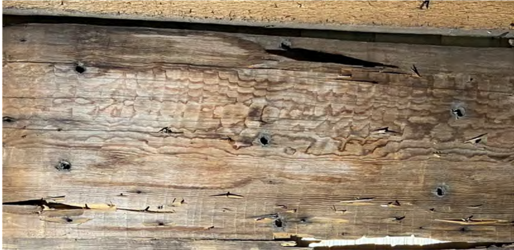
Fig. 71. Små plugghål (diam.: ca 11 mm) på den återanvända undertaksbrädan S24 T5–T7. Avstånden mellan plugghålen i respektive par/rad tvärs över brädan är här kortare än på brädan på föregående bild: ca 10–13 cm i sidled. Det vittnar om en yttre taktäckning bestående av lite smalare stavspån. Brädans nuv. bredd: 27–29 cm, men de ursprungliga kanterna är bortspräckta.
