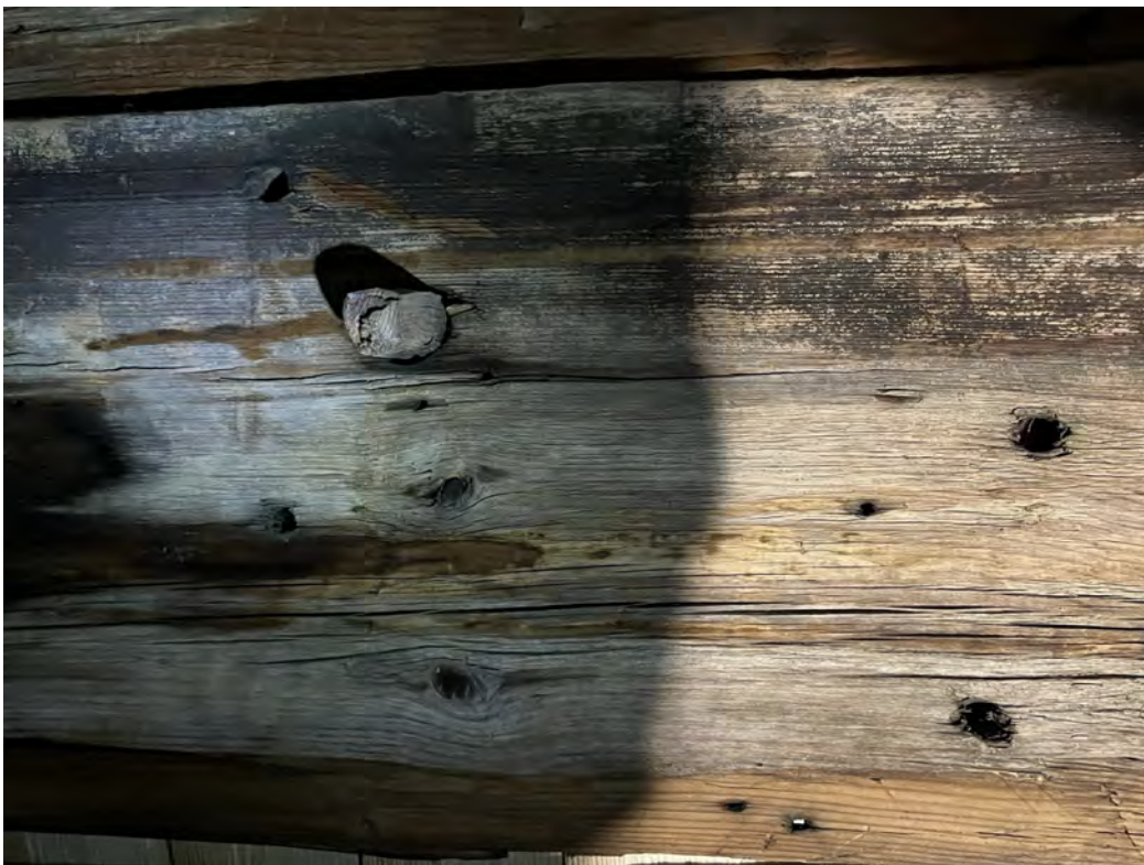
Fig. 74. Ursprunglig ovansida eller "fulsida" av undertaksbrädan N26 T12-V, nu vänd inåt mot vinden. Tjännrinningen visar att brädan har suttit stående med den vänstra änden på bilden vänd nedåt. Den kvarsittande pluggen (diam.: 26–29 mm) är tydligen inslagen i brädan under nyare tid, från utsidan, möjligen vid lagning/utbyte av ett takspån. (Under arbetets gång råkade denna lossna och trilla ned, tyvärr utan att kunna återfinnas. Den torde nu ligga någonstans bland skräpet eller mellan stenarna ovanpå muren i det NV hörnet av vinden, OH:s anm.)
