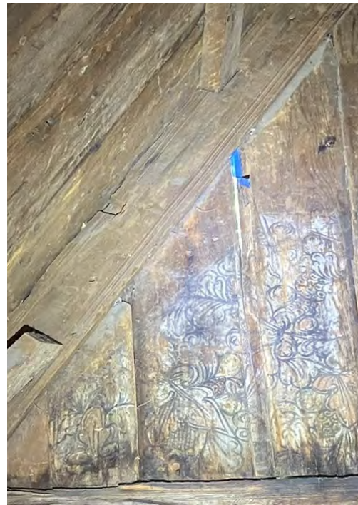
Fig. 127 a–b. T.v.: Gavelväggar i en medeltida norsk stavkyrka av mindre modell. Plankorna som fyller ut gavelröset står nedtappade i ett väggband och går upp i notar på undersidan av gavelsparrarna. Efter Christie 1974, fig. 36. – T.h.: Gavelrösteplankor i koret i Haltdalen stavkirke från insidan. Dekor-målningen är från början av 1600-talet. Foto: OH.
