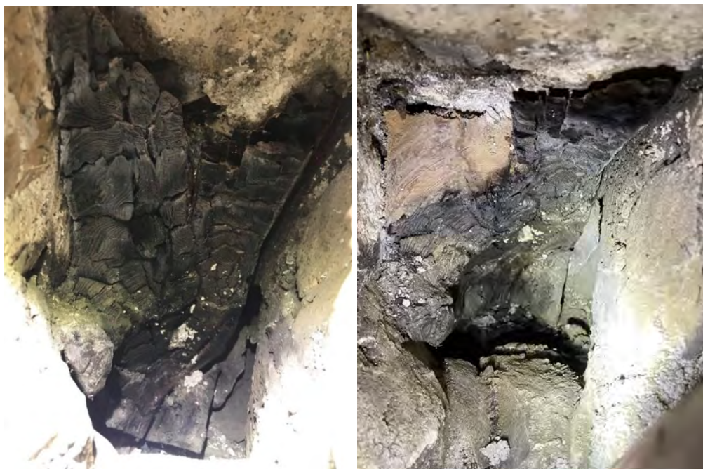
Fig. 38 a–b. Kvarsittande bränd stump av en ursprunglig sparre i hål nr 12 i södra långhusmuren i Frösö kyrka före och efter provtagning. Två bitar utsågades ur den utskjutande delen i övre vänstra hörnet i hålet, där de yngsta årsringarna i sparren sitter (provnr i laboratoriet: 86367). Foton: OH.
