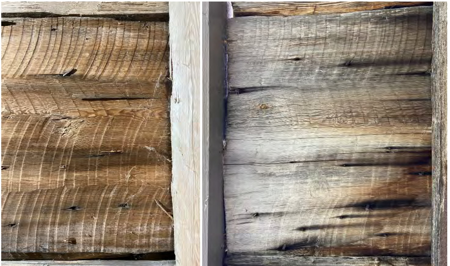
Fig. 81. Sprättäljningsmönstren, dimensionerna och träets struktur visar att stumpen N4 T10–T11 (t.v.) utgör fortsättningen på undertaksbrädan N5 T11–V (t.h.). Brädan har kapats i samband med takrenoveringen 1922. Obs. att N4 sedan dess sitter vänd med de på 1520-talet fasade kanterna åt fel håll; det vänstra fotot är därför här vridet 180 grader för åskådliggörelse. Foton: OH.
