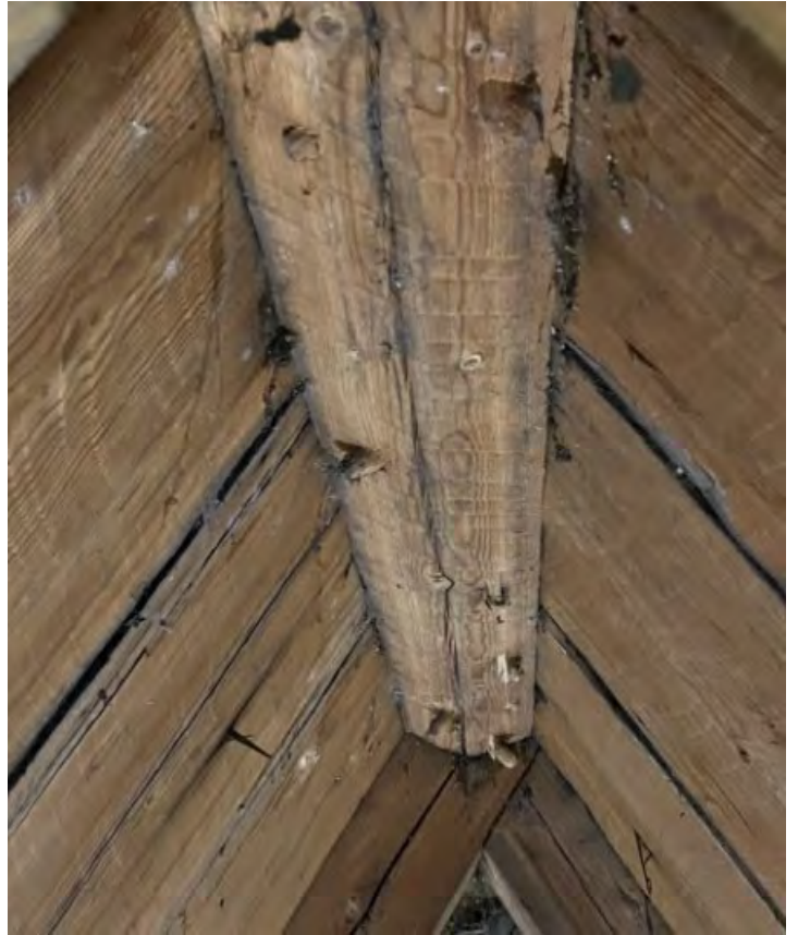
Fig. 86 a–b. T.v. rekonstruktion av taktäckningen vidnocken över mittrummet i långhuset i Urnes stavkirke. Efter Christie 2009, s. 141. – T.h. nockåsen i taklaget över koret (nuv. sakristian) i Hackås kyrka. Foto: OH.
