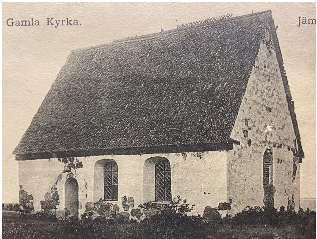
Fig. 61. Marby gamla kyrka före takrestaureringen 1922. Kyrkans stavspånstäckning var då i delvis dåligt skick. Foto: okänd fotograf okänt år (efter 1899). Efter vykort i ATA (beskuret).
