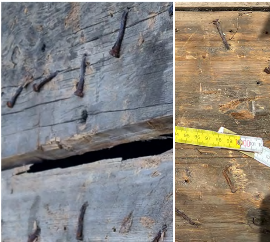
Fig. 103 a–b. T.v.: Ytterligare exempel: N17 Ö–T4, med ett motsvarande spikhål mellan T1 och T2 (i centrum av bilden). Foto: Kenneth Hellström. – T.h.: Spikhål på S5 T9–T12, strax öster om T10 (spikhålet halvt i skugga längst ned i bild). Foto: OH.
