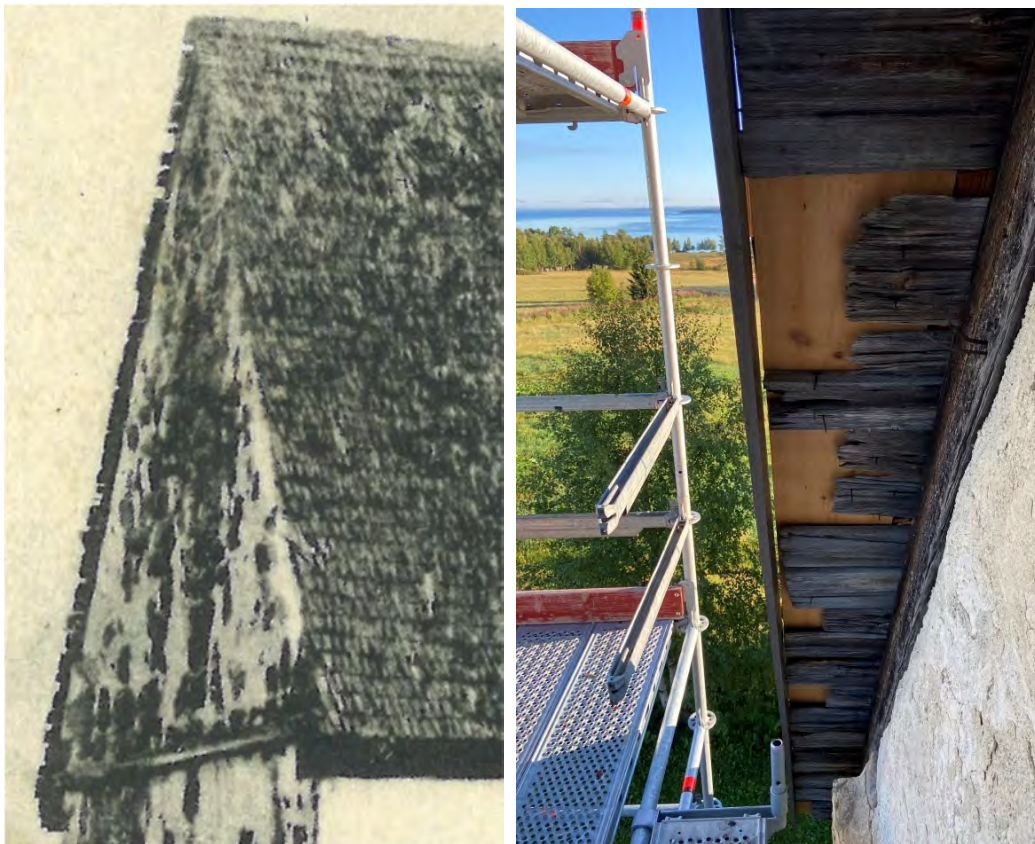
Fig. 62 a–b. T.v.: Västra gavelröset före takrenoveringen 1922 (fotot är taget någon gång 1899–1907). Detalj av fig. 58. – T.h.: Västra gavelsprånget mot norr 2022. De brädor som når ut till den nuvarande vindskivan torde alla ha monterats dit 1922 och består av dels gamla brädor som flyttats, dels nytt, sågat virke. Den ljusa förstärkningsbrädan är ditsatt 2022. Foto: OH.
