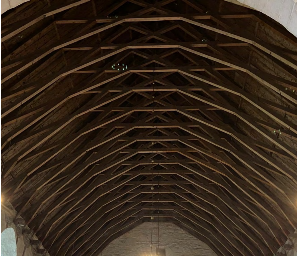
Fig. 32. Samma slags takstolar i Værnes kirke. Total spännvidd: 14,1 m (ca en meter mer än i Frösö kyrka). Dessa takstolar är daterade till 1148/49 (i öster) respektive 1160/61 (i väster). Foto: OH.
