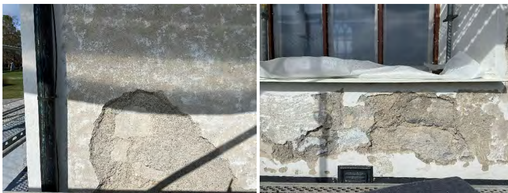
Fig. 20 a–b. Stenar i muren blottade vid fasadarbeten i maj 2023 på Frösö kyrkas f.d. västtorn (nu vapenhus, t.v.) och långhus (t.h.). Södra sidan av kyrkan. Foton: OH.
