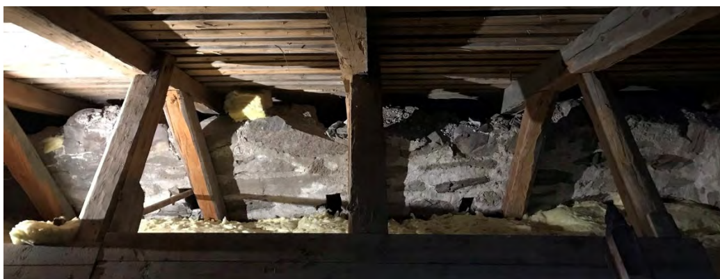
Fig. 28. Foto taget ovanifrån och snett nedåt mot långhusets norra, spetsiga murkrön, med tre hål synliga efter ursprungliga takstolarnas långa saxsparrar (nr 1–3 räknat från öster). Dessa saxsparrars nedre ändar har från början murats in i murverket. I hål nr 3 (t.v. i bild) har en stav nedsatts inför fotograferingen för att illustrera vilken lutning saxsparrarna har haft. Foto: OH.
