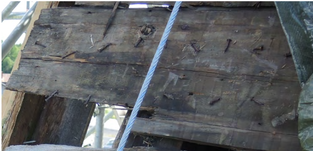
Fig. 71. Små plugghål (diam.: ca 11 mm) på den återanvända undertaksbrädan S24 T5–T7. Avstånden mellan plugghålen i respektive par/rad tvärs över brädan är här kortare än på brädan på föregående bild: ca 10–13 cm i sidled. Det vittnar om en yttre taktäckning bestående av lite smalare stavspån. Brädans nuv. bredd: 27–29 cm, men de ursprungliga kanterna är bortspräckta.
