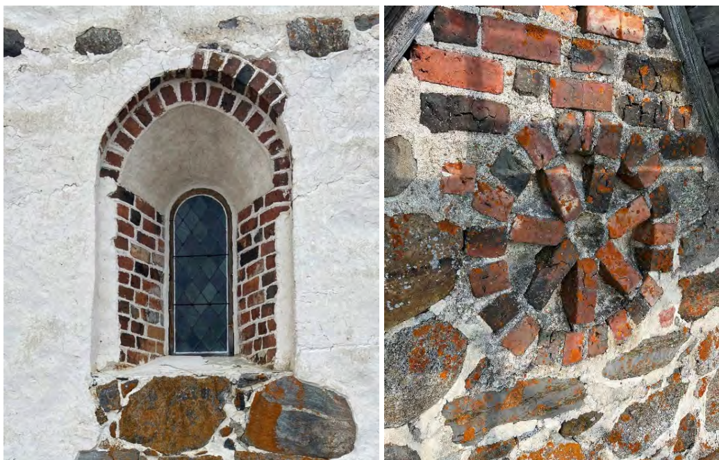
Fig. 136 a-b. Tegelfattat fönster i öster och tegelblindering i väster på Marby gamla kyrka. Foton: OH.
