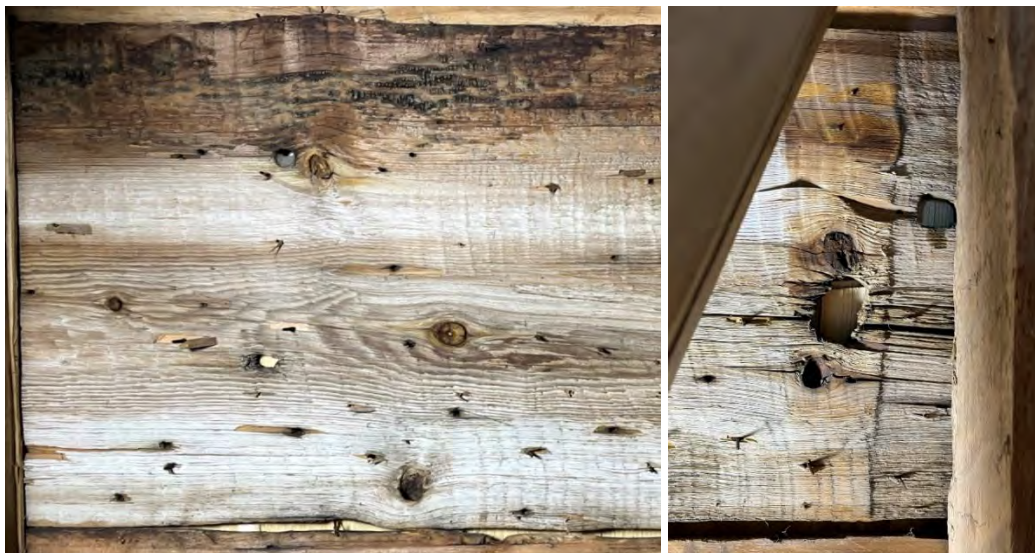
Fig. 90 a–b. Undersidan av brädan N19 Ö–T2 är väderbiten och vittrad utom på partiet tvärs över brädan som ses på bilden t.h. (ca 10 cm brett men avsmalnande). Spåren av tjärrinning överst på den vänstra bilden visar att brädan har suttit stående med den nuv. östra änden riktad nedåt. Vittringen skulle kunna förklaras av att brädan har suttit ute i ett gavelsprång och legat an mot en utstickande sidoås på det ovittrade partiet. Formen på det ovittrade partiet tyder på att sidoåsen har smalnat av och att brädans nuv. nedre kant (som är sekundärt avbildad) har suttit vänd utåt. Brädan torde alltså ha suttit i det vänstra gavelsprånget som skjutit ut från ett gavelröste. Brädan är nu som mest 38 cm bred. Foton: OH.
