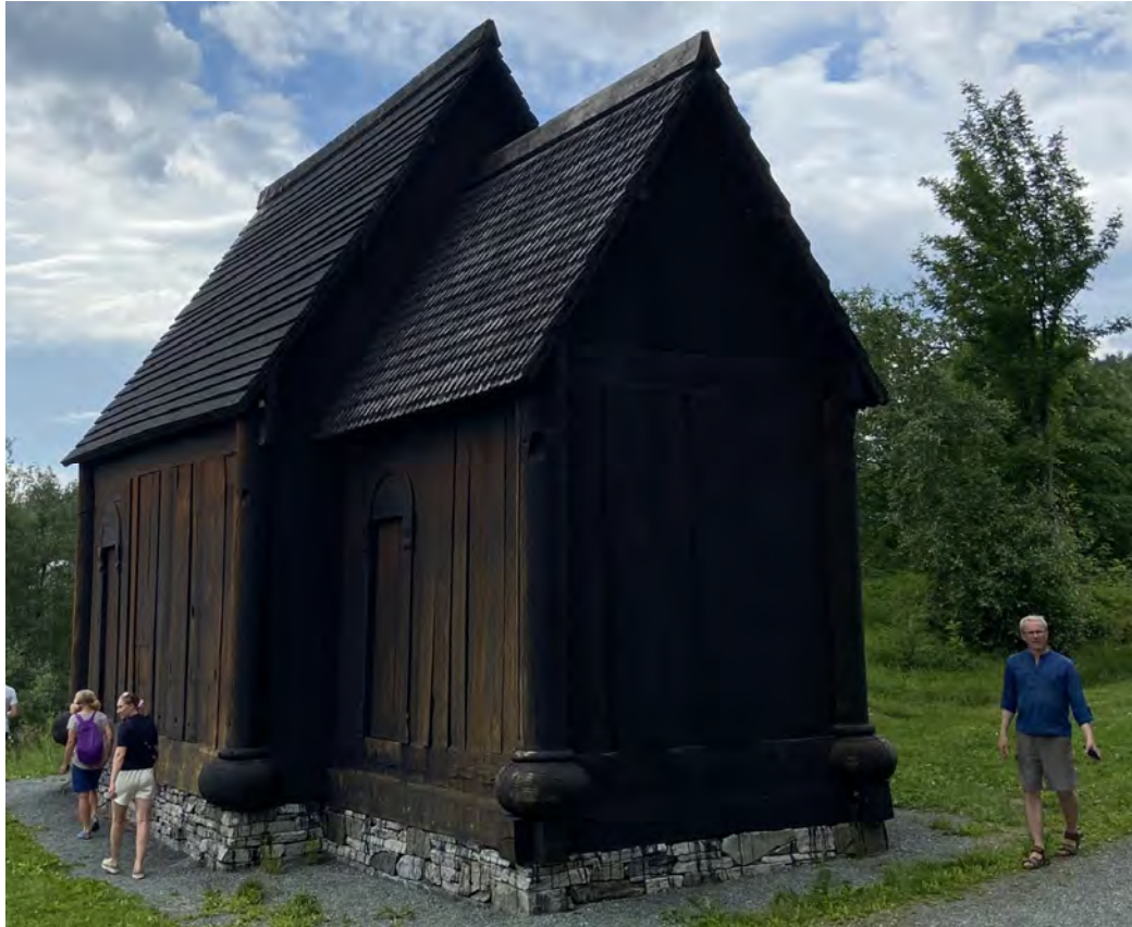
Fig. 99. Haltdalen stavkirke, Sverresborg Trøndelag Folkemuseum, Trondheim, med ett numera rekonstruerat yttertak på långhuset bestående av kopior av de medeltida brädorna. Brädornas längd: ca 6,7 m. På koret sitter stavspån. Kyrkan är daterad till omkr. 1163–1170 och har sannolikt tidigare haft en svalgång runtom (jfr fig. 109 nedan). Foto: OH 2022.
