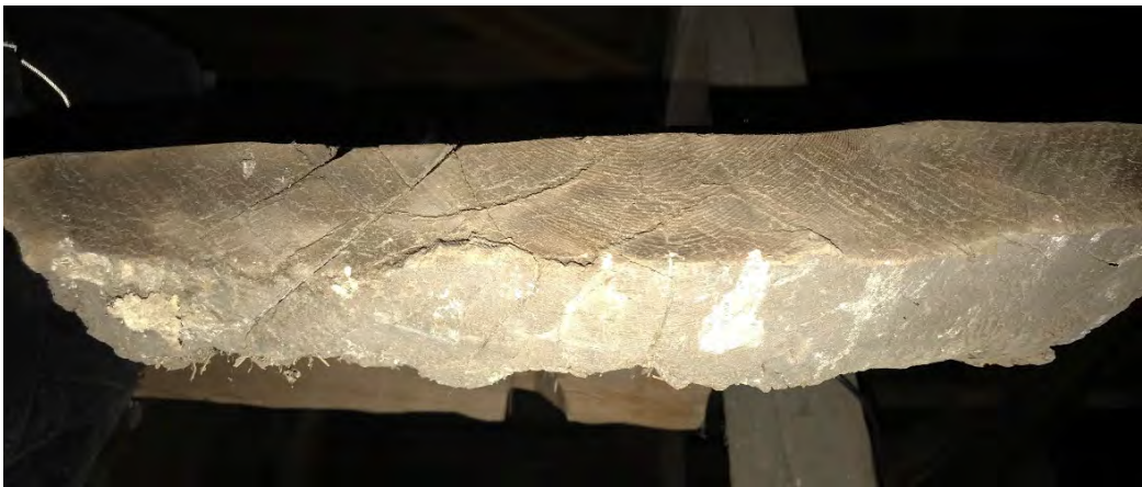
Fig. 152. Golvtiljans numera avkapade ände. Tjocklek: ca 10–12 cm.
