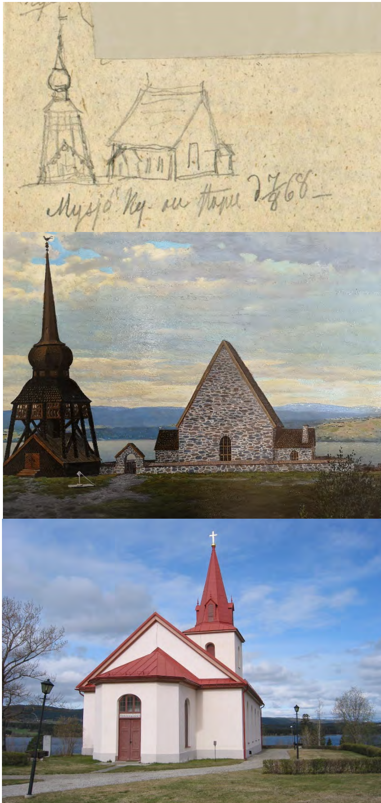
Fig. 133 a–c. Myssjö kyrka före och efter ombyggnaden 1878–80. Överst: Från SO. Skiss av N. M. Mandelgren 1868, LUF. Mitten: Från öster. Målning av Per Månsson i Persåsen 1932 efter en äldre, nu okänd målning av "J. Bergström" (Jöns Bergström d.ä. i Kövra, 1818–1905 eller Jöns Bergström d.y., 1843–1926), sockenstugan i Myssjö. Underst: Kyrkan idag från öster. Den numera rivna klockstapeln var uppförd 1755 av Olof Månberg och stigporten troligen 1709. Kyrkans fönster i öster var förstorat sedan 1777/78. Foton: LUF; Annabell Fogelberg resp. Anders Stjernberg/Härnösands stift 2004.
