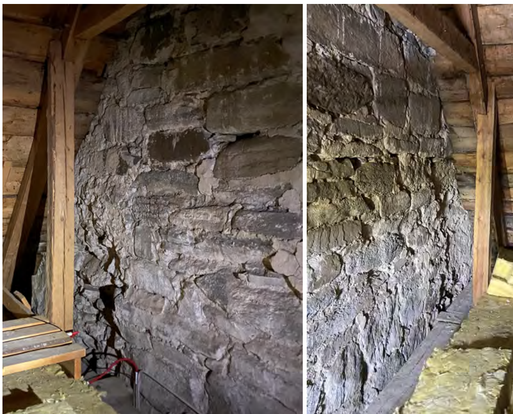
Fig. 18 a–b. Sår i gavelväggens murverk ovanför vapenhusets (= tornfotens) norra murkrön (t.v.) respektive södra murkrön (t.h.). Notera att den släta skalmuren går in ovanför såren ungefär i fotografens axelhöjd (vilket motsvarar takfotens nivå på långhuset). Foton: OH. – Jfr med det gamla exteriørfotot fig. 6 ovan.
