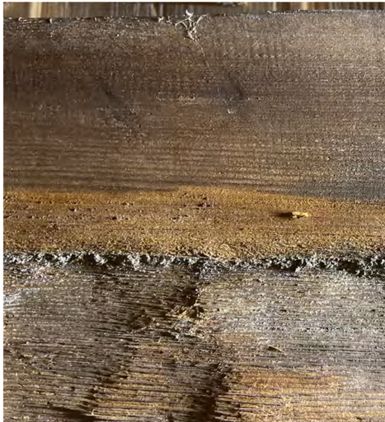
Fig. 96. Närbild på brädan som avbildas upptill i föregående figur (S7 T5–T9). På det ovittrade partiet, som är 5 cm brett, framträder vibrationsspår efter att man har släthyvlat ovasidan närmast kanten med en skave.
