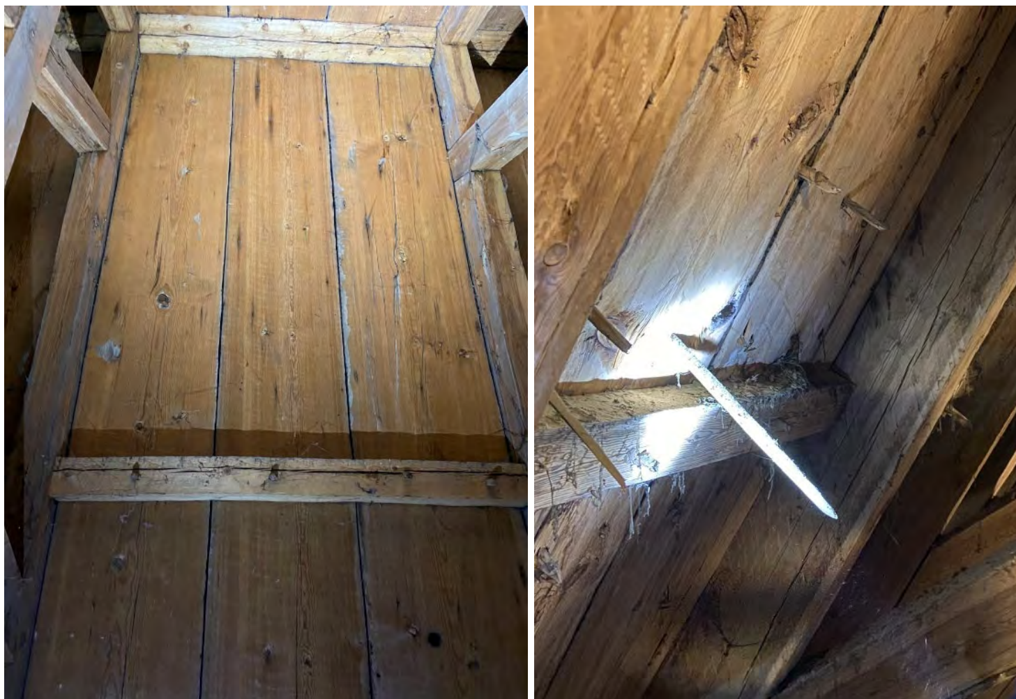
Fig. 82 a–b. Sprättäljda, stående undertaksbrädor i originalposition i Hackås kyrkas kor (nu sakristia) (t.v.) och i Selbu kirkes långhus (t.h.). I Hackås ligger brädorna nedfällda mellan takstolarnas högben, medan de i Selbu ligger delvis ovanpå högbenen. Takkonstruktionen i Hackås är daterad till omkr. 1151–1163, den i Selbu till 1176/77. (På bilden från Selbu ses också några anmärkningsvärt långa pluggar som troligen använts för att fästa takspån utanpå taket.) Foton: OH.
