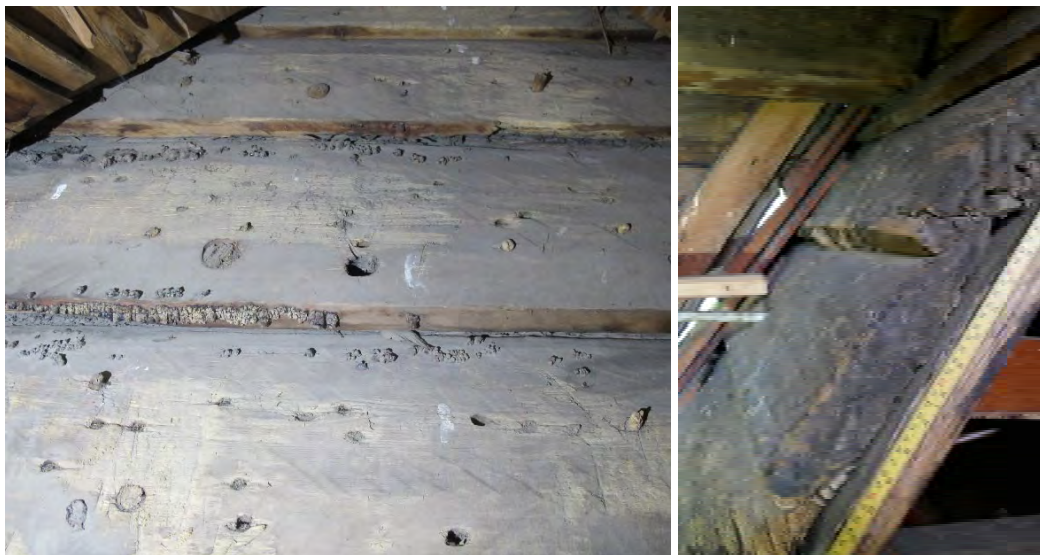
Fig. 100 a–b. Motsvarande brädor på Værnes kirke i Trøndelag (t.v.) och på Urnes stavkirke i Vestland fylke, Norge (t.h.). De förra mäter i bredd i genomsnitt ca 30 cm. Foto: Øystein Ekroll resp. Robin Gullbrandsson.
