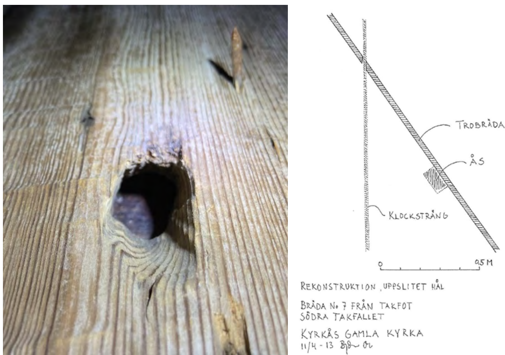
Fig. 1 a–b. Ett av fynden under projektets första etapp: ett hål i en undertaksbräda i Kyrkås gamla kyrka med slitage efter en klocksträng. Brädan har från början suttit i taket i en träkyrka daterad till tidsspannet 1143–59, rimligen en stavkyrka. Foto: Olof Holm (nedan: OH). Ritning: Björn Olofsson (BO).
