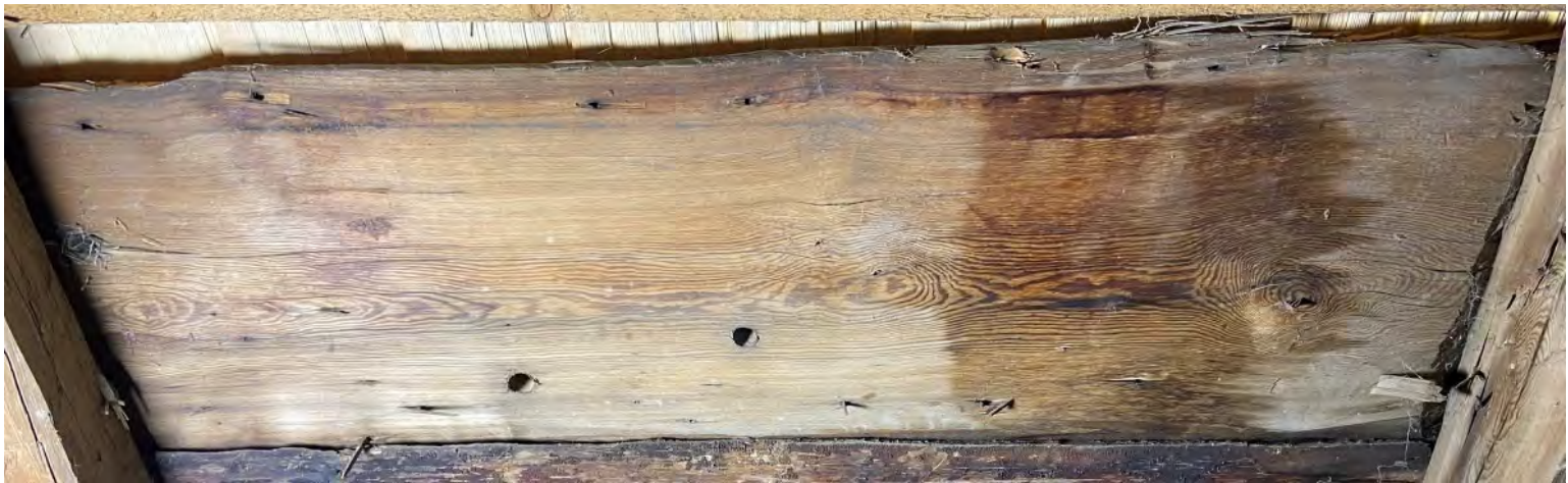
Fig. 114. Släthyvlad insida av plankan S3 T7–T8. Bredd: 37 cm. Notera den raka randen längs den nuvarande övre kanten. Foton fig. 114–119: OH.
