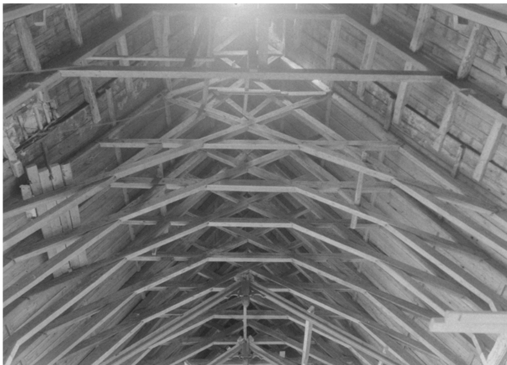
Fig. 31. Taklaget i Selbu kirke under restaurering 1949 (numera har kyrkan ett innertak). Total spännvidd: drygt 12 m (knappt en meter mindre än i Frösö kyrkas långhus). Virket i takstolarna är daterat till 1176/77. (Takstolen närmast i bild är från senare tid.) Foto: Schrøder Foto, Schrødersamlingen, Sverresborg Trøndelag Folkemuseum.
