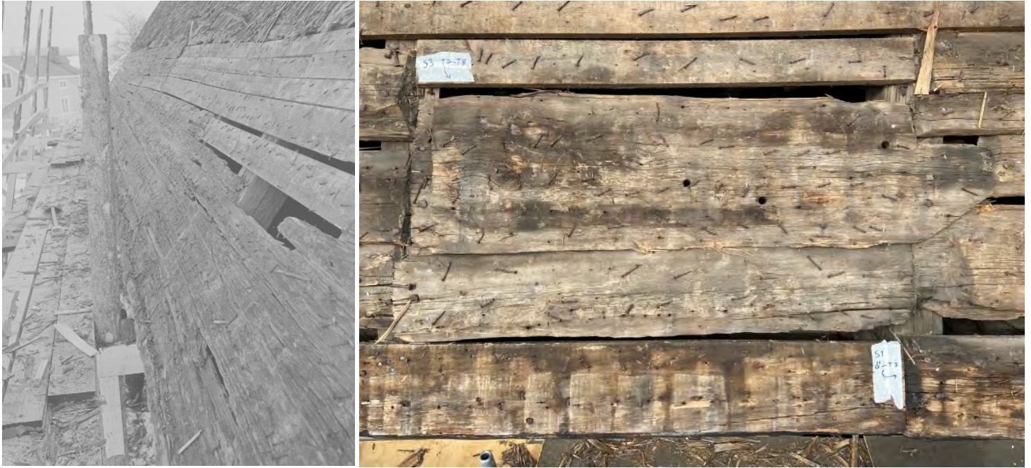
Fig. 106 a–b. T.v.: Samma långa brädor fotograferade 1982, innan fem nya ersättningsbrädor monterades mellan takstolarna 1 och 3 nedanför en ersättningsbräda från 1922 (den som sitter ovanför hålet på bilden). Foto: Jörgen Schwartzkopf, Jamtlis arkiv. – T.h.: Korta stumpar som takläggarna på 1520-talet fyllde ut med mellan takstolarna T7 och T8, vid ändarna av "9-metersbrädorna" på föregående bilder. De två i mitten är ursprungliga. (Den breda plankan är en gammal väggplanka och kommer att behandlas längre fram.) Foto: OH.
