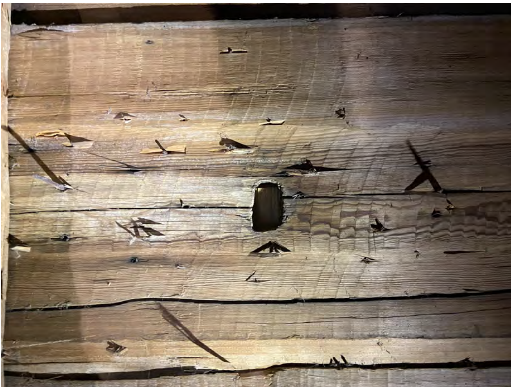
Fig. 76. Vittring i anslutning till ett stort hål med oklar funktion i N8 T1–T4. Här har taket tydligen inte hållit tätt, utan vatten har sipprat in genom hålet, runnit längs brädans insida och orsakat vittringen. Det visar att brädan har suttit stående med den vänstra änden på bilden riktad nedåt.
