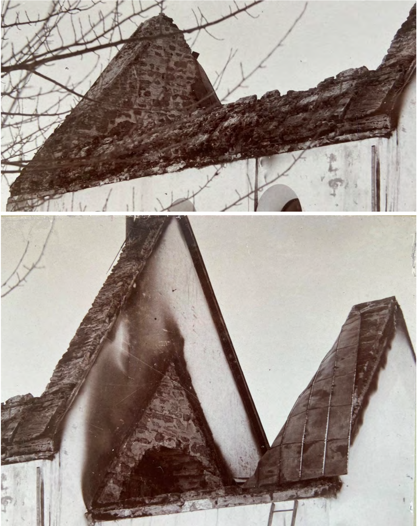
Fig. 15 a-b. Detaljer av fotot fig. 14. Under och utanför muravsatserna efter de uppbrunna yttre remstyckena ses troligen kvarsittande, moderna takfotslistor av plåt. Även i gavelsprånget på triumfbågmuren sitter plåten kvar.
