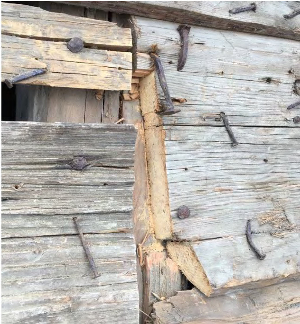
Fig. 132. Änden av undertaksbrädan N13 T1–T4 med bevarade barkrester nedtill. Efter provtagning (provnr 86375). Foto: Per Malmsten.
