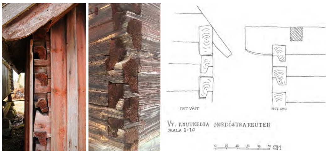
Fig. 163 a–c. Knuttimring med skarpkantat timmer och släta knutar i Rödöns kyrkas f.d. vapenhus (nu kyrkbod) omkr. 1600–08 (t.v.) och Kyrkås gamla kyrkas sakristia omkr. 1673 (mitten och t.h.). Foton: BO resp. OH. Uppmätning: Christina Persson och BO; renritning: BO (efter Olofsson 2008).
