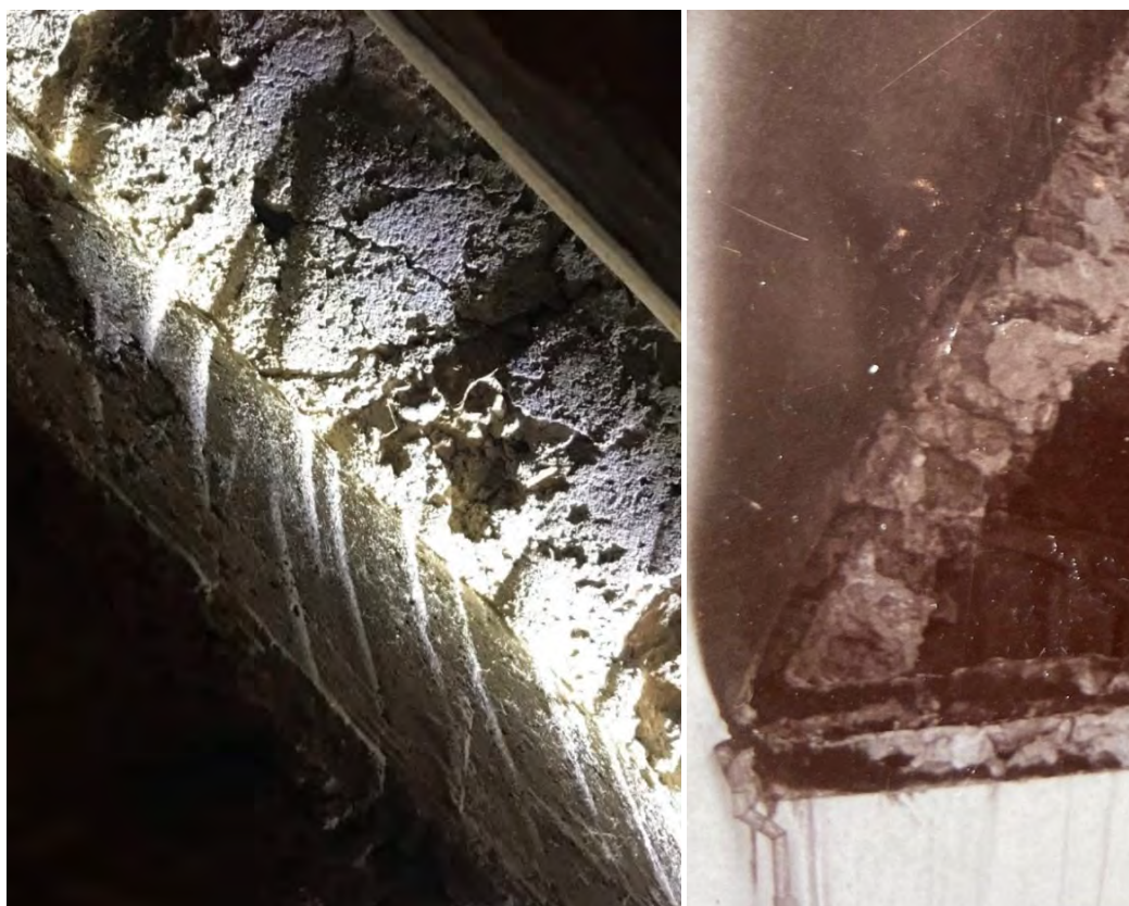
Fig. 23 a–b. T.v.: Avtryck i murbruket av ett högben som har suttit på insidan av gavlröstet på Frösö kyrkas kor, södra takfallet. Sprättäljningsspåren framträder tydligt. Överst i bild skymtar ett modernt högben. Foto: OH. – T.h.: Avtryck av ett inmurat högben, ovanpå vilket yttertaget anslutit mot triumfbågsmuren. Detalj av fotot fig. 14.
