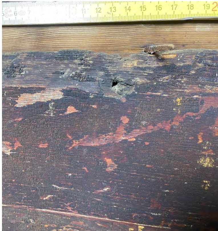
Fig. 102. Spikhål med avtryck av ett smitt spikhuvud nära den ursprungliga nedre kanten på en f.d. yttertaksbräda. Här S2 T7–T8. Obs. att denna bräda, förutom att den nu sitter med ovansidan inåt, också är vänd upp och ned. Foto: OH.
