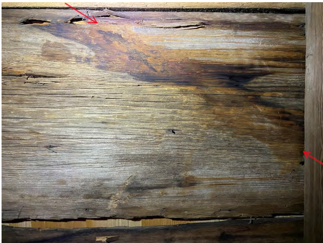
Fig. 124. Plankan S15 T5–T7. Pilarna markerar ungefärligen gränsen mellan plankans väderbitna yta t.v. i bild och en ovittrad men grånad yta med spår av tjärrinning t.h. Plankan fortsätter på andra sidan av högbenet som skymtar t.h. Tjärrinningen visar att plankan ursprungligen har stått med den högra änden nedåt. Foto: OH.
