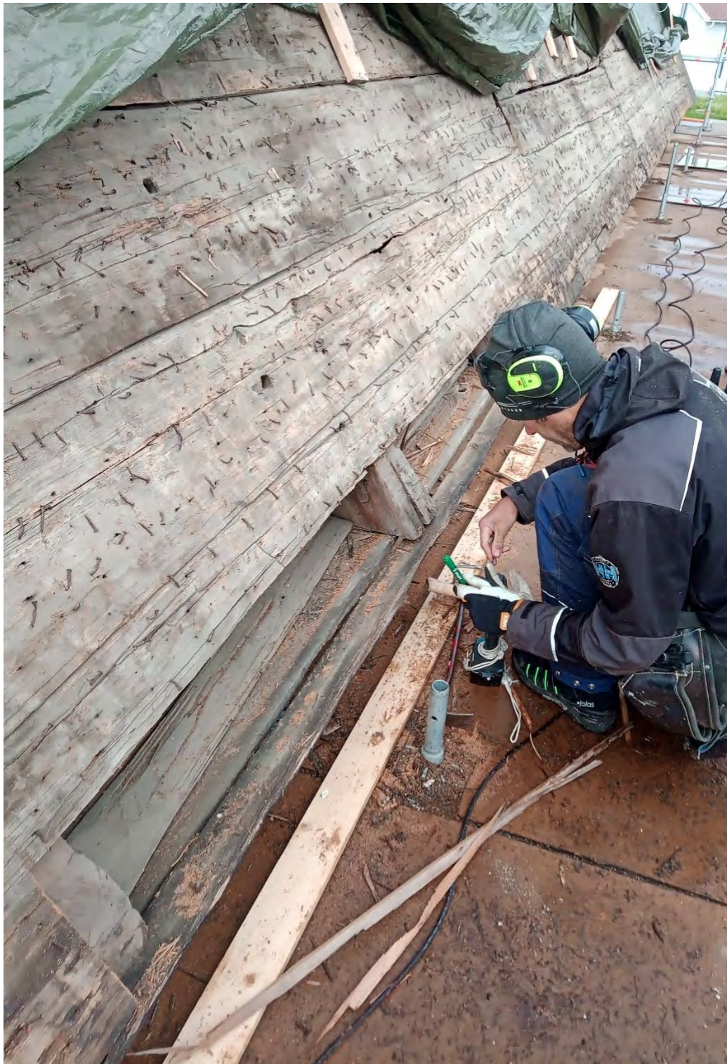
Fig. 64. Norra takfallets nedersta parti, frilagt i samband med byte av stickspån sommaren 2022. Här bildar plana och breda undertaksbrädor ett jämnt undertak. Brädorna är fasade så att kanterna ligger omlott. Brädorna närmast i bild är återanvända från en äldre byggnad (stavkyrkan) och har omsorgsfullt spröttäljda undersidor. En rötskadad bit av brädan N1 som sträcker sig från östra vindskivan till takstol 4 har sågats loss (tillvaratagen och nu förvarad på vinden). Ovanför den sitter N2 och N3 med varsitt stort plugghål synligt i bild. Notera att dessa plugghål inte sitter ovanför någon av takstolarna. De utgör i stället spår av infästningar i en äldre takkonstruktion, där undertaksbrädorna var monterade stående, utan fasade kanter. Längre bort i bild ses ytterligare tre sektioner med brädor, som huvudsakligen är bilade tvärs fibrerna på undersidorna. Sistnämnda brädor kan antas vara tillverkade när stenkyrkan byggdes på 1520-talet. Snickaren på bilden är Kenneth Hellström. Foto: David Pettersson.
