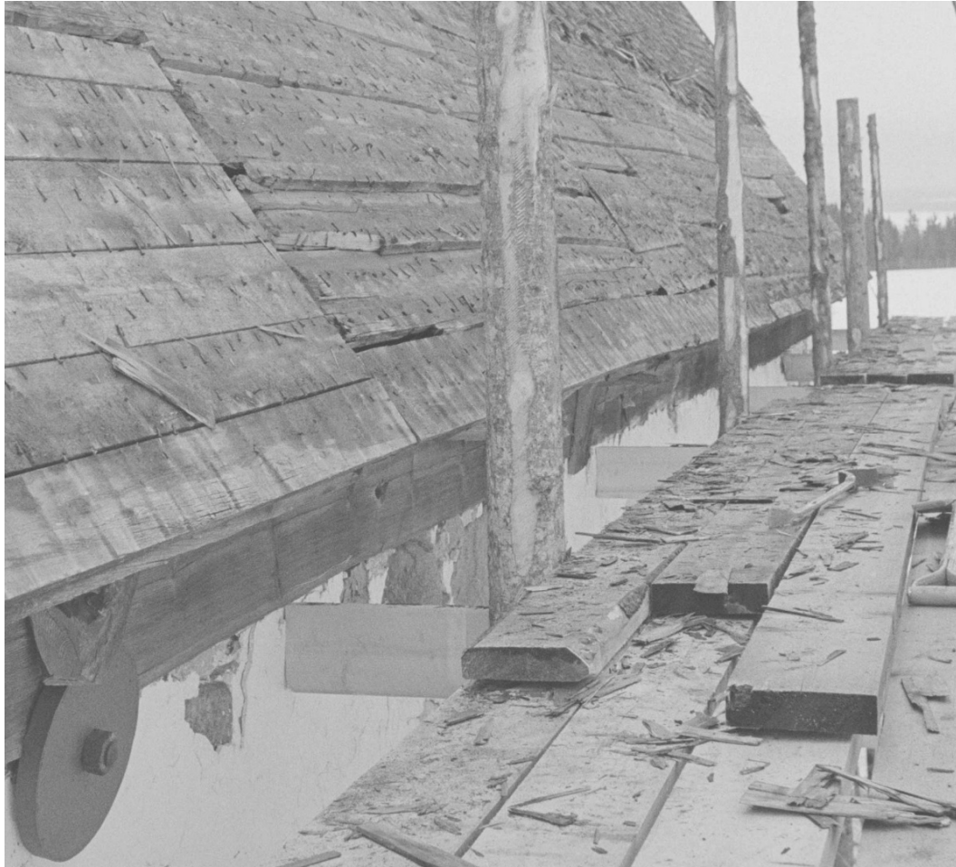
Fig. 107. Den nedersta delen av södra takfallet på Marby gamla kyrka. Bakom den närmaste stolpen på bilden ses tre f.d. yttertaksbrädor, S2–S4 T8–T11 ("4-metersbrädorna"), som är av samma längd: nu ca 3,35 m. Bortanför dem sitter utfyllnadsstumparna S2–S3 T7–T8, som är blott dryga metern långa. Längst bort sitter de fyra f.d. yttertaksbrädorna S1–S4 Ö–T7 ("9-metersbrädorna"), som ses på föregående foton. Brädorna närmast i bild är ersättningsvirke från 1922. Foto: Jörgen Schwartzkopf 1982, Jamtlis arkiv.
