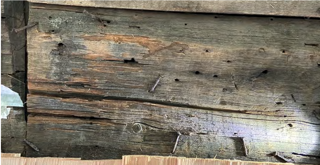
Fig. 75. Ursprunglig undersida av S14 T10–T12, nu vänd utåt. I släpljus framträder ett elegant sprättäljningsmönster, trots att denna sida under nyare tid har blivit vittrad och nött. Sågsnittet i väster och de moderna spikarna som går ned i takstolen tyder på att denna bräda, i likhet med många andra, har kapats och omplacerats vid takrenoveringen 1922. Orsaken till kapningen i detta fall var säkert den rötskada som syns på bilden. Brädan har dessutom kapats i den andra änden.
