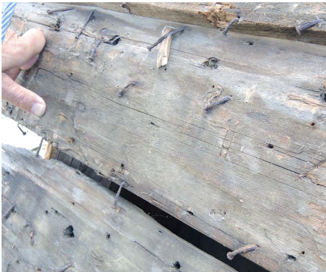
Fig. 94 a–b. Exempel på välbevarade, buktande ovansidor. Bilden upptill: brädan S2 T7–T8, vars ursprungliga ovansida sedan 1520-talet sitter vänd inåt. Här ses fortfarande ett tjockt lager skyddande tjära. Tjärytan är ömtålig och beröring bör undvikas! Brädan är sekundärt avfasad upptill på bilden. (Fotot har för åskådlighetens skull vridits 180 grader; den ursprungliga överkanten sitter nu vänd nedåt.) – Nedtill: Brädan N18 Ö–T3, vars ovansida alltjämt sitter vänd utåt. Denna bräda och brädan nedanför har långsgående rader av 11 mm plugghål. Foto: David Pettersson.
