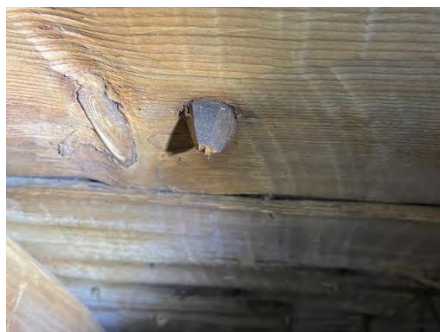
Fig. 111. Spetsen av en 11 mm plugg som ett stavspån har varit fäst med. N12 T1–T4. Foto: OH.
