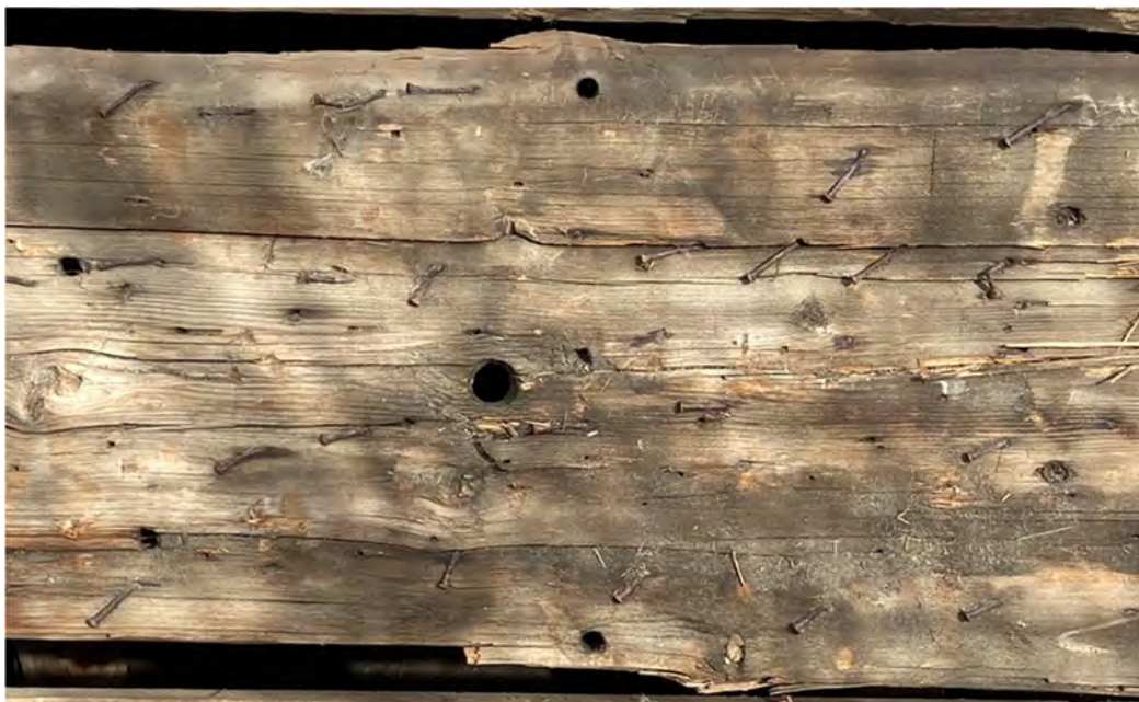
Fig. 70. Olika typer av plugghål på en lång, återanvänd undertaksbräda, här S9 T6–T10 sedd ovanifrån. I mitten ett stort, koniskt format plugghål, vidgande sig uppåt. Här har brädan varit fastnaglad mot ett upplag. I övrigt små plugghål (diam.: ca 11 mm), sittande parvis eller i rader om tre tvärs över brädan, ibland med kvarsittande fragment av avbrutna pluggar. Avståndet mellan dessa mindre plugghål i respektive par/rad är på de längre brädorna vanligtvis ca 13–16,5 cm i sidled. Notera förskjutningen från rad till rad, som tyder på att det är stavspån som har varit fästa med pluggar i de små hålen och att brädan har suttit stående. Stavspånen har dock inte legat på undertaksbrädorna utan på ett lager av horisontellt lagda yttertaksbrädor (varom mera nedan). Brädans nuv. bredd: ca 40 cm, men skadad i kanterna. Jfr med följande bild.
