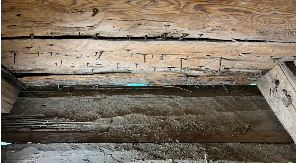
Fig. 73. Ursprunglig ovansida eller "fulsida" av en ursprunglig undertaksbräda återbrukad som takfotsbräda mellan takfoten i norr och det yttre remstycket (som skymtar längst ned i bild). Till skillnad från alla liknande brädor som har återanvänts som undertaksbrädor är denna bräda nästan helt fri från sentida spikhål.
