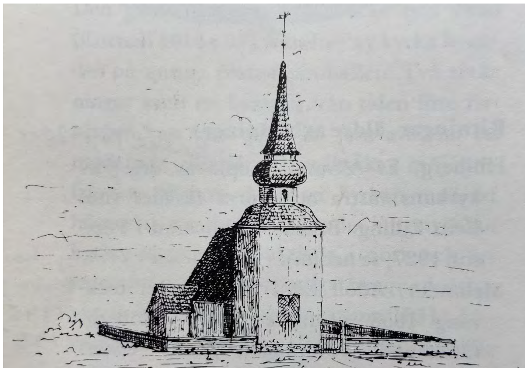
Fig. 162. Bräcke gamla kyrka, uppförd av timmer på 1580-talet, riven 1861. Sakristian tillbyggd 1650, tornet uppfört 1776 av Pål Persson i Stugun. Brädselningen utanpå kyrkan var enligt kyrkans räkenskaper gjord 1752. Från nordväst. Teckning: A. E. Melander, kopierad efter en teckning av dekorationsmålaren J. P. Moberg 1858. Föreningen Gamla Östersunds samlingar. Efter Almqvist 1984, s. 118.
