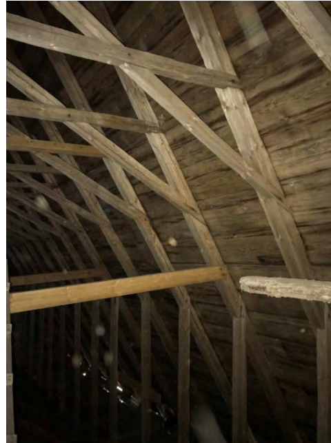
Fig. 145 a–b. Takstolarna i Ragunda gamla kyrka (t.v.) och i Lidens gamla kyrka (t.h.). Den utstickande bommen till höger i bild är en kvarsittande ställningsbom i östra gavelröstet. De ljusa plankorna är fastspikade i modern tid (och fyller egentligen ingen funktion). Ritning: Ola Storsletten & Peter Sjömar (efter Storsletten 2002). Foto: OH.
