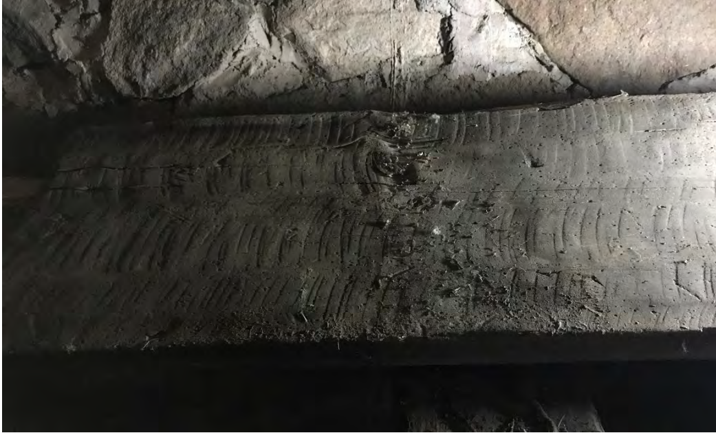
Fig. 151. F.d. golvtilja liggande på vinden i Ragunda gamla kyrka. Här den sprättäljda, nötta ovansidan. Bredd: 42–44 cm.
