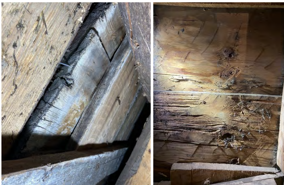
Fig. 101 a–b. Motsvarande yttertaksbrädor på koret (nuv. sakristian) i Hackås kyrka. Brädornas ändrar har tidigare mött gavelröstet på triumfbågsmuren, som numera är rivet. Brädorna har sekundärt täckts med spikade stavspån. Foton: OH.
