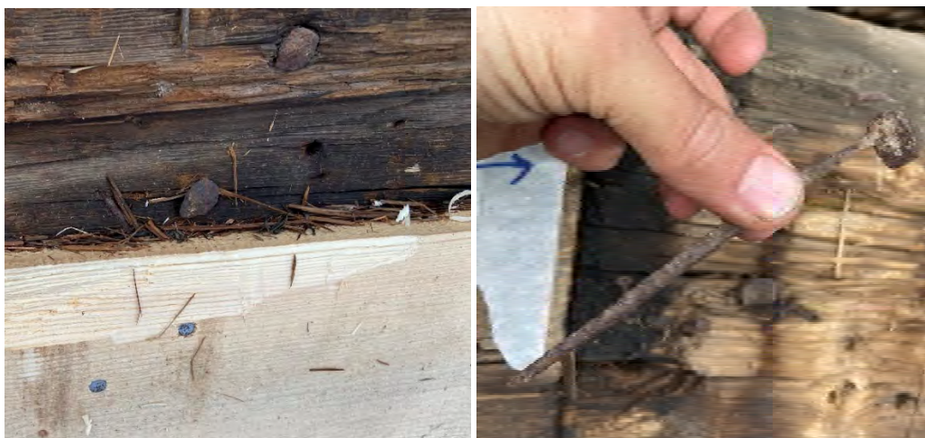
Fig. 60 a–b. T.v.: Gamla, smidda spikar som de f.d. yttertaksbrädorna S1 och S2 Ö–T7 är fästa med i en av takstolarna. – T.h.: Lös spik av samma slag i västra änden på S1. Foton: OH.
