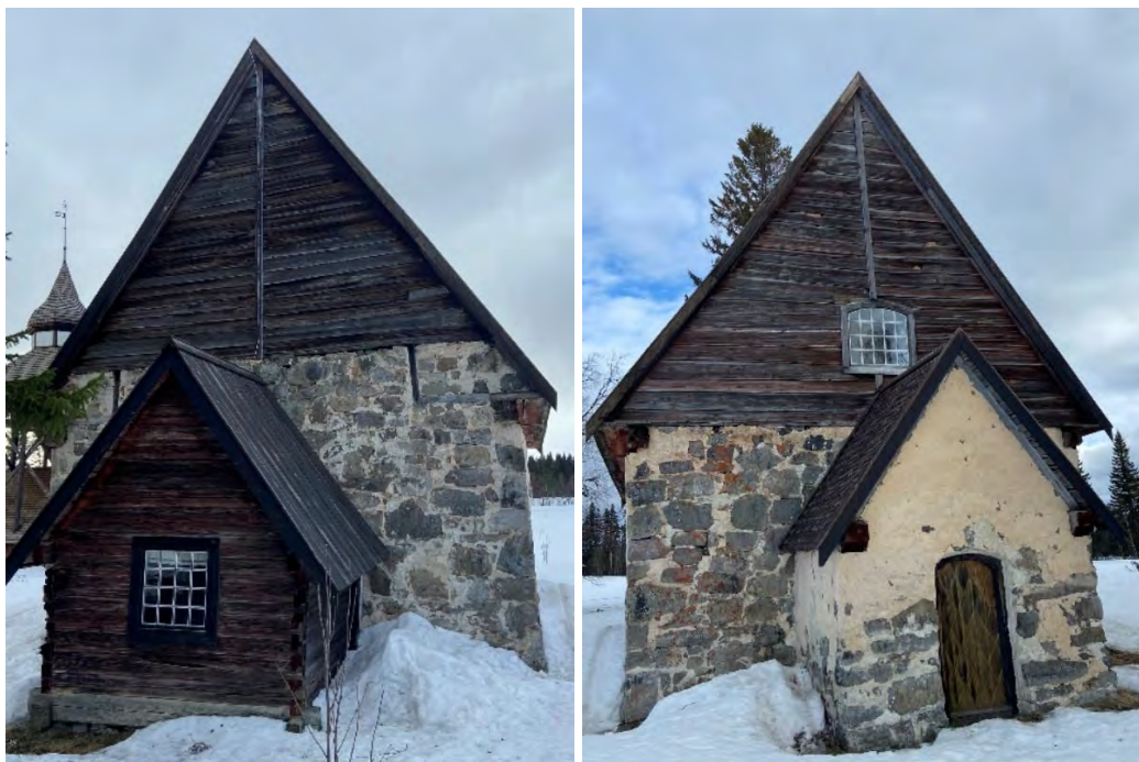
Fig. 161 a–b. Östra respektive västra gaveln på Kyrkås gamla kyrka, med murverk som slutar på olika höjd. Den timrade sakristian och det murade vapenhuset utgör senare tillbyggnader (dendrodaterade till omkr. 1673 respektive omkr. 1747, Olofsson 2008). Foton: OH.
