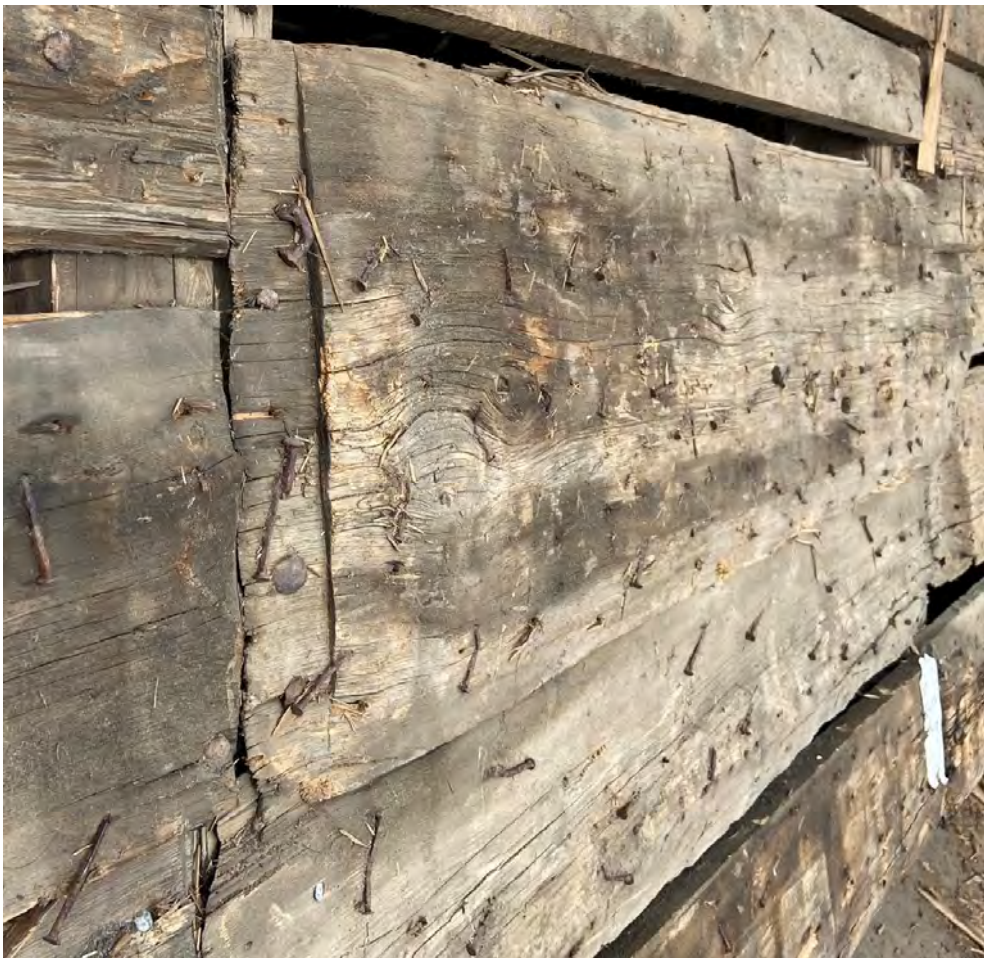
Fig. 118. Utvärdig fals i änden av plankan S3 T7–T8. Obs. att fasningen undertill i änden är sekundär, gjord vid monteringen på 1520-talet. Plankans utsida är bitvis mycket välbehållen, vilket skulle kunna förklaras av att den från början har varit skyddad under ett lager med tjära, likt den gamla yttertaksbrädan som skymtar till vänster i bild (S3 T8–T11).
