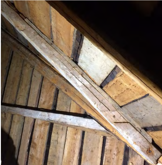
Fig. 53 a–b. Bjälke nr 1 i Hallens kyrka i jämförelse med takstolstypen i Ragunda gamla kyrka. Fotot är här vridet så att urtaget är riktat horisontellt på bilden, detta för att illustrera att bjälken kan vara en del av en ursprunglig saxsparre i en takstol av samma typ som i Ragunda. Ritning: Ola Storsletten & Peter Sjömar (efter Storsletten 2002).
