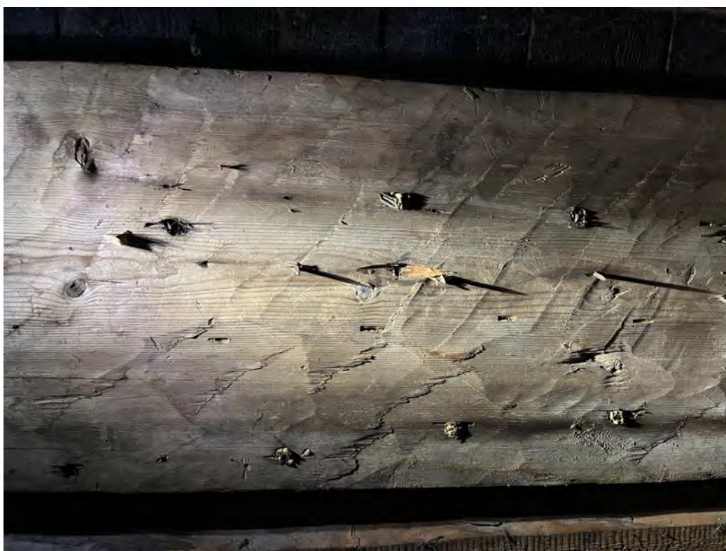
Fig. 55. Äldre undertaksbräda i Hallens kyrka med spår av såväl en pluggad spåntäckning som en eller två spikade spåntäckningar äldre än den nuvarande spåntäckningen (vars spikar ses i mitten av brädan). Foto: OH.
