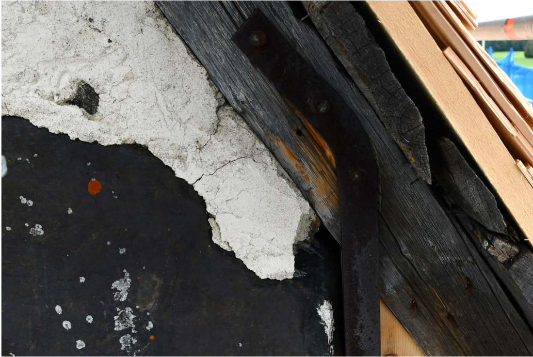
Figur 17 Man lyckades få högenet i rätt läge. Det vilar nu mot murkrönet igen.
