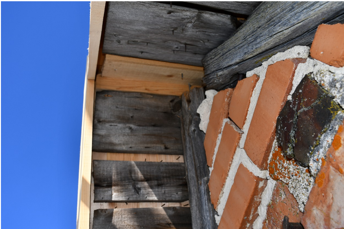
Figur 18 Västra gaveln efter åtgärd.
