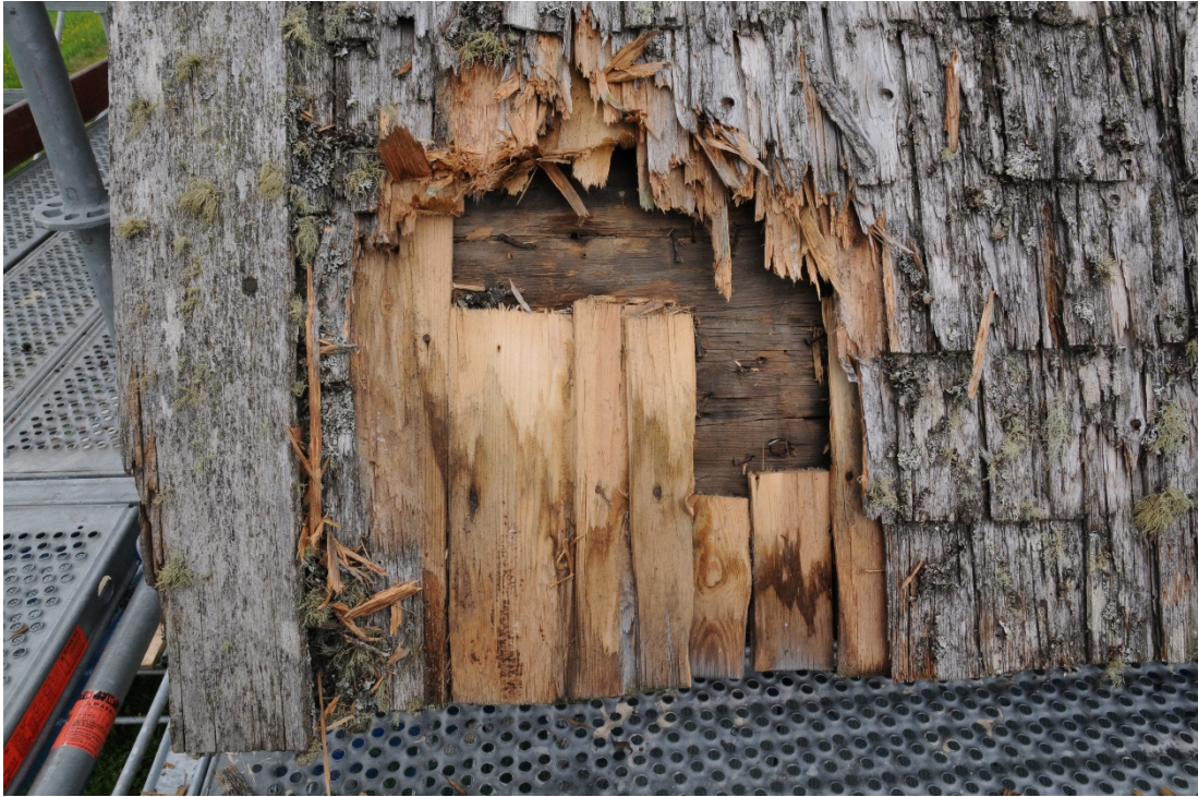
Figur 5 Vid takfoten låg först en rad med 1/3-dels spån kant i kant. Sedan en rad med 2/3-dels spån lagts överlappande från vänster till höger. Därefter fulllånga spån från vänster till höger.
