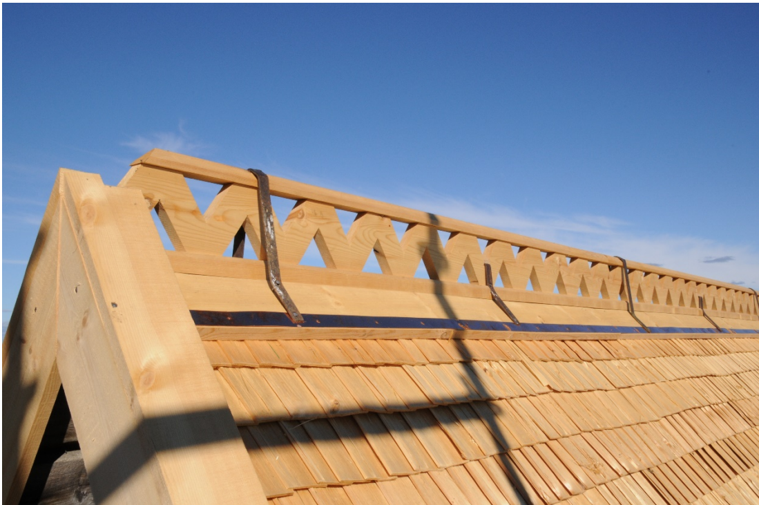
Figur 10 Takkam efter åtgärd.
