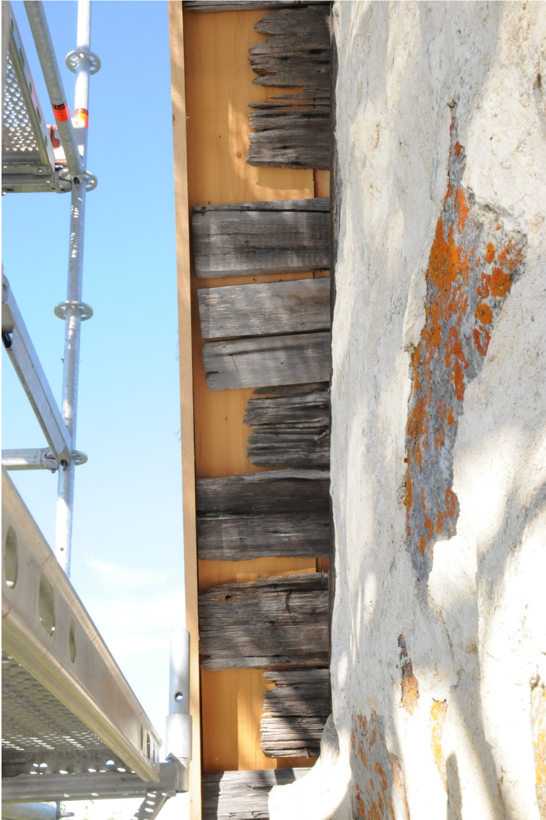
Figur 19 Takutsprång mot nordväst efter åtgärd.
