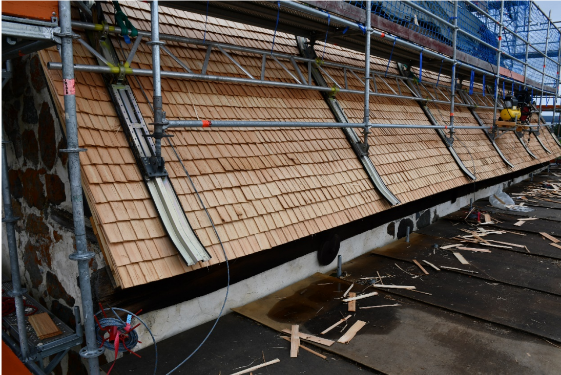
Figur 7 Vid spånläggningen användes en byggställning på medar.
