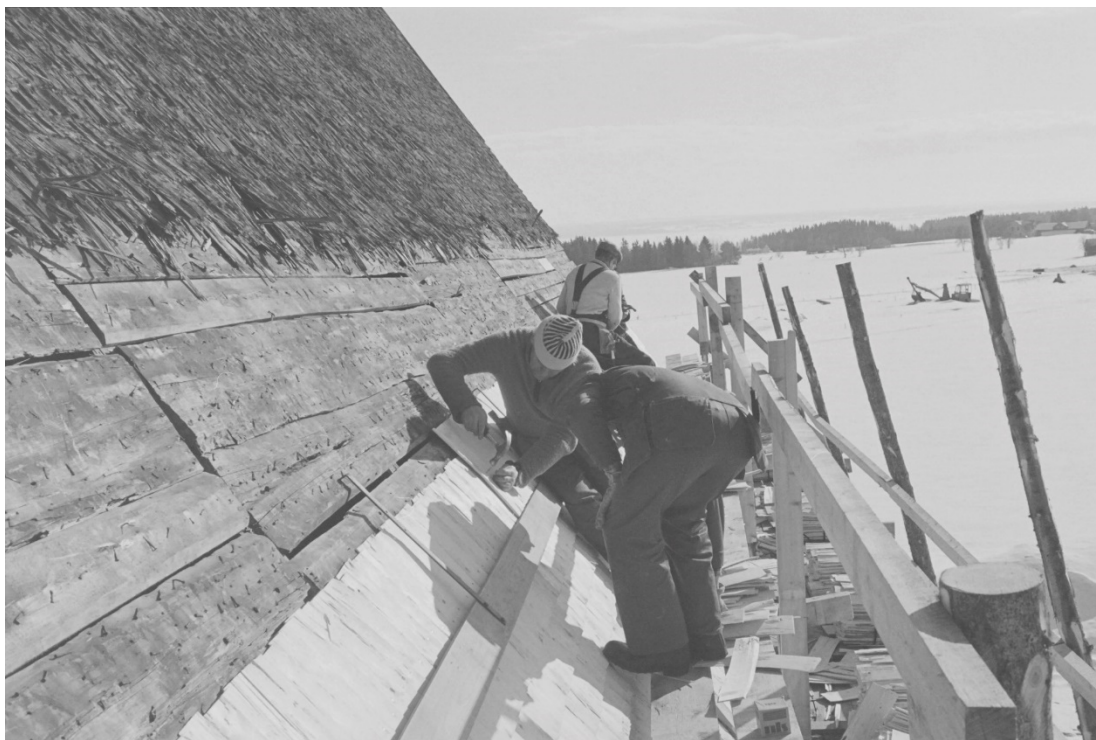
Figur 2 Omläggning av taket på Marby gamla kyrka 1982 Foto: Jörgen Schwartzkopf, Jämtlands läns museum (JLM 82 S 24/28).
