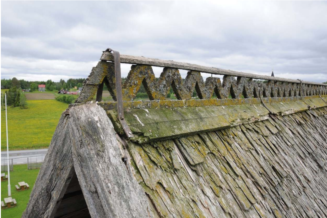
Figur 9 Takkam före åtgärd.
