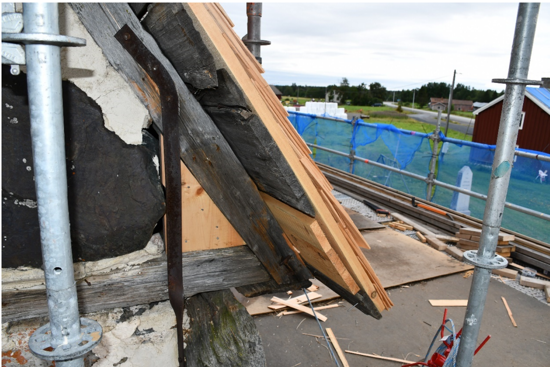
Figur 14 Hålet i sydvästra hörnet fylldes igen med trä.
