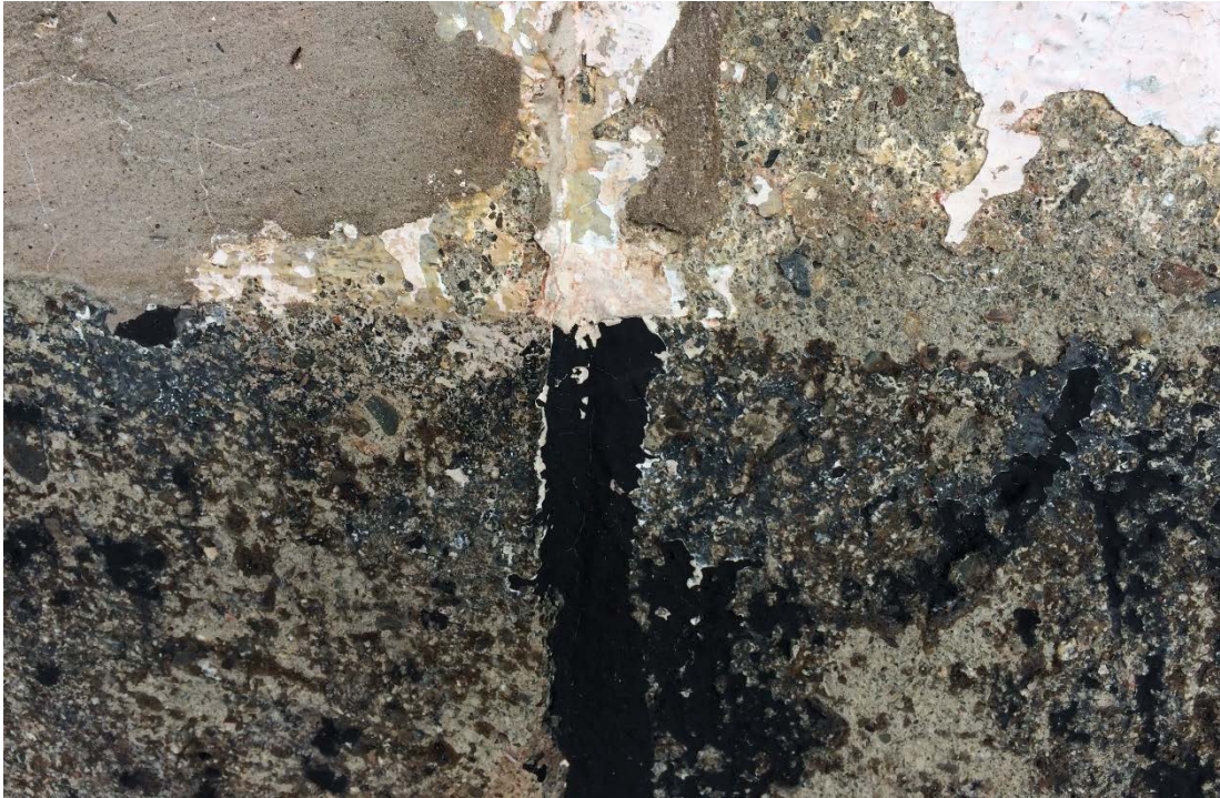
Figur 15 Detalj av sockel efter rengöring.
