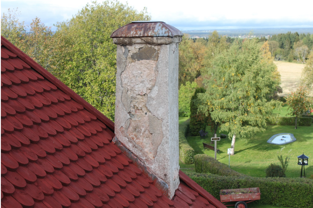
Figur 31 Skorsten på sakristia före åtgärd.
