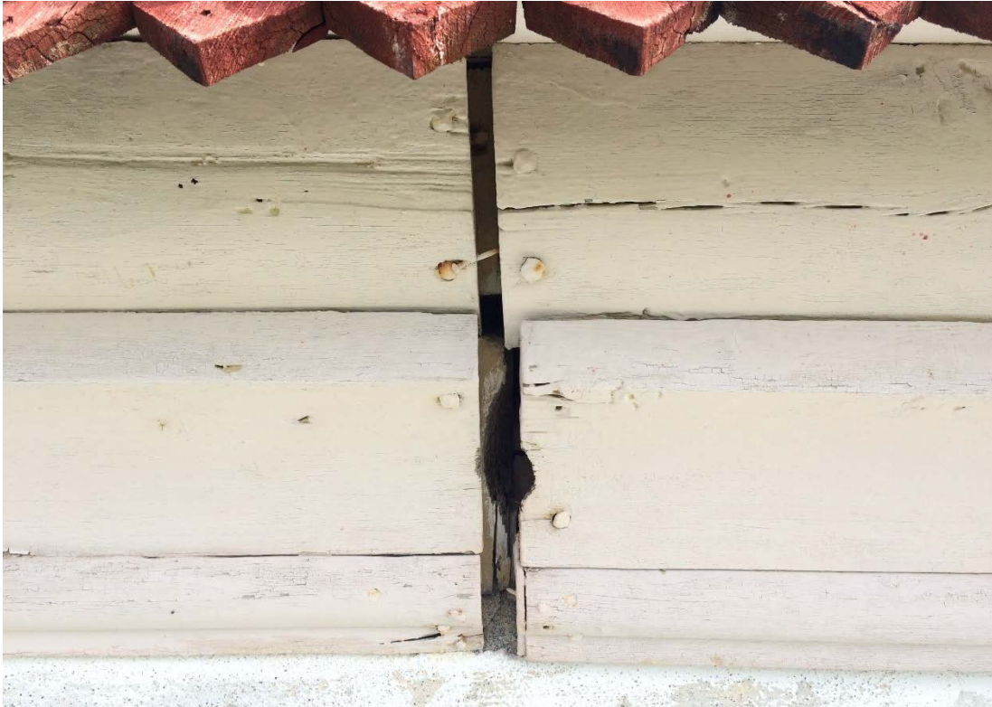
Figur 21 I skarvarna hade det på vissa ställen ramlat bort smala passbitar.
