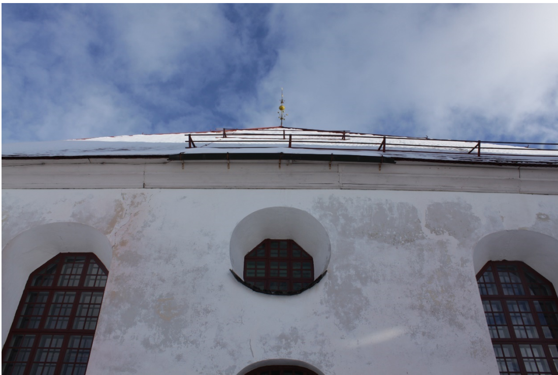
Figur 4 Detalj av västra fasaden före åtgärd.
