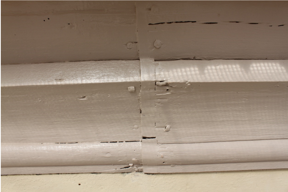
Figur 23 I skarvarna fylldes de värsta gliporna i med nya passbitar.
