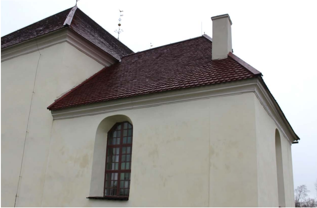
Figur 13 Mötet mellan långhus och sakristia efter åtgärd.
