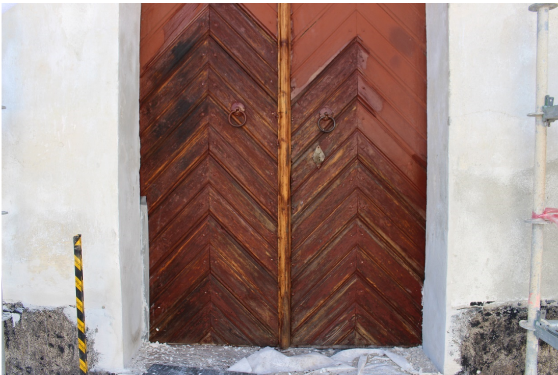
Figur 26 Dörr mot väster under pågående arbete.
