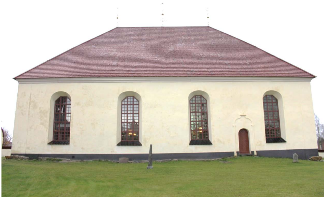
Figur 12 Södra fasaden efter åtgärd.
