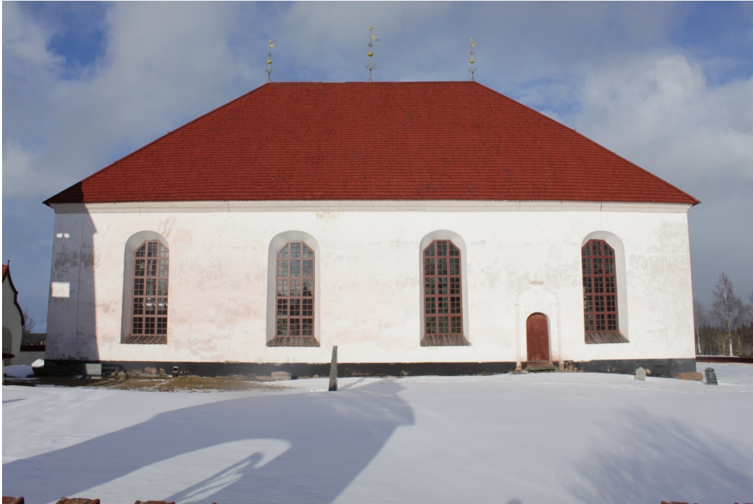
Figur 5 Södra fasaden före åtgärd.
