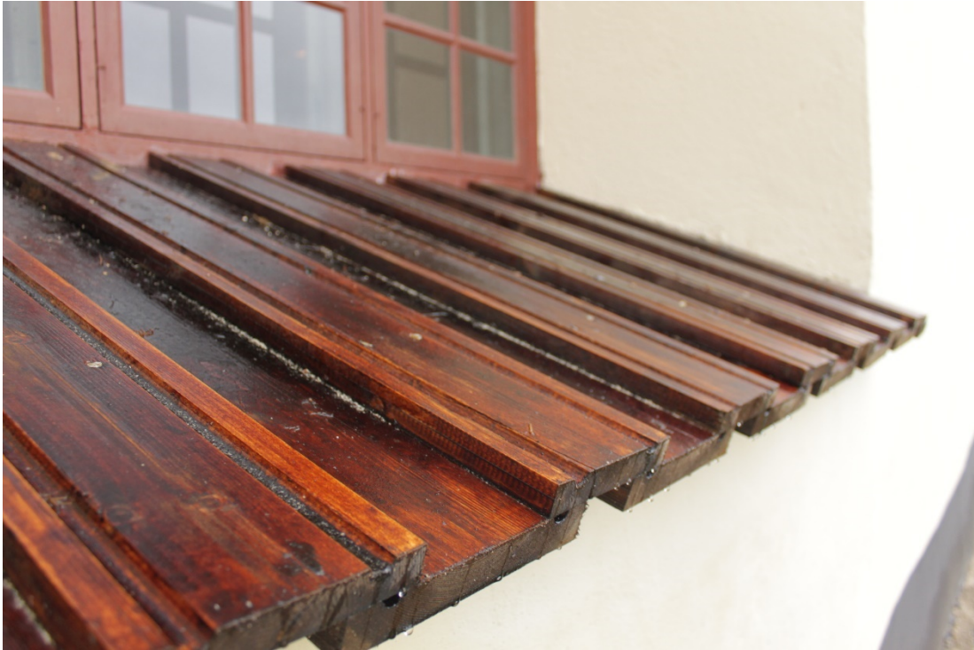
Figur 19 Solbänk efter åtgärd.
