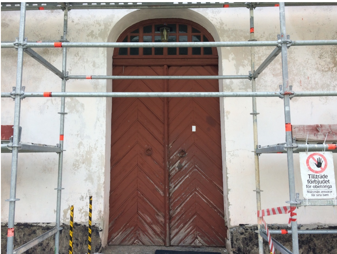
Figur 24 Dörr mot väster före åtgärd.
