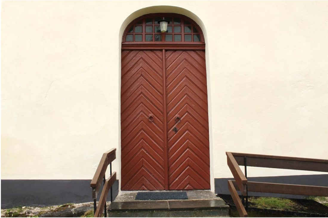
Figur 27 Dörr mot väster efter åtgärd.
