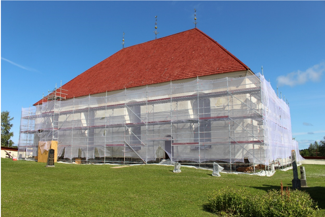
Figur 9 Ovikens kyrka under pågående arbete.
