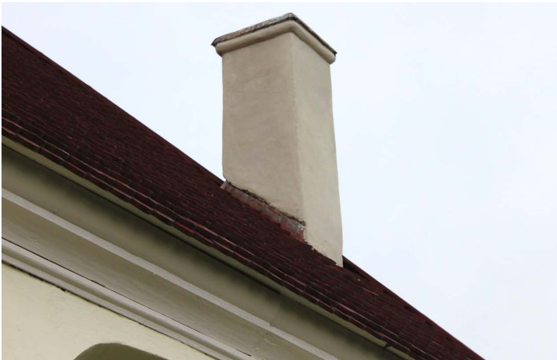
Figur 32 Skorsten på sakristia efter åtgärd.
