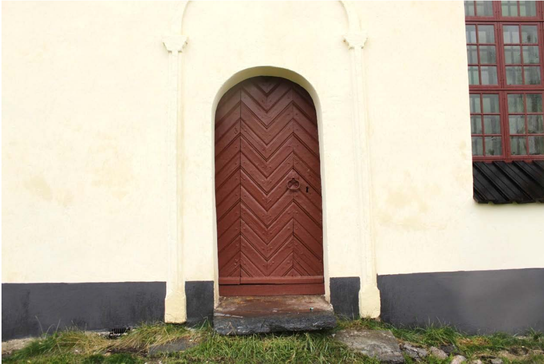
Figur 29 Dörr mot söder efter åtgärd.
