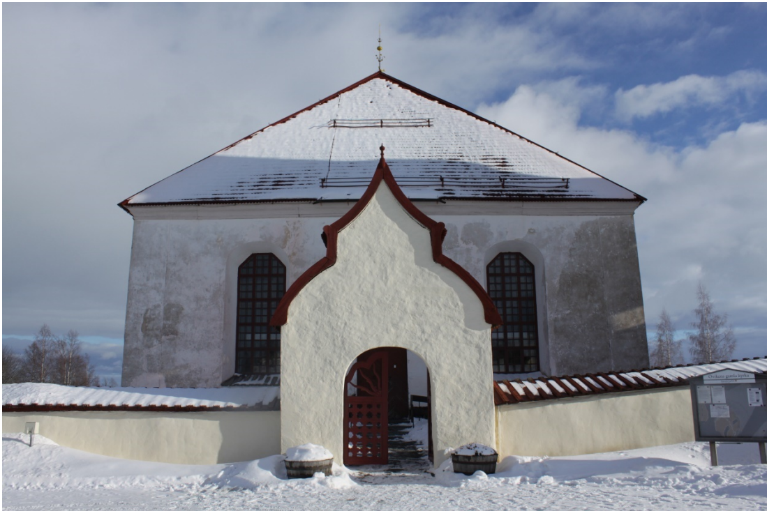
Figur 3 Västra fasaden före åtgärd.
