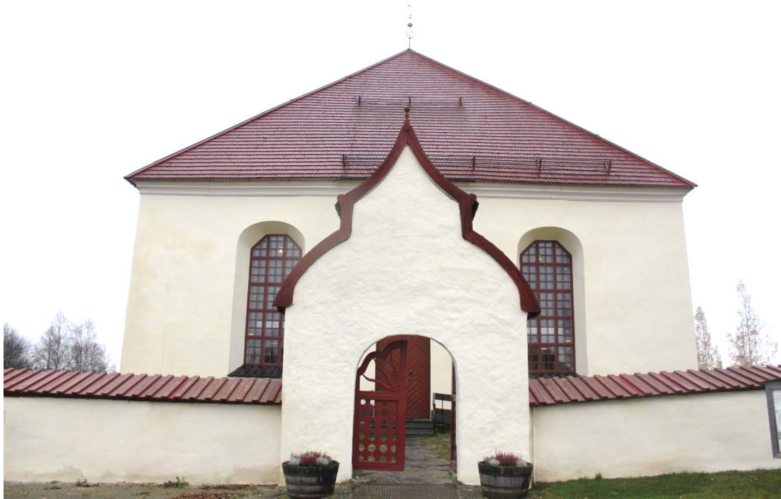
Figur 11 Västra fasaden efter åtgärd.
