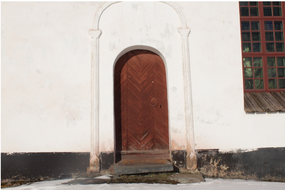
Figur 28 Dörr mot söder före åtgärd.
