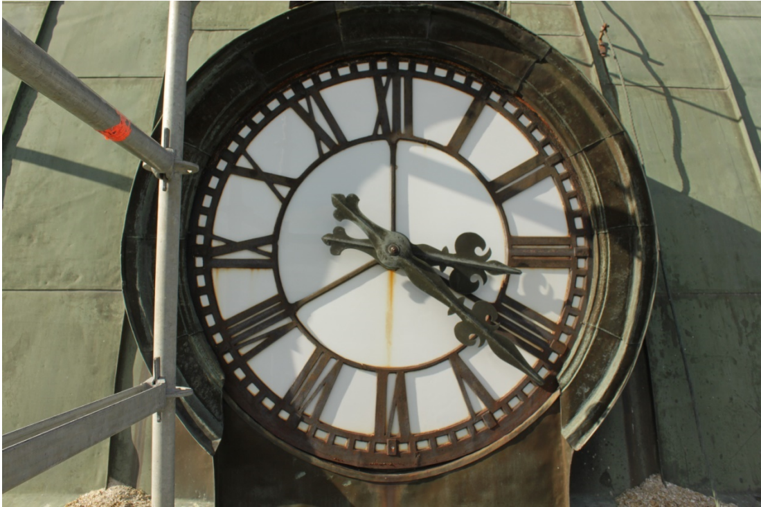
Figur 18 Urtaula mot öster före åtgärd.
