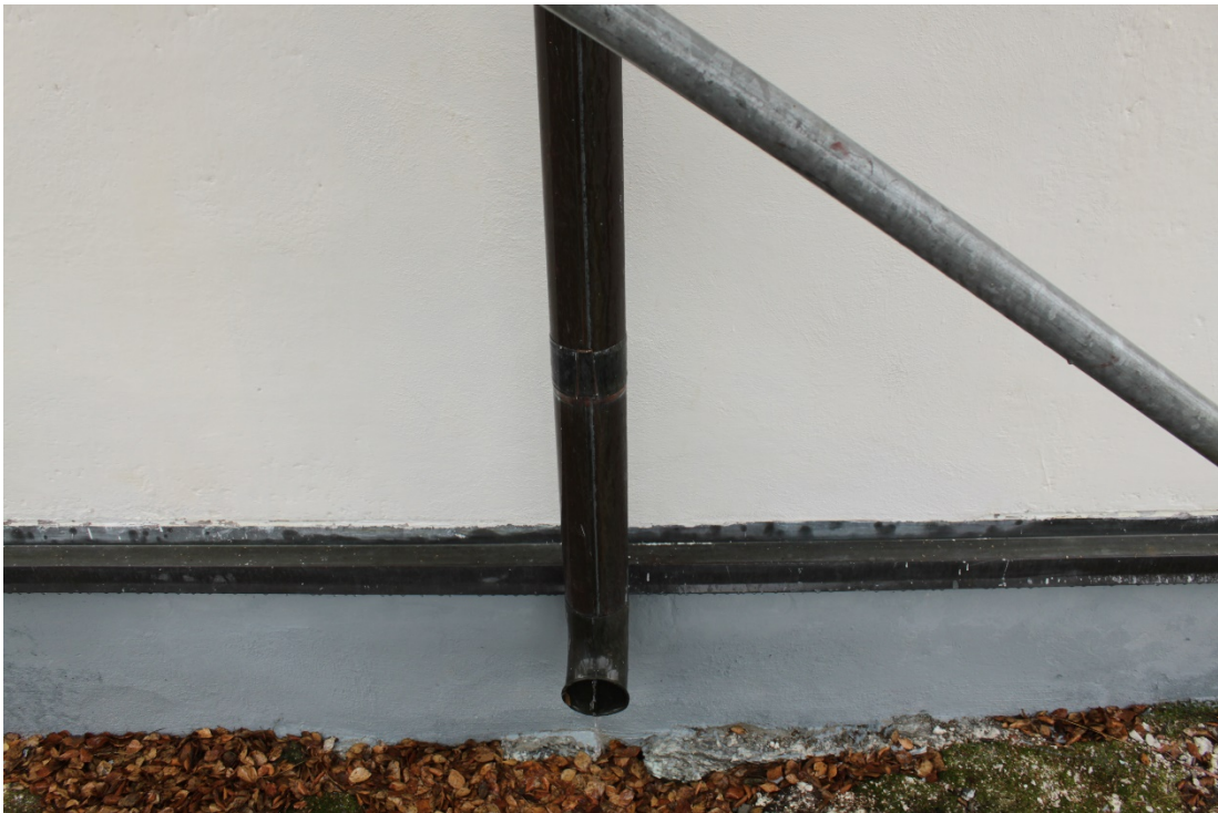
Figur 7 Stuprör på norra sidan efter åtgärd.
