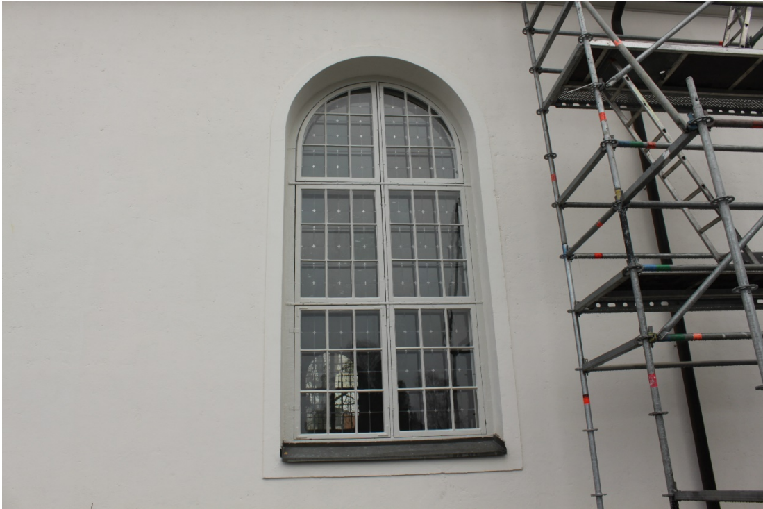
Figur 10 Fönster efter åtgärd.
