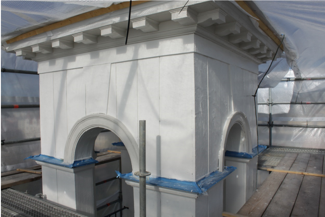
Figur 24 Övre del av lanternin under pågående målning.
