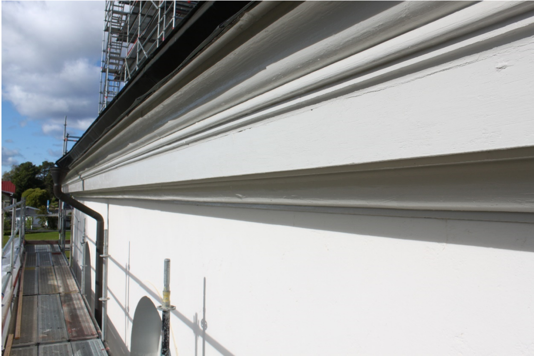
Figur 30 Taklisten efter åtgärd.
