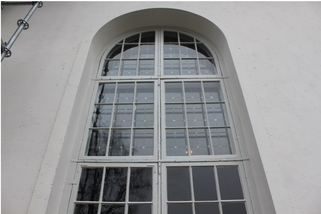
Figur 11 Fönster efter åtgärd.
