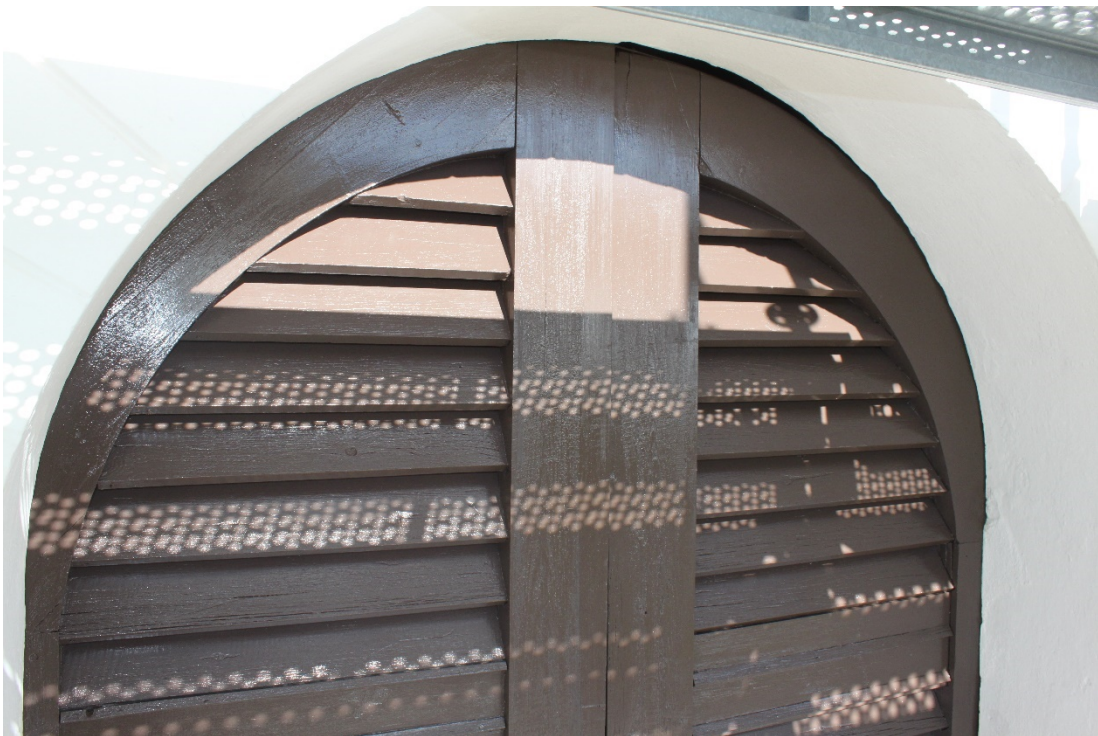
Figur 17 Ljudluckor efter åtgärd.
