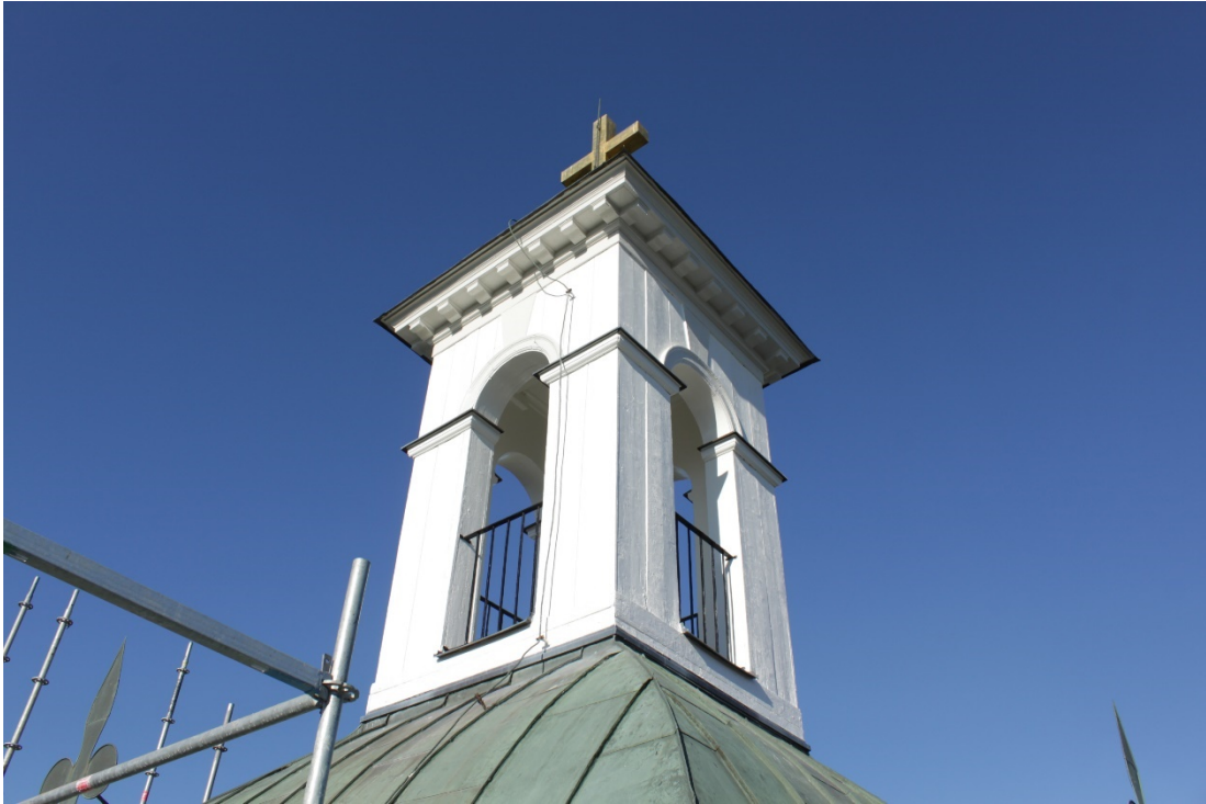
Figur 26 Lanternin efter åtgärd. Notera de grå listverken mot den vita fasaden.
