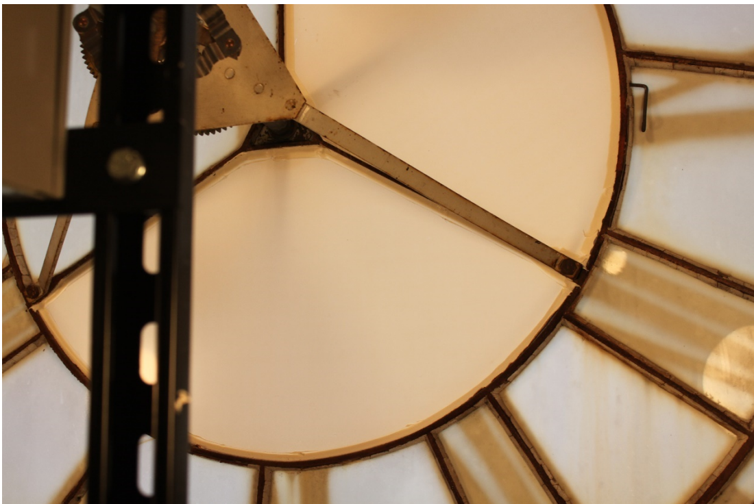
Figur 21 Urtavla mot söder efter åtgärd. Två rutor har bytts ut.
