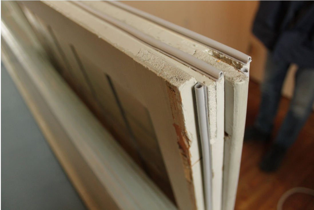
Figur 12 Innerbågarna har försetts med tätningslist.
