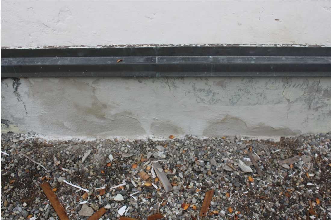
Figur 32 Lagning av putsckador på sockeln innan avfärgning.
