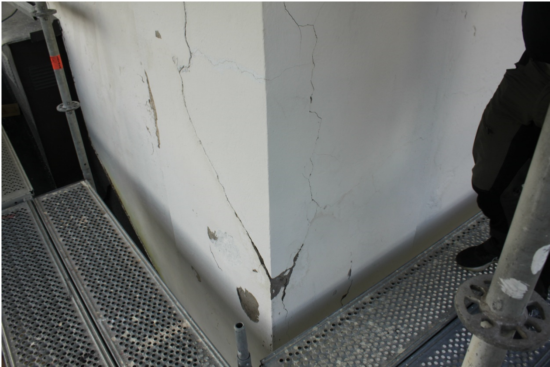
Figur 2 I det nordöstra hörnet på tornet förekom putsskador.
