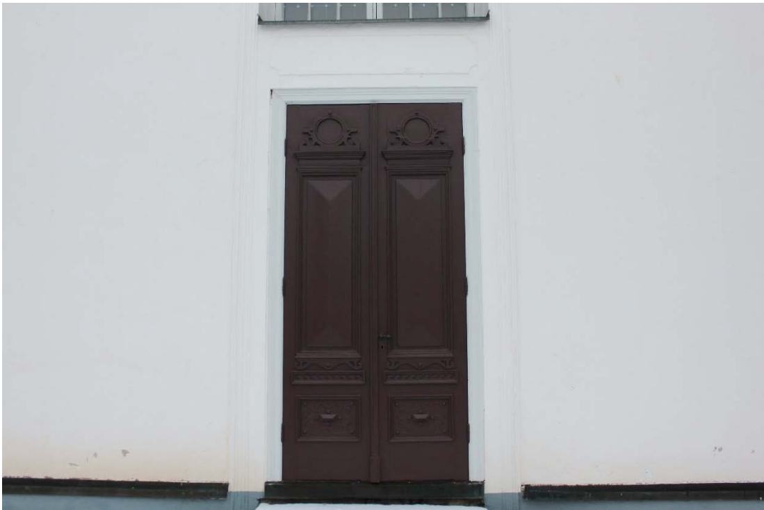
Figur 15 Dörr mot söder efter åtgärd.
