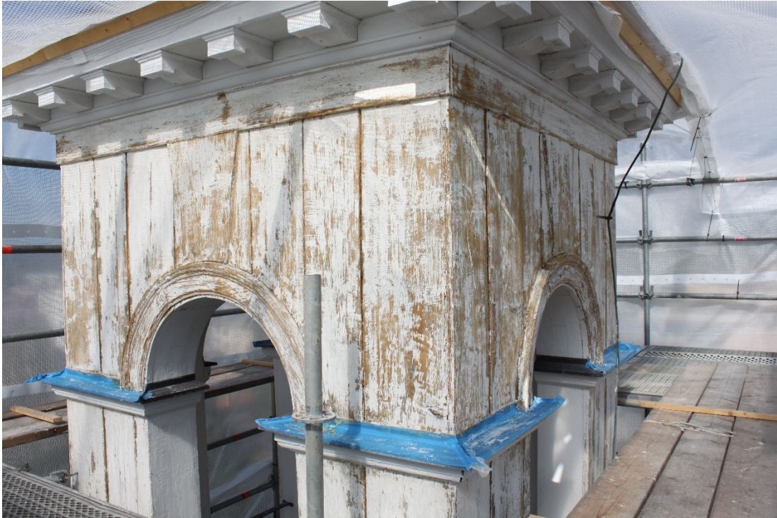
Figur 22 Lanternin under pågående skrapning.
