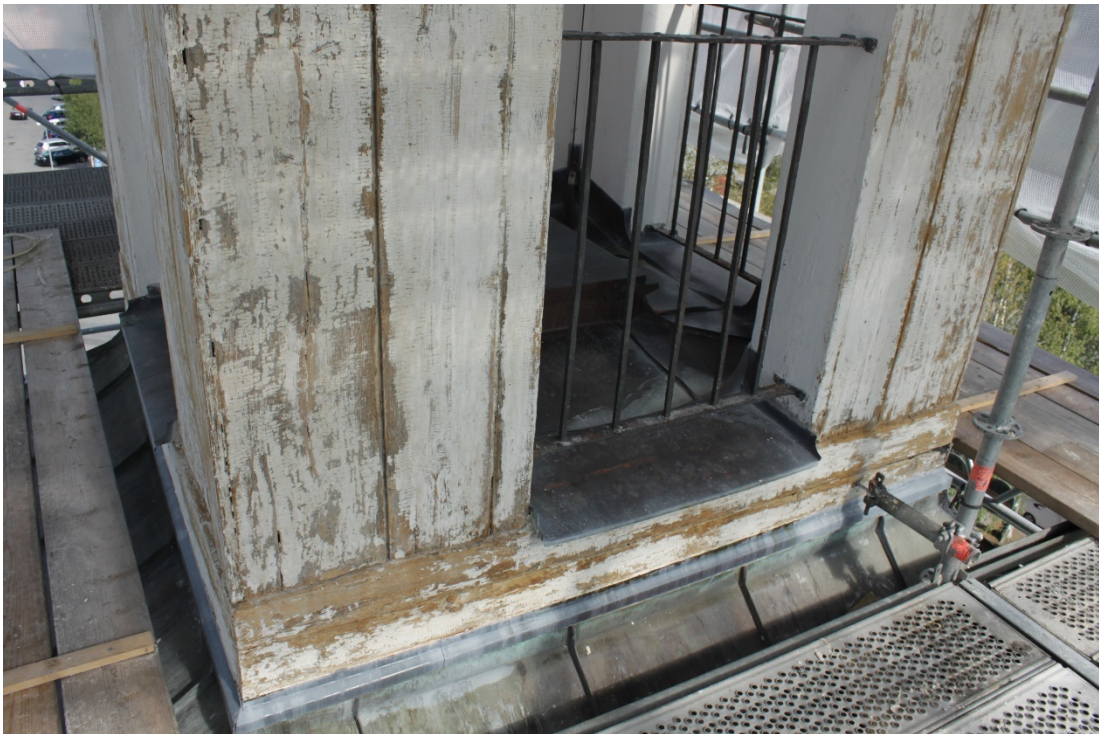
Figur 23 Nedre del av lanternin under pågående skrapning.
