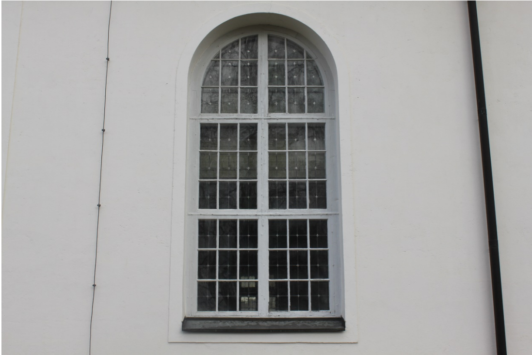
Figur 8 Fönster före åtgärd.
