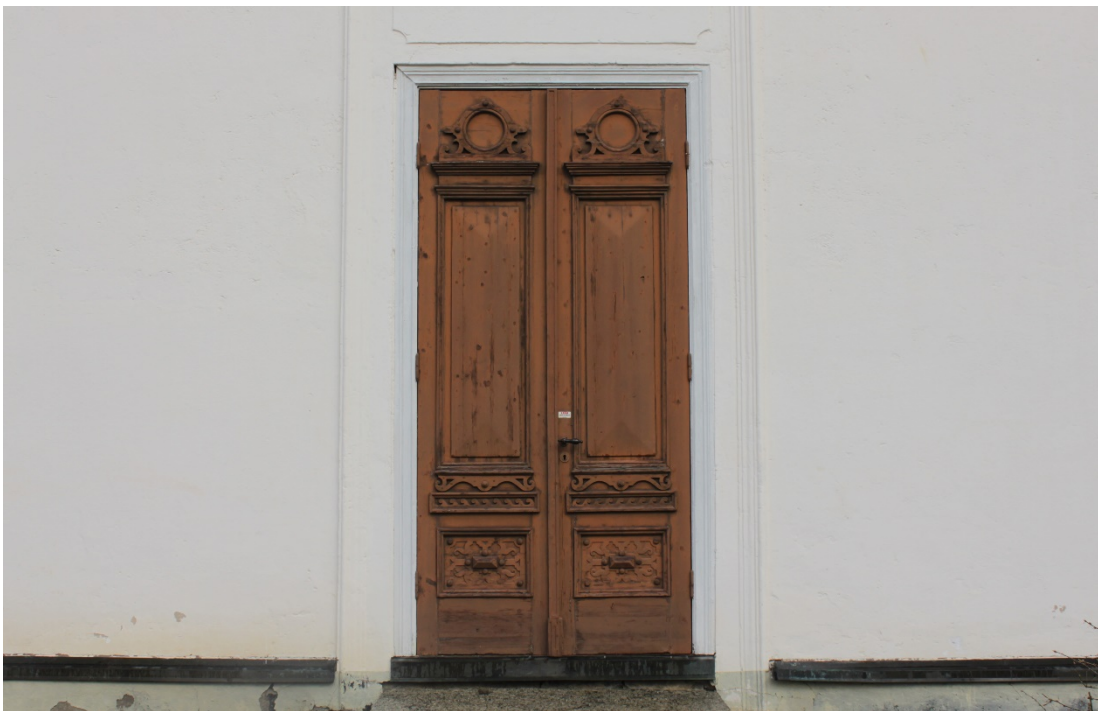
Figur 13 Dörr mot söder före åtgärd.
