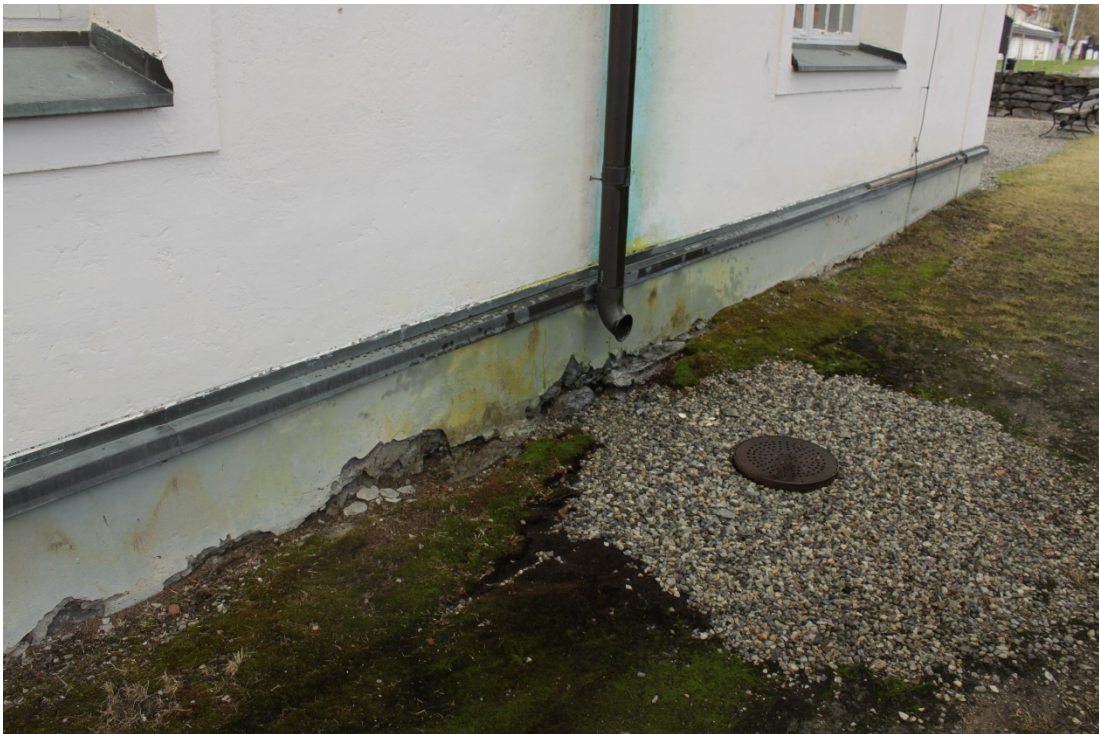
Figur 31 På sockeln förekom putsbortfall och färgen flagade.
