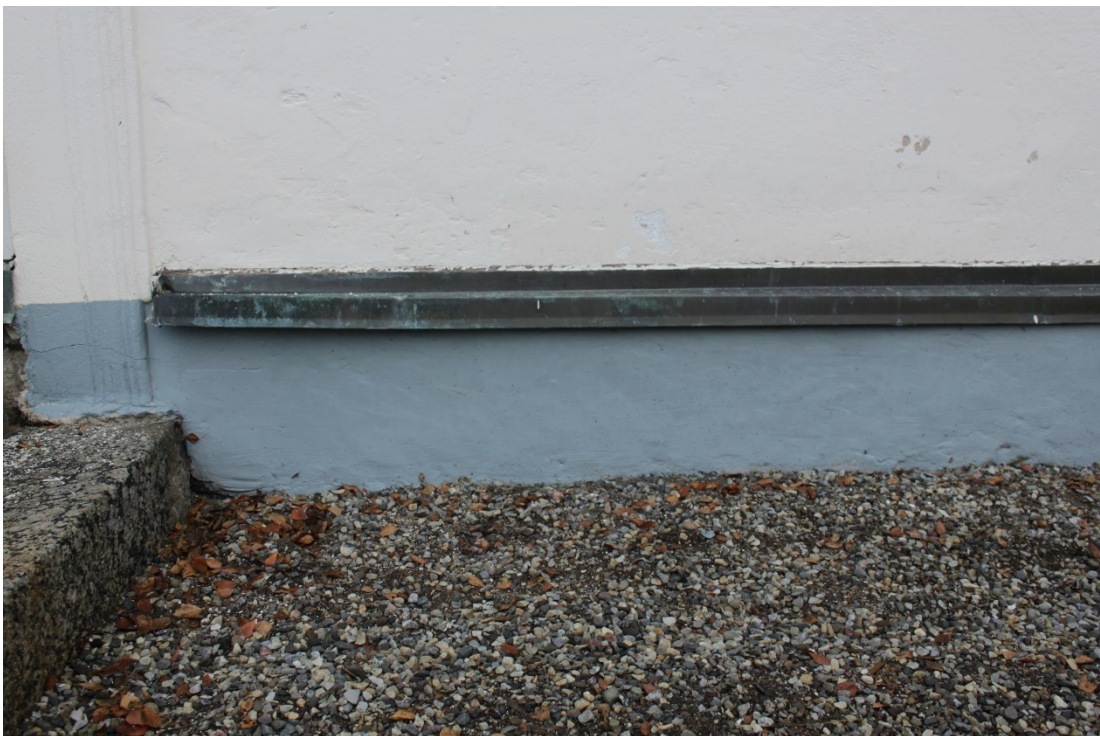
Figur 33 Sockeln efter åtgärd.
