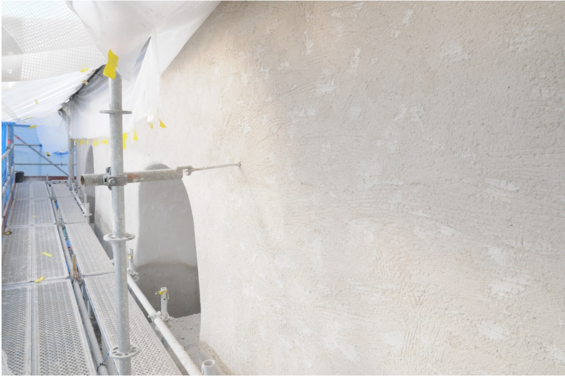
Figur 10 Fasaden efter två putslager.
