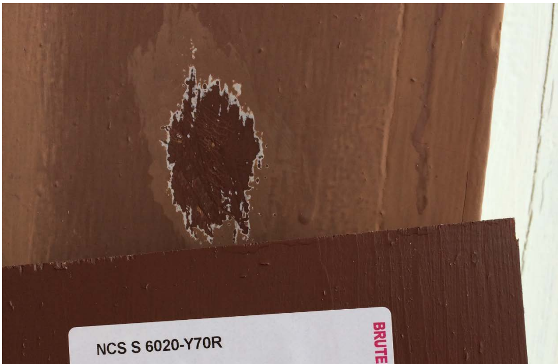
Figur 19 Jämförelse mellan framskrapad kulör och uppstrykningsprov.
