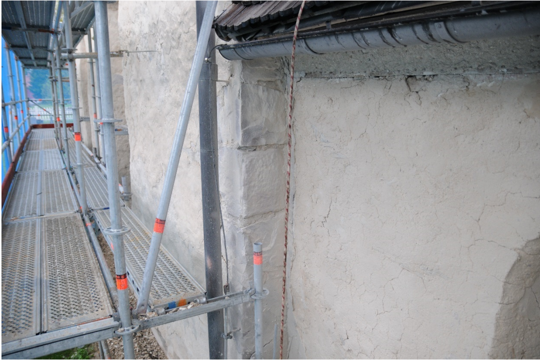
Figur 8 I långhusets nordöstra hörn framträdde efter blästring huggna stenblock.
