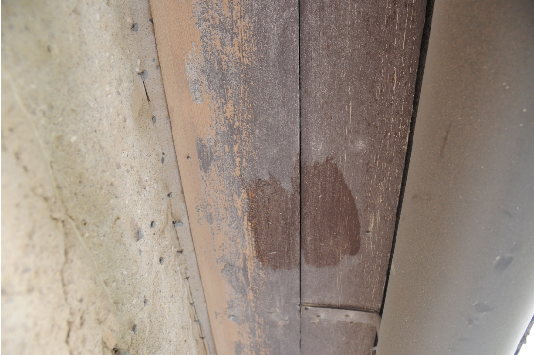
Figur 26 Takfotsinbrädning efter blästring av fasaden.
