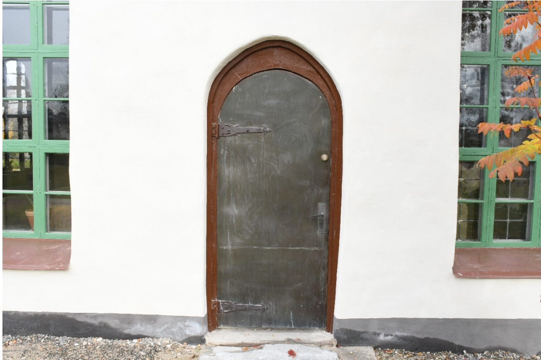
Figur 22 Dörr mot söder efter åtgärd.
