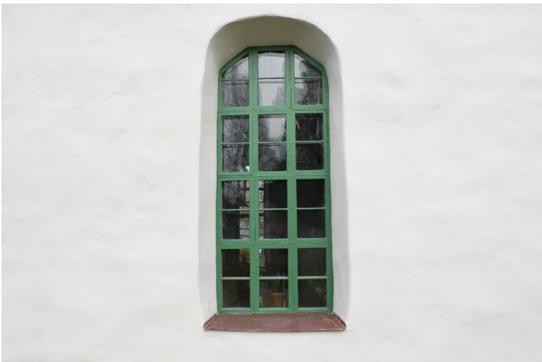
Figur 25 Fönster efter åtgärd.
