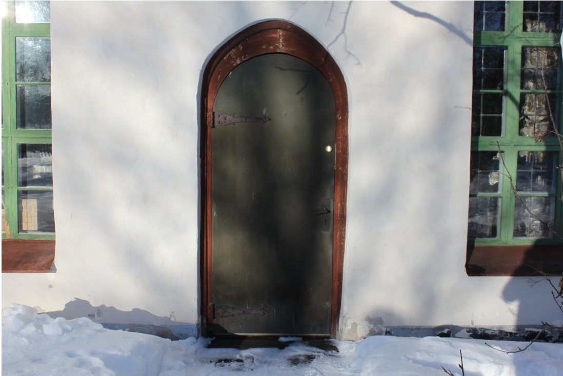
Figur 20 Dörr mot söder före åtgärd.
