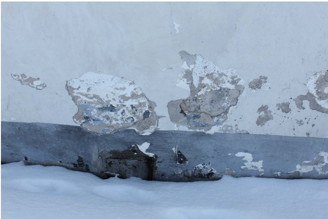
Figur 3 Putsbortfall visade flera olika putslager.
