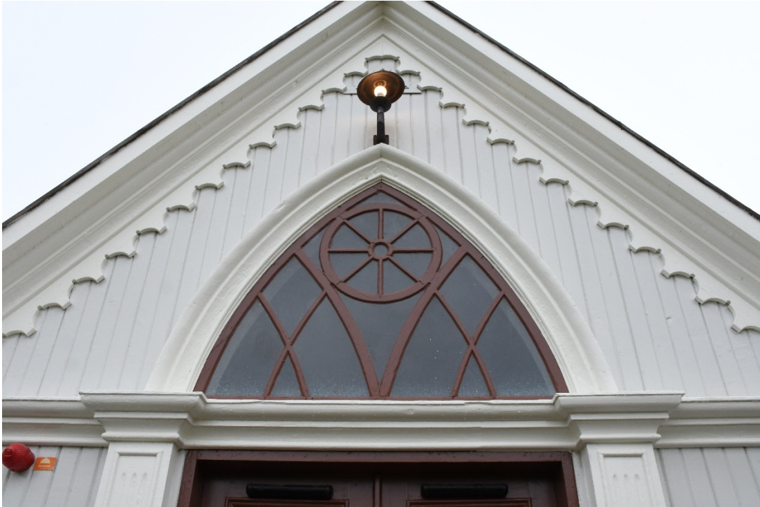
Figur 18 Parti ovanför dörren efter åtgärd.
