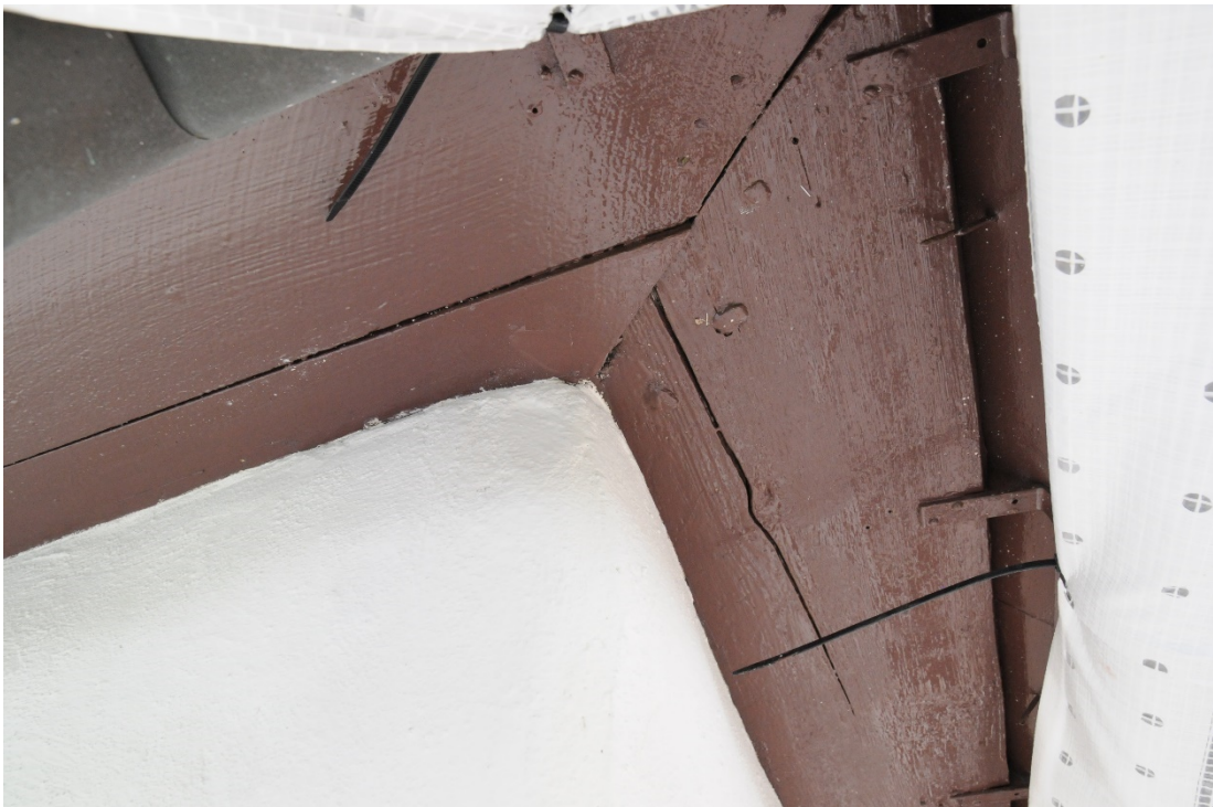
Figur 27 Takfotsinbrädning efter åtgärd.
