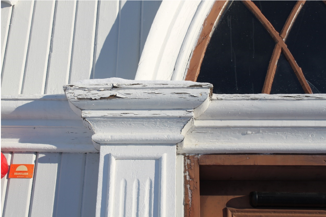
Figur 14 Färgbortfall förekom framför allt på listverken ovanför dörren.
