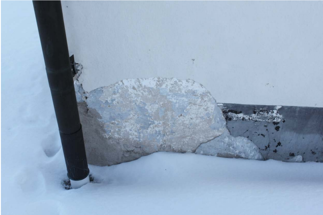
Figur 4 Nedtill framträdde äldre sockelmarkeringar under putsen.
