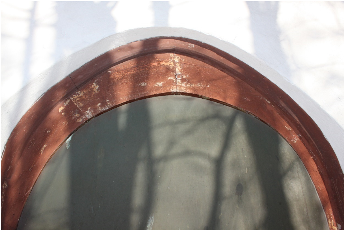
Figur 21 Dörrkarmens färglager var slitet med färgbortfall.
