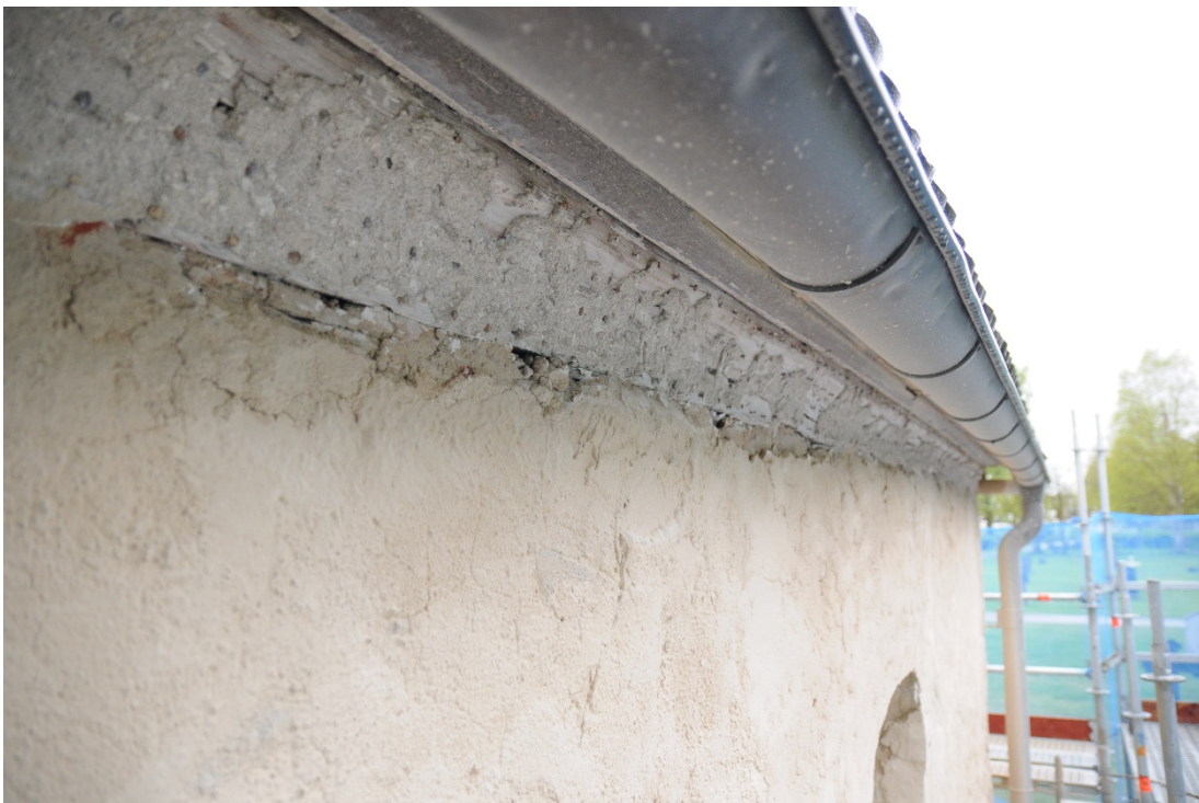
Figur 9 Sakristia efter blästring. På sakristian framträdde en taklist i trä under putsen. Den var profilerad i form av en S-sväng.
