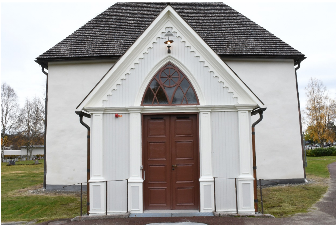
Figur 17 Vapenhus efter åtgärd.
