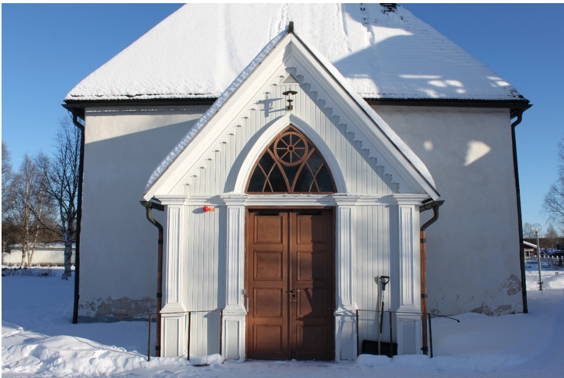
Figur 13 Vapenhuset före åtgärd.
