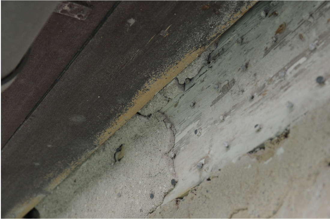
Figur 6 Efter blästring framträdde hammarbandet på murkrönet. Det har längre tillbaka varit synligt, då det förekom vit färg på timret.
