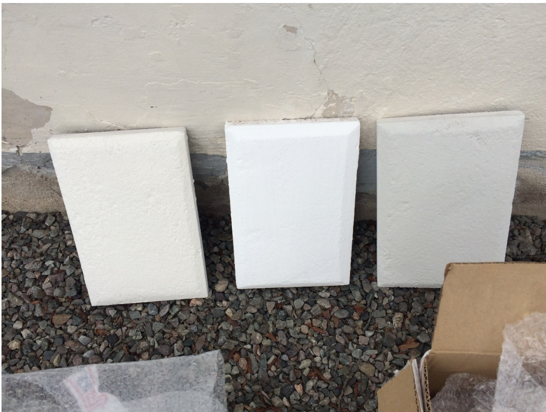
Figur 5 Tre kulörprov togs fram för avfärgning av putsen utifrån befintlig avfärgning. 7104 (till vänster i bild) låg nära den tidigare avfärgningen, varför den valdes som kulör för fasaden.
