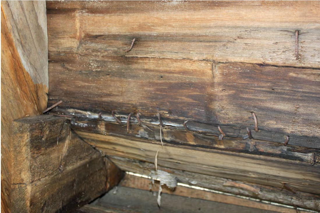
Figur 29 Invändigt i huv/spira förekom rötskador.
