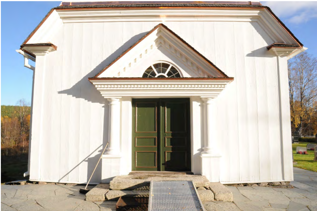
Figur 12 Entré efter åtgärd.
