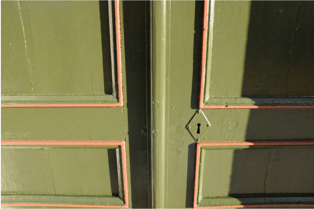
Figur 13 Närbild dörr efter åtgärd.
