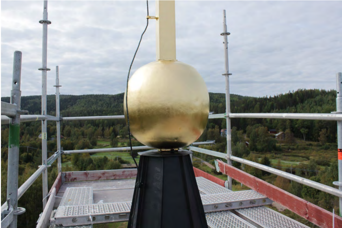
Figur 35 Anslutning mellan spira och korsglob efter åtgärd.
