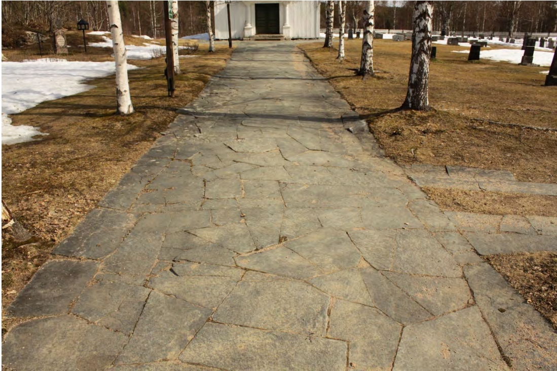
Figur 41 Gång från grinden mot kyrkan före åtgärd.
