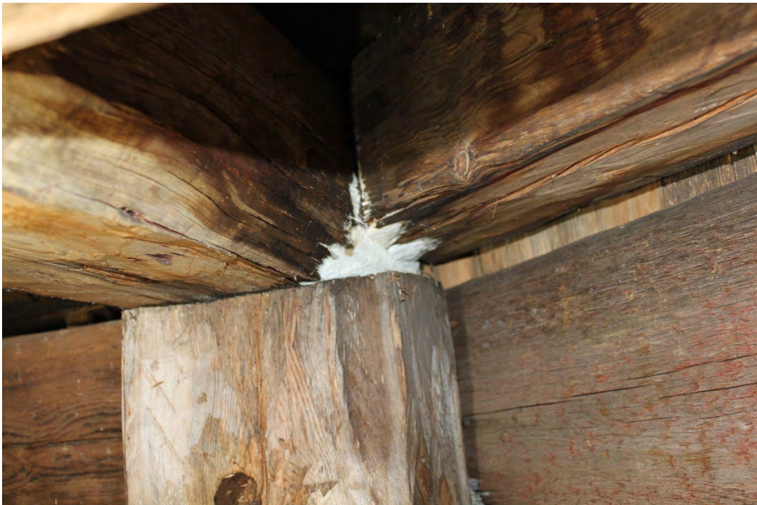
Figur 30 Påväxt i träkonstruktionen.
