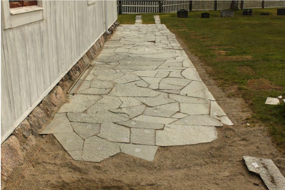
Figur 39 Stengången märktes upp innan stenarna plockades bort, för att kunna lägga tillbaka dem igen.
