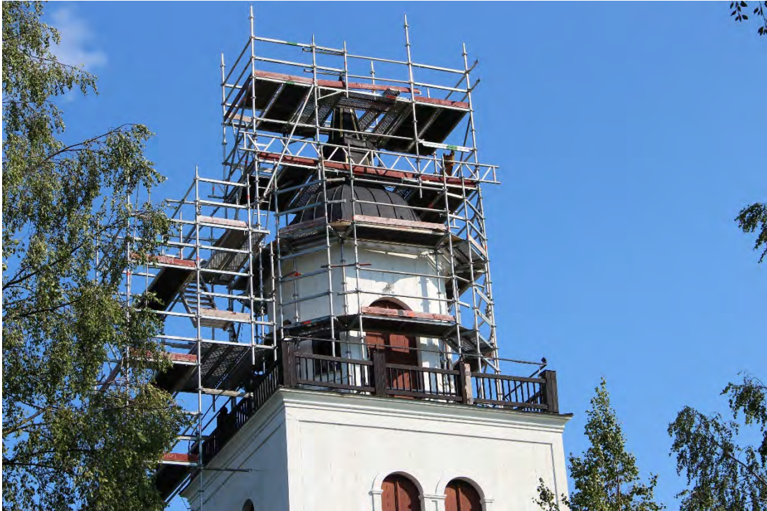
Figur 25 Lanternin under pågående arbete.
