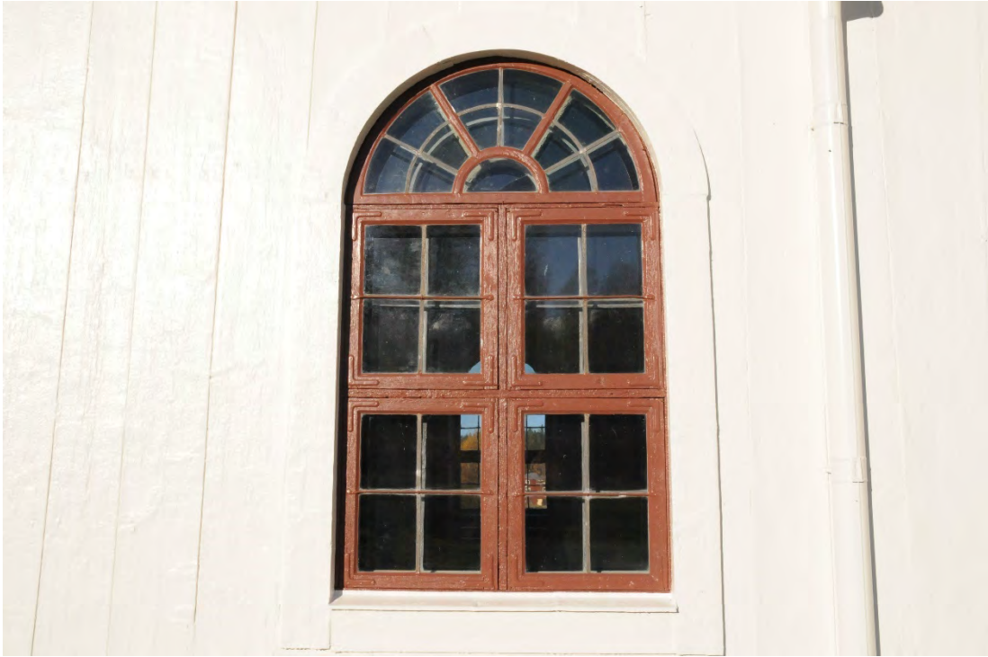
Figur 15 Fönster efter åtgärd.
