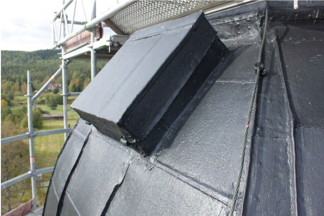
Figur 33 Taklucka efter åtgärd.
