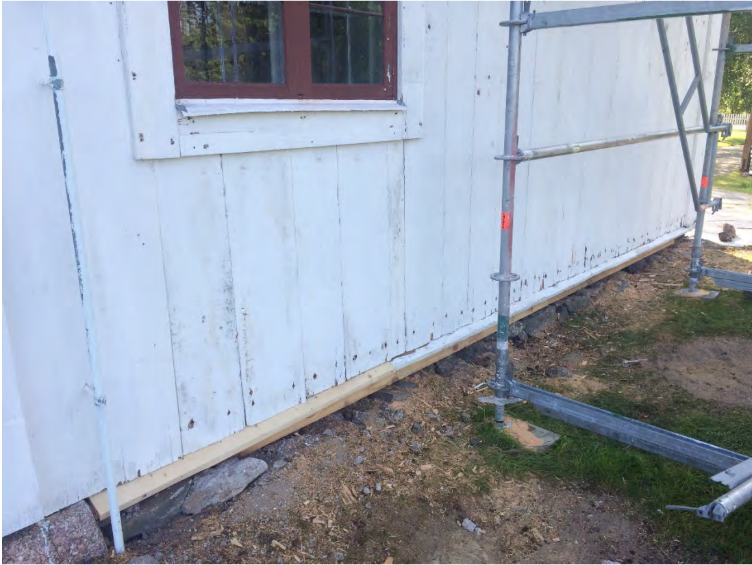
Figur 7 Norra sidan på tornet efter att panelen kommit på plats igen.
