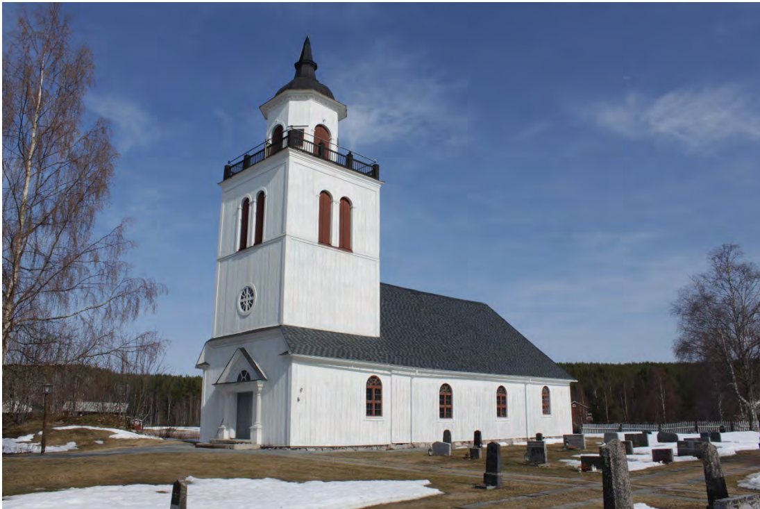
Figur 3 Överhogdals kyrka före åtgärd.
