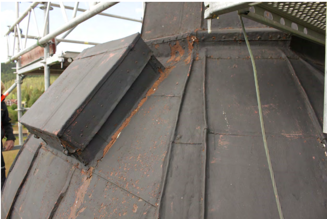
Figur 28 Lucka på tornhuv före åtgärd.
