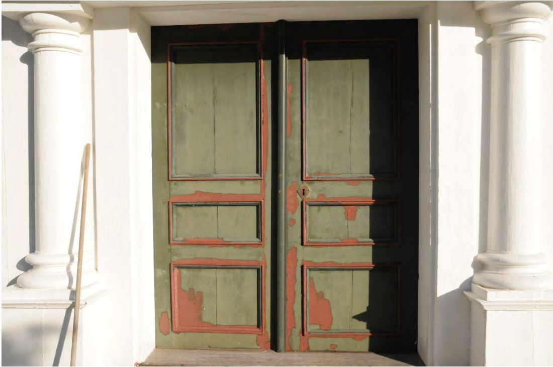
Figur 11 Dörrar under pågående målning.
