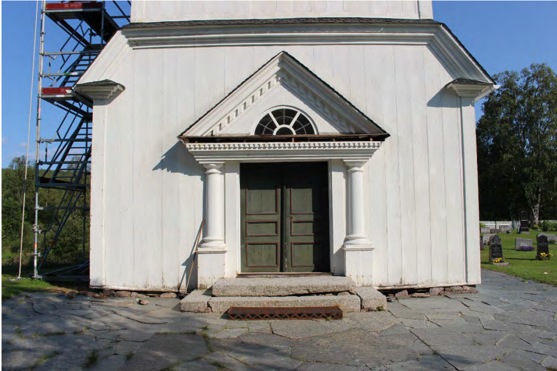
Figur 9 Entré före åtgärd.
