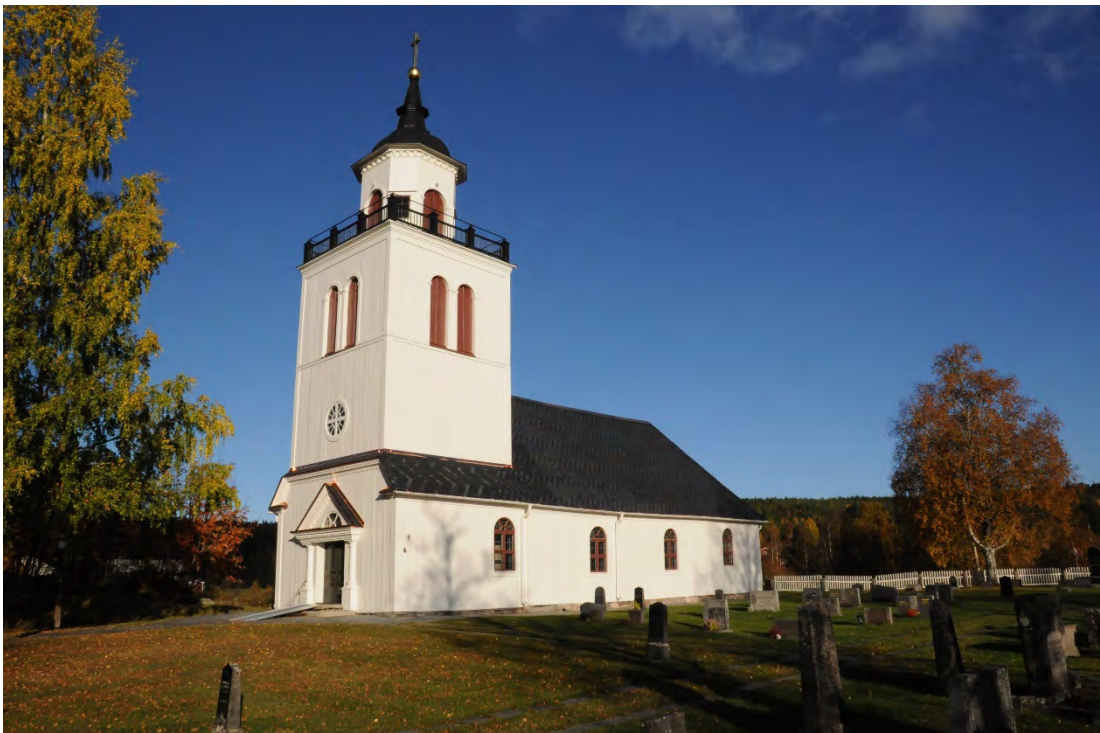
Figur 44 Överhogdals kyrka efter åtgärd 2022.
