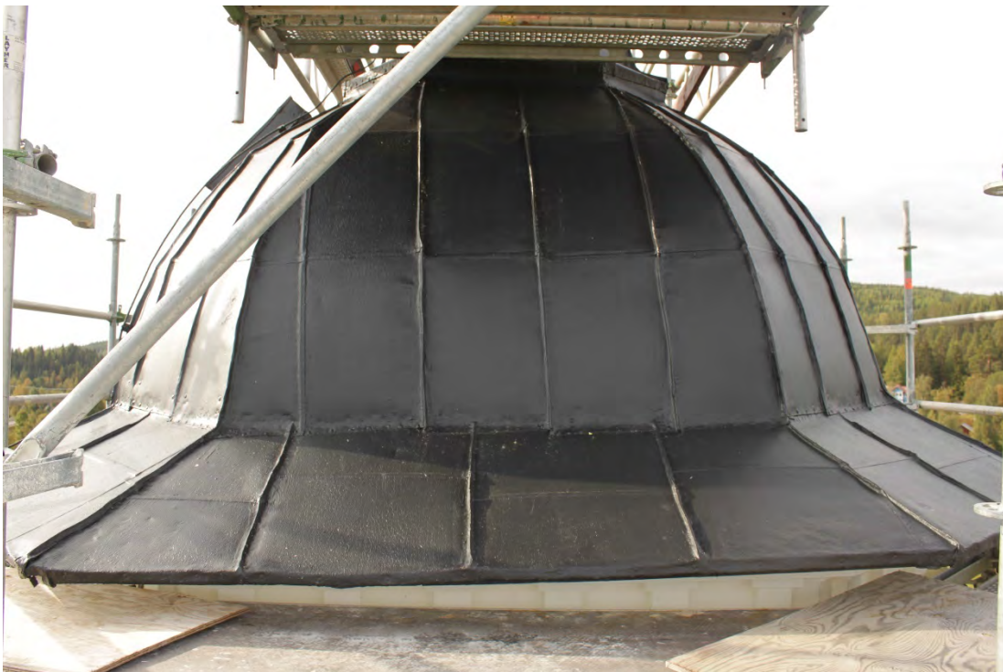
Figur 32 Tornhuv efter åtgärd.
