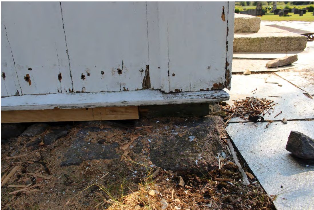
Figur 8 Detalj av nordvästra hörnet sedan skadan på syllen åtgärdats.
