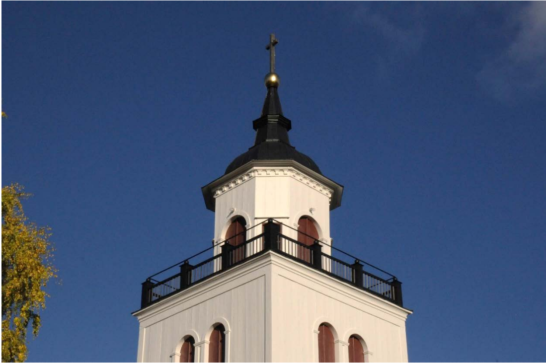
Figur 37 Lanternin och spira efter åtgärd.
