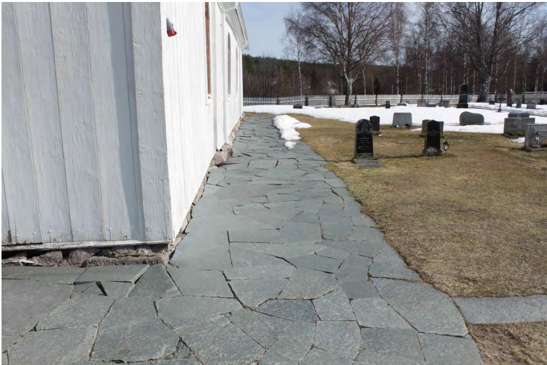
Figur 38 Skiffergång längs kyrkans södra sida före åtgärd.
