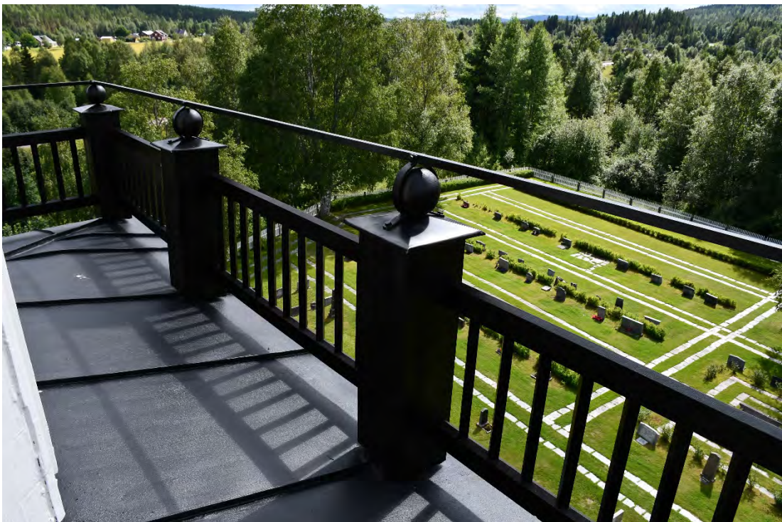
Figur 24 Räcke och stolpar efter åtgärd.
