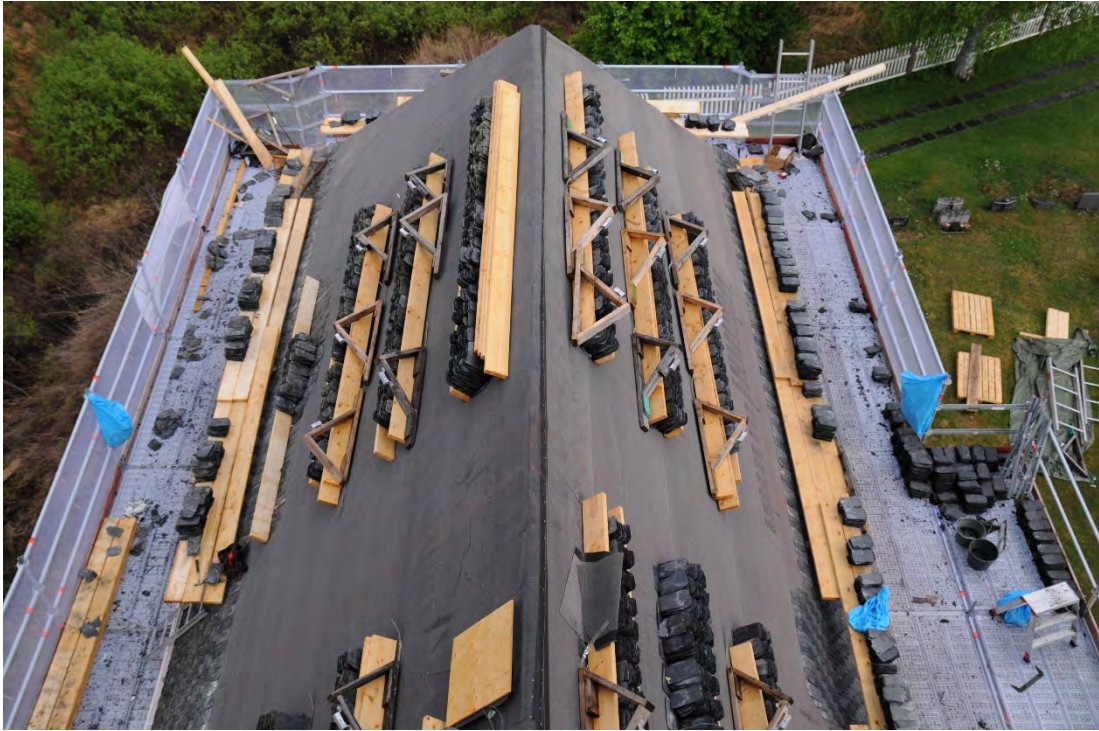
Figur 17 Skiffertak under arbete.
