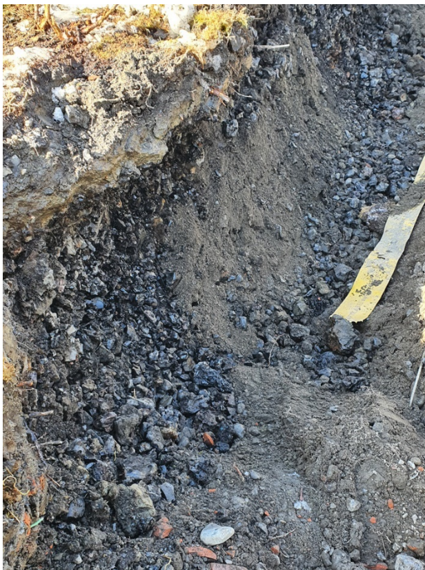
Figur 3. Del av det grävda schaktet i slagglagrets östra kant. Foto: Kristina Jonsson.
