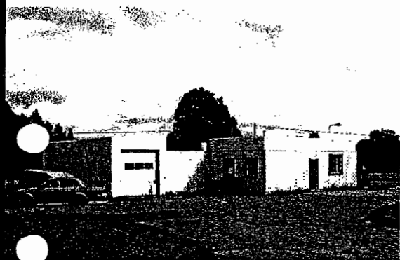
▲ Stängt. Bensinstationen i Ås har slagit igen. Stations- och verkstadsbyggnad av klassiskt 1960-talssnitt.
