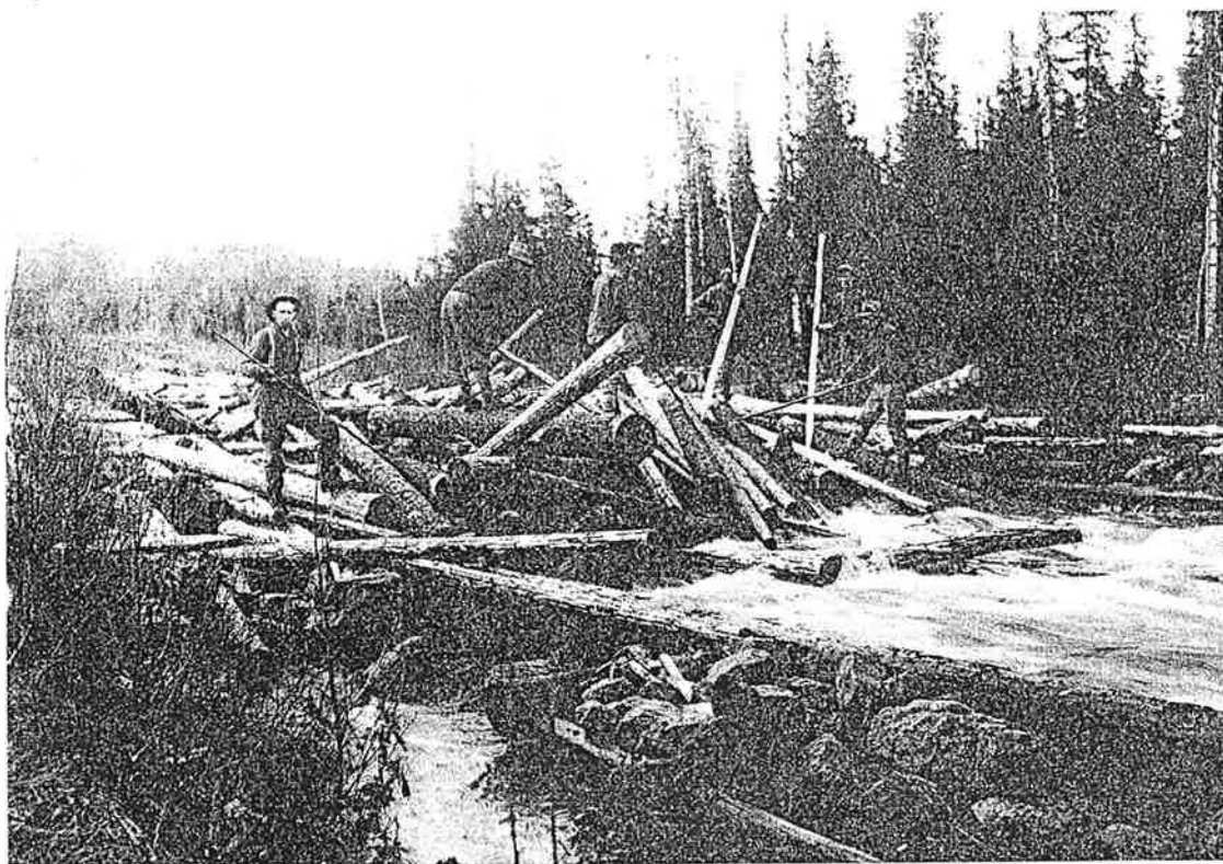
Flottare i Ursbäcken, Alanäs, 1920-talet. Man har byggt en kanal av sten och stockar för att virket inte ska fastna. Men ändå kunde det bli stora brötar när det ville sig illa.
