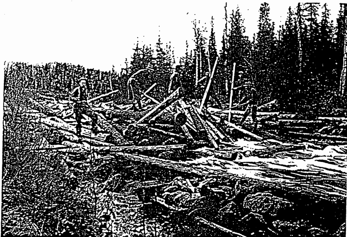
Flottare i Ursbäcken, Alanäs, 1920-talet. Man har byggt en kanal av sten och stockar för att virket inte ska fastna. Men ändå kunde det bli stora brötar när det ville sig illa.
