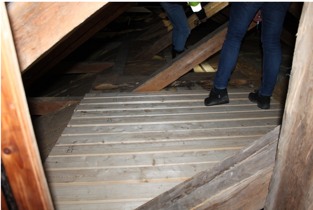
Figur 8 På vinden har man byggt en plattform innanför luckan från tornet och lagt ett gångstråk av plank.
