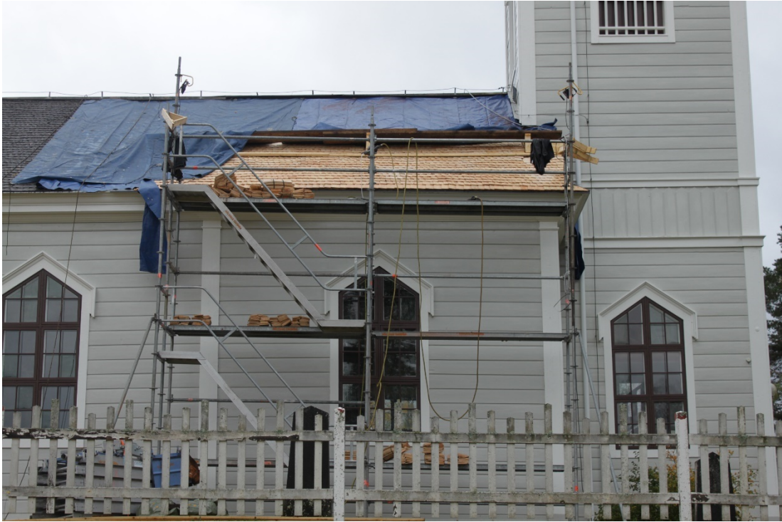
Figur 1 Påbörjade takarbeten på norra sidan av kyrkan.
