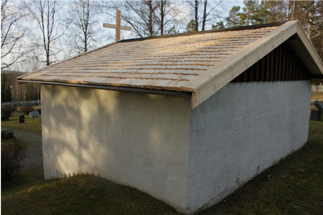
Figur 15 Bårhuset efter omläggning av taket.
