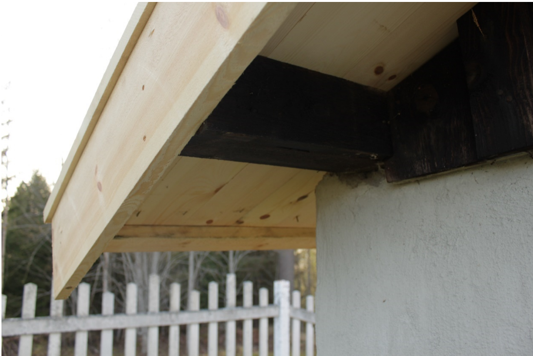
Figur 16 Detalj av takfot efter omläggning.
