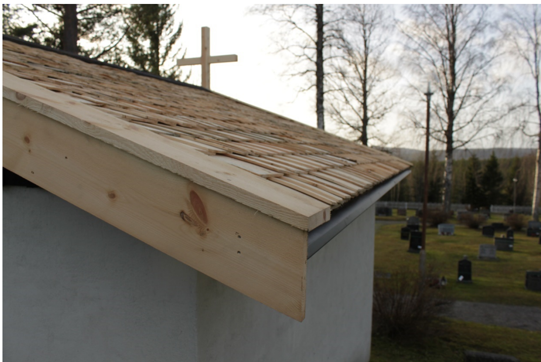
Figur 17 Vindskiva och vattbräda efter åtgärd. Notera fotplåten på bårhuset.
