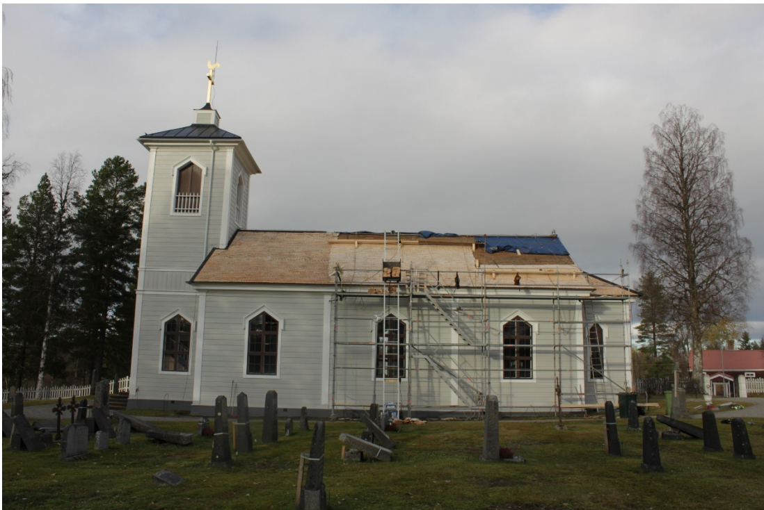
Figur 4 Södra sidan av kyrkan under pågående arbete.
