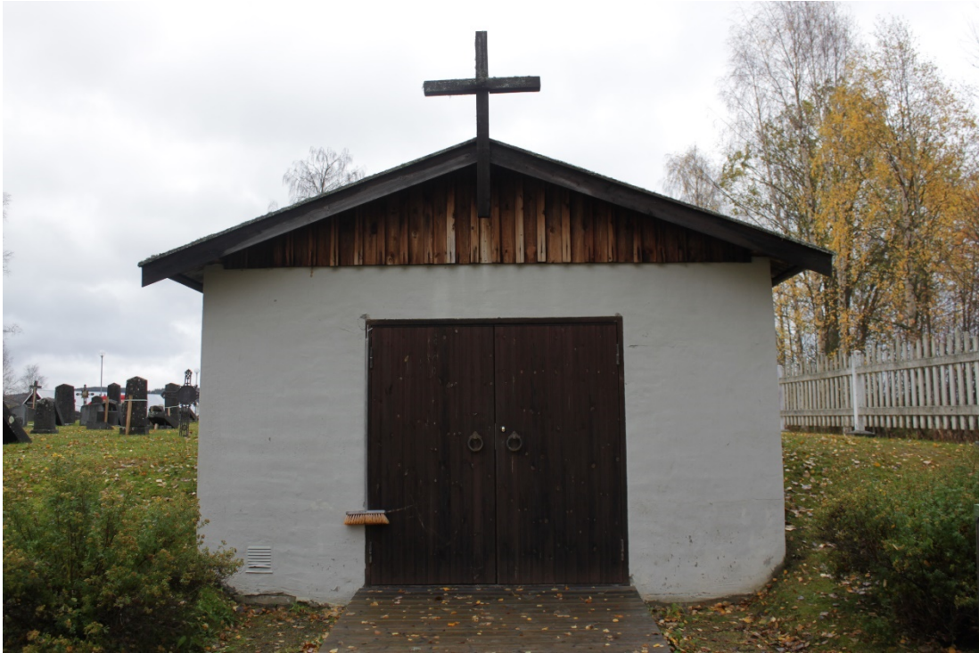
Figur 11 Bårhusets fasad mot väster, före åtgärd.
