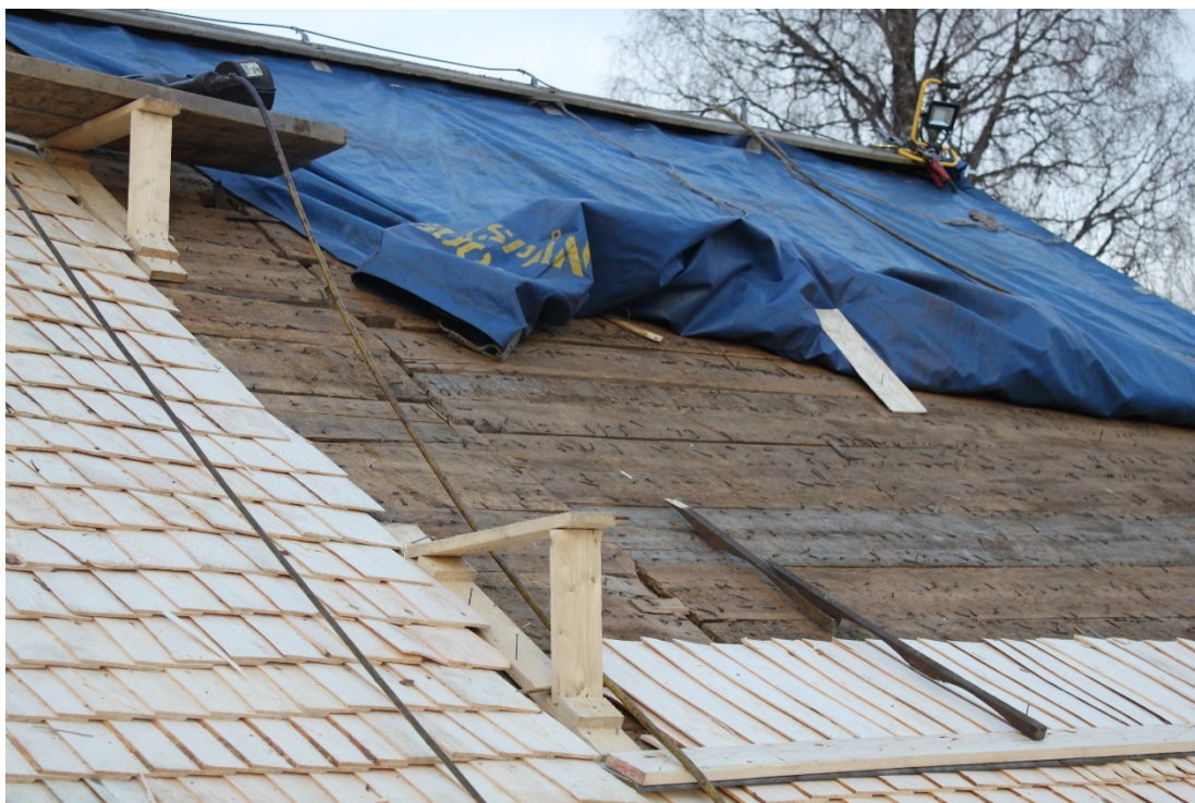
Figur 5 Inga skador upptäcktes i underlaget.
