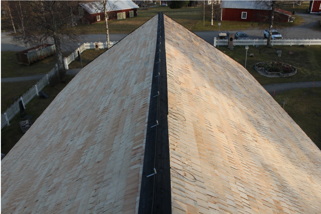
Figur 7 Mot taknock har man på det södra takfallet, satt öglor för att kunna säkra sig i.
