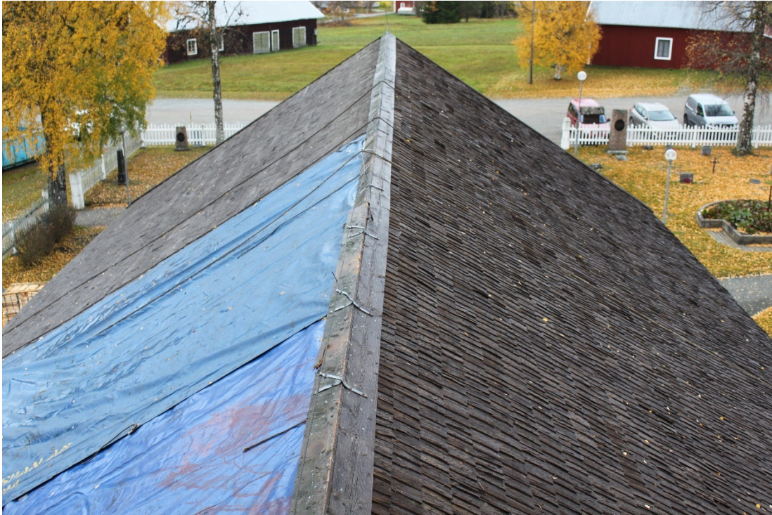
Figur 3 Långhustaket sett från tornet.
