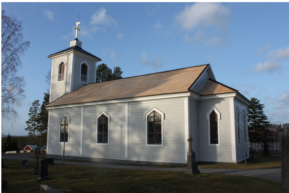
Figur 6 Nyhems kyrka efter spånläggning.
