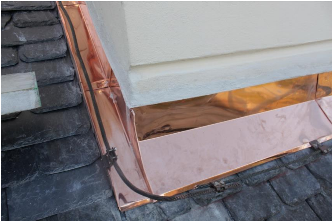
Figur 19 Plåt i mötet mellan tak och torn mot norr.
