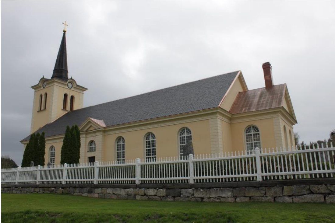
Figur 28 Södra sidan efter åtgärd.
