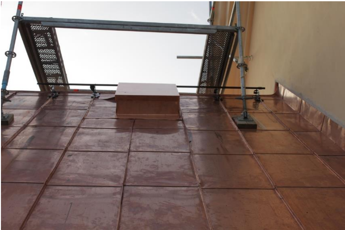
Figur 23 Taklucka och räcke på sakristian efter åtgärd.
