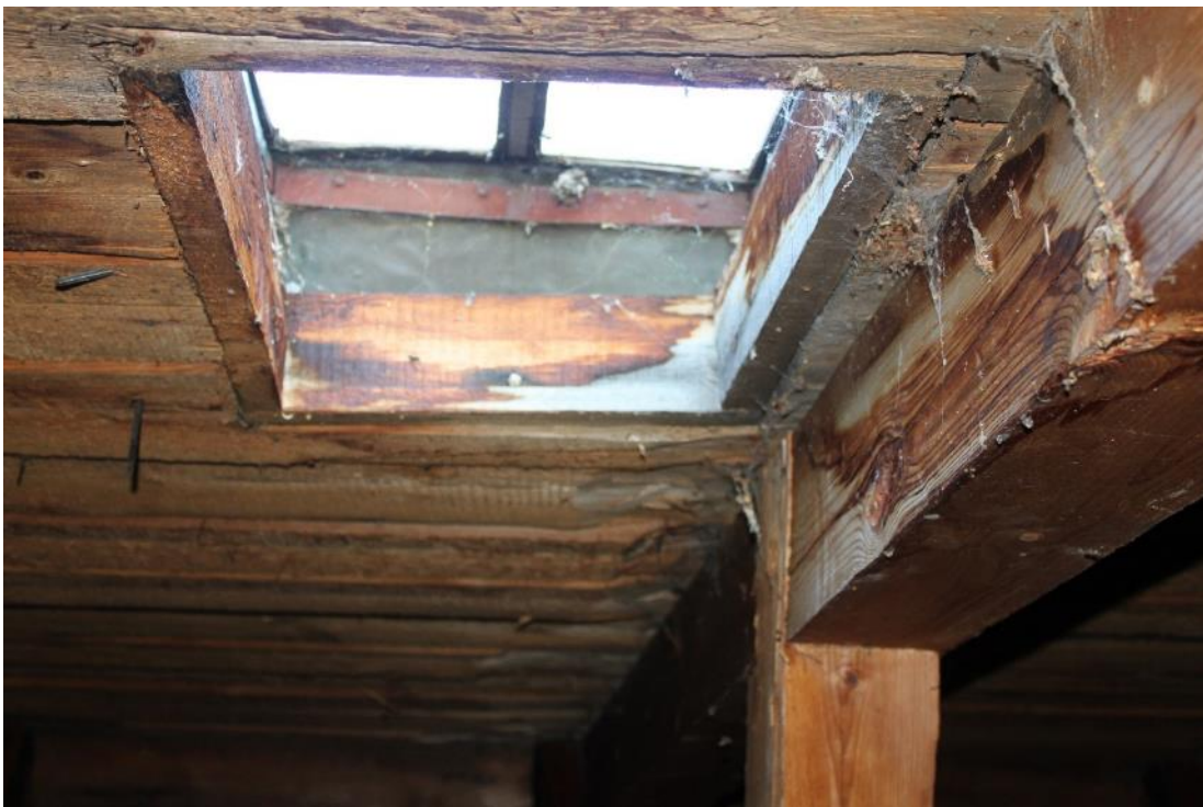
Figur 9 Takfönster innan demontering sett från vinden.
