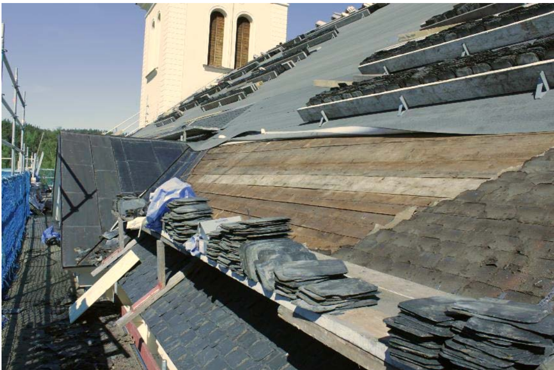
Figur 3 Demontering av skiffer och papp på södra takfallet.
