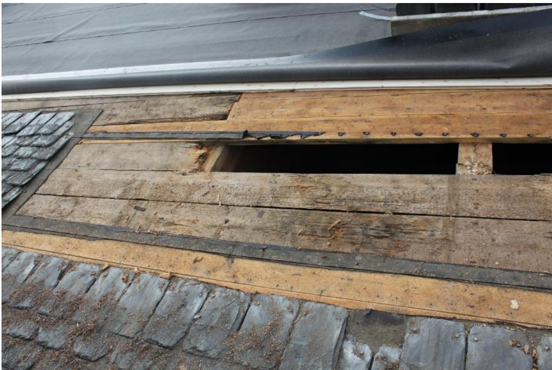
Figur 5 De ljusare brädorna visar tidigare lagningar.
