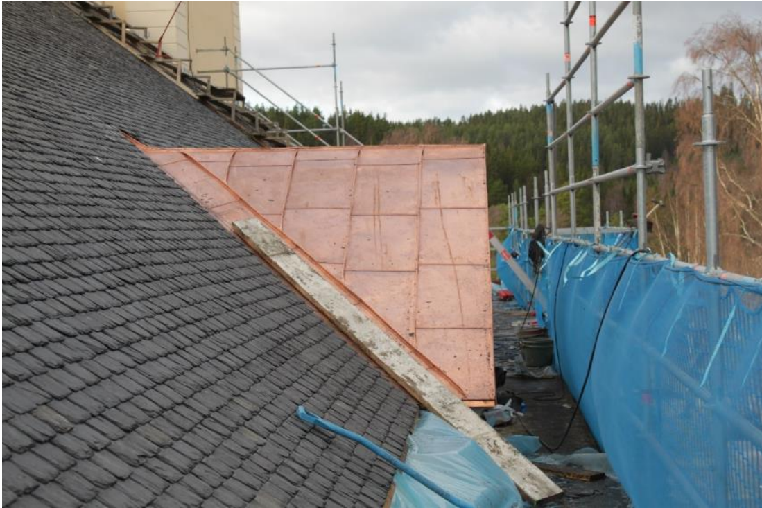
Figur 18 Plåtbeklädnad på trekantsgavel efter åtgärd.
