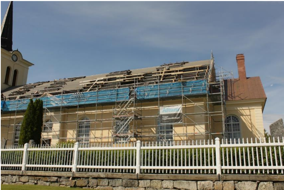
Figur 15 Kyrkan från söder under pågående takarbeten.
