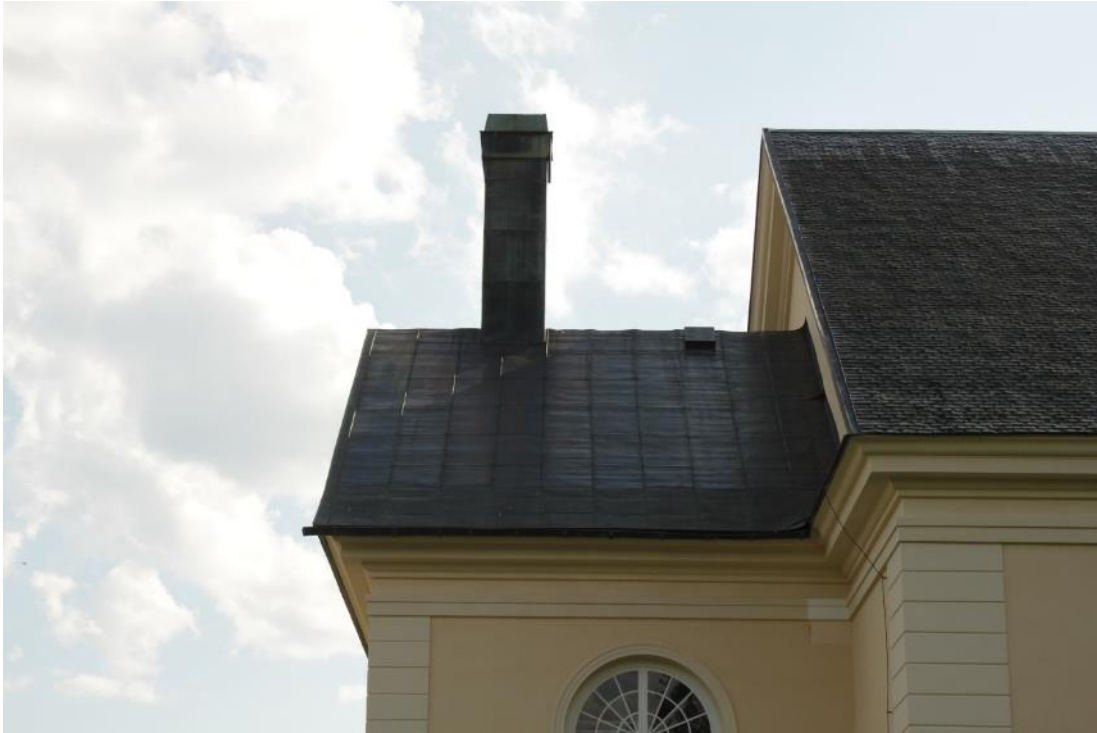
Figur 20 Sakristians norra takfall före åtgärd.
