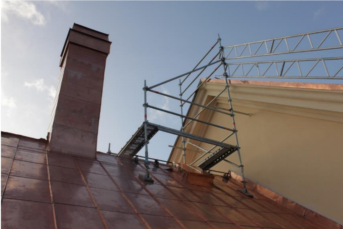
Figur 22 Sakristians norra takfall efter åtgärd.
