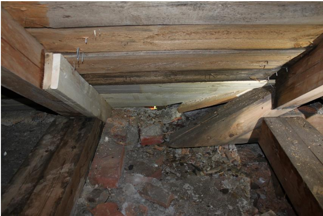
Figur 7 Lagning av rote och förstärkning av takstol på vinden.
