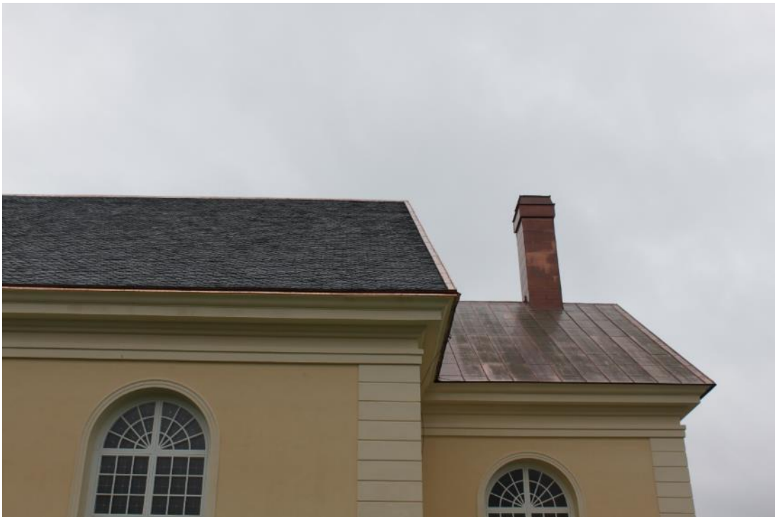
Figur 29 Södra sidan av sakristian efter åtgärd.
