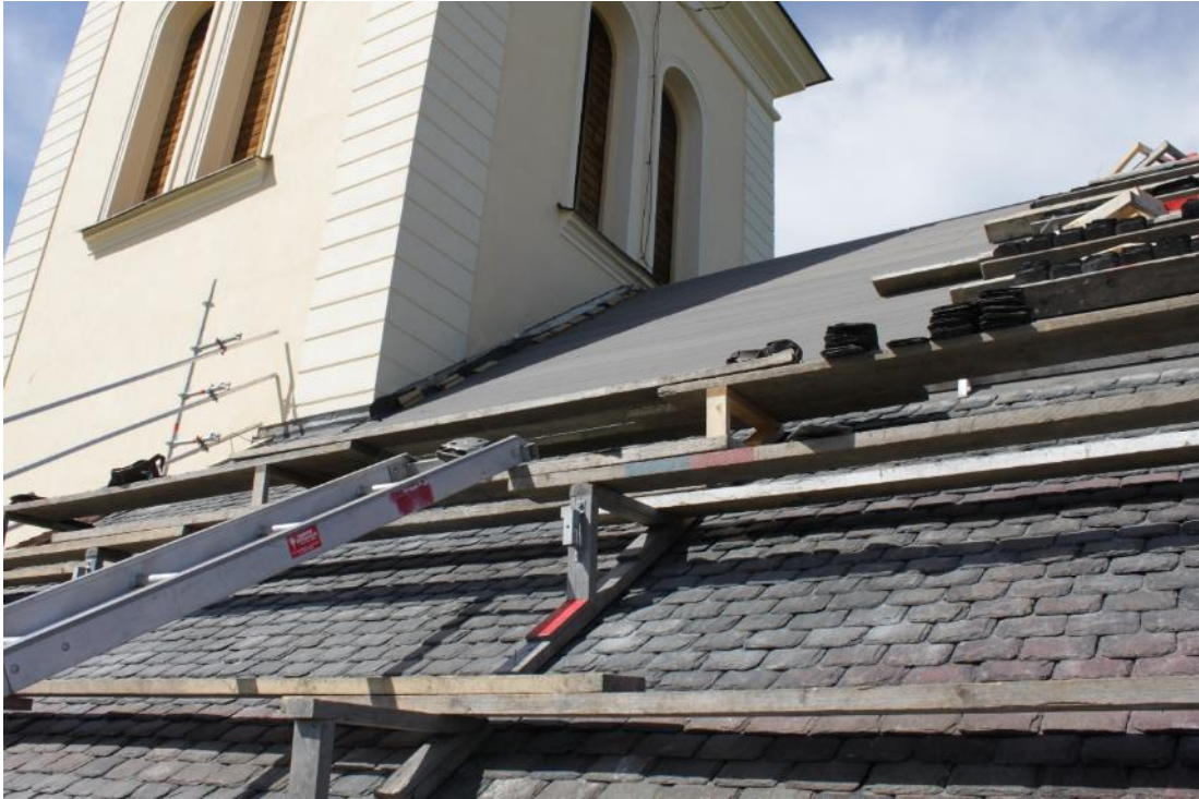
Figur 14 Pågående omläggning av södra takfallet.
