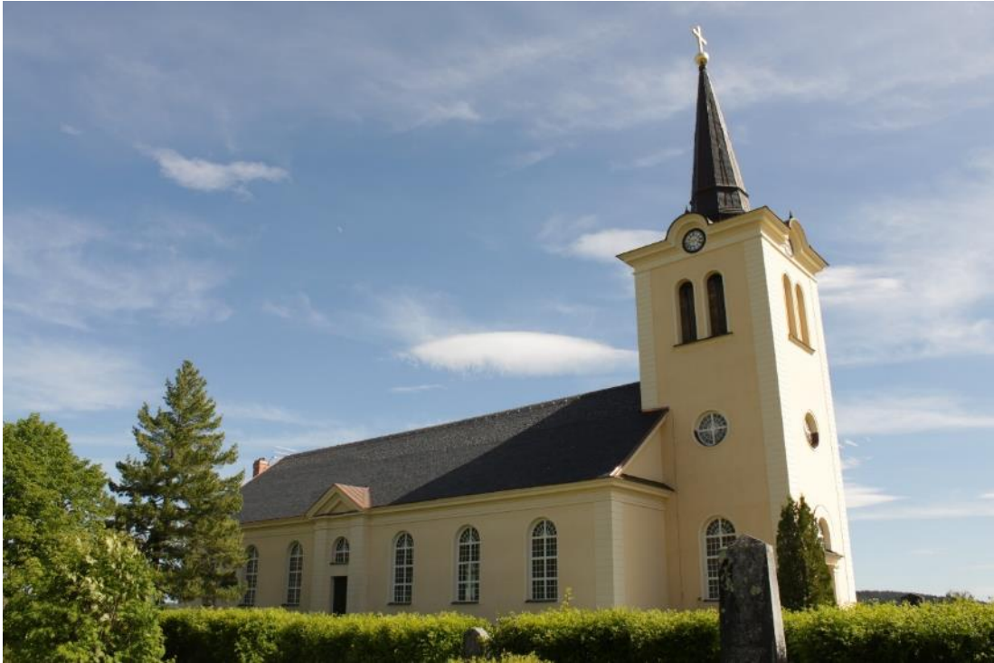
Figur 26 Norra sidan efter åtgärd.
