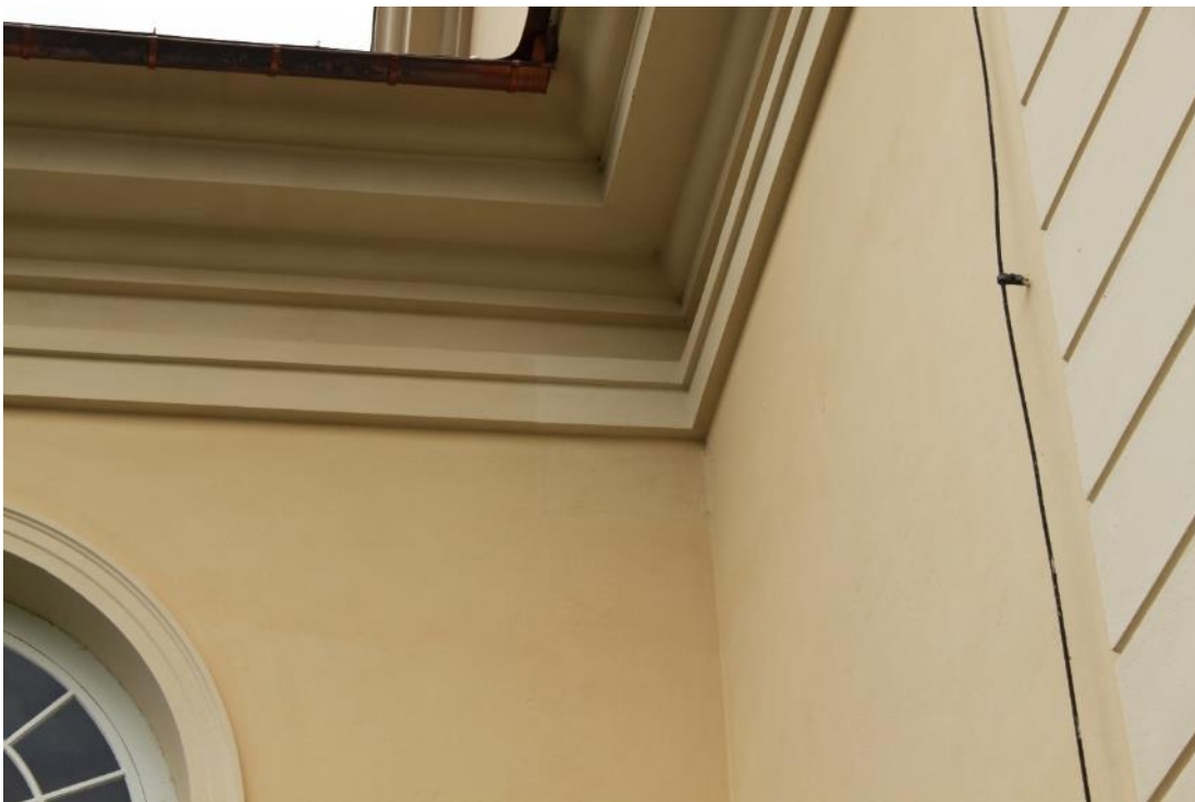
Figur 25 Den sparade rutan med tidigare färgsättning blev övermålad i samband med avfärgning av lagningar på taklisten.
