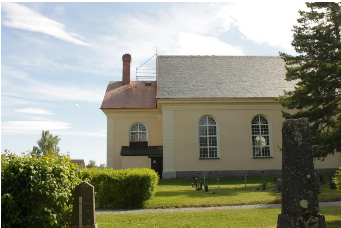
Figur 27 Norra sidan av sakristian efter åtgärd.
