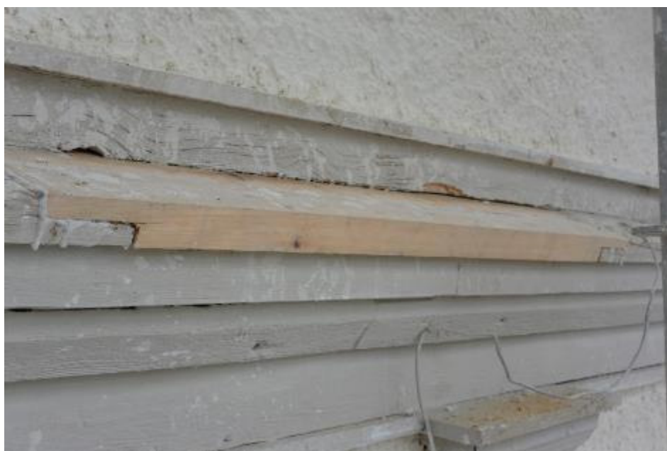
Ilagning av rötskadad gesims som det såg ut under pågående avfärgning.
