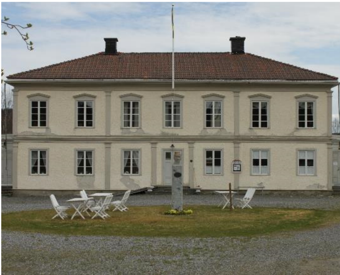
Västra fasaden före 2020 års putslagning och avfärgning.
