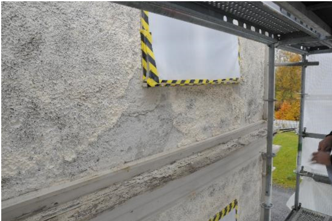
Södra fönstret på västra fasaden under pågående arbete. Kalkfärgen har blästrats bort och utstockningen är på plats men ny spritputs och avfärgning kvarstår.
