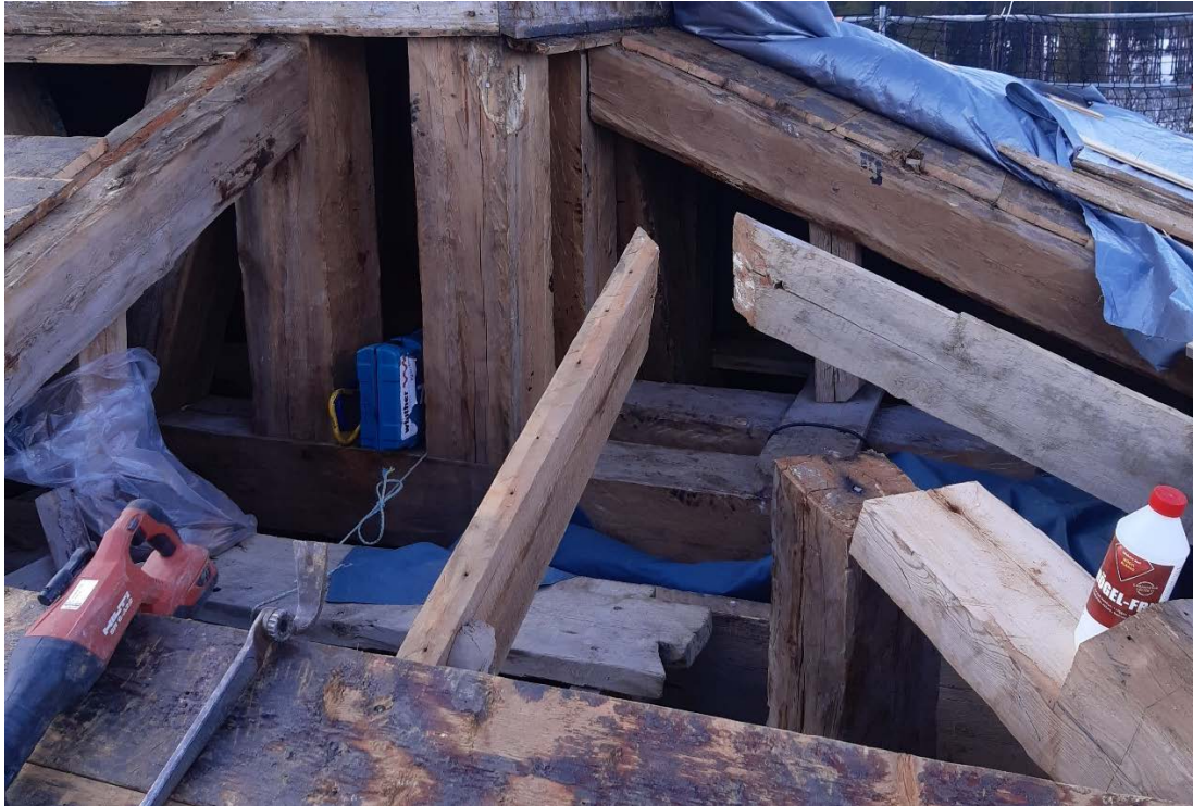
Figur 12 I nordöstra hörnet på tornhuven byttes en del av en bjälke (foto: Torbjörn Cajonberg, Winther bygg AB).
