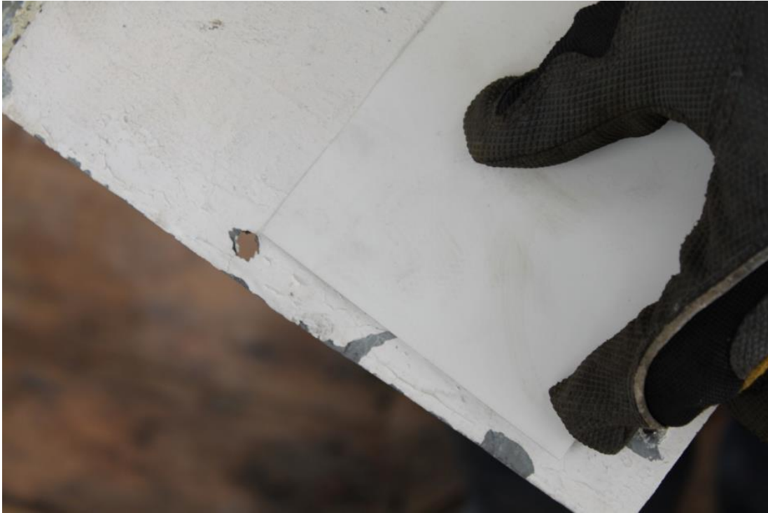
Figur 26 Vid jämförelse med den tidigare plåtinklädnaden, stämde Plannjas kulör varmvit (ungefär motsvarande NCS S0502-Y) bra överens med den tidigare kulören.
