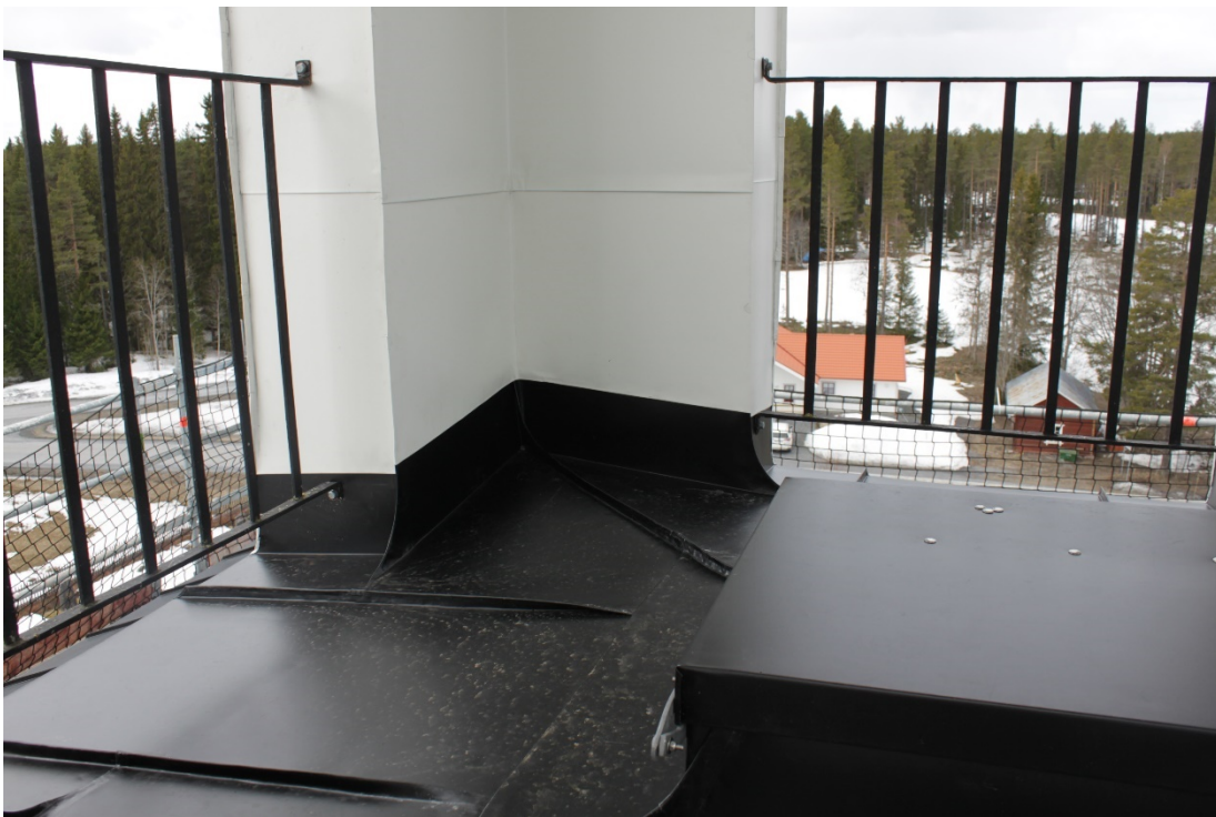
Figur 30 Möte mellan golv och vägg i lanternin efter åtgärd.
