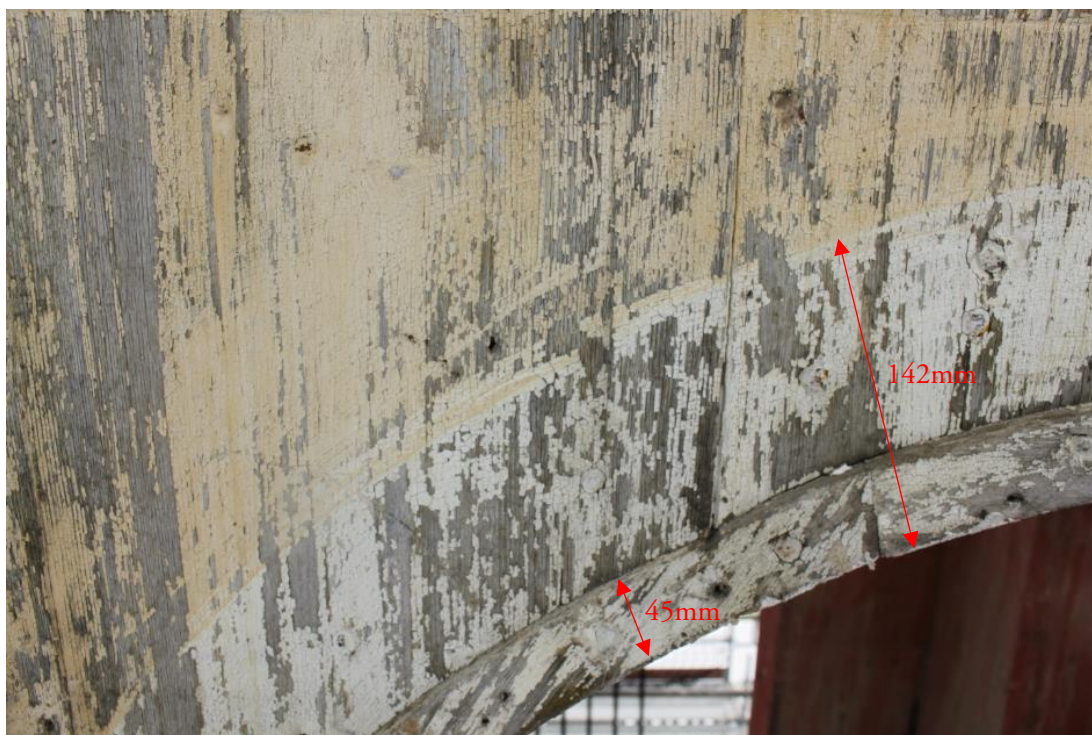
Figur 23 På utsidan syntes spår av en gul kulör med vitt kring öppningar och hörn. Närmast öppningen satt en trälist 45mm bred. Den målade omfattningen (inklusive trälist) var 142mm bred.
