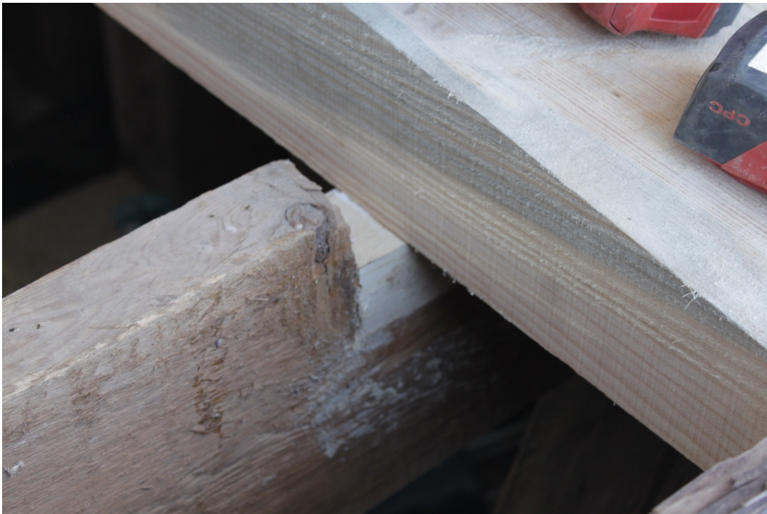
Figur 20 Mot öster gjordes en mindre ilagning av urtaget som bjälken vilar på.
