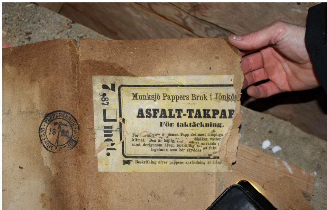
Figur 9 På tornvinden återfanns en etikett med texten ASFALT-TAKPAPP från Munksjö Pappers Bruk.
