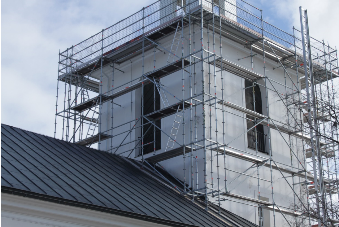
Figur 32 Stuprören avslutas med utkastare mot långhusets tak.
