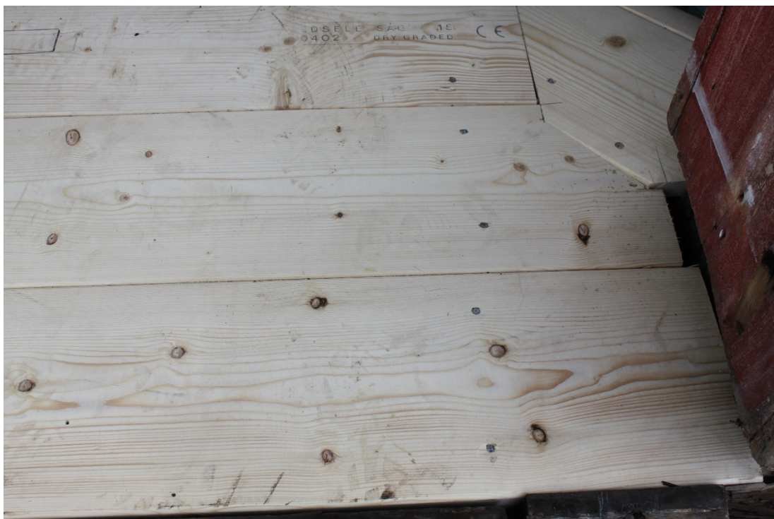
Figur 21 Nytt golv på lanterninen.
