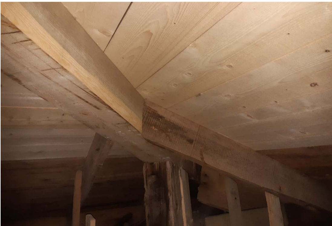
Figur 13 Den bytta bjälken och det nya rotet (foto: Torbjörn Cajonberg, Winther bygg AB).
