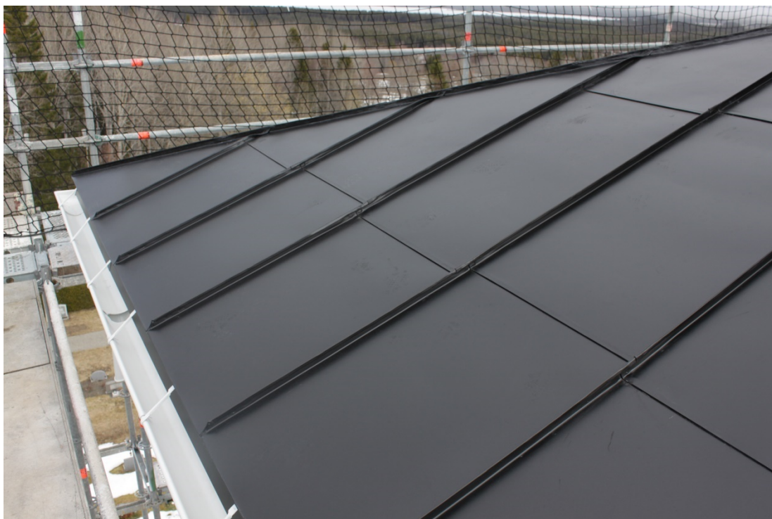
Figur 15 Ny dubbelfalsad plåt har monterats med ca 4 cm förskjutning av falsarna.
