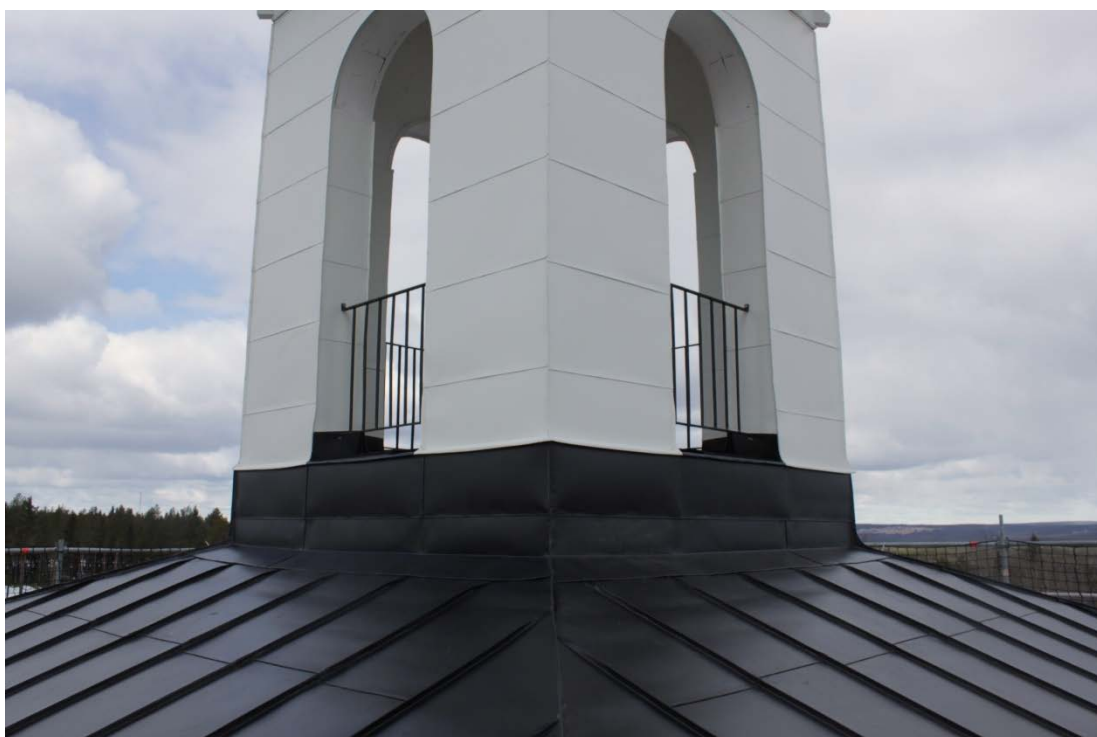
Figur 28 Lanternin efter åtgärd.
