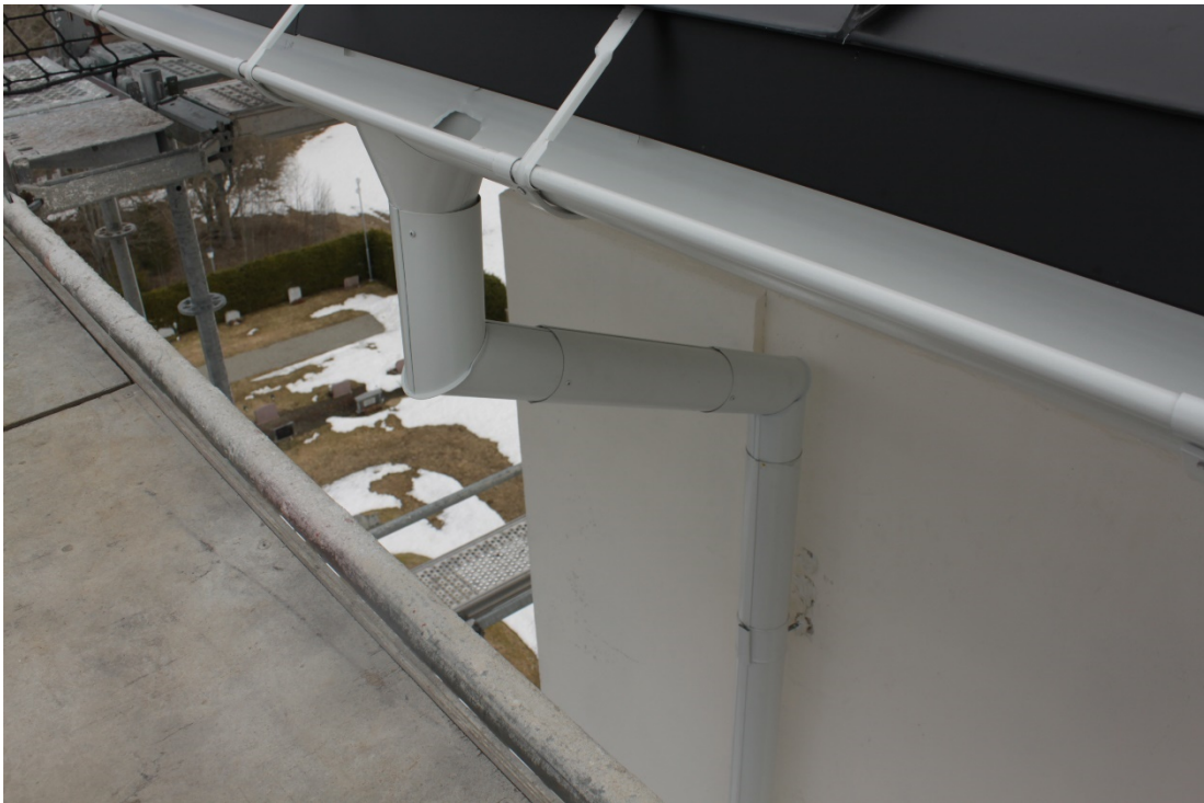
Figur 31 Takavvattning mot väster.
