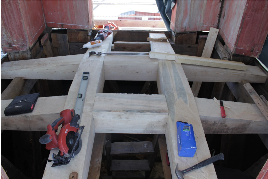
Figur 19 Alla fyra golvbjälkarna under lanterningolvet förnyades.
