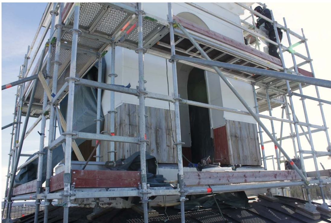
Figur 27 Lanternin under pågående arbete.
