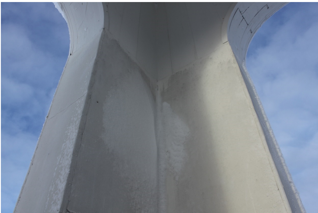
Figur 7 Insida lanternin före åtgärd. På insidan går plåten upp till början på öppningarnas bågar.
