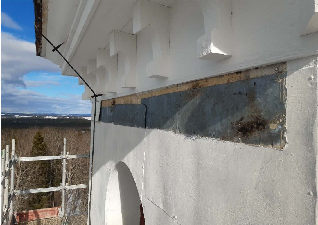
Figur 6 Utsida lanternin under pågående rivning.
