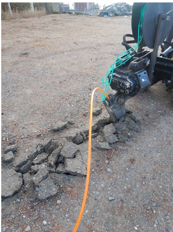
Figur 4. Kabelplöjning inom schaktsträcka 3. Foto: Kristina Jonsson.
