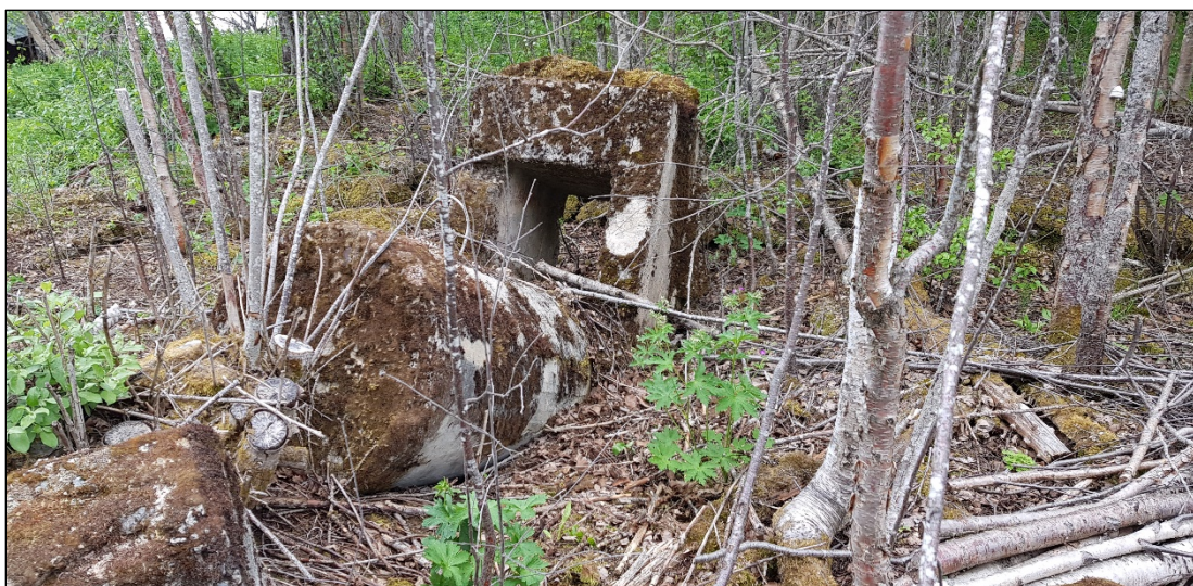
Fig 6. Liggande betongkonstruktion på grunden för den s.k. fabriken vid Blåmyran, L2021:5172
