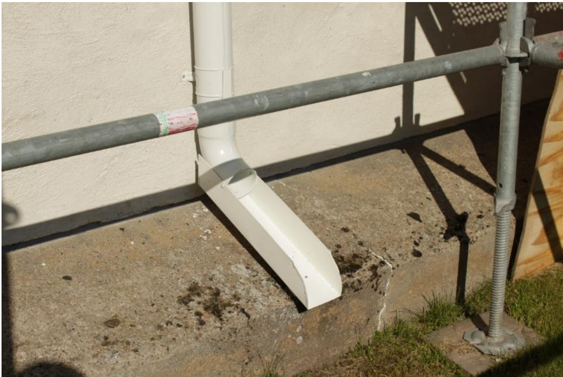
Figur 11 Avslutning på stuprör efter åtgärd.
