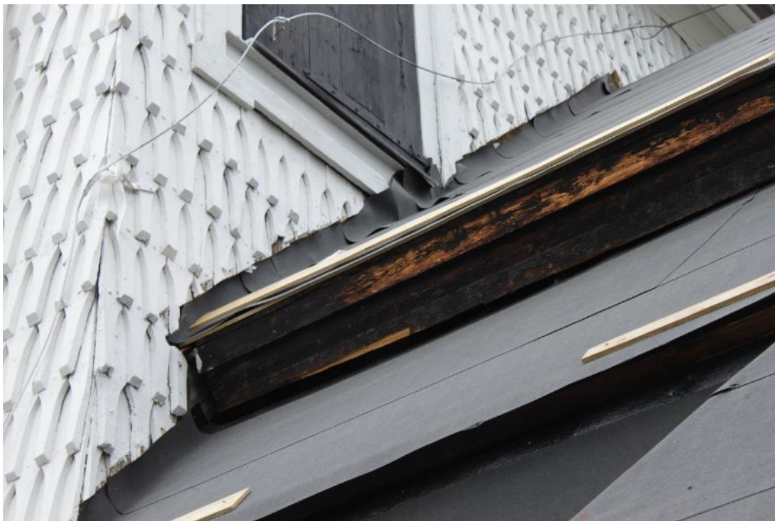
Figur 6 I mötet mellan tornets spånklädda fasad och skiffertaket, kapades den nedre delen av spåntäckningen, för montage av den nya ståndskivan.
