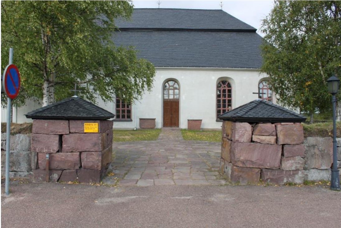
Figur 22 Grindstolpar mot söder efter åtgärd.
