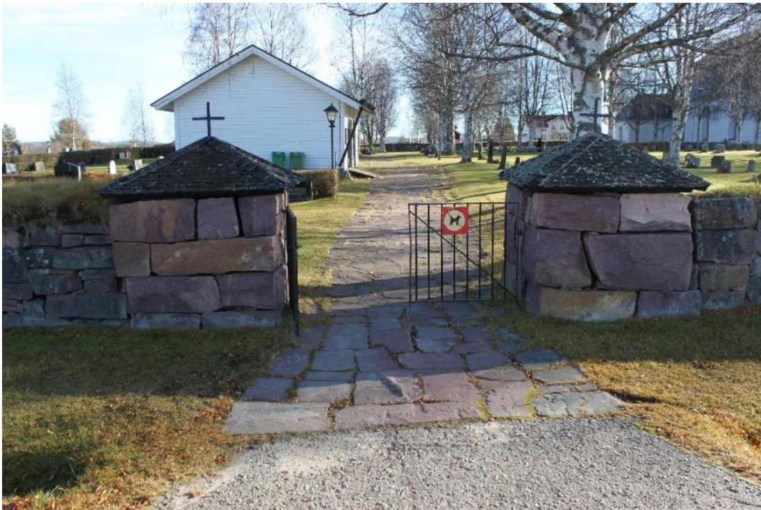
Figur 23 Grindstolpar mot väst före åtgärd. Foto: Julia Cronqvist, Jamtli
