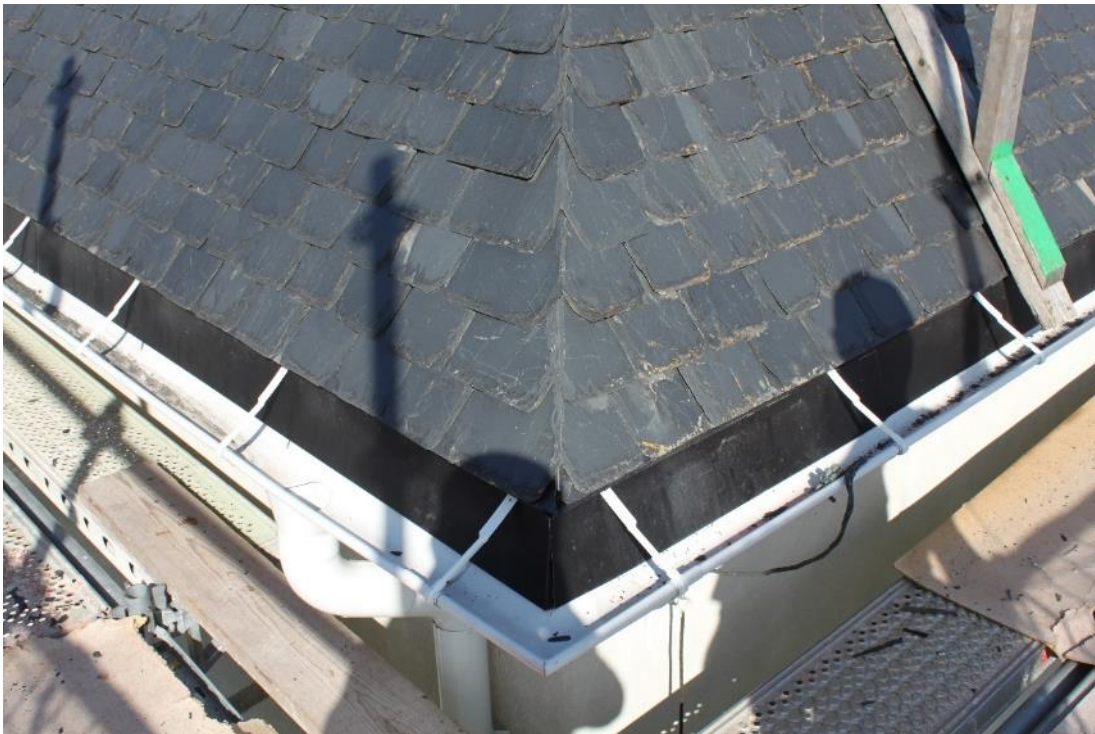
Figur 9 Hängränna på sakristia efter åtgärd. Den nya rännan har försetts med stagband.
