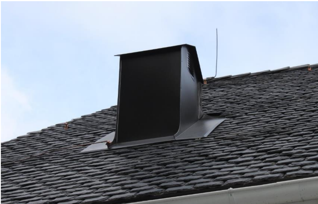
Figur 13 Ventilationshuv efter åtgärd.
