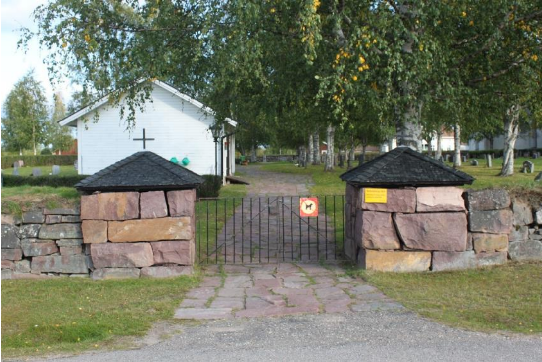
Figur 24 Grindstolpar mot väst efter åtgärd.
