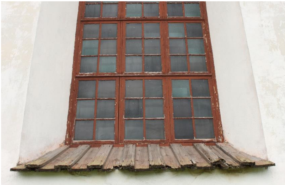
Figur 3 Fönster före åtgärd.
