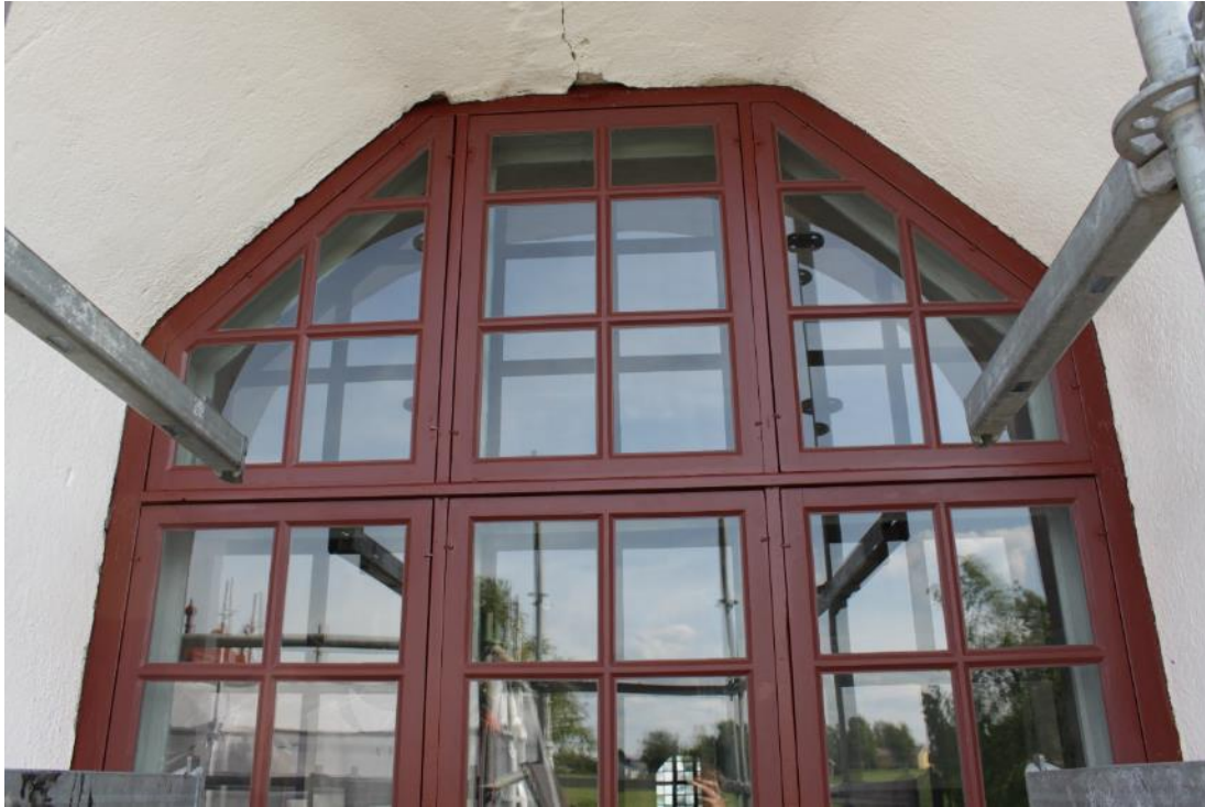
Figur 8 Fönster efter åtgärd.
