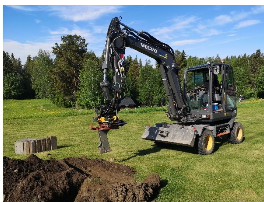
Figur 6. Där del B tog vid plöjdes sträckan istället för att grävas med grävska som övriga delar. Fotad mot SV.
