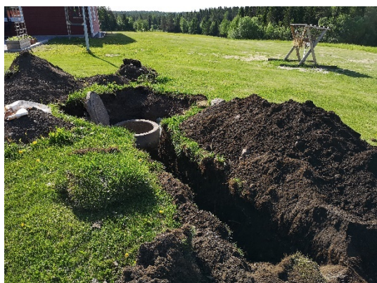
Figur 5. Del A med kabelbrunnen i botten delen av schaktet. Fotad mot SÖ.
