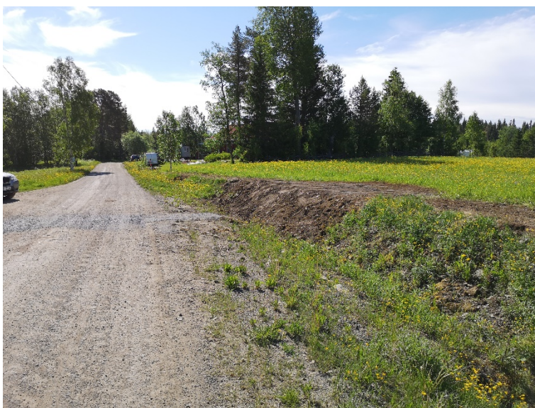
Figur 18. Det redan grävda och igenlagda schaktet SV om byvägen. Schaktet är lagt på åkerhakket ner mot diket. Schaktet som gått över vägen syns i form av nylagt grus till vänster i bild. I dungen mitt i bild ligger gården på fastighet Klocksåsen 3:11. Fotad mot SÖ.
