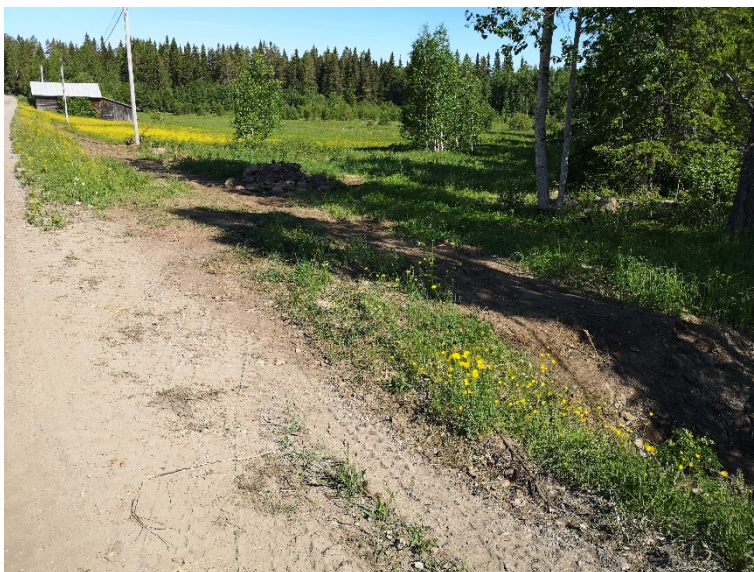
Figur 17. Det redan grävda och igenlagda schaktet NÖ om byvägen gick precis i kant med vägen. Fotad mot NV.
