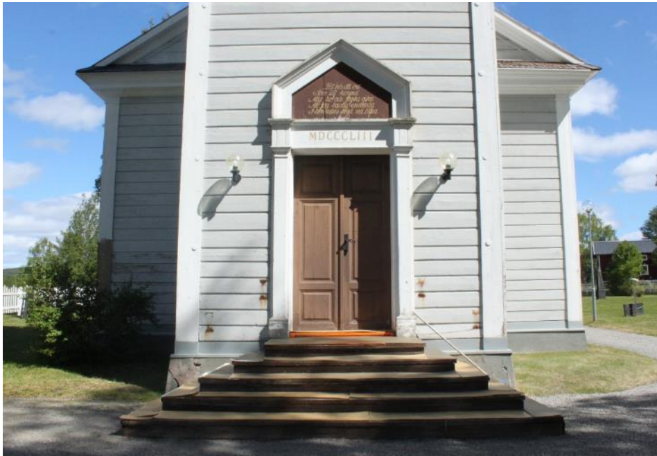
Figur 23 Entrén åt väster före åtgärd.
