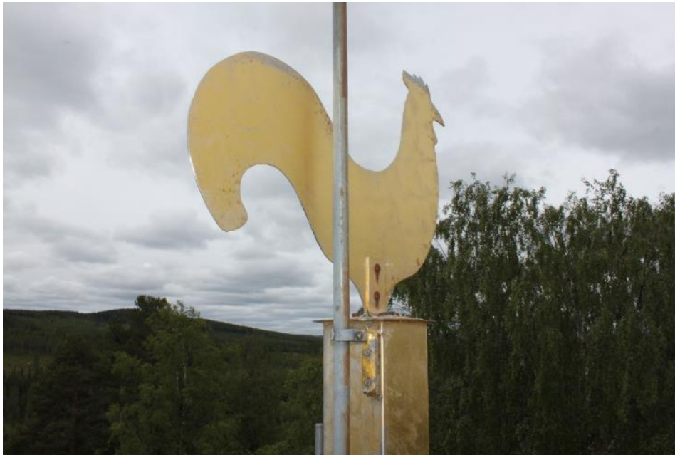
Figur 33 Tupp före åtgärd.
