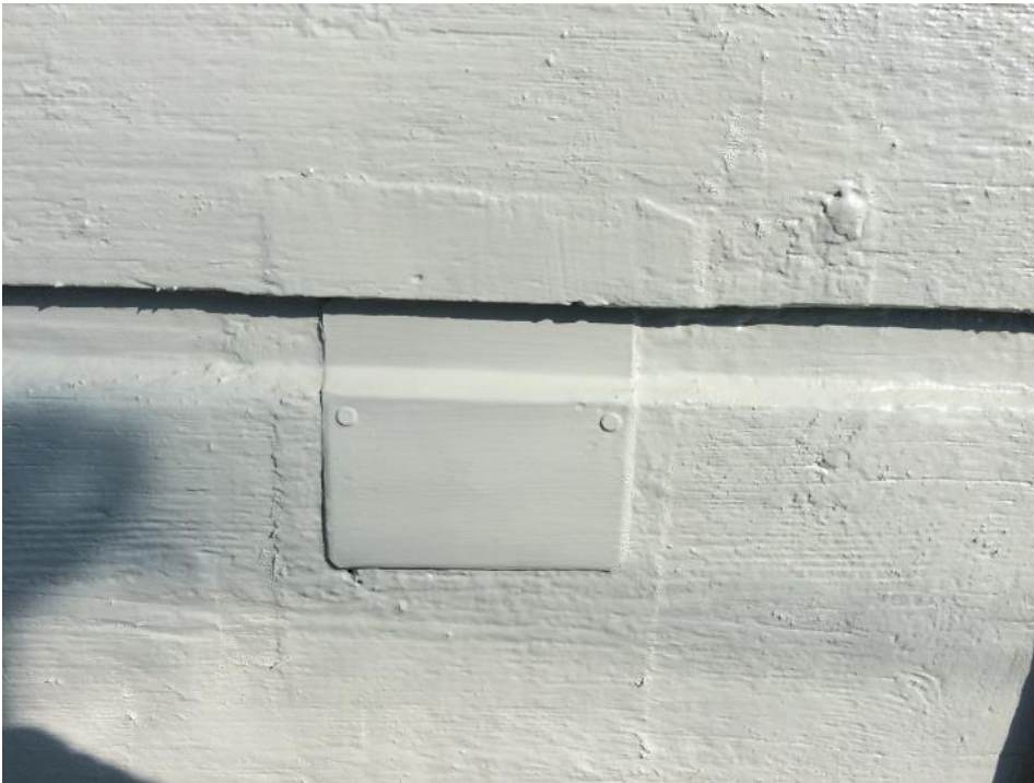
Figur 10 Hålen har lämnats kvar, men täckts över med profilerade plåtar.
