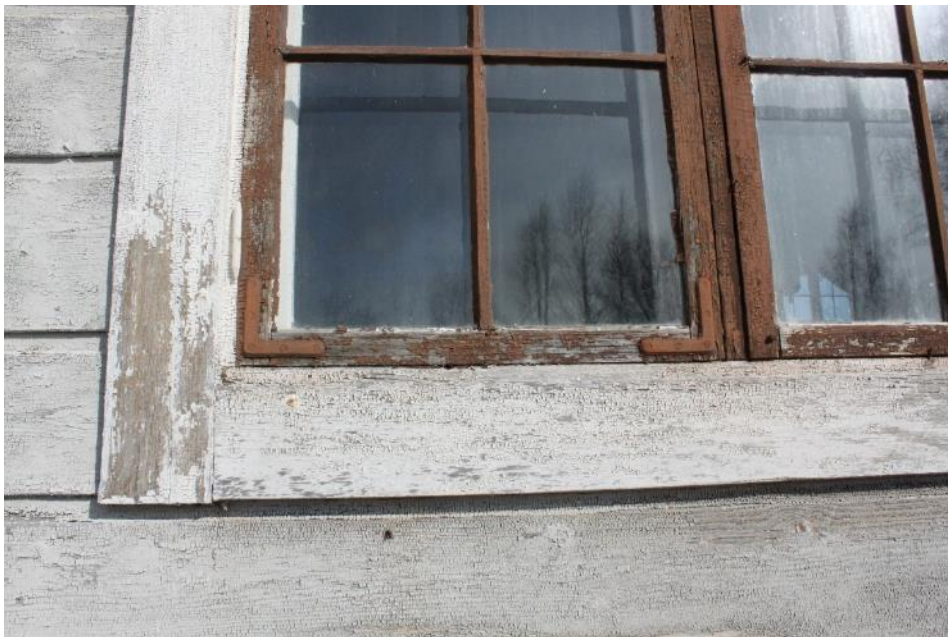
Figur 18 Detalj av fönster på den södra väggen före åtgärd.
