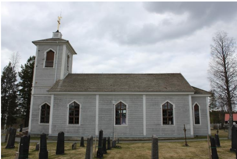
Figur 3 Nyhems kyrka från söder, före åtgärd.
