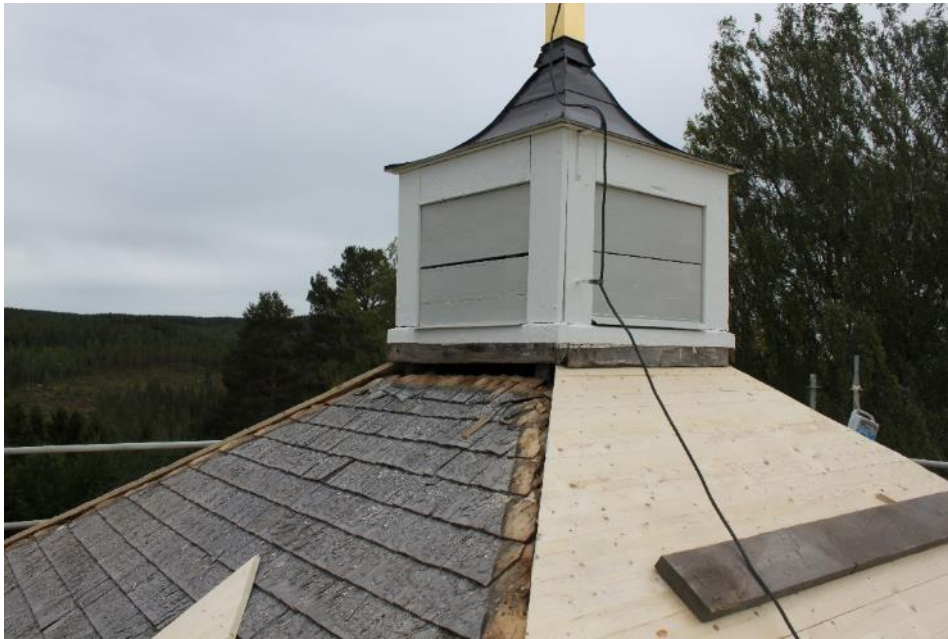
Figur 29 Tornets takfall har klätts med panel. Den har lagts ovanpå stickspånen.
