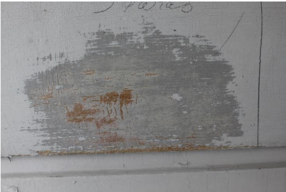
Figur 6 Färgskikten var tunna och slitna vilket gjorde det svårt att ta fram en färgtrappa för fasadens olika färglager (bild från norra sidan på långhuset).
