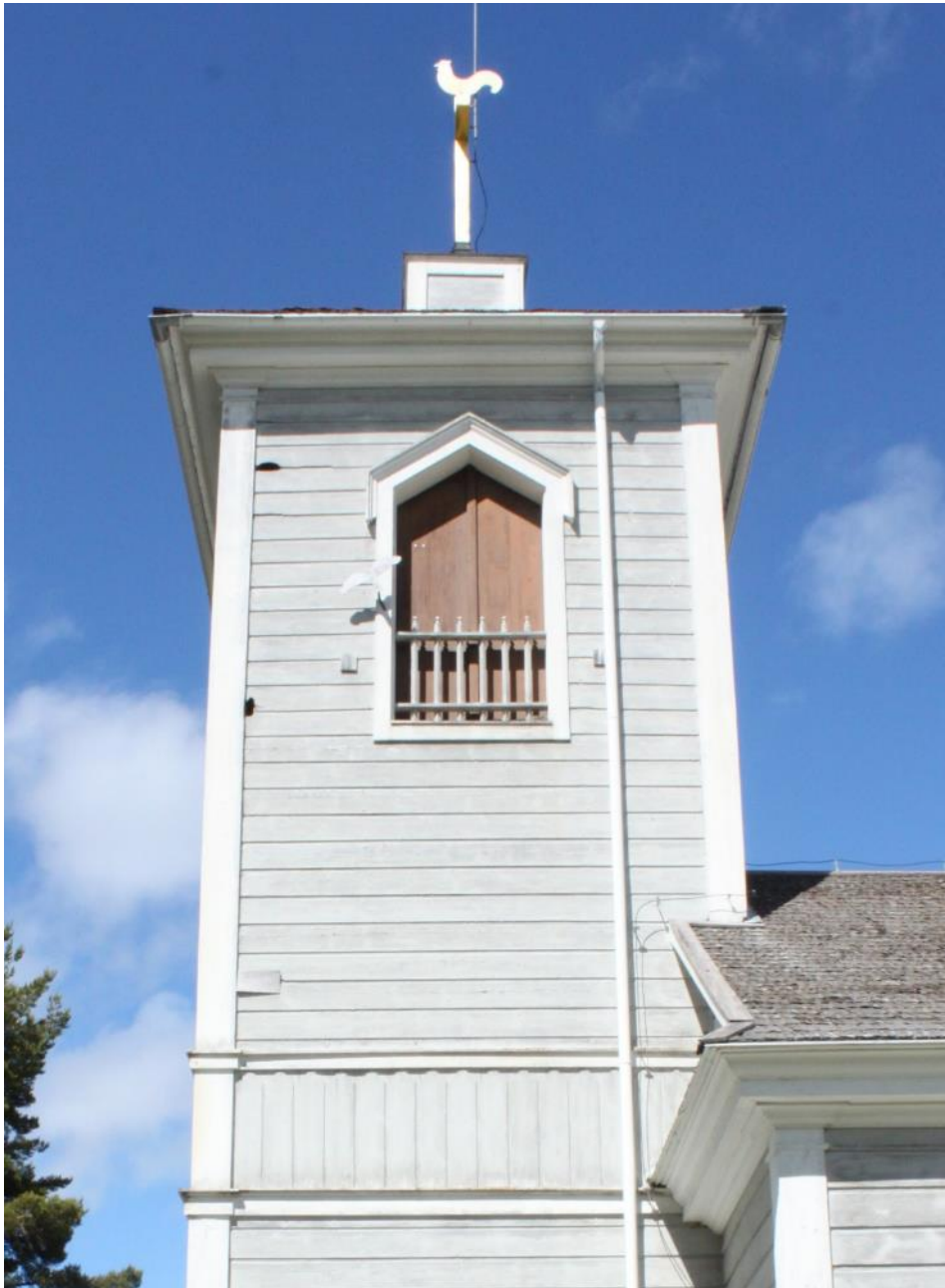
Figur 7 Tornet åt söder, före åtgärd.
