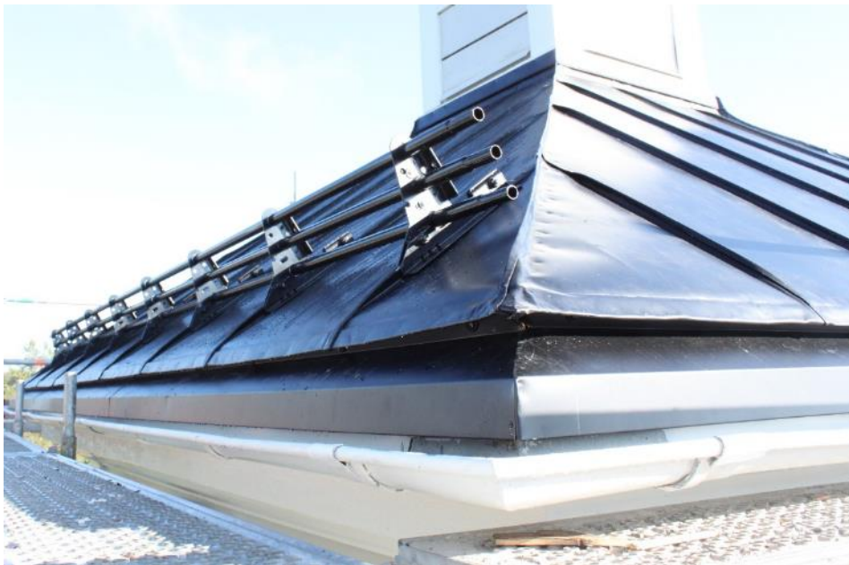
Figur 32 Ett snörasskydd sattes på västra takfallet ovanför huvudentrén. Snörasskyddet sitter med falsklämmor, vilket innebär att åtgärden kan ses som reversibel.
