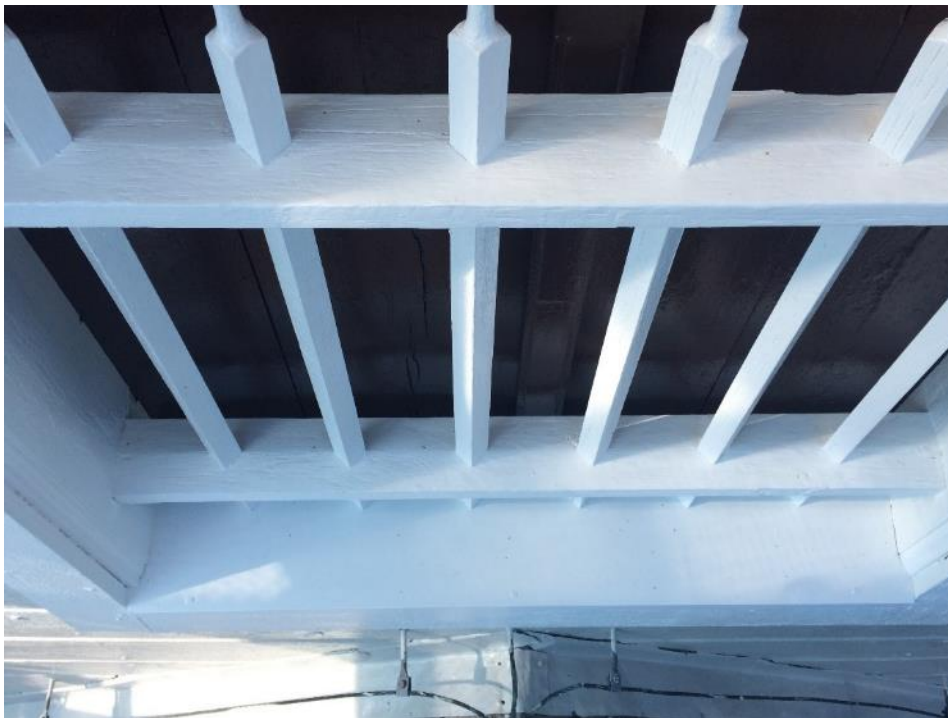
Figur 22 Bottenstycket kom att ersättas med ett nytt i samma utförande.
