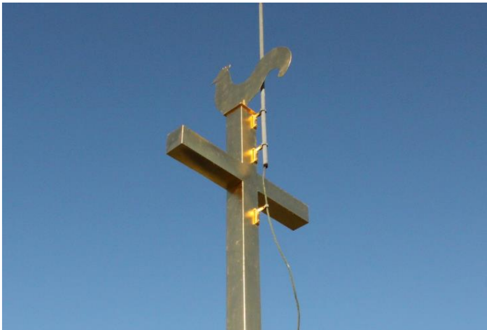
Figur 34 Kors och tupp har målats två gånger med Beckers metallprimer, sedan två gånger med gul linoljefärg innan förgyllning.
