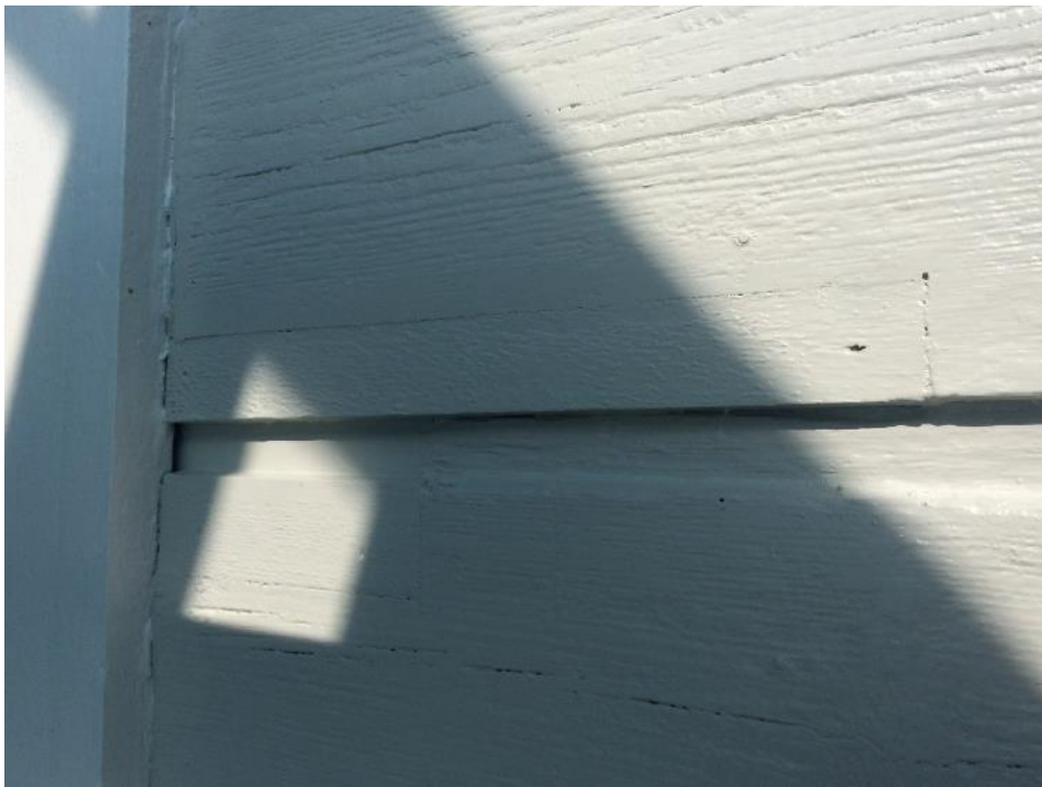
Figur 16 Skada på torn efter åtgärd.
