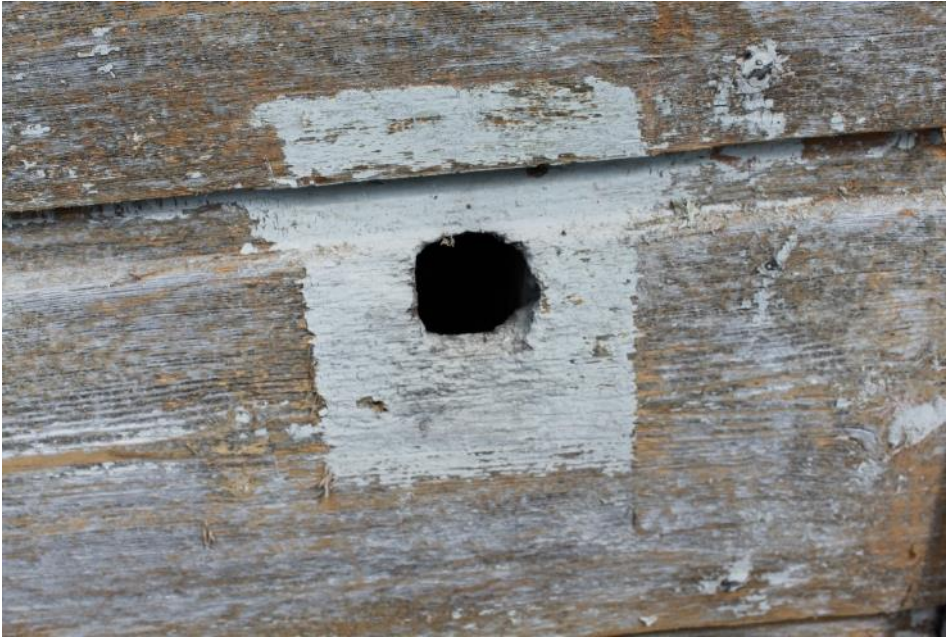
Figur 9 På södra och norra sidan av tornet satt tidigare träklossar, en på vardera sidan om ljudluckan. Klossarna täckte över hål.
