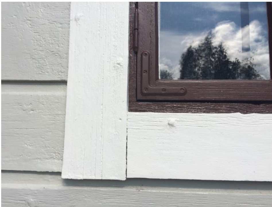
Figur 20 Närbild på fönster efter åtgärd.
