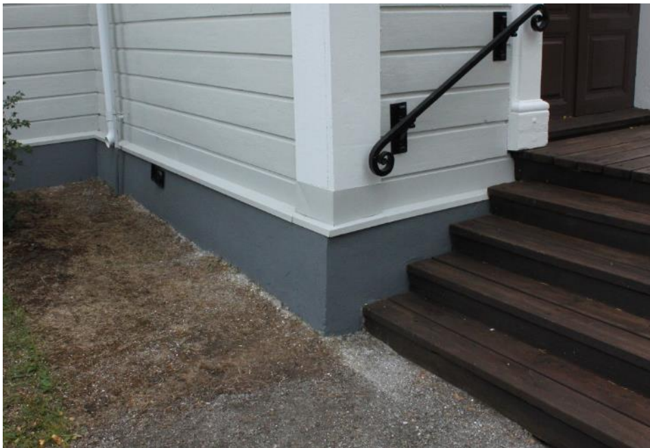
Figur 36 Skadade delar av sockeln har lagats upp. Sockeln har sedan målats med Beckers sockelfärg, Grafit 531 (motsvarande NCS S 6502-G).
