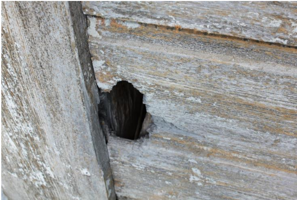
Figur 11 Tornet hade flera hål efter hackspett.
