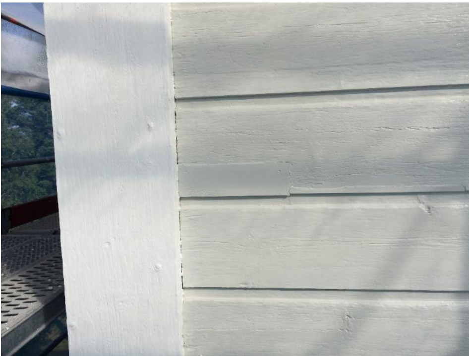
Figur 14 Skada på torn efter åtgärd.
