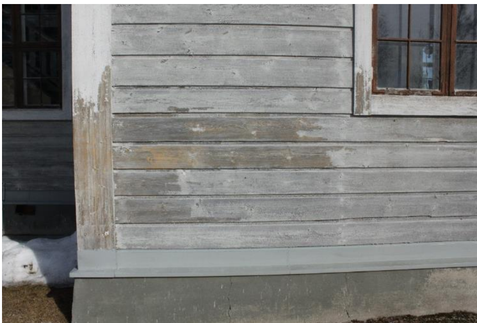
Figur 4 Åt söder var färgen tunn och spröd med synligt gråträ (sydvästra hörnet).
