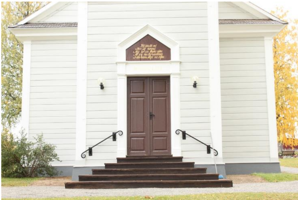
Figur 24 Entrén åt väster efter åtgärd. Dörrarna har målats med linoljefärg från Engwall o. Claesson i samma bruna kulör som ljudluckor och fönsterbågar (NCS S 7010Y-70R).
