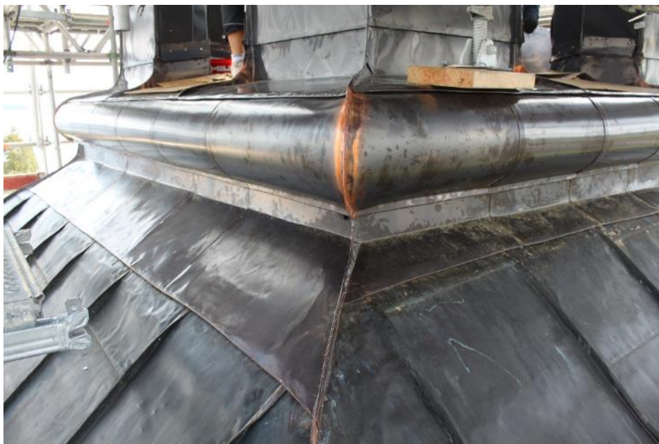
Figur 12 Sockel på lanternin efter åtgärd.
