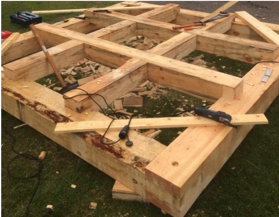
Figur 4 Sockel på lanterninen samt golvbjälkar har förnyats. Ramverk och bjälkar gjordes i ordning på marken för att sedan tas isär och byggas ihop på plats. foto: Joakim Nilsson Hammarstrands bygg.
