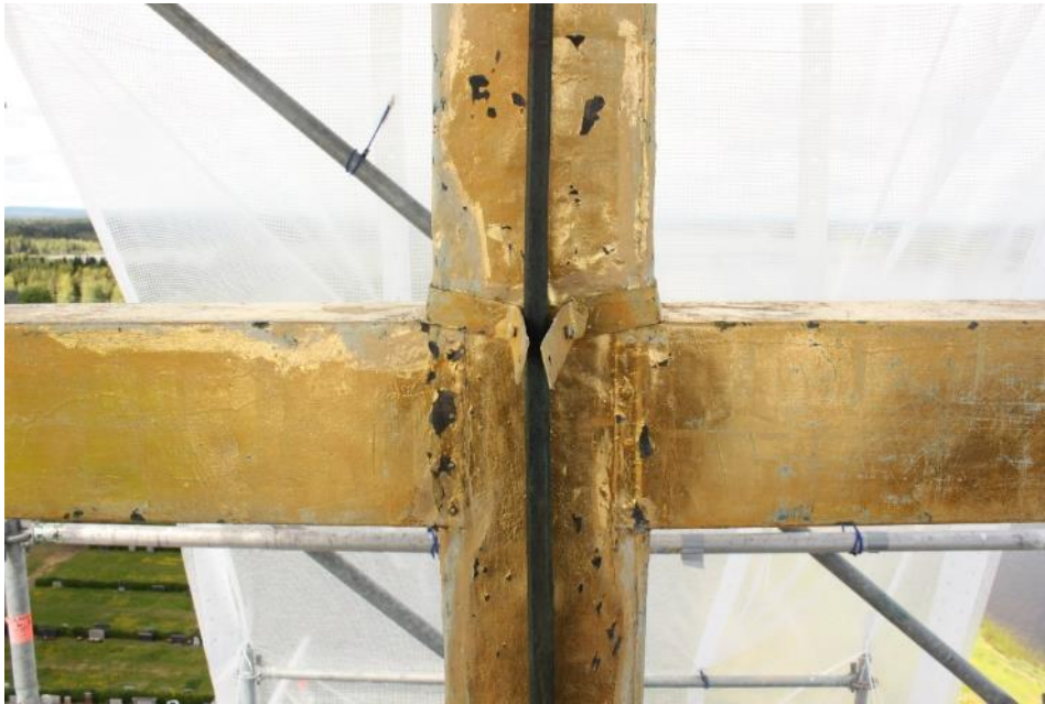
Figur 30 Förgyllningen på kors och korsglob var sliten och fläckvis borta.
