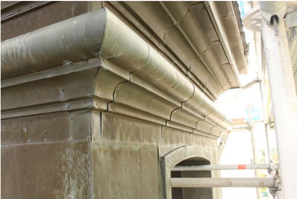
Figur 23 Lanternin före åtgärd.
