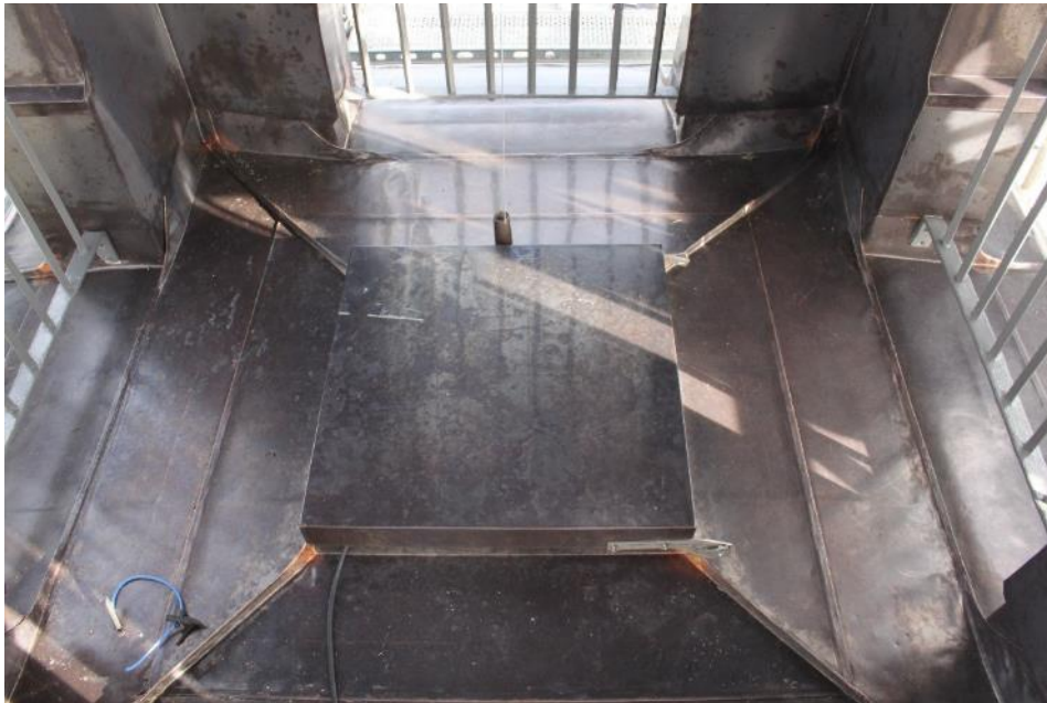
Figur 7 Lanterningolv och lucka efter åtgärd.
