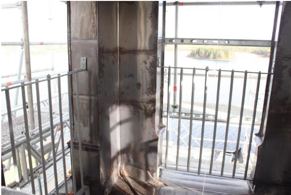
Figur 29 Efter åtgärd. Lanterninräckena har målats med Beckers rostskyddsgrund O och sedan Beckers Metallgrund och täck, kulör 8000 N.
