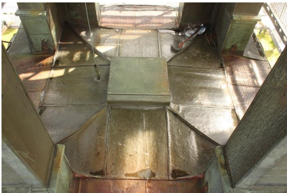
Figur 2 Lanterningolv och lucka före åtgärd.
