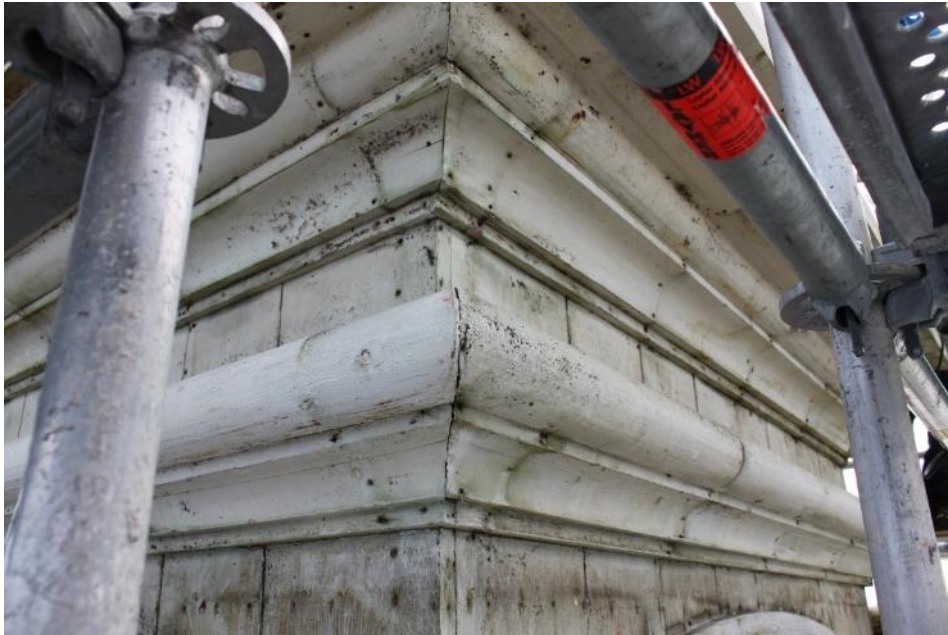
Figur 25 Lanterninens profilerade taklist i trä efter att plåten tagits bort.
