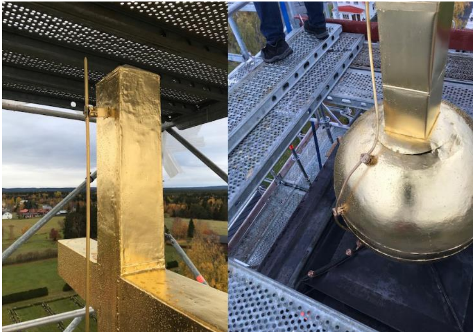
Figur 35 Kors och korsglob var på plats då Tommy Olsson, Arenatum AB och Ralph Sjödin, Winther Bygg gick igenom de kvarstående punkterna från slutbesiktningen den 8 oktober. Foto: Tommy Olsson, Arenatum AB.
