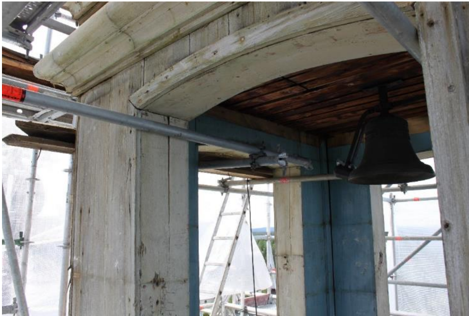
Figur 24 I samband med att plåten på lanterninen avlägsnades sommaren 2018, kom den underliggande träpanelen att bli synlig. Lanterninens panel var på utsidan vitmålad (ungefär motsvarande NCS S 1002-Y50R), medan insidan av lanterninen var målad i en blå kulör (ungefär motsvarande NCS S 3020-B50G).
