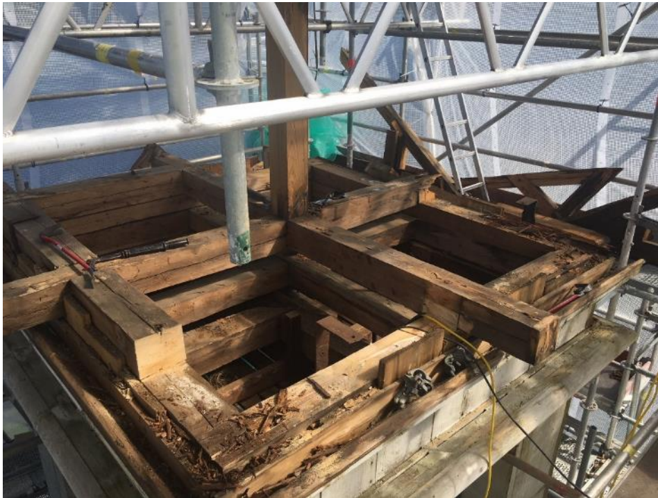
Figur 16 Översta timmervarven under takstolarna, foto: Joakim Nilsson Hammarstrands bygg.
