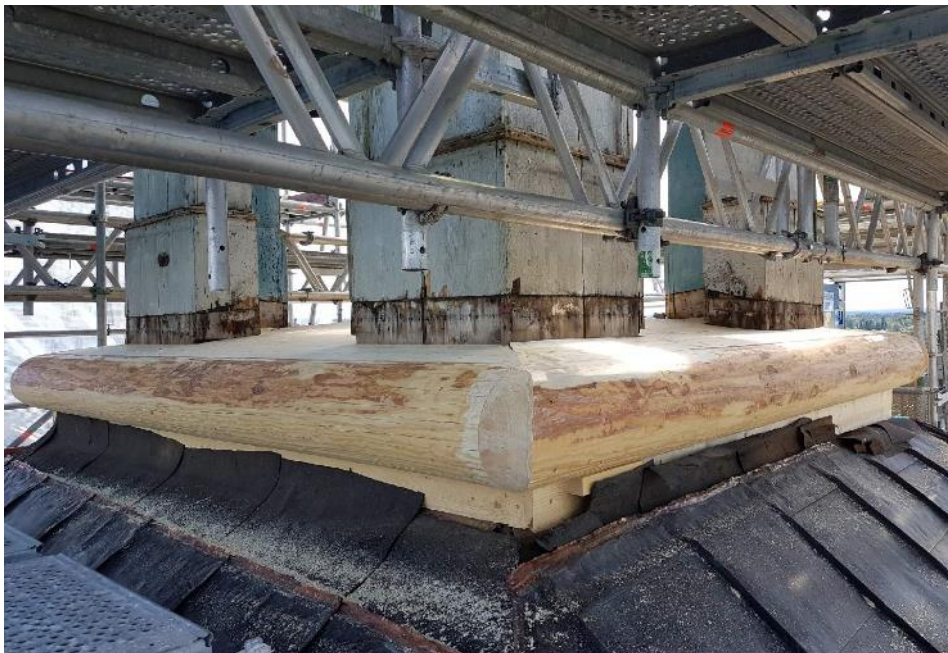
Figur 11 Sockel på lanternin efter att de nya halvklavorna kommit på plats. foto: Joakim Nilsson Hammarstrands bygg.
