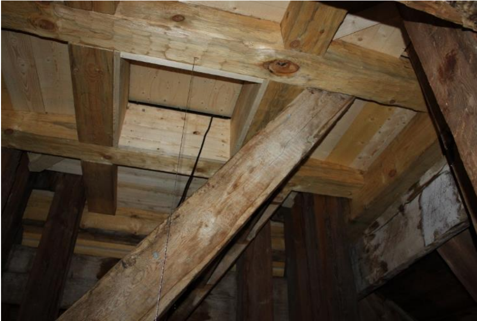
Figur 8 Lanterningolv sett underifrån efter åtgärd.
