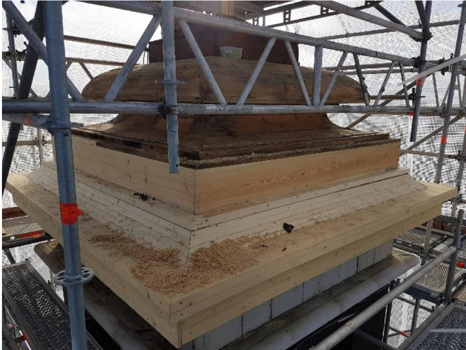
Figur 21 Ursprungligt material gick att återanvända till den övre delen av lanterninen. foto: Joakim Nilsson Hammarstrands bygg.
