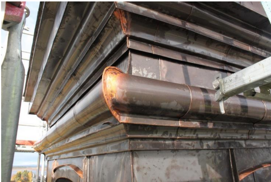
Figur 27 Lanternin efter åtgärd.
