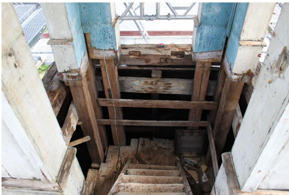
Figur 3 Lanterninen efter att plåt och golvkonstruktionen avlägsnats.
