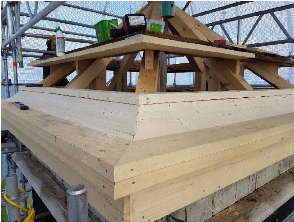
Figur 20 Nedre delen av lanterninens tak har förnyats. Man klarade inte av att göra den svängda delen i ett stycke, som tidigare utan delade upp den i flera mindre delar. foto: Joakim Nilsson Hammarstrands bygg.
