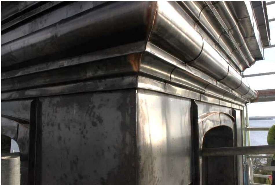
Figur 26 Lanternin efter åtgärd.
