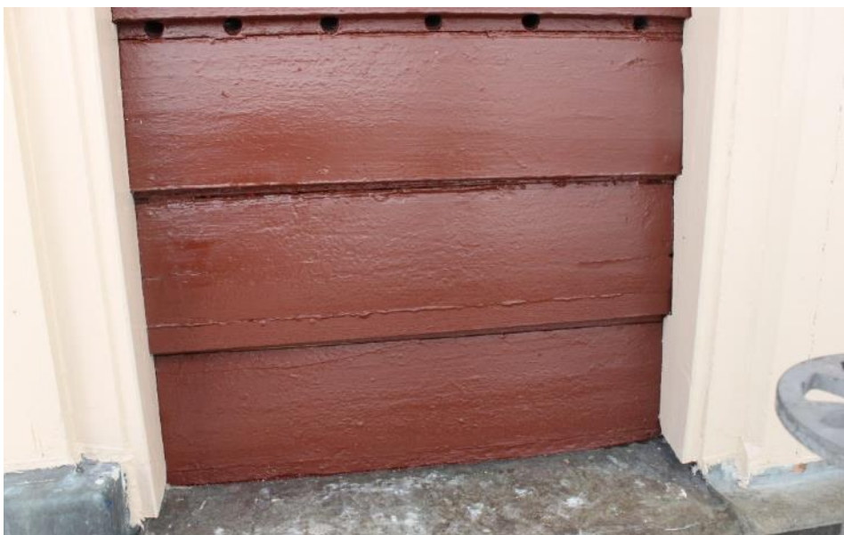
Figur 23 Saknade delar av de två nedersta brädorna har ersatts med nytt virke.
