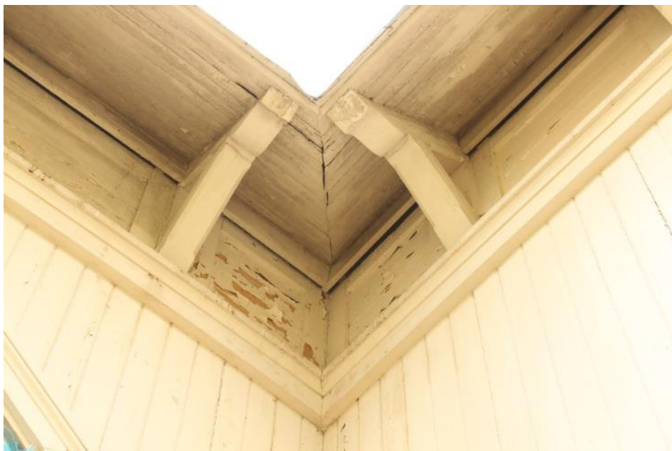
Figur 18 I det inre sydöstra hörnet, i vinkeln mellan långhus och korsarm var takpanelen anfränt.
