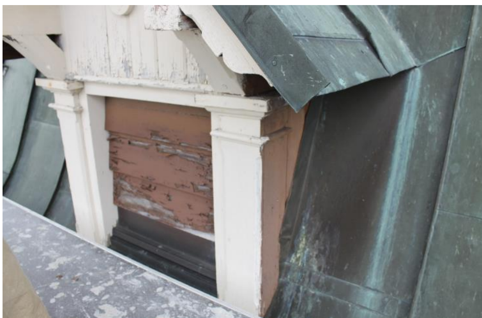
Figur 33 Takkupa före åtgärd.
