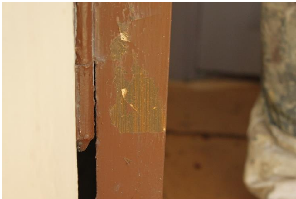
Figur 27 Den yttre bruna färgen tillkom troligen vid mitten av 1980-talet. Under denna återfinns en tunn, brun strykning synlig på kanten av dörren.
