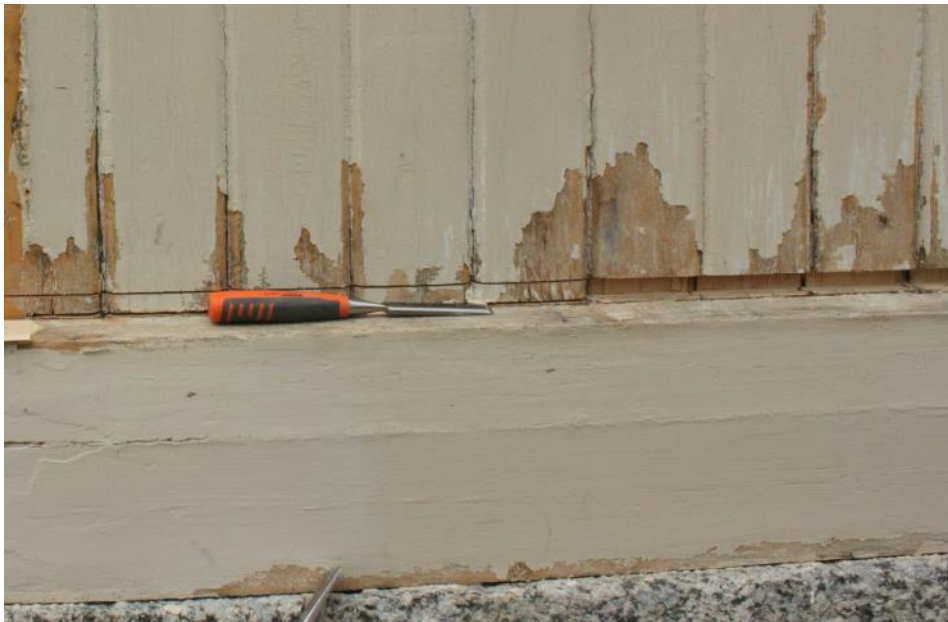
Figur 2 Fasadpanelen har ovanför sockelbräda spårats för den nya plåtavtäckningen.
