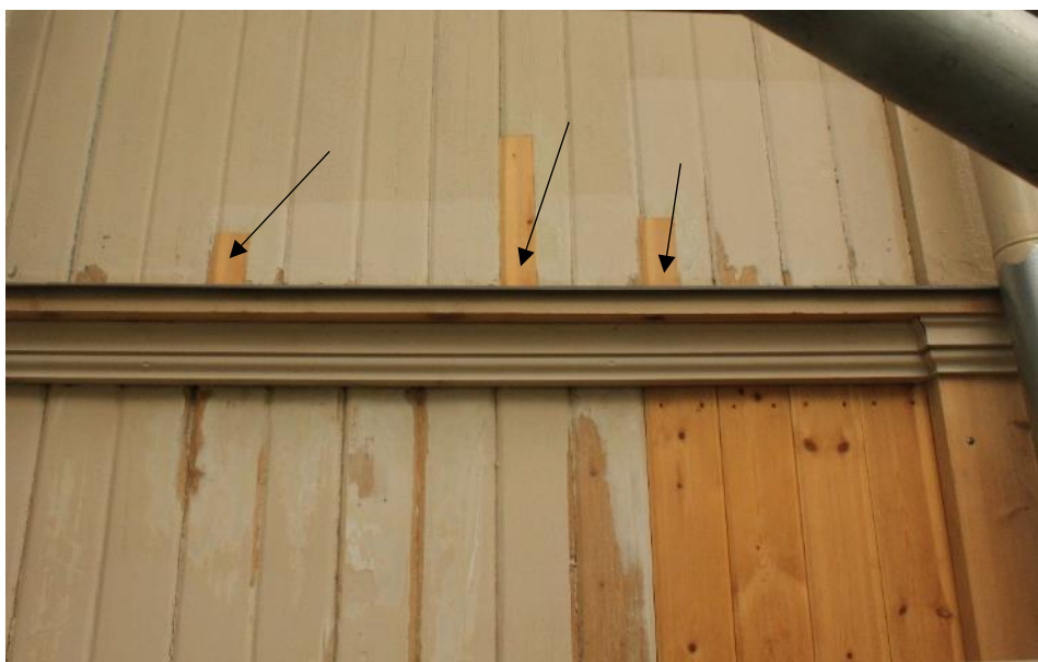
Figur 16 Ovanför midjebandslisten har panelen lagats på tre ställen. Den bortskurna delen av panelbrädan har ersatts med nytt virke som limmats dit med 1-komponents polyuretanlim (SikaBond-545).
