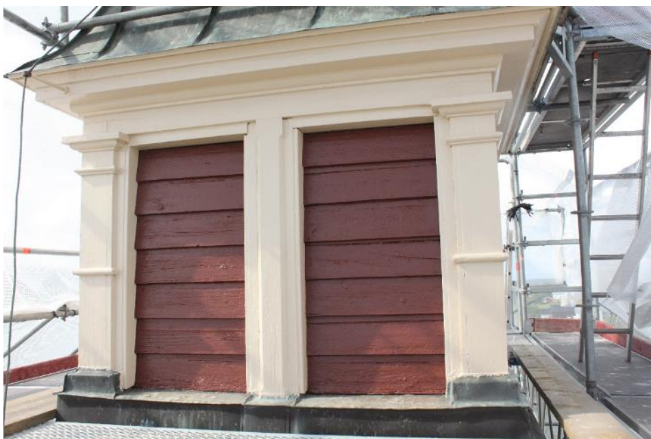
Figur 32 Lanternin efter åtgärd.
