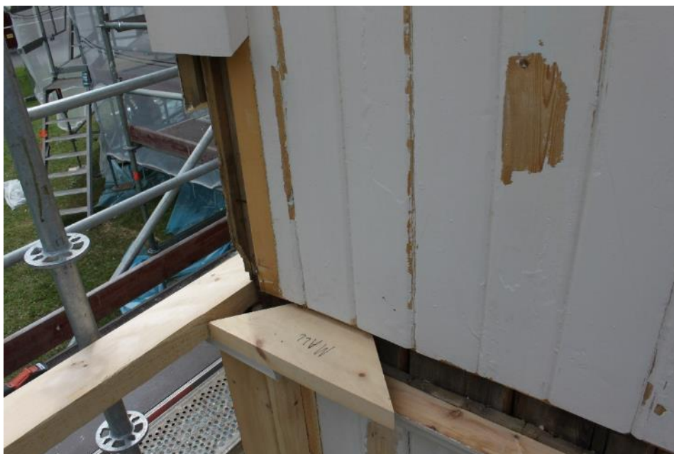
Figur 3 Den nya vattbrädan har fasats för att få bra vattenavrinning.
