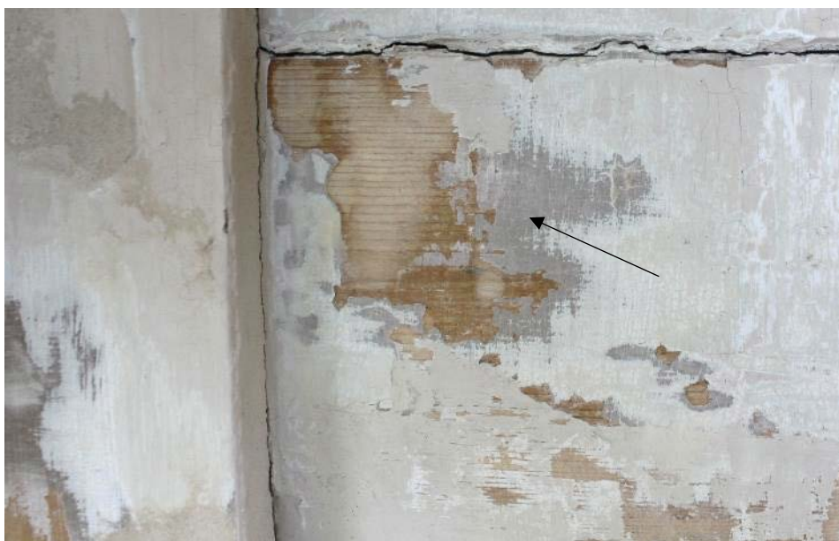
Figur 24 Vid taklisten på tornet hittades spår av en grå kulör.
