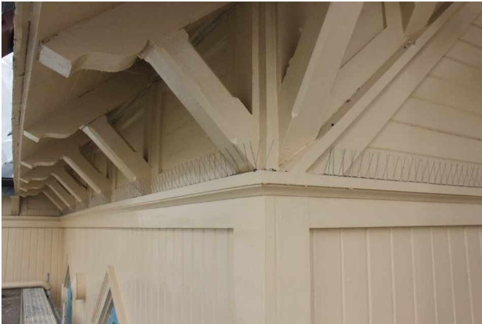
Figur 43 Fågelpiggarna har monterats på alla horisontella stöd vid taket och efter taklisten.
