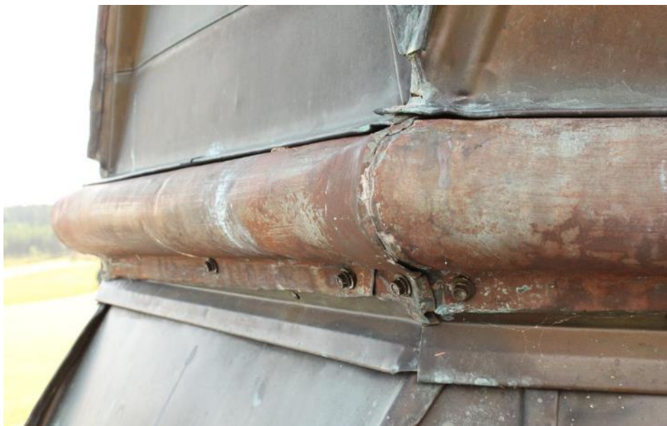
Figur 41 De delar av den rundade plåtlisten som gick att nå från ställningen, har skruvats fast.
