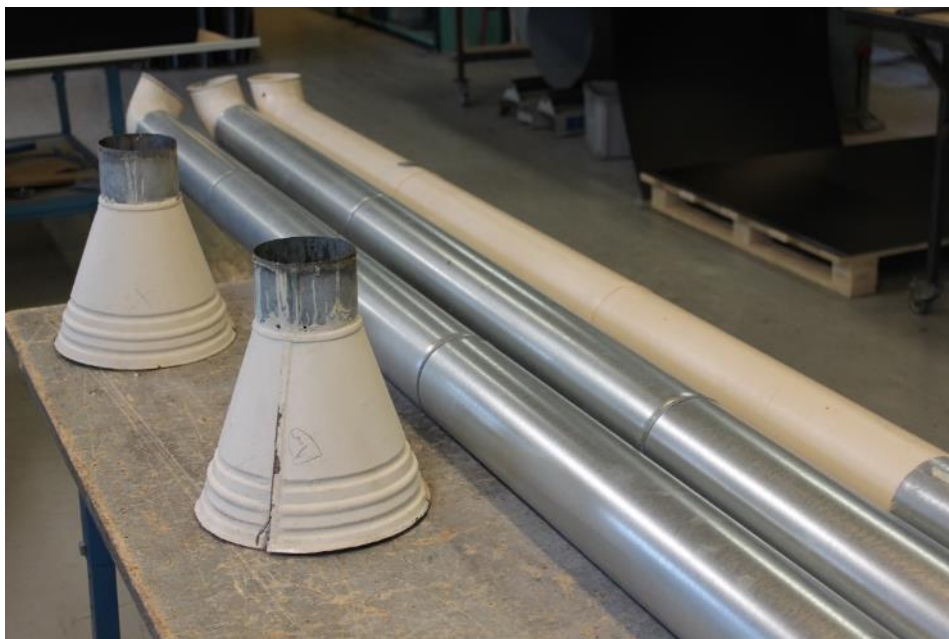
Figur 42 Delar av de tidigare stuprören har återanvänts.
