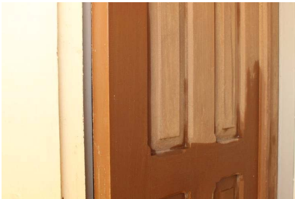
Figur 26 Dörren mot öster, som ännu inte berörts av ommålningen, hade vid starten för 2019 års arbete, kvar sin bruna kulör. På bilden har delar av dörren trättats. På de fuktade ytorna har den urblekta bruntonen återfått något av sin ursprungliga kulör.
