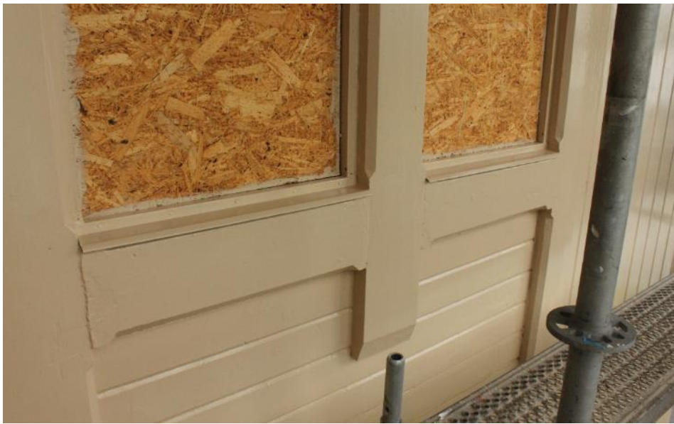
Figur 39 Fönstren halvvägs upp på tornet som tidigare saknade fönsterbleck, har försetts med sådana.
