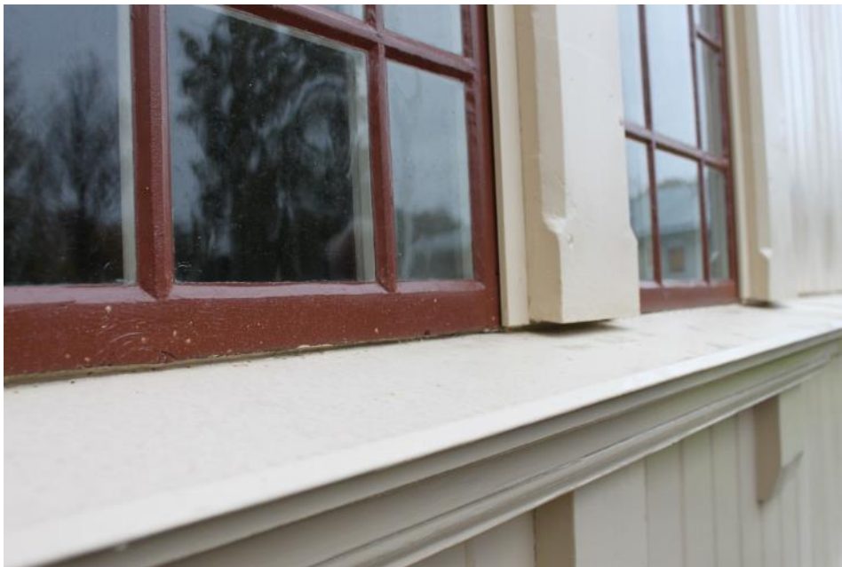
Figur 10 Fönster efter åtgärd.
