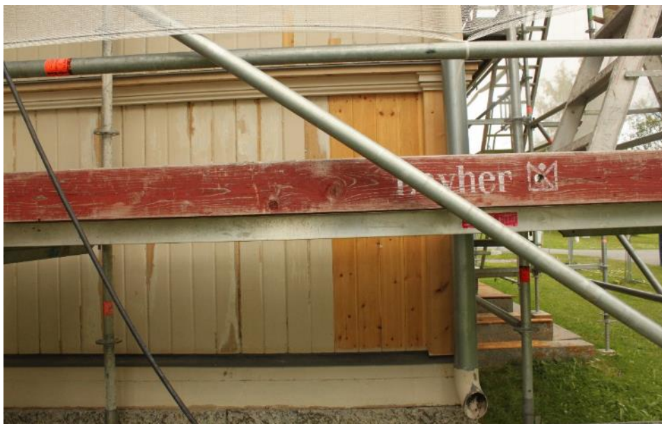
Figur 14 Fyra stycken panelbrädor och knutbrädor nedanför midjebandslisten har ersatts med nytt virke.
