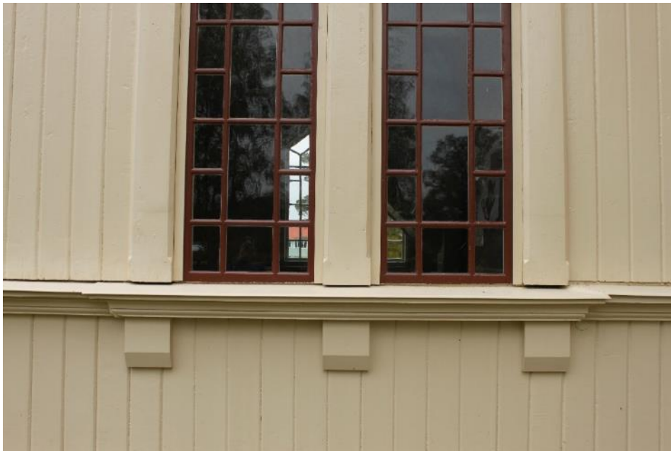
Figur 9 Fönstret på den västra sidan av tornet efter åtgärd.
