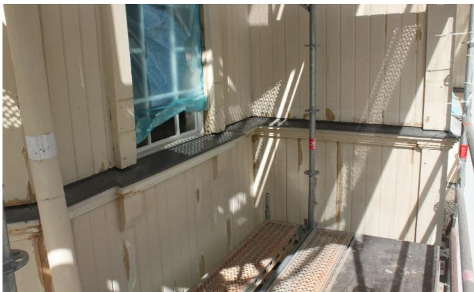
Figur 38 Plåtavtäckningen vid midjebandslisten och sockelbrädan har bytts ut.
