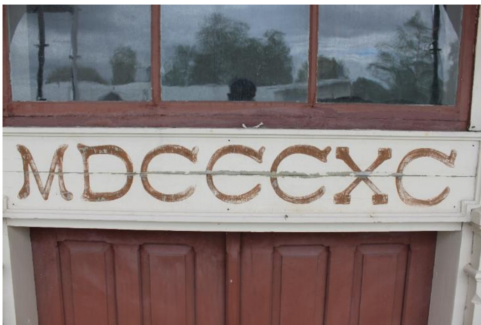
Figur 29 Inskriptionen var före åtgärd väldigt sprödd.
