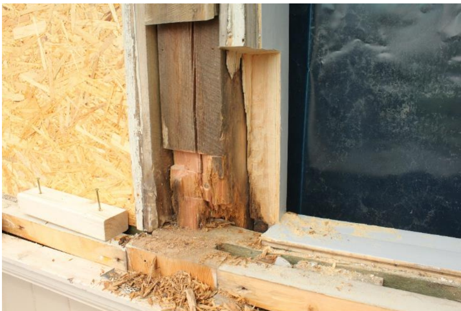
Figur 6 Delar av firsörningen mellan fönstren och karmen har sågats bort och ersatts med nytt virke.
