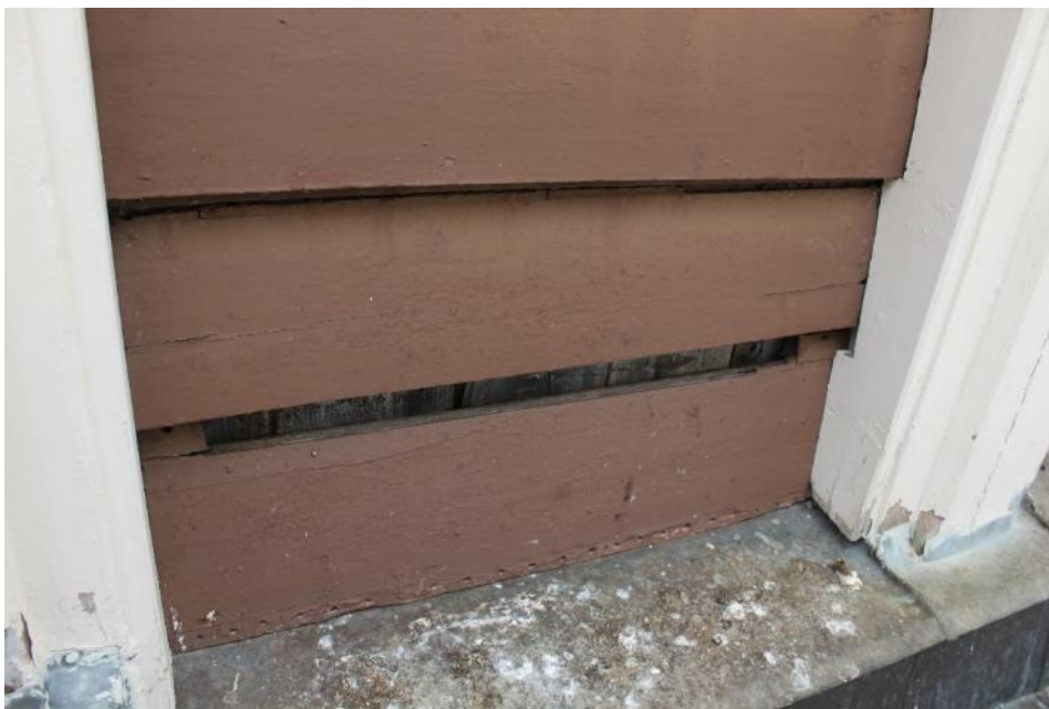
Figur 22 På en av jalusiluckorna på lanterninen mot nordöst saknades delar av de två nedersta brädorna, dessa har ersatts med nytt virke.
