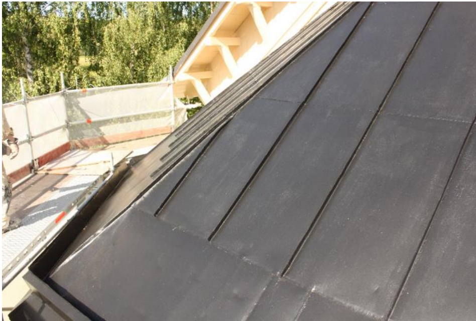
Figur 36 Plättaket på sakristian efter åtgärd.
