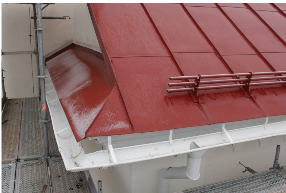
Figur 10 Sydvästra hörnet efter åtgärd.
