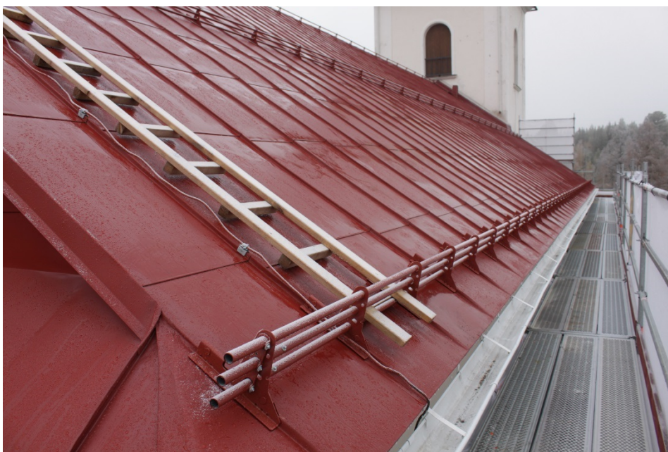
Figur 8 Norra takfallet efter åtgärd.
