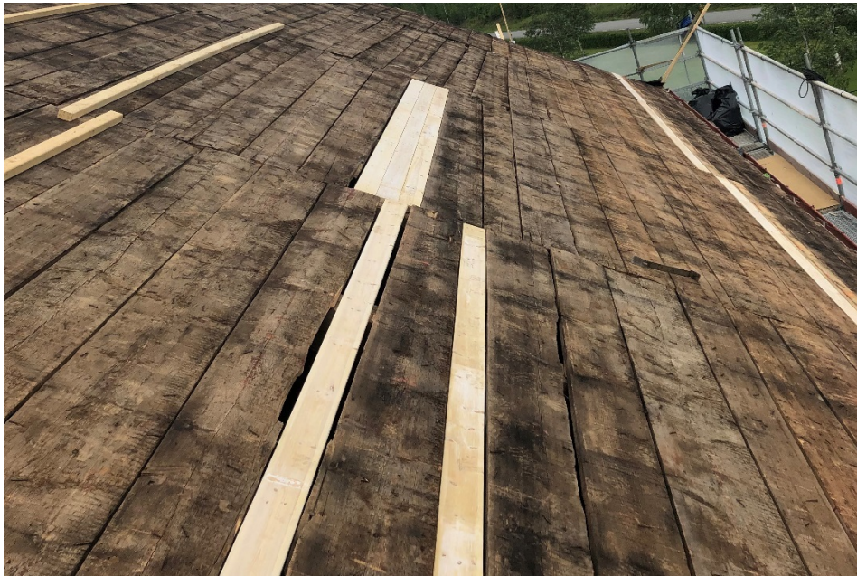
Figur 5 Cirka 35 kvm av rotningen har bytts ut eller kompletterats med nytt virke. Foto: Torbjörn Winther.
