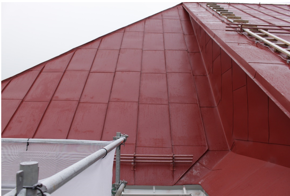
Figur 12 Norra takfallet på sakristian efter åtgärd.
