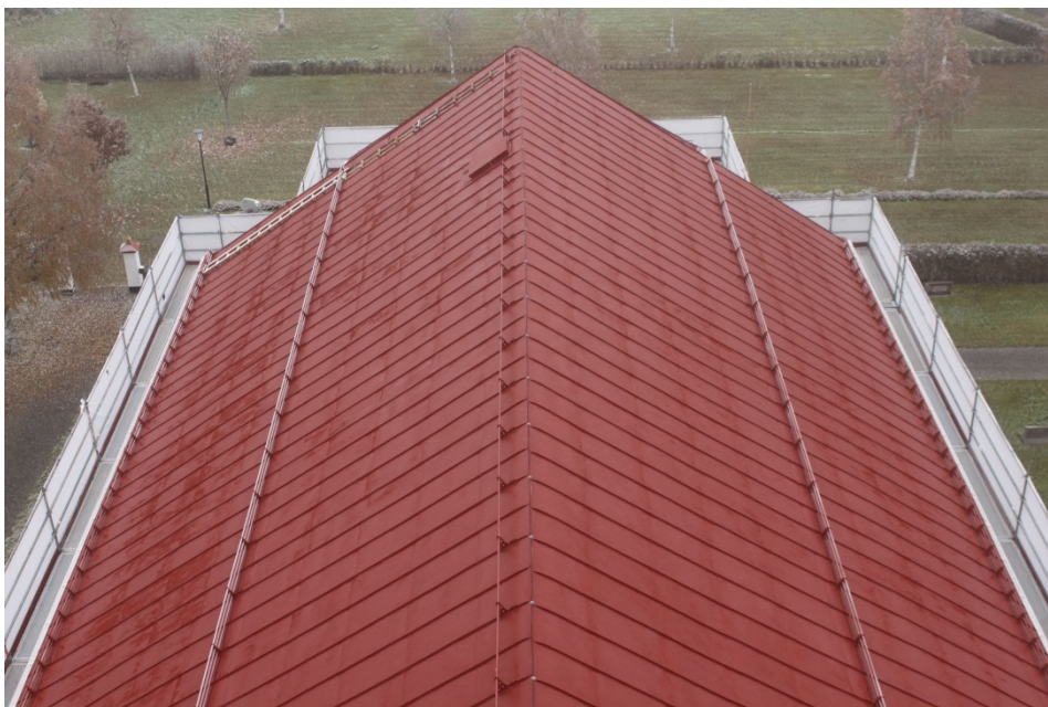
Figur 20 Taket efter åtgärd sett från tornet.
