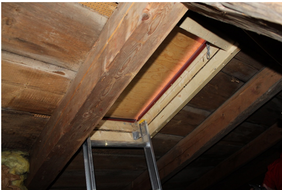
Figur 15 Västra takluckan från vinden.
