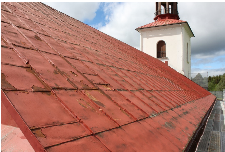
Figur 7 Norra takfallet före åtgärd.
