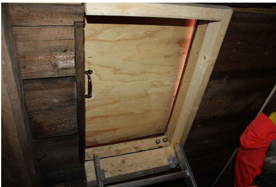
Figur 16 Östra takluckan från vinden.
