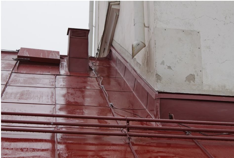
Figur 13 Ny taklucka i väster närmast tornet.
