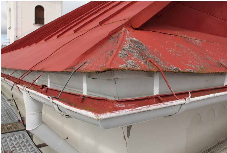
Figur 17 Hängerädda och stuprör i sydöstra hörnet före åtgärd.
