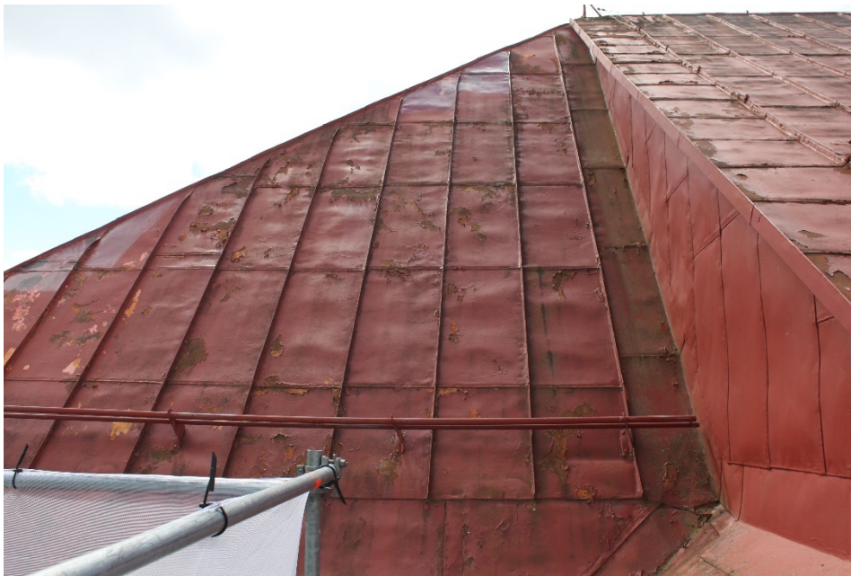
Figur 11 Norra takfallet på sakristian före åtgärd.
