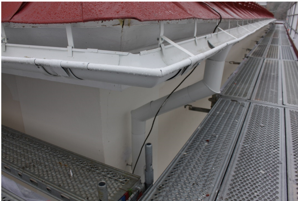
Figur 19 Hängränna och stuprör efter åtgärd.
