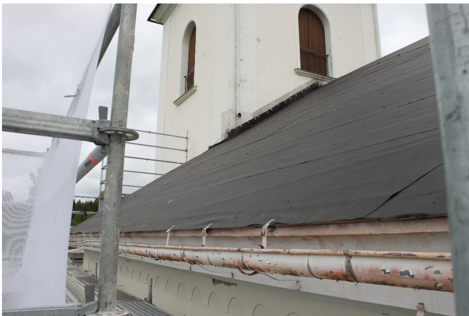
Figur 6 Södra takfallet sedan man satt papp.
