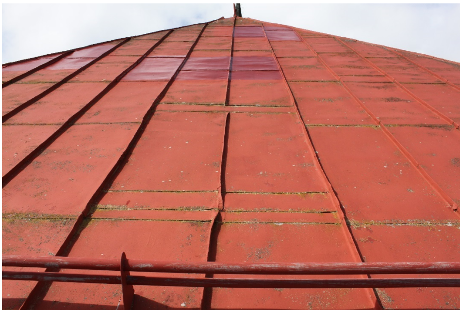
Figur 4 Östra takfallet på sakristian före åtgärd. Mitt på taket kan man ana lagningen efter den skorsten som tidigare fanns där.
