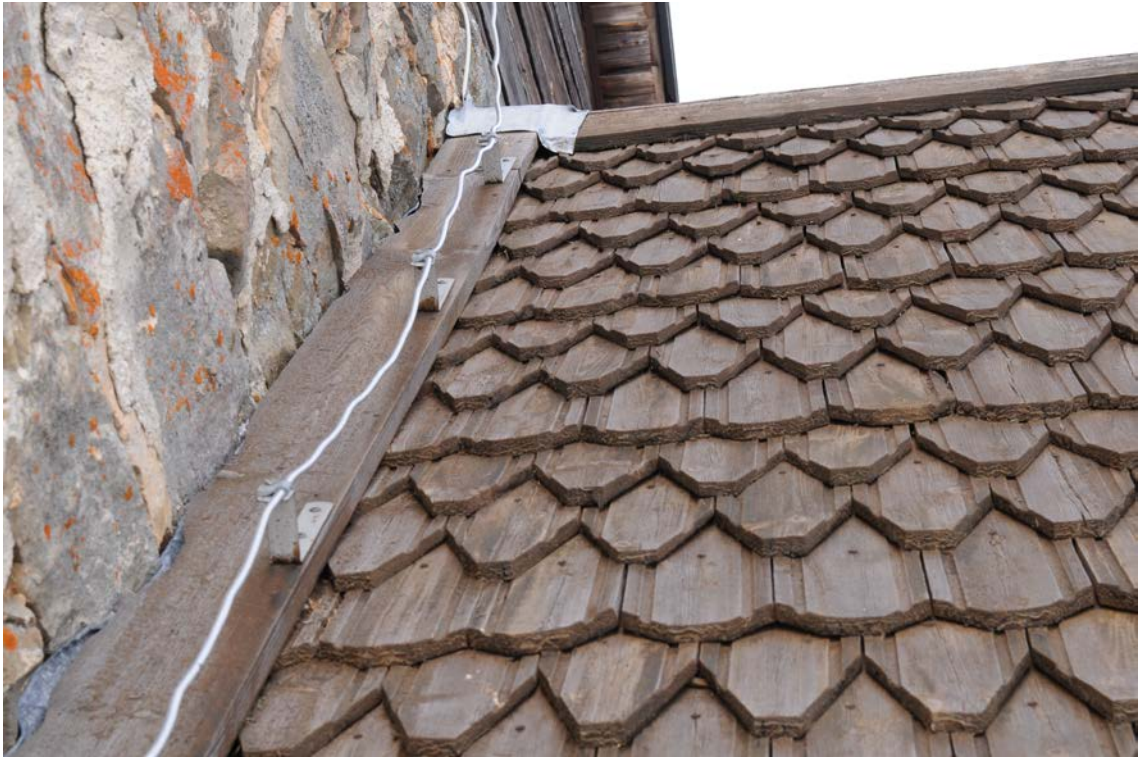
Den sågade stavspånen före brädtaket lades ovanpå. Spånen är lagd i trelagers täckning där två skiftet har näbbformad underkant medan det tredje skiftet är rundat. Lägg märke till att spånen har vattenspår.
