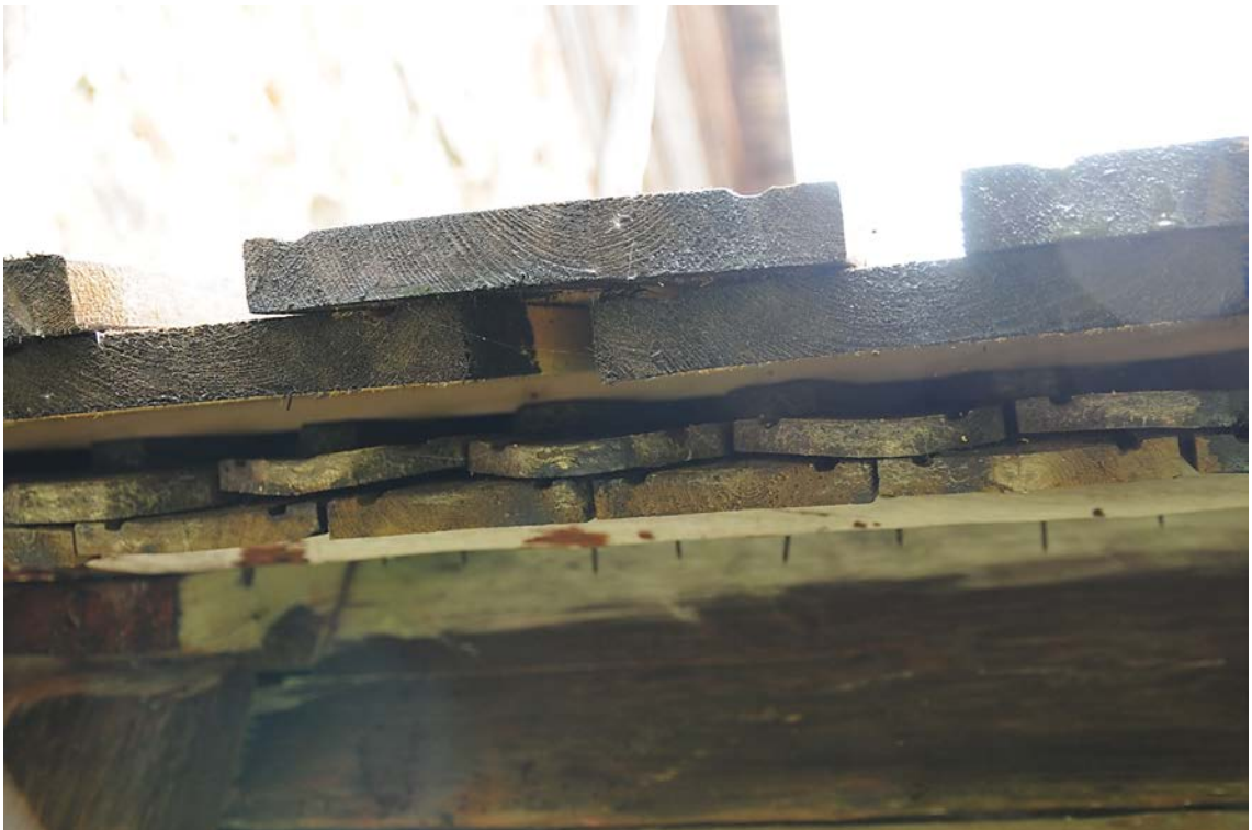
Sakristians två skikt, det undre gamla spåntaket och det övre ca 34 mm tjocka brädtaket.
