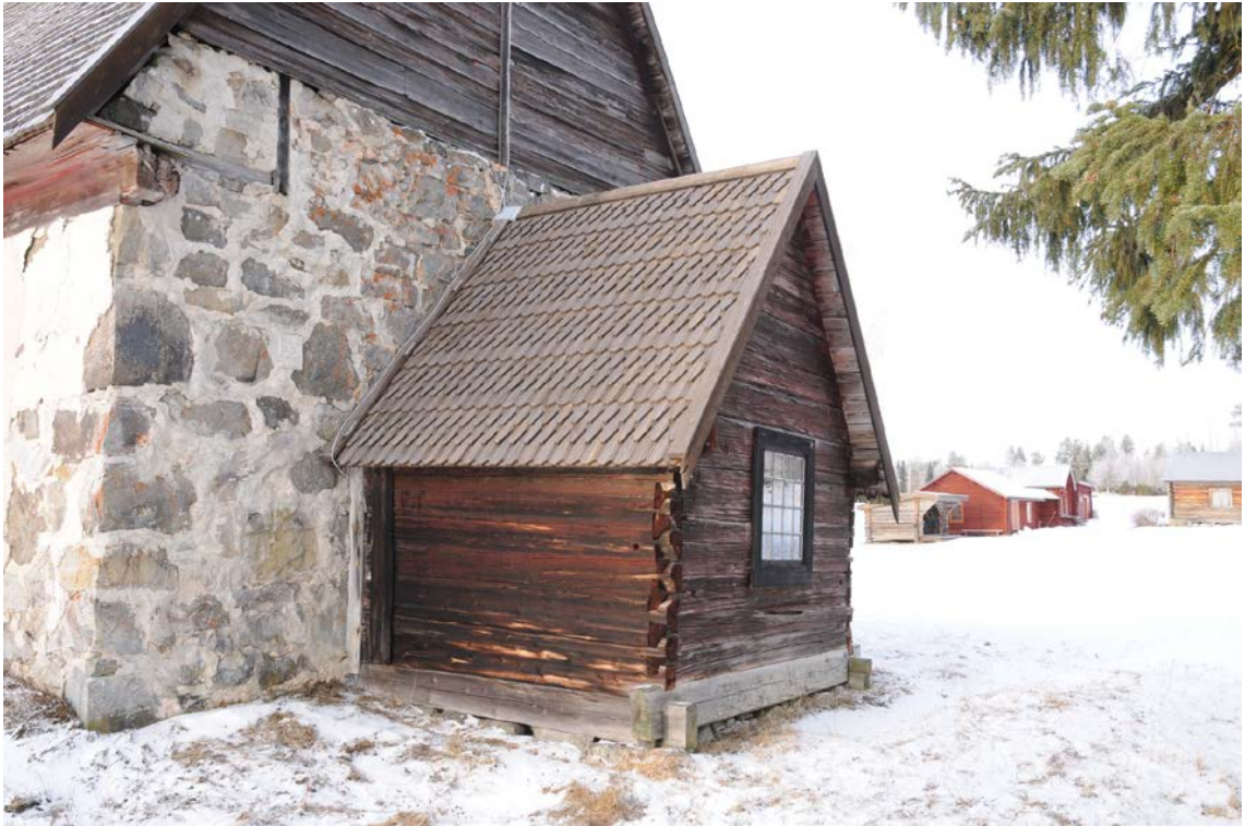
Sakristian sedd från norr med det gamla stavspånstaket.
