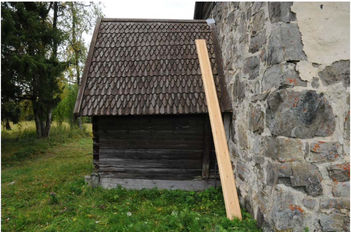
Sakristian sedd från söder med det gamla stavspånstaket.
