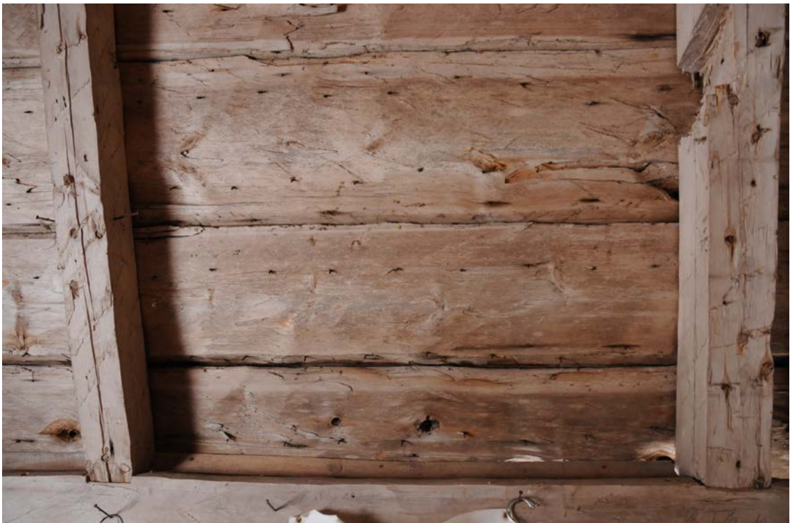
Rotningens handbilade brädor (möjligen original, 1670-tal) sedda inifrån sakristian. Spåns pikarna går igenom brädorna och det finns därutöver även hål efter en äldre generation spån. Det var för att skona undertaket så mycket som möjligt som det nya taket blev ett brädtak och inte ett nytt spåntak.
