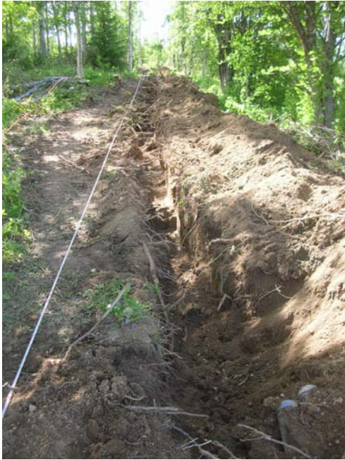
Foto 1. Schaktet fotograferat från nordväst.
