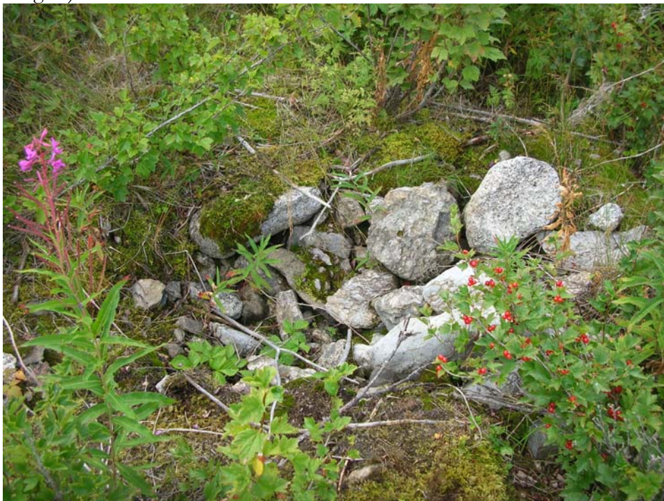
Bild 3. Del av ett av de mest skadade rösena.
