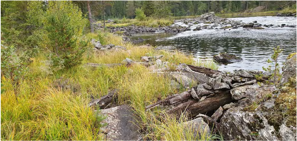
Fig. 36. Enkel tråkista (stenkista) (L2019:3959).
