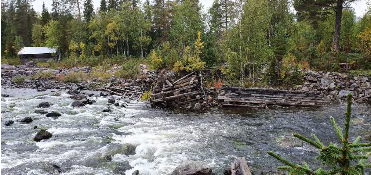
Fig. 88. Dammvall (L2019:4054), nordvästra sidan.
