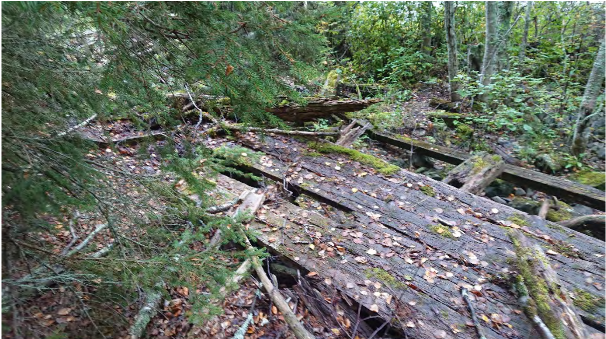
Fig. 112. Träindustri, kanal, skibord/botten av ränna (L2019:4087).
