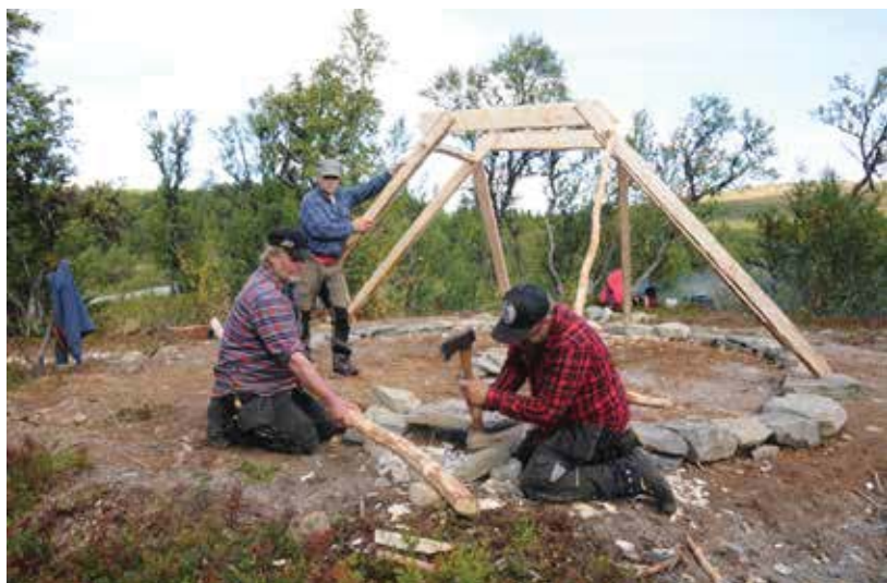
Rekonstruktion av riskåtans stomme i Glen. Lasse Wagenius, Bengt Arne Johansson och Andreas Salomonsson monterar de stödjande klykorna.
