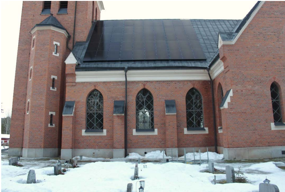
Figur 7 Långhusets södra takfall efter åtgärd. Foto: 2019-02-27.
