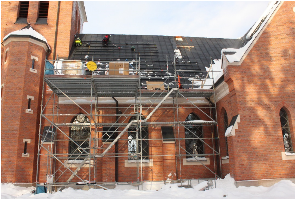
Figur 3 Bärreglar håller på att monteras. Foto: 2019-02-11
