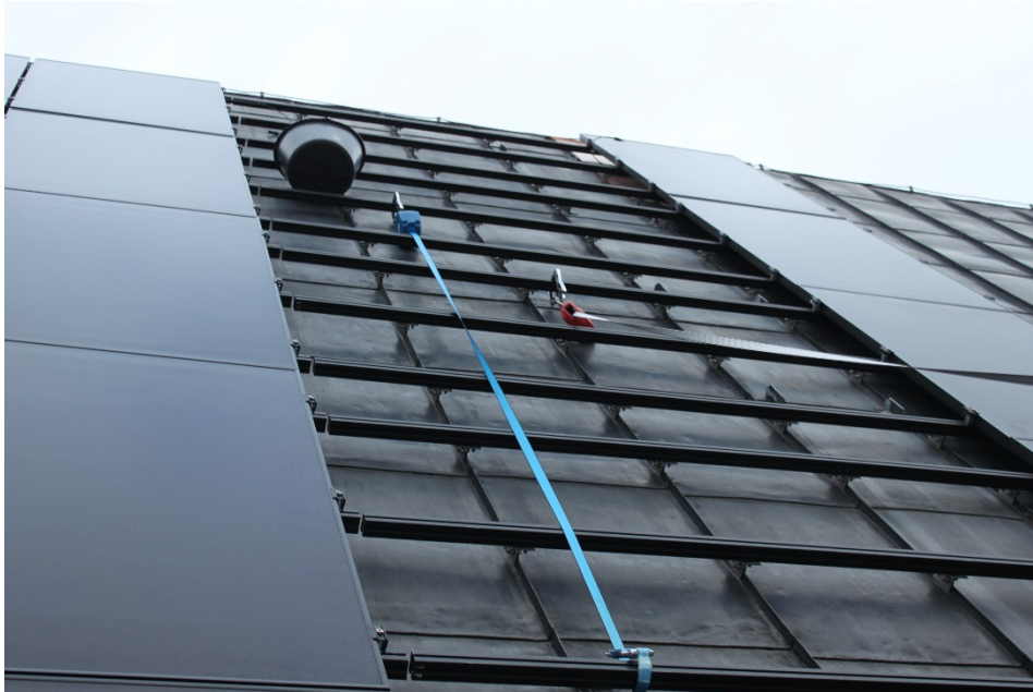
Figur 5 Med hjälp av falsfästen har bärreglar monterats över taket som solpanelerna sedan fästs på. Foto: 2019-02-15
