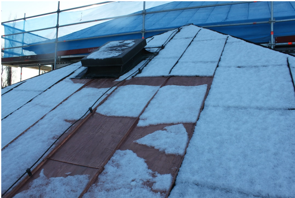
Figur 16 Sakristian efter åtgärd. Hål efter den rivna skorstenen är lagat med kopparplåt. Foto 6 november 2017.
