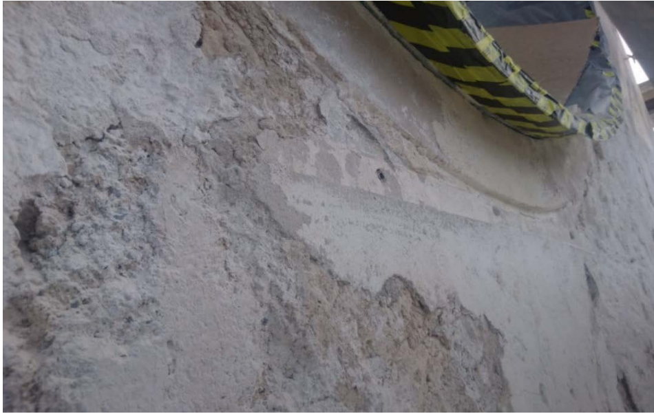
Figur 19 Under pågående arbete (foto Björn Persson)
