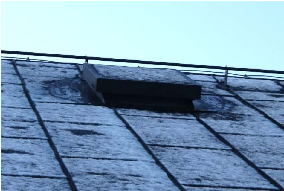
Figur 13 Den utbytta takluckan mitt på taket, efter åtgärd.
