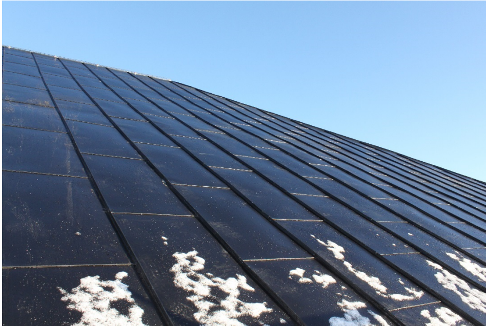
Figur 7 Taksfall efter åtgärd.
