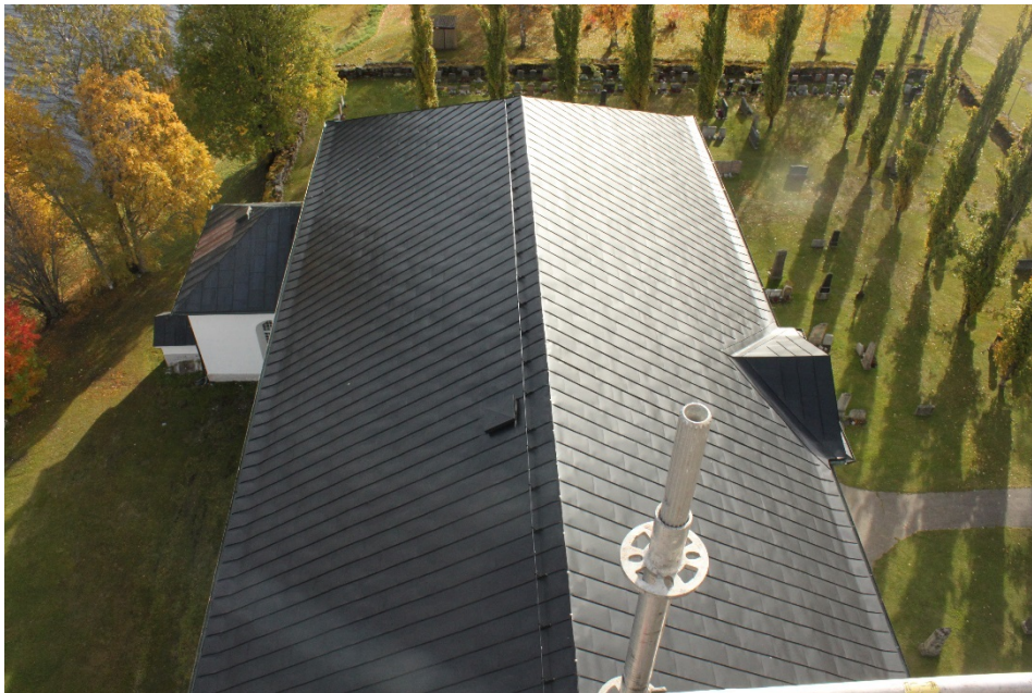
Figur 10 Långhustaket sett uppifrån lanterninen. Foto 2018-10-01.
