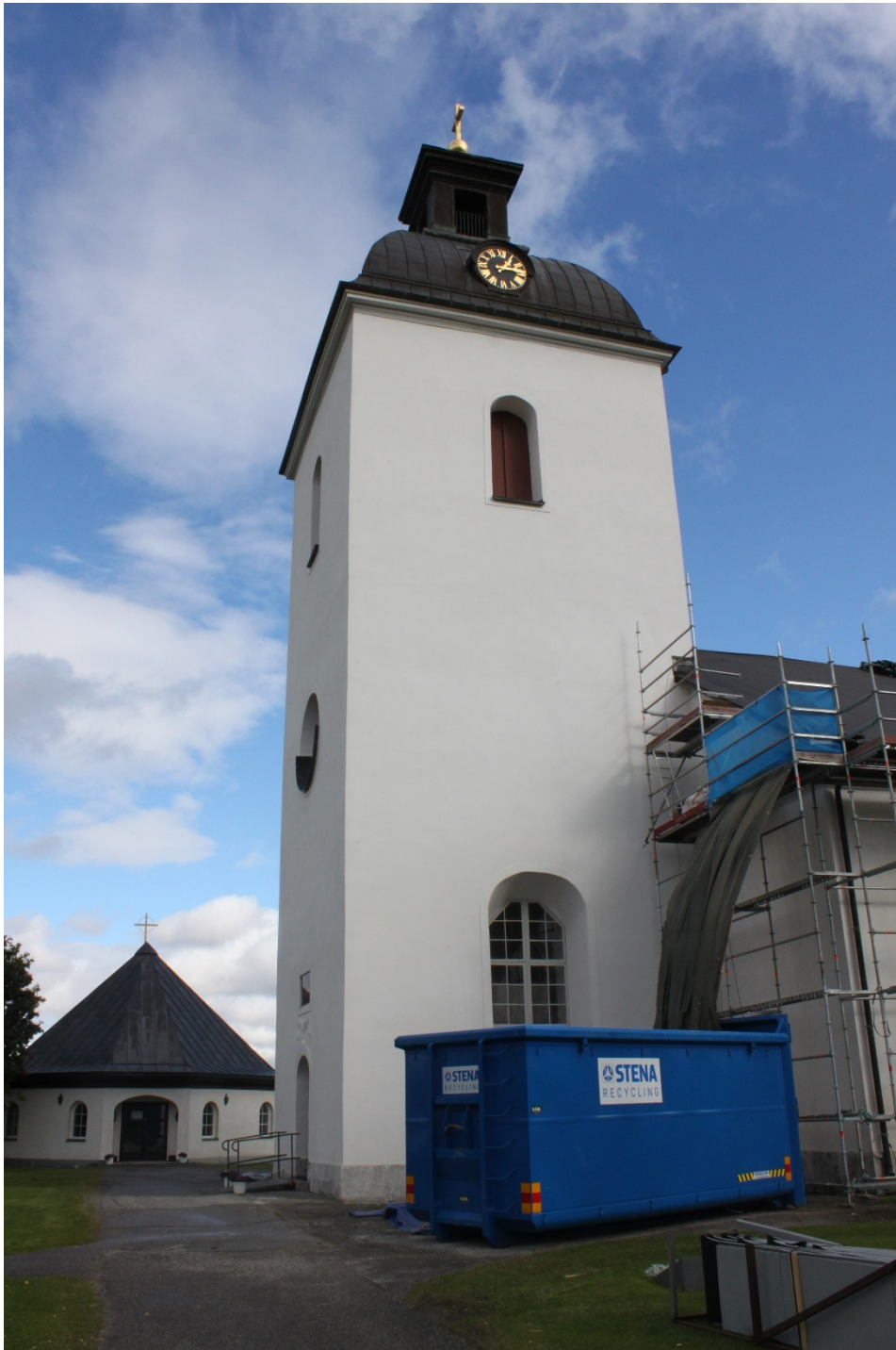
Figur 21 Tornet efter åtgärd.
