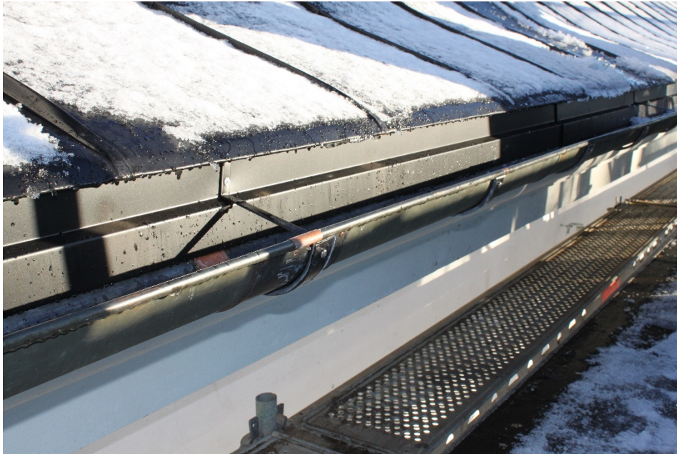
Figur 8 Den gamla hängrännan har återanvänts, liksom de gamla järnkrokarna. mellan dessa har man isolerat med blyplåt.
