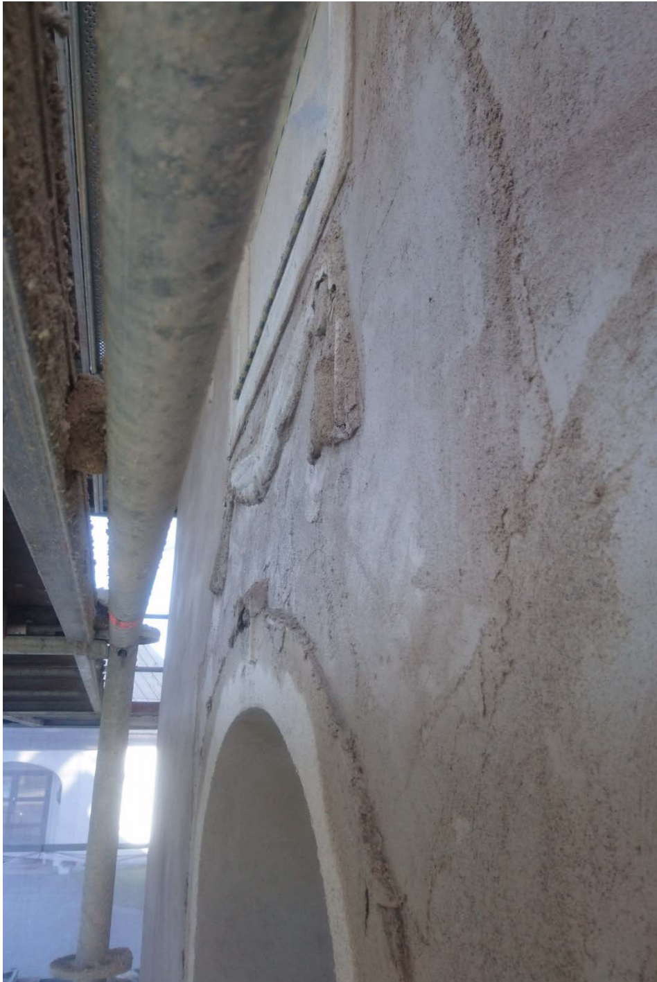
Figur 18 Under pågående arbete (foto Björn Persson)
