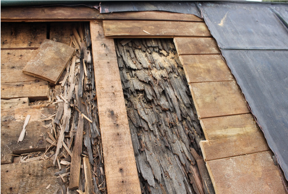
Figur 1 Rivning av plåt, takbrädor och spåntäckning.
