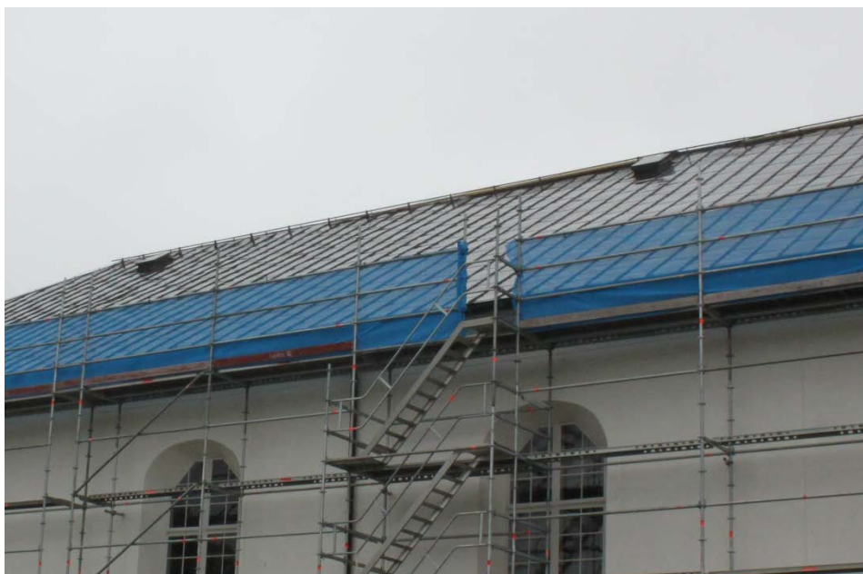
Figur 11 Norra takfallet före åtgärd med de båda takluckorna. Den vänstra takluckan på bilden togs bort, i samband med omläggningen av taket.
