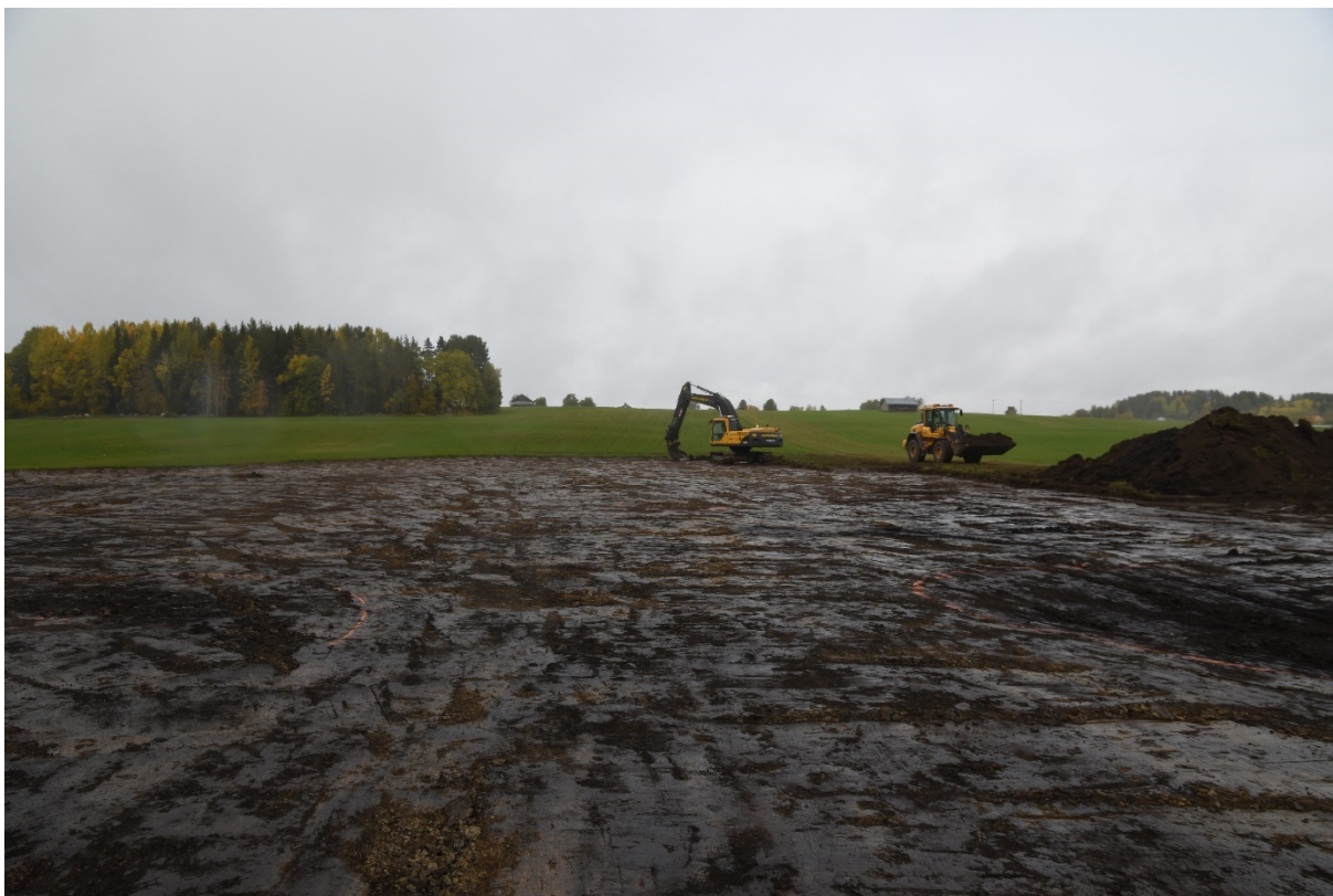
Förundersökning av Brunflo 470. Matjordsavbanade ytan sett från söder.
