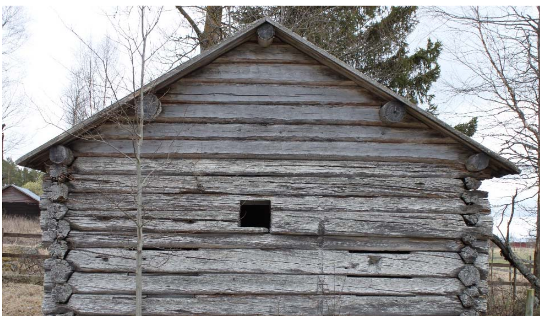
Blomtorpet. Utbytt virke i röstet. Huggningstekniken på stockarna är en helt annan än på originalvirket. Den repetitiva dalabilningen finns även på insidan av stockarna där dessutom vissa originalstockar hade kvar sin rundning. Här har således inte åtgärderna anpassats efter förutsättningarna på platsen.
