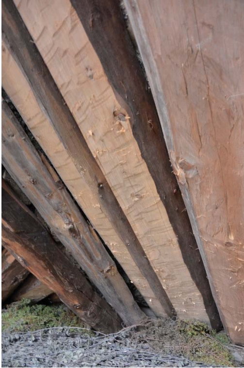
Bartjan, Kåta no 9 och no 35. Till vänster syns den bilade innerveden där valet av verktyg och huggningsteknik är gjort för att likna den huggning som fanns på originalvirket. Till höger en konstruktion där man på ett bra sätt har valt ut virke för att så bra som möjligt rekonstruera utseendet på originalkonstruktionen med självväxta klykor.
