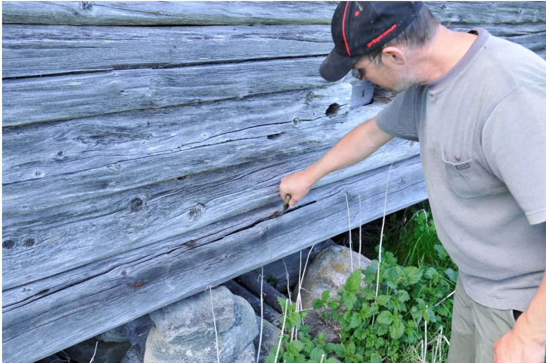
Långbodarna, Ladugård XIV. Syllstocken som trots att den ligger högt över mark och mot sydost har en allvarlig rötskada. Här kan man misstänka att stocken inte var frisk i samband med att man lade in den i stommen.
