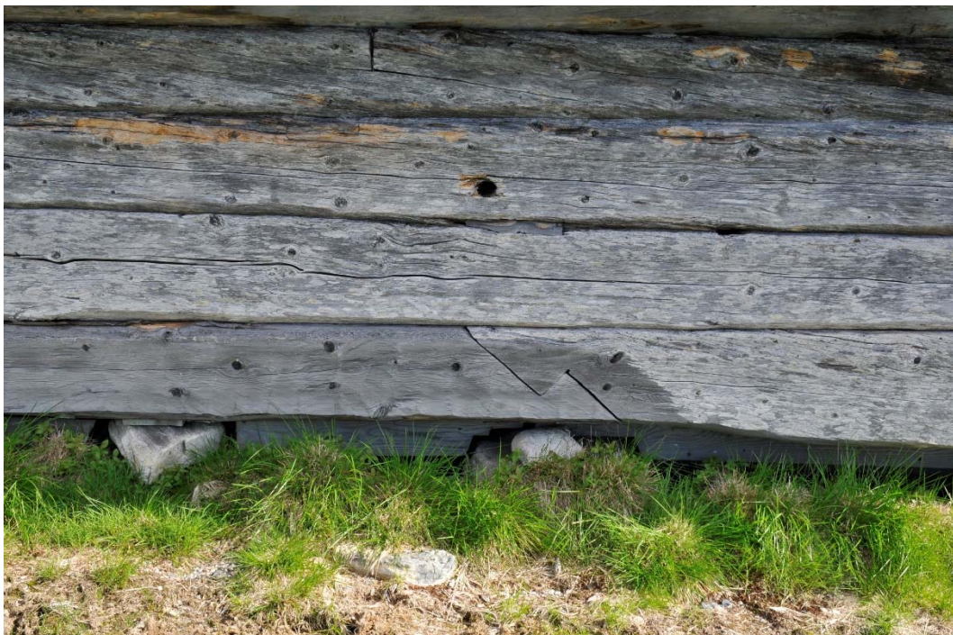
Långbodarna, Fjös XVII. Blixtskarv i syllstocken. För att blixtskarvar ska hålla bra måste det finnas ett stöd (upplag) under skarven. Här har stödet sjunkit men ännu ligger det ett tryck på intilliggande stöd till vänster så att skarven håller. Andra exempel på liknande lagningar på vällen visar att blixtskarvar inte är lämpligt i syllvarv men tanke på de dåliga grundförhållandena.
