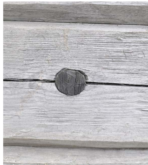
Ytterberg 36:12, Härbre. Vid infästningen av halvsulningarna på väggen användes olika typer av dymlingar för att pröva olika tekniker och det ger en god möjlighet att på sikt utvärdera hur de håller. Ännu så länge finns det inga brister i någon av de olika infästningstyperna. Till vänster en dymling med en grövre skalle som håller fast den halvsulade ilagningen, till höger en dymling med en inslagen kil som gör att ilagningen hålls fast.
