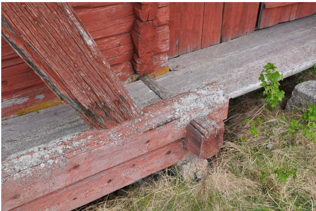
Ytterberg 54:1, Loft no 2. De stockar som ligger i svalen är utsatta för fukt och har skadats av röta. Stockarna är inte av nog bra kvalitet.
