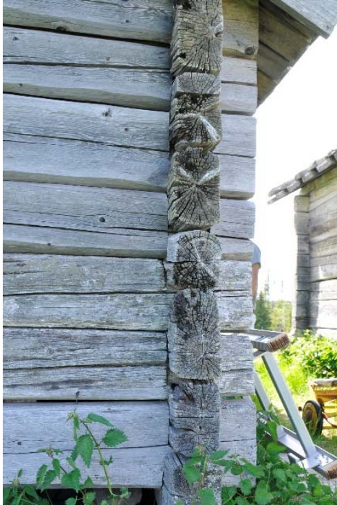
Långbodarna, Bod III och Fjös XVII. Olika utförande av knutlagningar. I båda fallen har man ilagat saknade eller skadade delar med begagnat virke. Till vänster har dimensioner och virkesval fungerat medan exemplet till höger sticker ut alltför mycket där vittringen är en helt annan på den utbytta delen och den passar inte heller varken formmässigt eller när det gäller träets årsringar. På Fjöset till vänster var åtgärderna inte planerade i förväg och åtgärderna gjordes mot slutet av säsongen när det fanns tid och material över vilket i viss mån kan förklara att nytt virke avviker från ursprunget.
