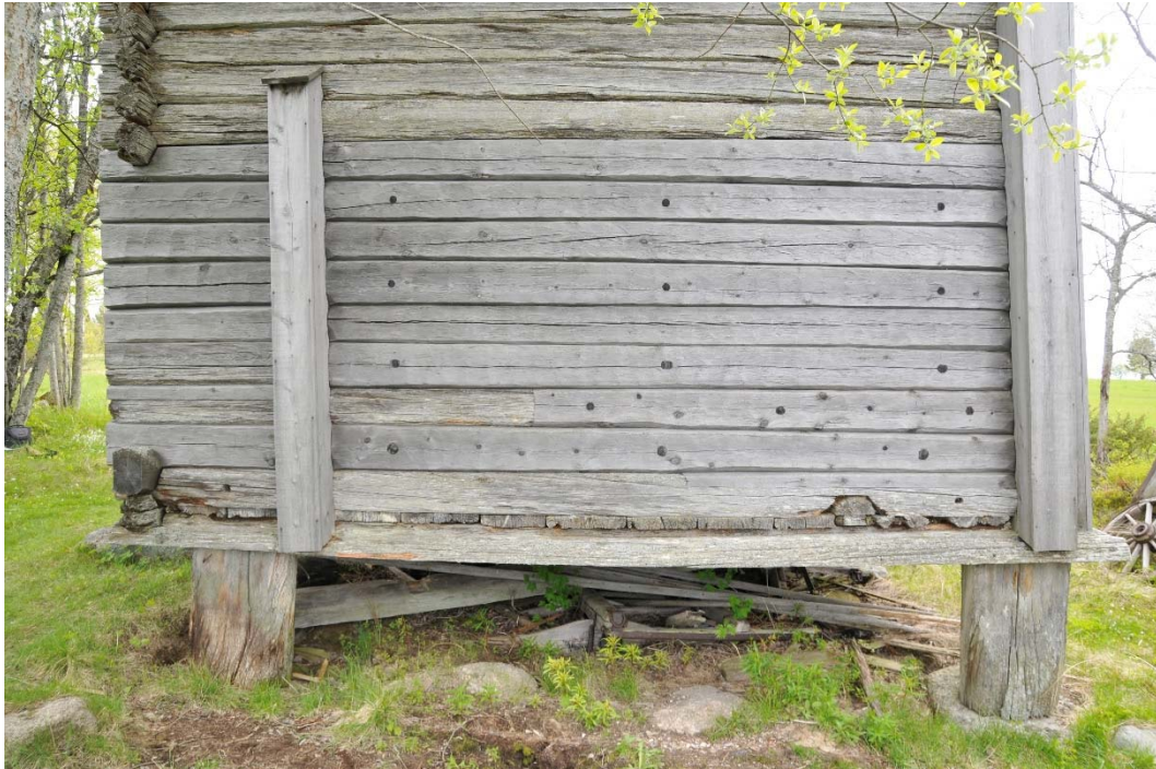
Ytterberg 36:12, Härbre. Vid upprustningen som skedde i form av en utbildning i hantverk provades olika typer av skarvningar och lagningar på denna vägg som var rötskadad på utsidan. Utförandet och hållbarheten på lagningarna har varit god och det finns inga tecken på att skarvningarna inte håller.
