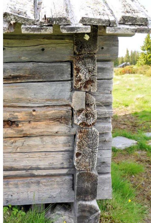
Långbodarna, Bod III och Fjös XVII. Olika utförande av knutlagningar. I båda fallen har man ilagat saknade eller skadade delar med begagnat virke. Till vänster har dimensioner och virkesval fungerat medan exemplet till höger sticker ut alltför mycket där vittringen är en helt annan på den utbytta delen och den passar inte heller varken formmässigt eller när det gäller träets årsringar. På Fjöset till vänster var åtgärderna inte planerade i förväg och åtgärderna gjordes mot slutet av säsongen när det fanns tid och material över vilket i viss mån kan förklara att nytt virke avviker från ursprunget.
