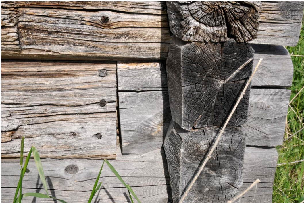
Långbodarna, Bod VIII. En typ av skarv som inte hållit då den har haft för litet material som går omlott och de pluggar som borrats snett in i virket har inte hållit för rörelserna i stommen.
