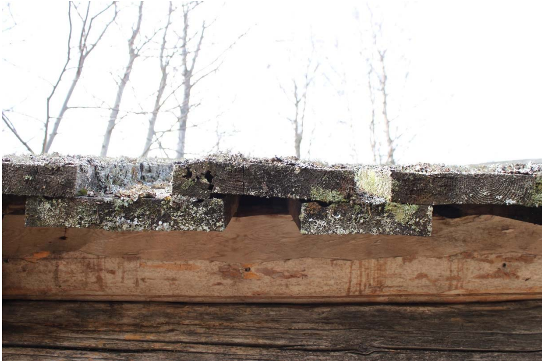
Blomtorpet. Brädtaket är i mycket dåligt skick och virkeskvaliteten är inte särskilt bra med låg kärnandel. Om virket valdes utifrån särskilt uppställda krav är inte känt.
