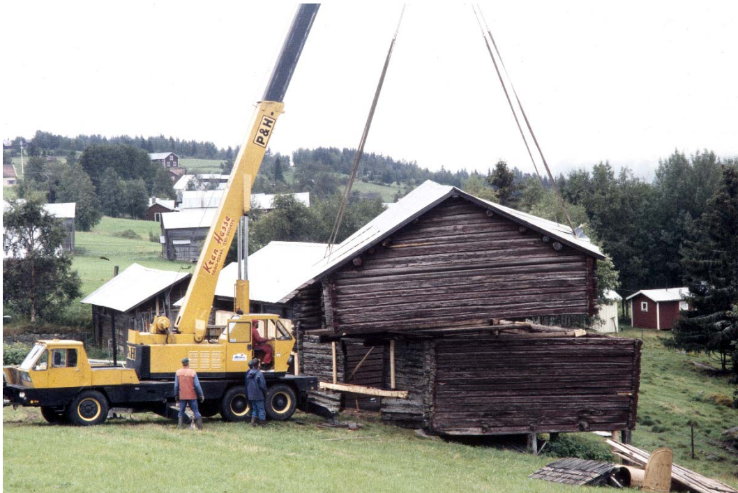
Ytterberg 54:1, Loge no 1. Här fanns det behov av timmerlagningar nära mark i anslutning till porten. Valet att lyfta bort byggnadens stomme i två delar och lämna den låga del som skulle åtgärdas kvar togs av ekonomiska skäl men framförallt av arbetsmiljö- och säkerhetsskäl. På ena sidan står logens stomme direkt på marken men på den andra sidan vilar den på höga stolpar. En lyftning i marknivå av hela byggnaden skulle riskera att den tippade. Åtgärden med kranlyftet visar att det fanns vid den tiden fanns resurser att åtgärda mer komplicerade och dyra projekt och att det fanns en öppenhet för mer oortodoxa och nya grepp för att lösa uppgiften.
