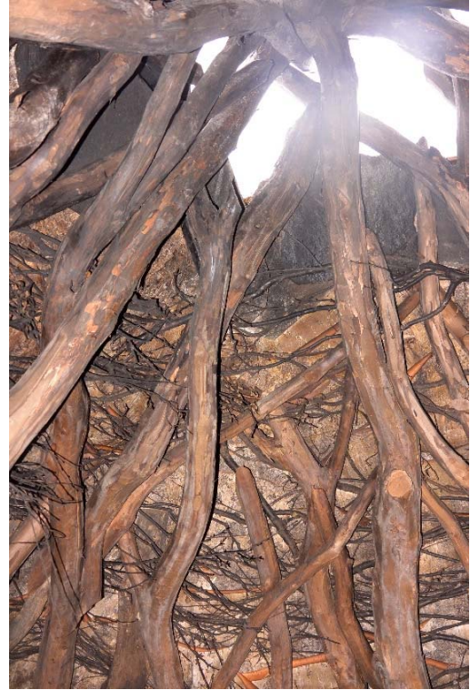
Bartjan, Kåta no 9 och no 35. Till vänster syns den bilade innerveden där valet av verktyg och huggningsteknik är gjort för att likna den huggning som fanns på originalvirket. Till höger en konstruktion där man på ett bra sätt har valt ut virke för att så bra som möjligt rekonstruera utseendet på originalkonstruktionen med självväxta klykor.
