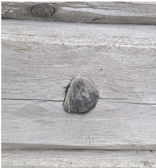
Ytterberg 36:12, Härbre. Vid infästningen av halvsulningarna på väggen användes olika typer av dymlingar för att pröva olika tekniker och det ger en god möjlighet att på sikt utvärdera hur de håller. Ännu så länge finns det inga brister i någon av de olika infästningstyperna. Till vänster en dymling med en grövre skalle som håller fast den halvsulade ilagningen, till höger en dymling med en inslagen kil som gör att ilagningen hålls fast.
