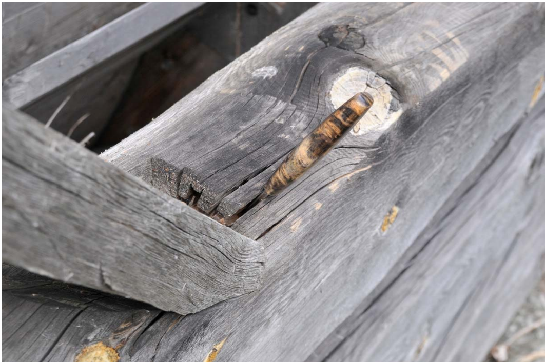
Duvberg, kornlada. I en av stockarna som bär upp vattenhjulets axel med tillhörande tak finns en djup rötskada. Även här torde den dåliga virkeskvaliteten vara den främsta orsaken.
