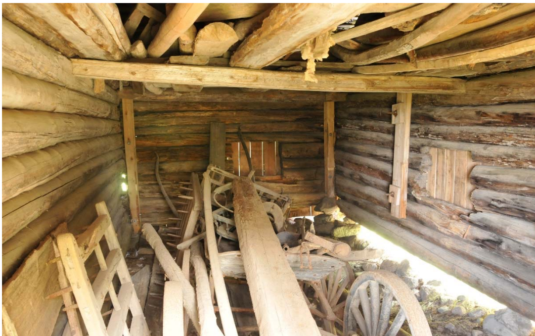
Ytterberg 54:1, Skjul no 6. Skadorna i skjulet var omfattande och om man skulle byta allt skadat skulle man passera en rimlig gräns både ekonomiskt och antikvariskt. Lösningen blev att man lyfte byggnaden med hjälp av följare i hörnen som sedan fick stå kvar som stöd för stommen. Med små åtgärder kunde man stoppa förfallet och byggnaden som är viktig för miljön som helhet gick att rädda.
