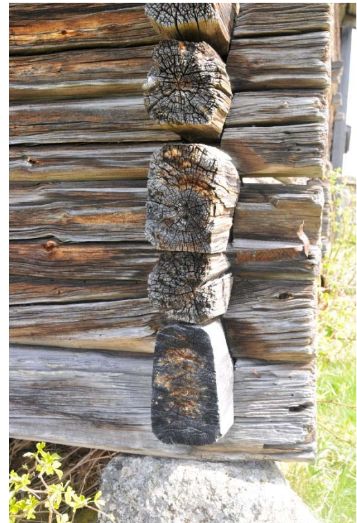
Långbodarna, Fjös XIV och Ytterberg 54:1 Loge no 4. Exempel på hur man har behandlat ändveden på knutarna. Till vänster ett tydligt motorsågsspår efter avkapningen. Till höger en huggen ändved som motsvarar den kapyta som finns på originalstockarna.
