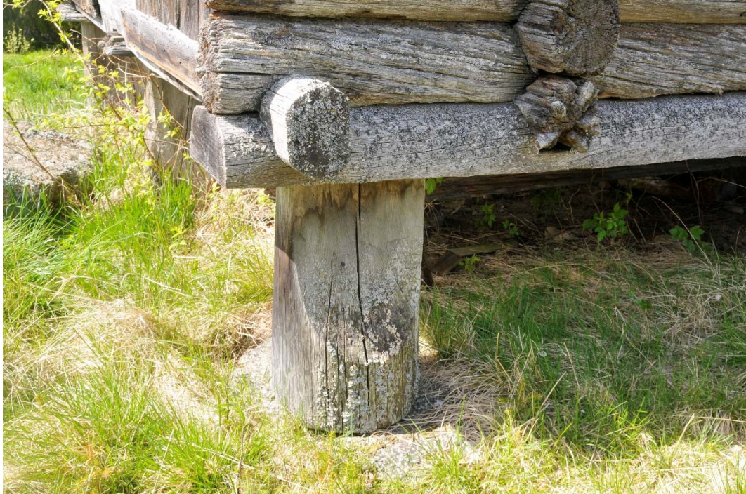
Ytterberg 54:1, Härbre no 3. Stolparna under byggnaden byttes ut 1995 och ytveden har kraftiga rötskador. De originalstolpar som kunde återanvändas under byggnaden är i betydligt bättre skick.
