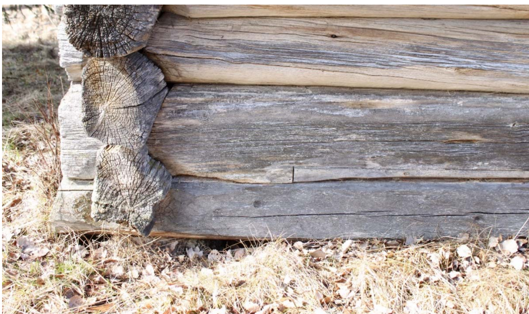
Blomtorpet. Andra stocken från mark har ilagats i underkant med en plank som spikats upp under stocken. Inget att anmärka på hållfastheten och den är inte heller iögonfallande.
