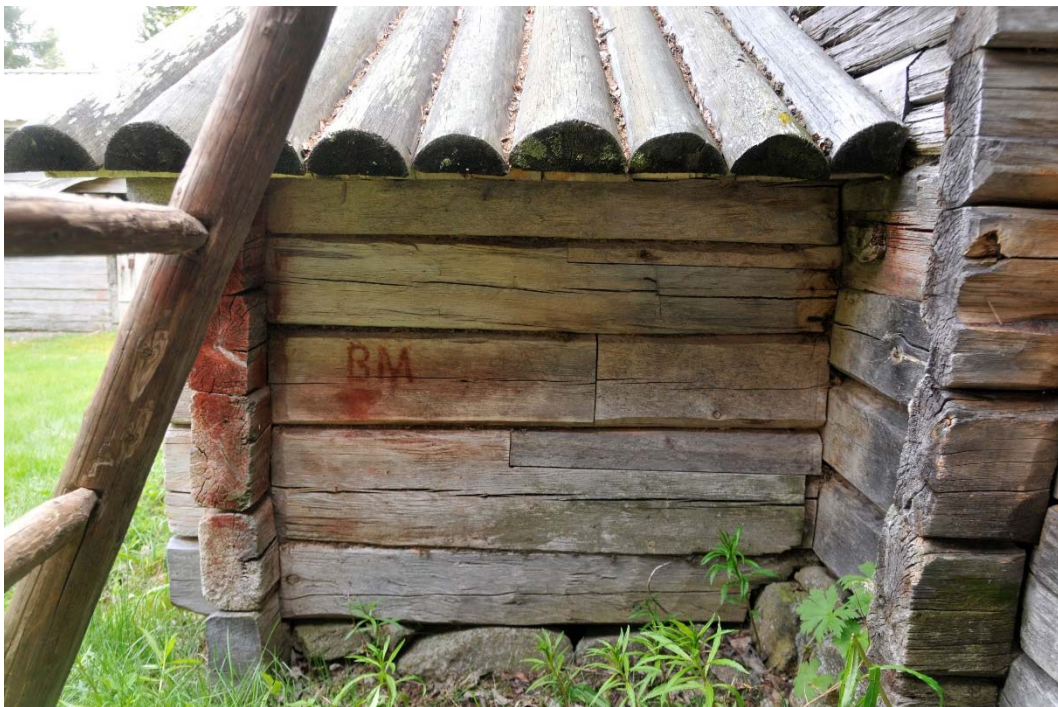
Västremmen, Lillstugan. Skarvar och ilagning av skador. Skarvarna är något glesa men i övrigt inget att anmärka på utförandet eller val av virke. Den nedersta ilagningen i varv två är kanske något för rak horisontellt vilket gör att den sticker ut i förhållande till de andra sprickorna och linjerna i stommen. Då källarsvalen har glidit ifrån väggen har man tvingats välja om lagningen skulle göras lika lång som ovanliggande stock eller om den ska följa den undre stockens längd där man kan se hur stockarna sett ut ursprungligen med en inlaxning i stommen.
