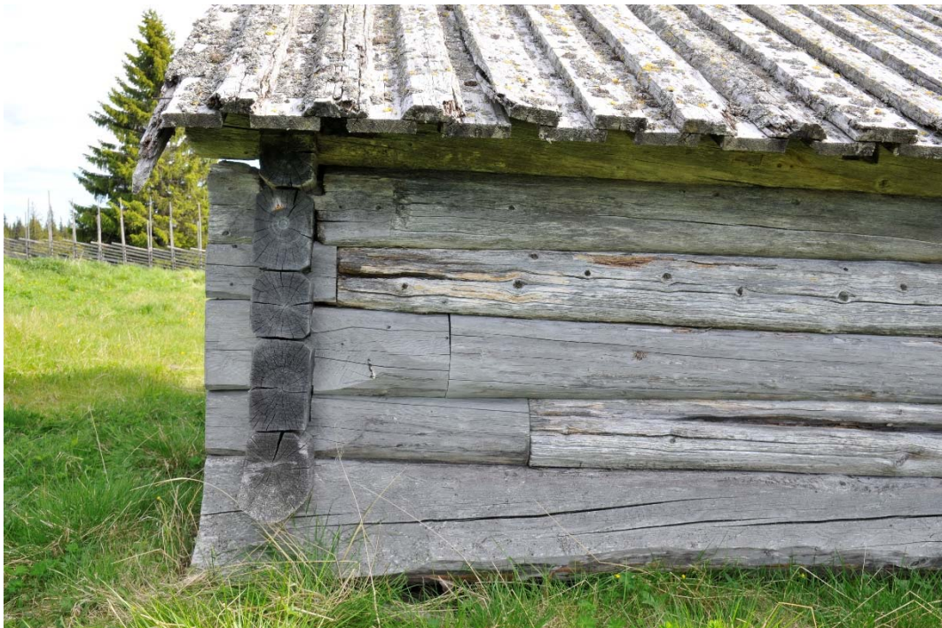
Långbodarna, Bod VII. Ett tydligt exempel på problem med virkesförsörjningen i denna upprustning. Bristen på virke med rätt egenskaper ledde till att man inte kunde välja rätt dimensioner och syllstocken här har fått betydligt större dimensioner än vad originalstocken hade. Dessutom ledde bristen på virke till att man även var tvungen att skarva den nya tredje stocken i väggen. Något som ser helt omotiverat ut om man inte känner till problemen med virkesanskaffningen. Notera även brädtakets skick där främst locken har stora rötskador.
