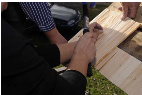
Arbetet med att spika spåntaket börjar vid takfoten. Så jobbar man sig uppåt.
