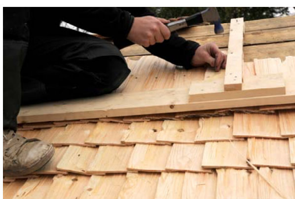
Arbetet med att spika spåntaket börjar vid takfoten. Så jobbar man sig uppåt.
