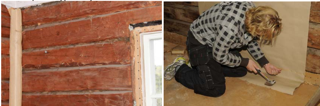
Papp spikas först fast i hörnen. Oskar Källberg spikar fast papp på väggarna. När den torkar ströks den.
