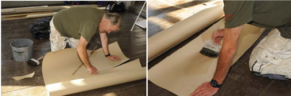
Per Halvarsson skär pappen i lagom stora bitar. Den blötläggas sedan genom att penslas med vatten.
