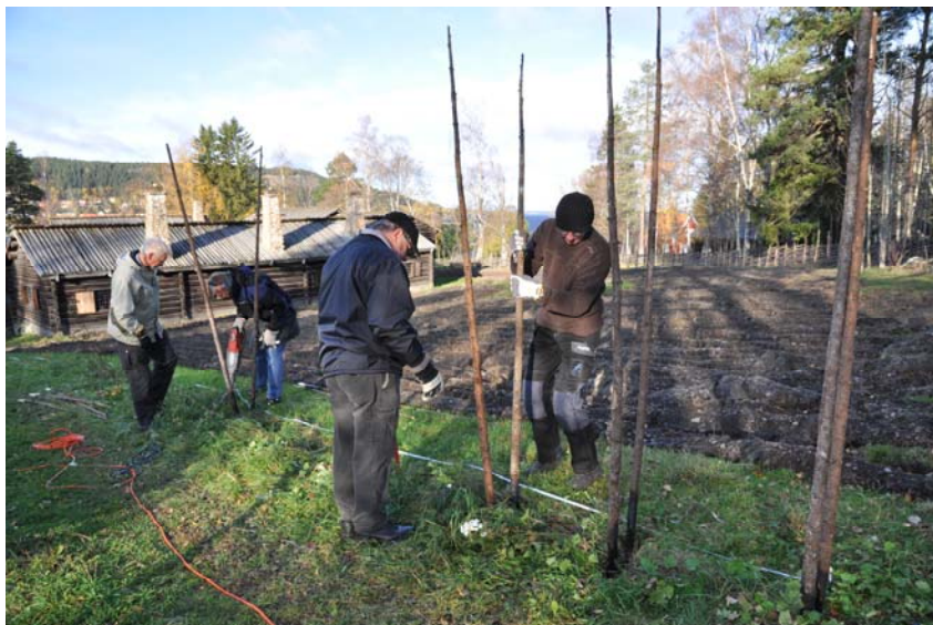
Arbetet började högst upp i slänten. Deltagarna gjorde hål för störarna med 80 cm mellanrum. Det gjordes växelvis med borr och med spett. Ett måttband lades ut för att för att underlätta arbetet.
