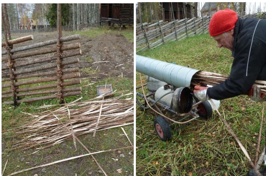
En hög med vidjor går snabbt åt när man bygger gärdegård. Vidjorna stoppas in i ångmaskinen för att blötas och värmas.
