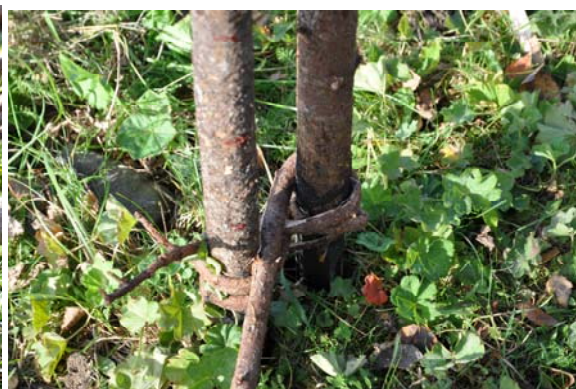
Slanorna låses fast med vidjor som värmts i ångmaskinen. Vidjorna blir då böjbara och formas till en åtta. När de kallnar kan knuten inte gå upp.
