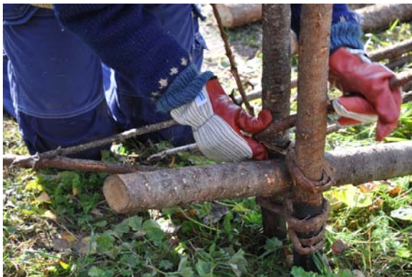
Slanorna låses fast med vidjor som värmts i ångmaskinen. Vidjorna blir då böjbara och formas till en åtta. När de kallnar kan knuten inte gå upp.
