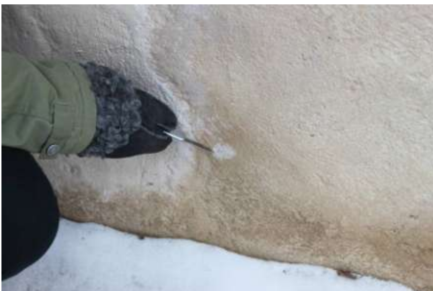
När skrapning med kniv gjordes på den mörka utfällningen kom den ljusa putsen fram under.
