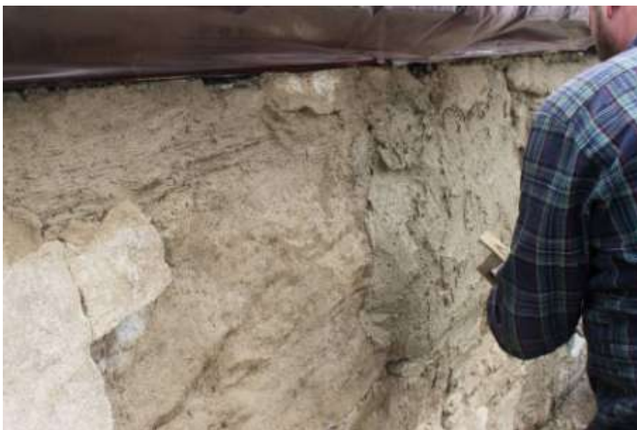
Grundningen började läggas på efter att slamman har torkat in.
