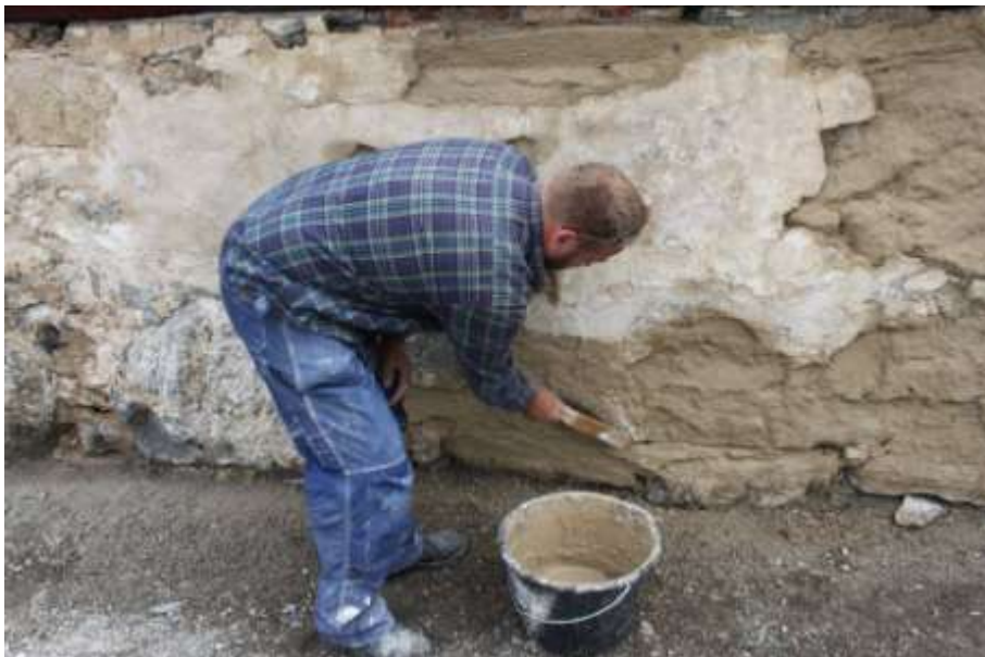
En slamma borstades in på ren sten för att skapa bättre vidhäftning för grundningen.
