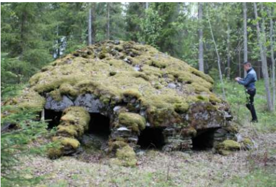
Den obrända kalkmilan i Åse som har fyra eldningsgångar.
