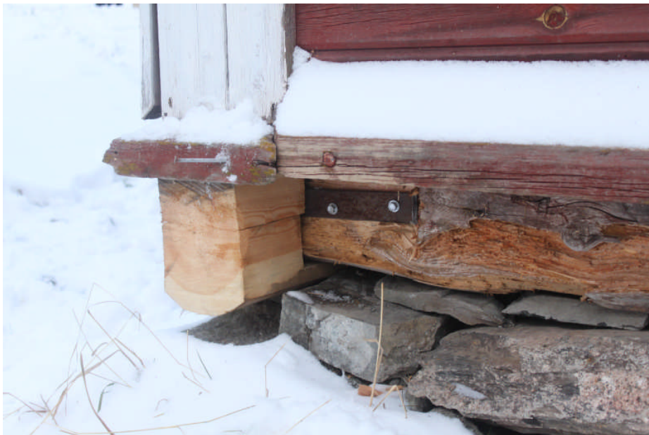
DA-knuten sedd från D-väggen
