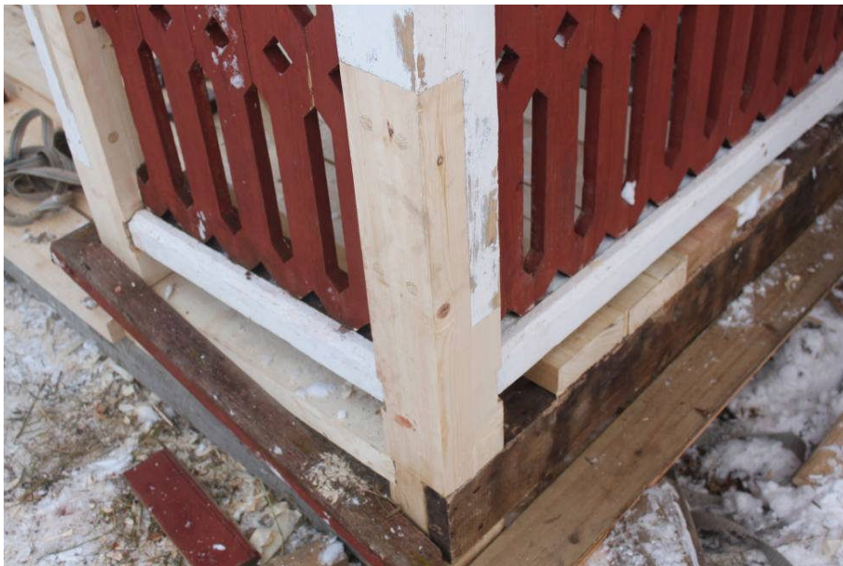
Hörnstolpar har fått skarvas i nederkant och sedan tappats ned i syllramen
