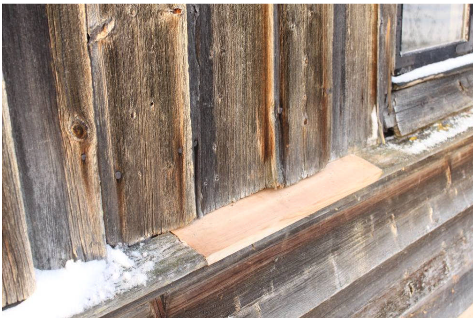
Lagning av dropplist, parhusets D-vägg
