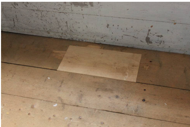
Lagning av rötskadat parti
