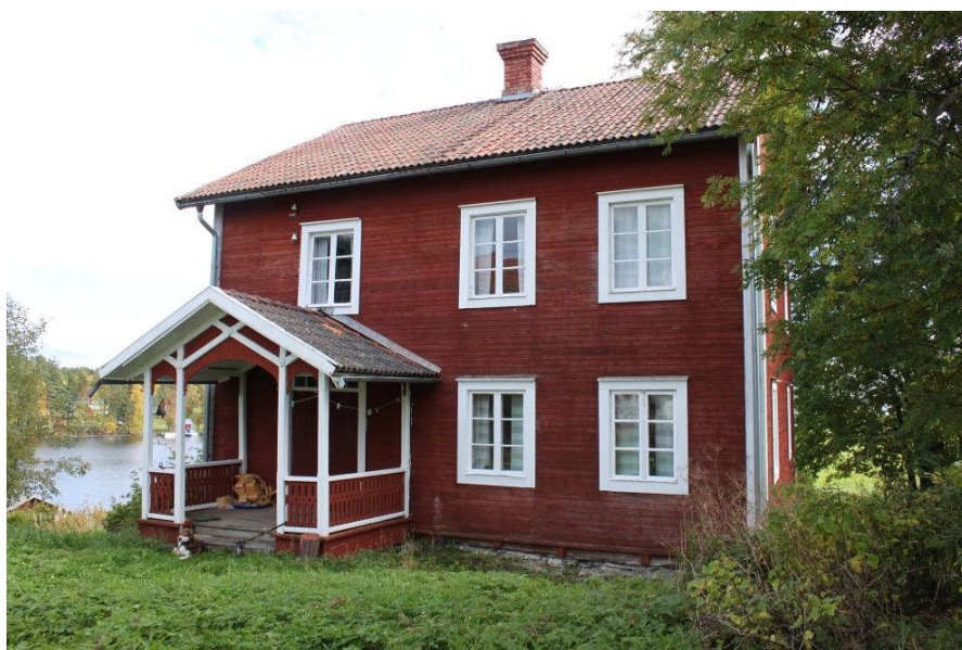
Farstubro före åtgärder
