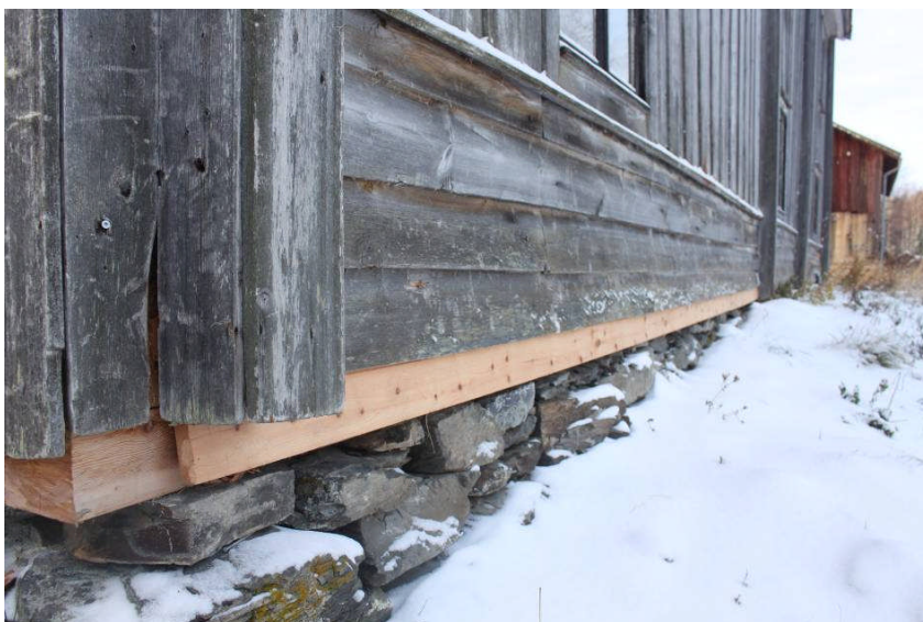
Ny panelbräda på parhusets C-vägg
