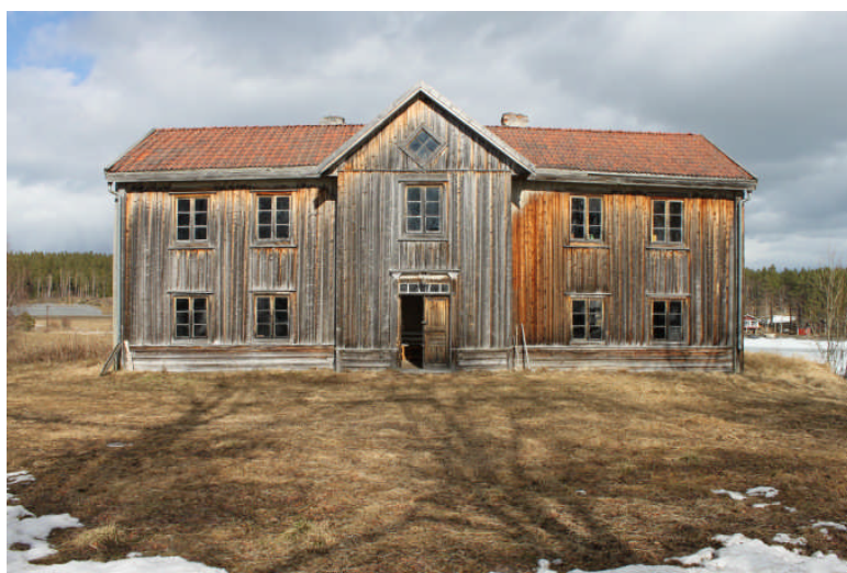
Bostadshus (parstuga). IMG_0347 (Bild från åtgärdsprogram)
