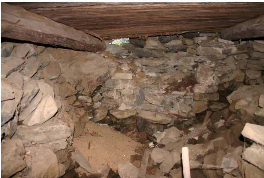
Bilden visar undersidan av trossbotten den så kallade blindbotten. Bottenbrädorna i trossbotten vilade enligt Joni Lidberg på de bärlinor som även bar upp golvåsarna
