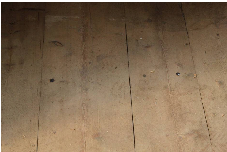
Handsmidda spikar har satts i de befintliga spikhålen i golvplanken
