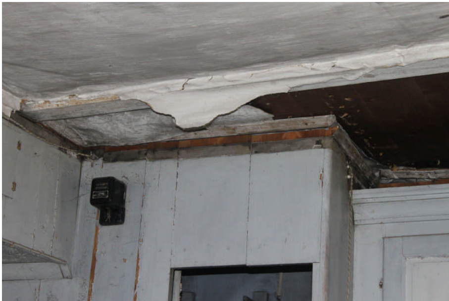
Del av fast inredning före det att golvbjälklaget höjts (Bild tagen 2011)
