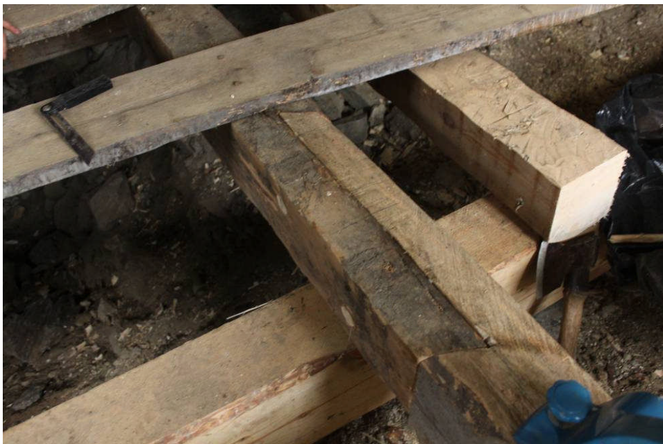
Vertikal bladskarv med sneda vinklar
