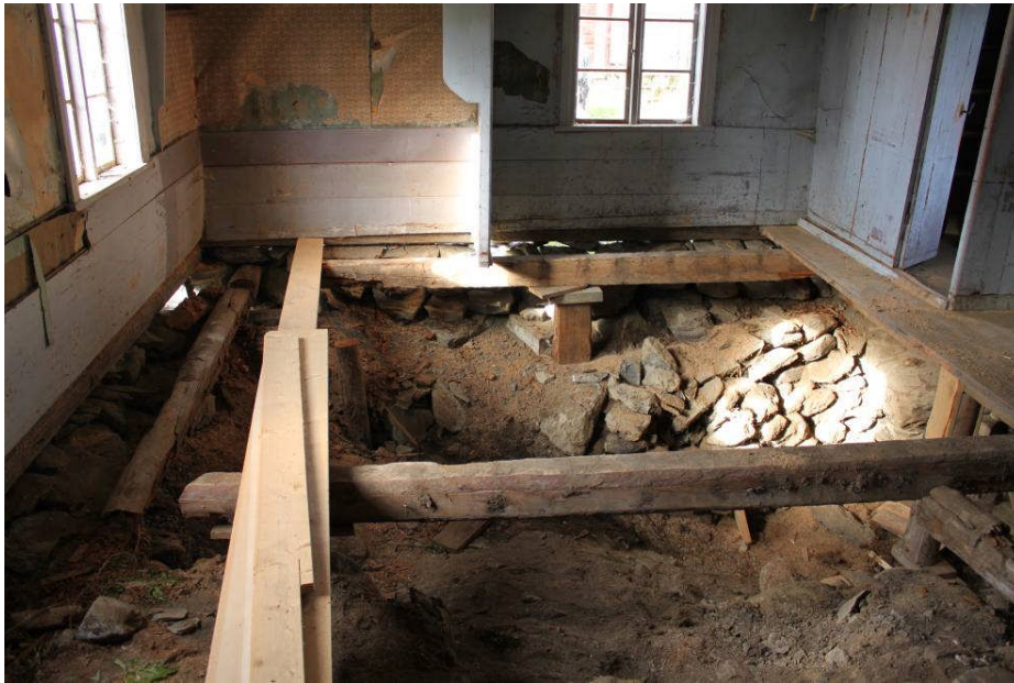
Delar av golvbjälklaget, i bild syns två av de äldre golvåsarna nr 1 och 2, till vänster ligger en av de äldre rötskadade bärlinorna, nr 1
