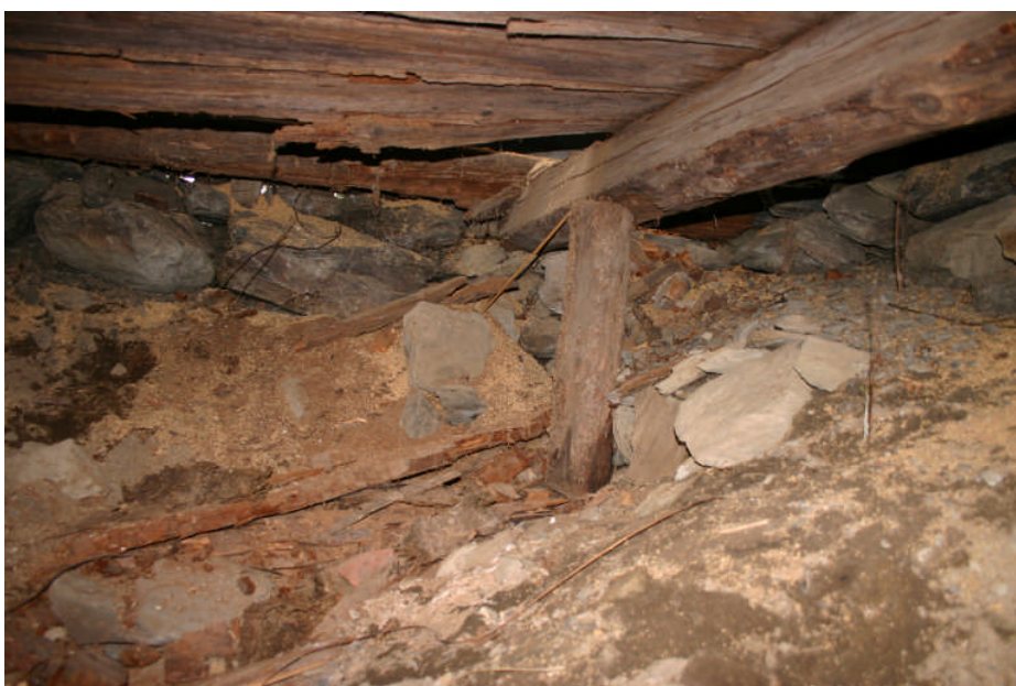
Trossbottens undersida, motsatt sida (Bild från 2010)
