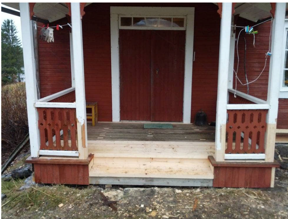
Farstubron är färdig, målningsarbeten återstår
