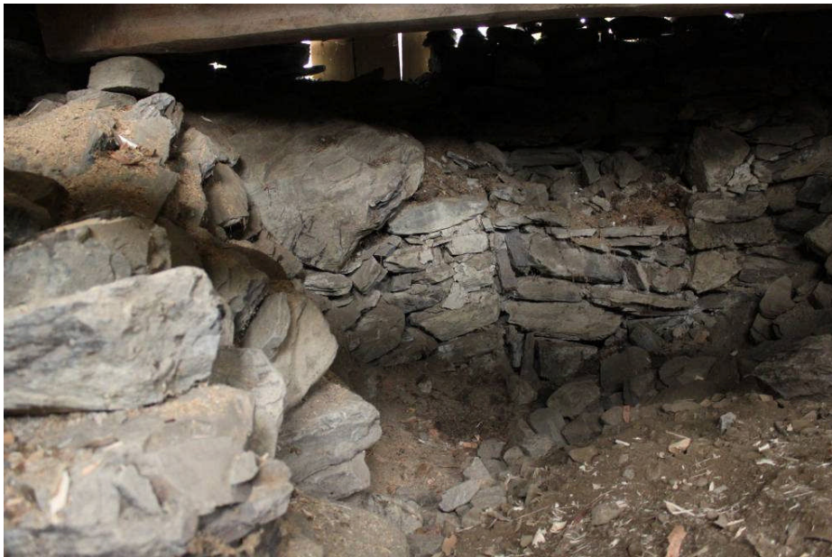
Resterna av det som troligen varit en källare, vy mot C-väggen
