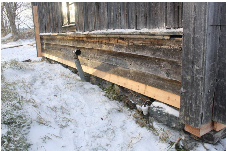
Ny undre panelbräda på parhusets D-vägg
