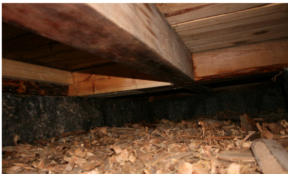
Lagning av golvåsar, här vid stolpe 2 (till vänster om dörren) på den södra sidan
