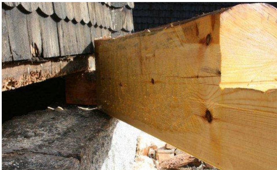
Nya syllstocken sätts på plats, med ett hack där golvhäsen passas in.
