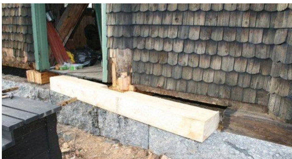
Syllstocken passas in, sista biten till höger under stolpe 4 var i gott skick och bevarades. Trappan flyttades ut från klockstolpen under arbetets gång.
