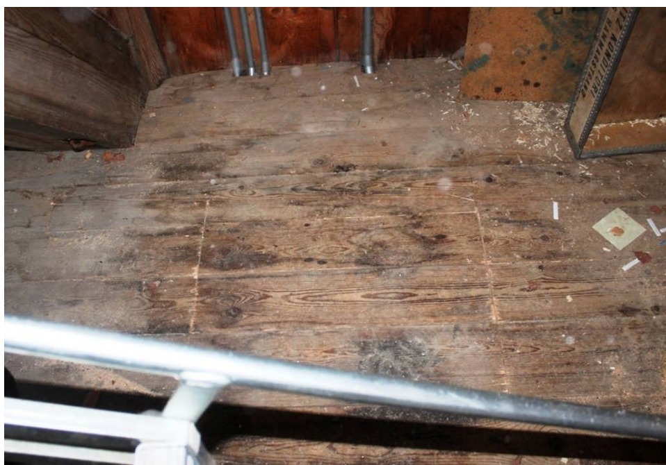
Luckan som gjordes för att komma åt golvåsarna i klockstapeln
