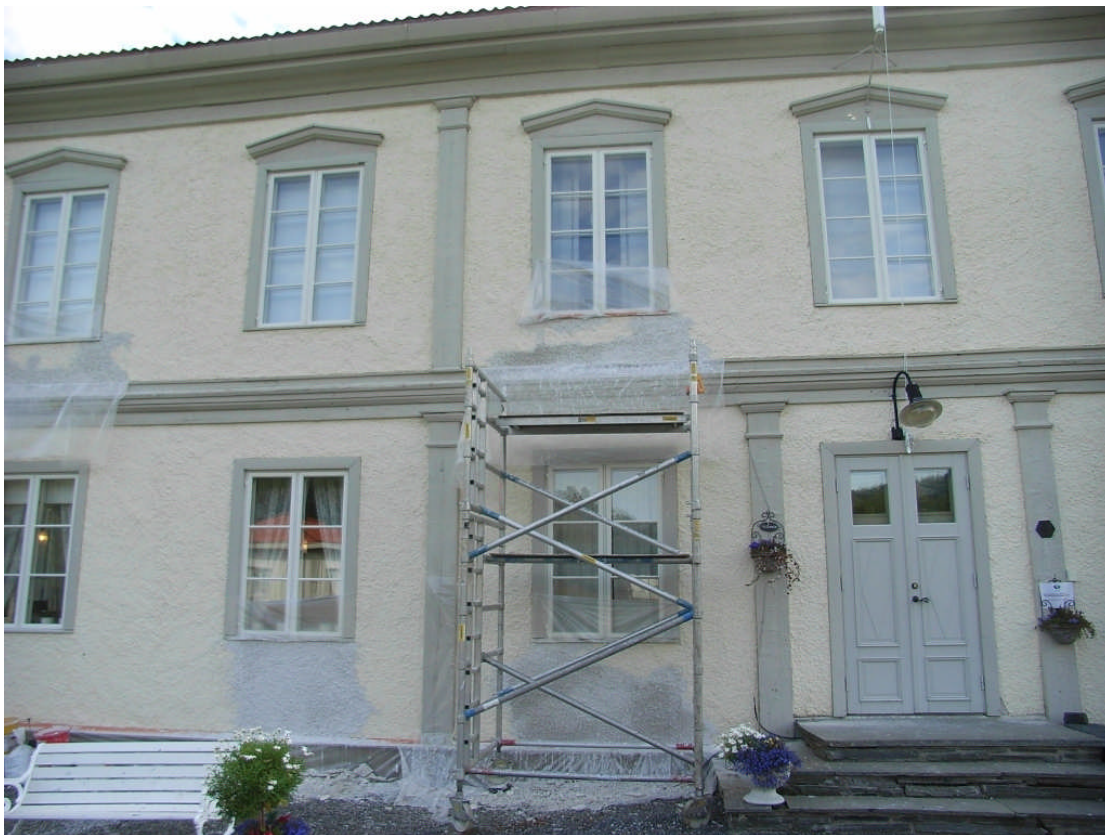
Mest utsatt är den vänstra sidan av fasaden, här pågår påläggning av ytputs.
