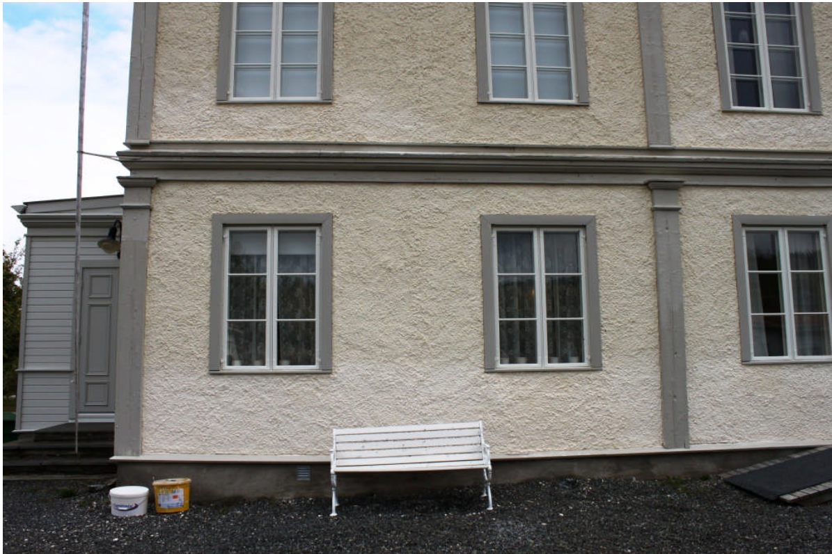
Fasad A när avfärgningen är klar, marginell skillnad kan ses på partierna med ny avfärgning som är lite ljusare men det kommer att jämnas ut.
