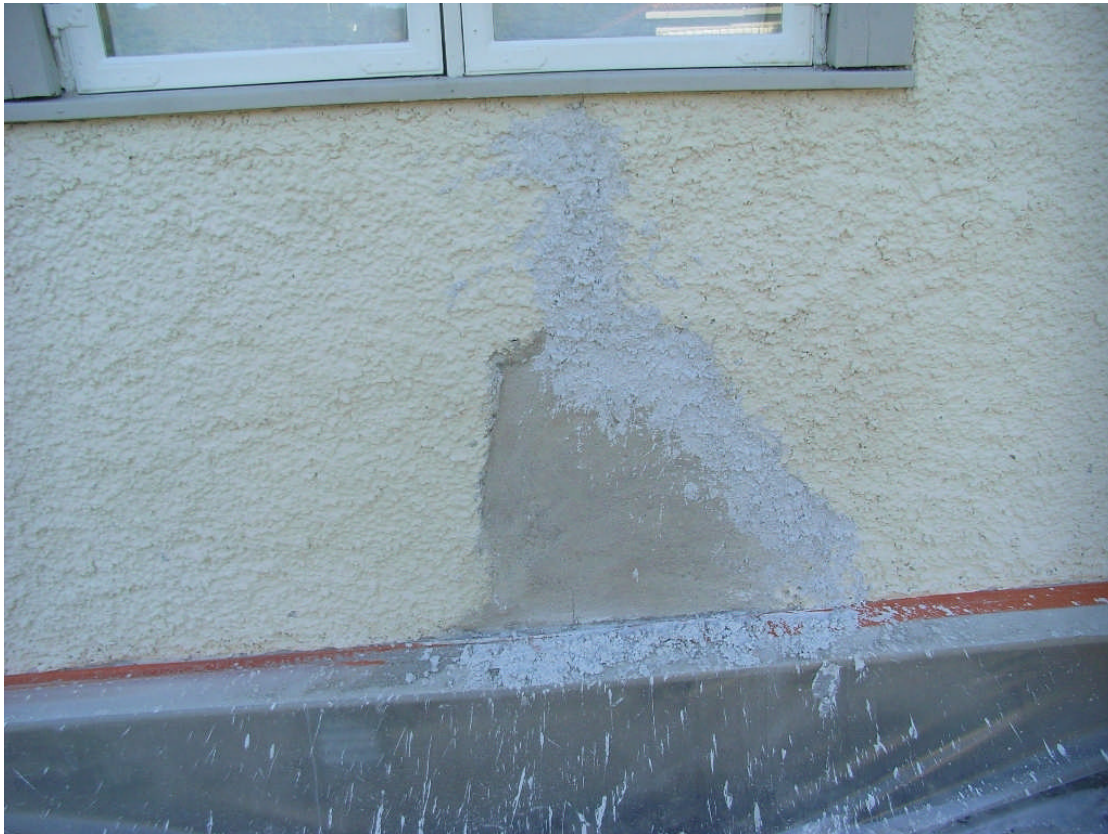
Att påföra spritputsen har påbörjats. Utstockningen var här i gott skick.
