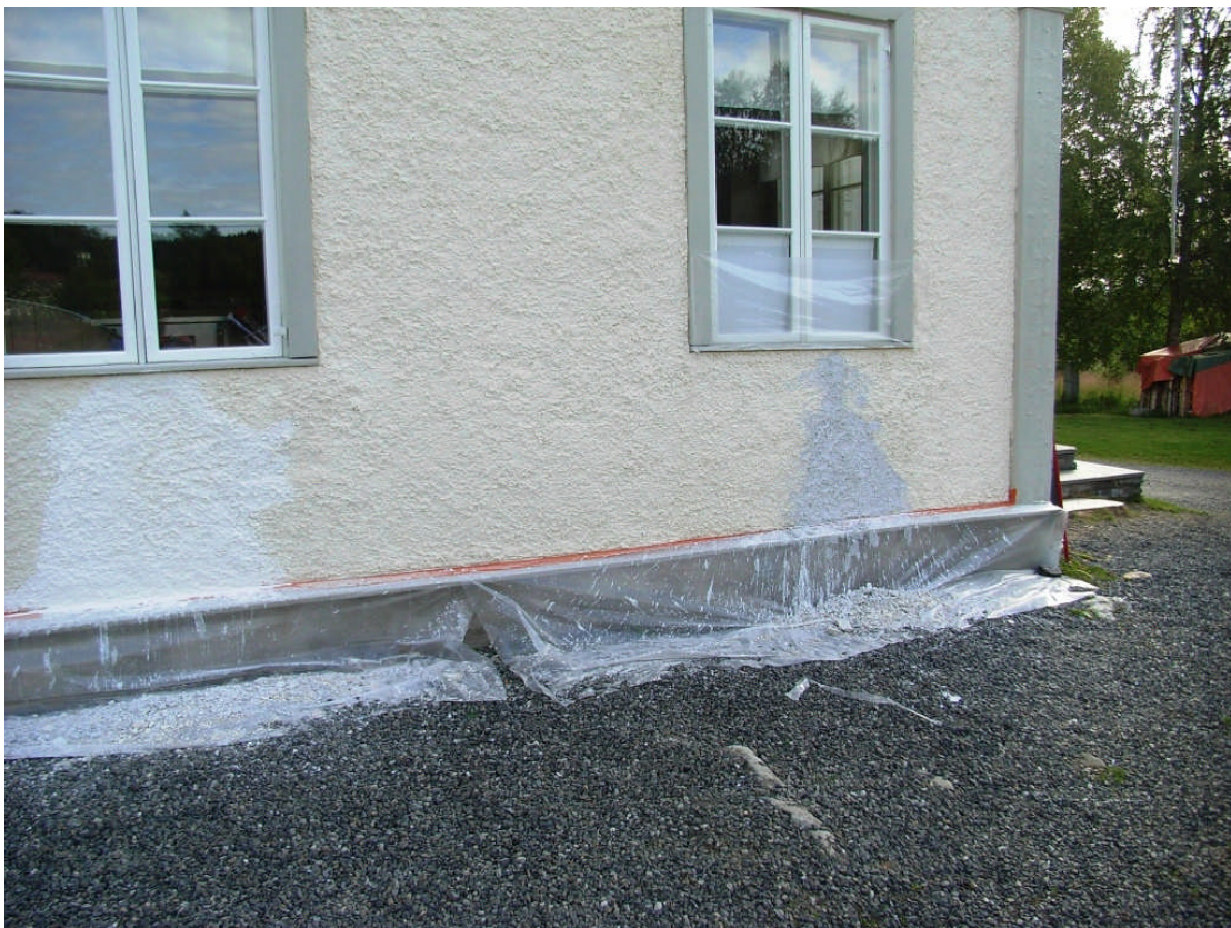
Under fönstret till vänster har avfärgning påbörjats. Lagningarna avfärgades två gånger och partierna under fönstren i sin helhet avfärgades ytterligare tre gånger.
