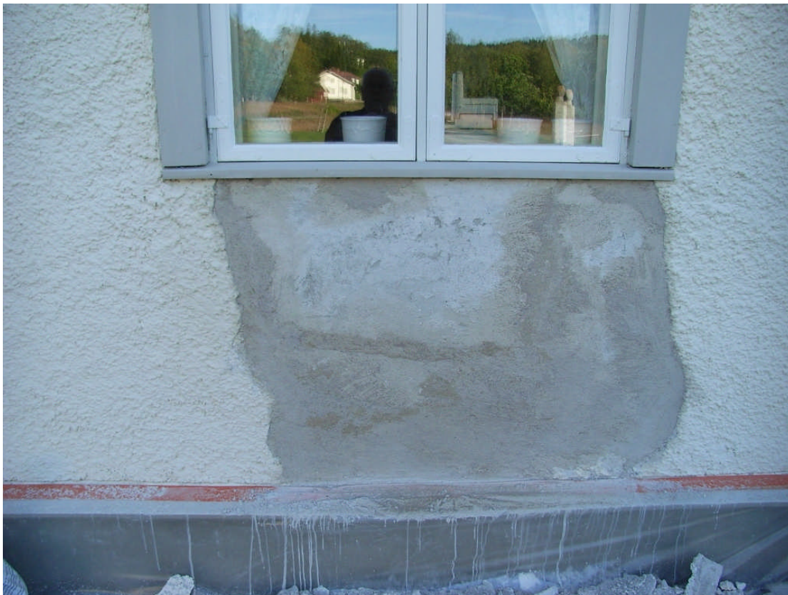
Fasad A, under fönster 2 från vänster. Skadade ytputs är borthuggen, och komplettering och utfyllning har gjorts med kalkputs. Sockel inklädd med skyddsplast.
