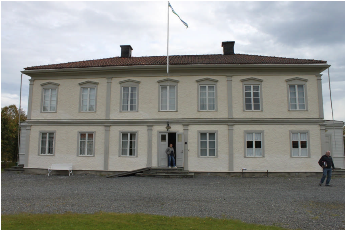
Fasad A när arbetena är färdiga.
