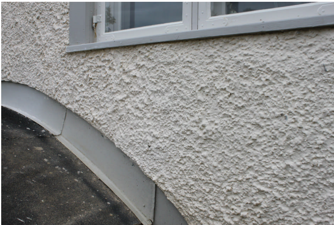
Skadan i putsen på C-väggen är åtgärdad, och ingen skillnad syns mellan lagning och angränsade ytor.
