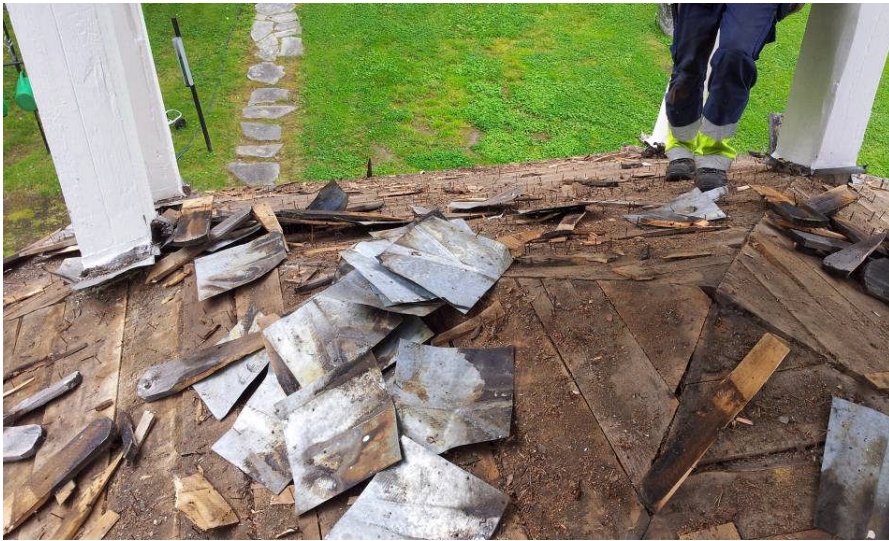
Spåntäckningen har rivits av, äldre insticksplåtar kom fram då spånen revs bort (Bild tagen av Bengt Anderzon, vaktmästare Tännäs-Ljusnedals församling)
