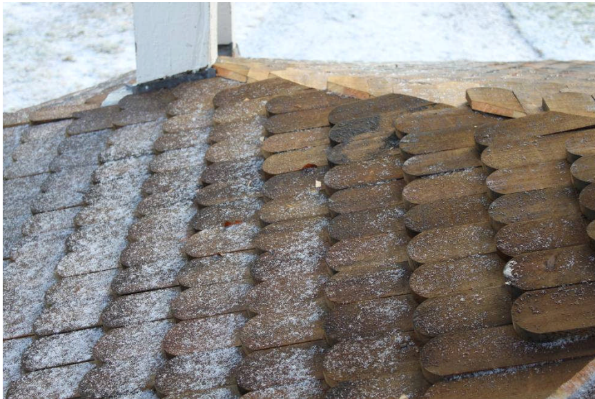
Spånen har lagts med växelvis överlappning avnocken
