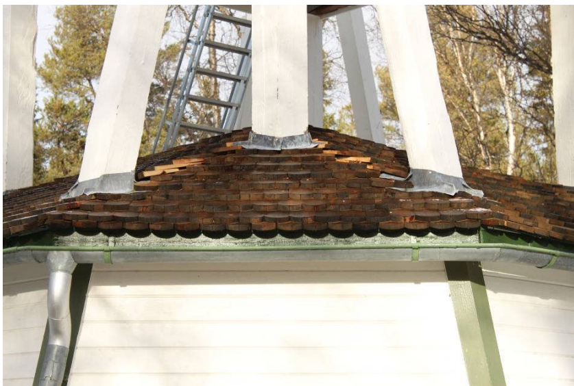
Här ser vi att spånen på det högra och vänstra takfallet kragar över det triangelformade takfallet
