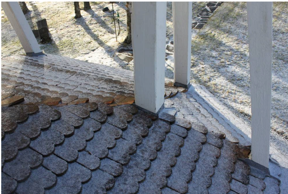
Intäckning kring stödbenens nedre delar har gjorts av blyplåt som bockats och vikts samt spikats fast
