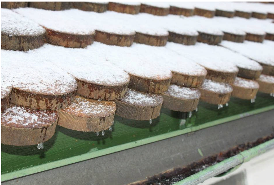
Det första spånvarvet läggs av kortare spån
