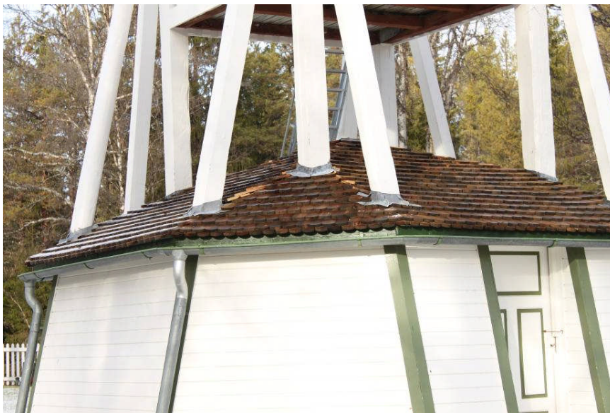
Solfjäderstäckning har använts över skarvarna, detta gäller alltså de tre nedersta spånvarven mot takfotskanten
