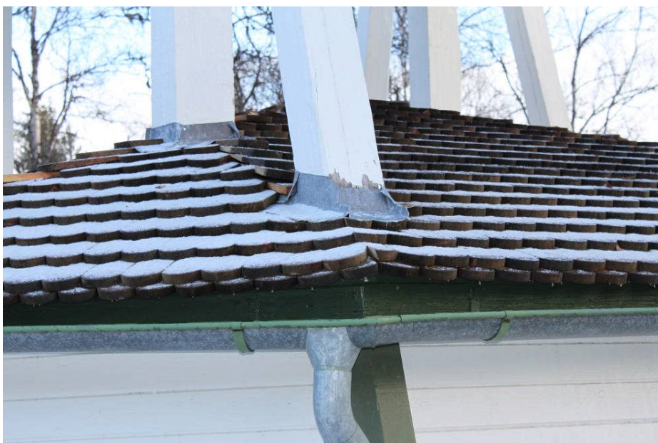
Intäckning kring stödbenens nedre delar har gjorts av blyplåt som bockats och vikts samt spikats fast
